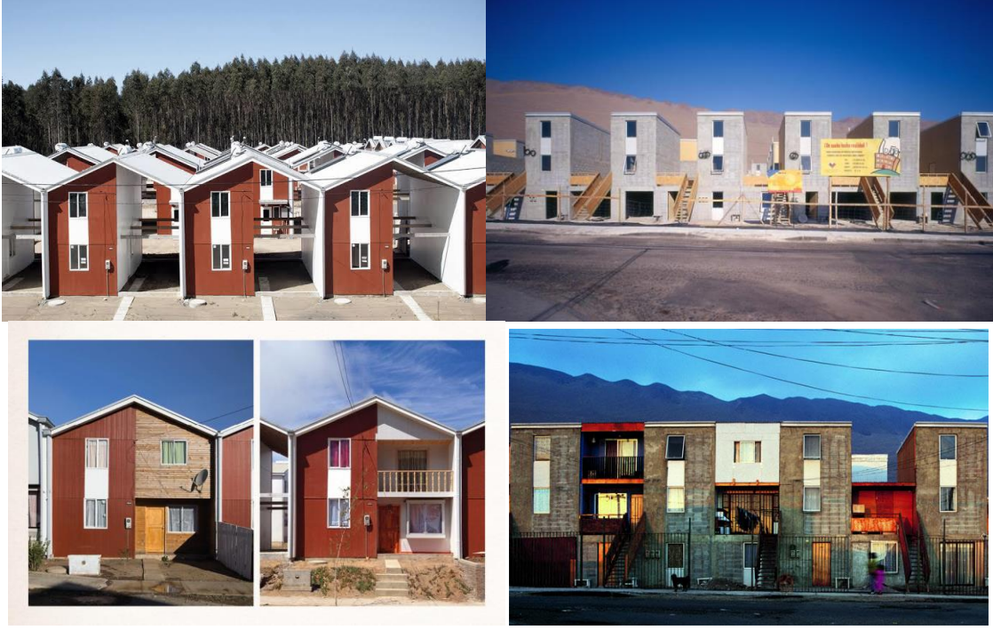
Görsel 1.5. Alejandro Aravena, "Half a good house", 2016, yarım evler ve sahipleri tarafından tamamlanmış halleri, Şili. ( https://www.archdaily.com )
