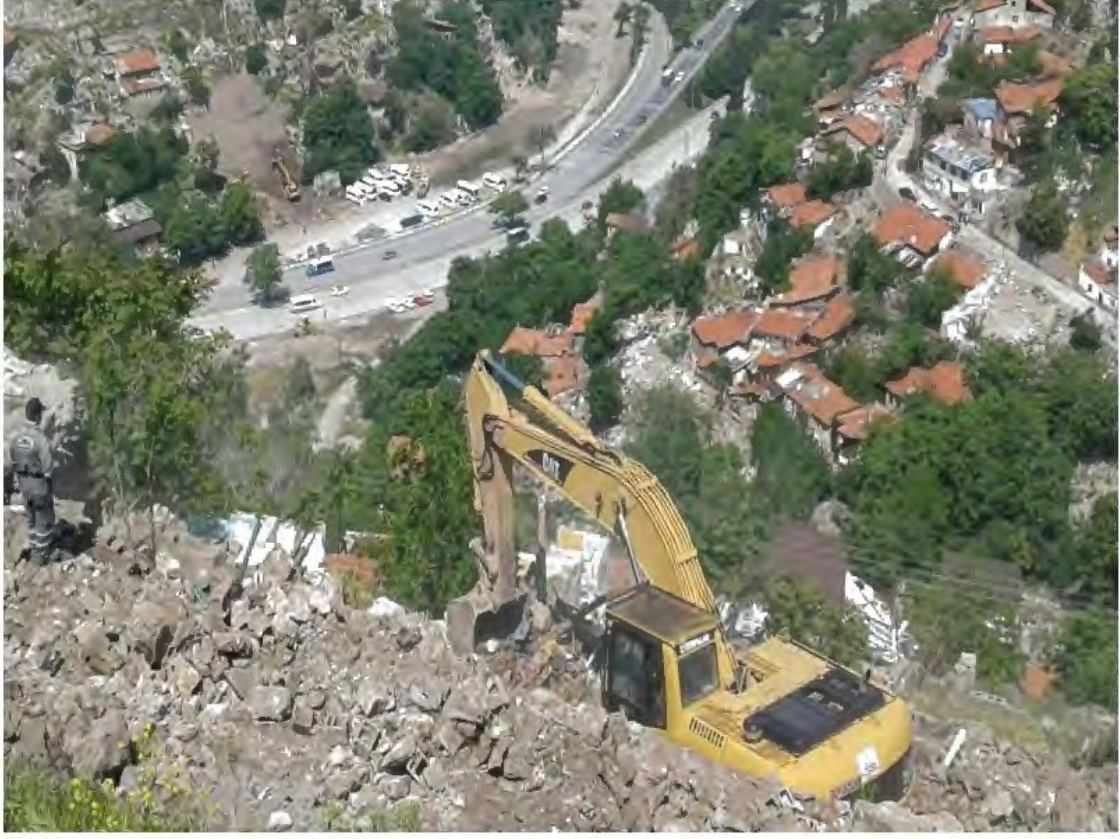
Görsel 3.6. Proje alanında devam eden yıkım çalışmaları (http-21)
