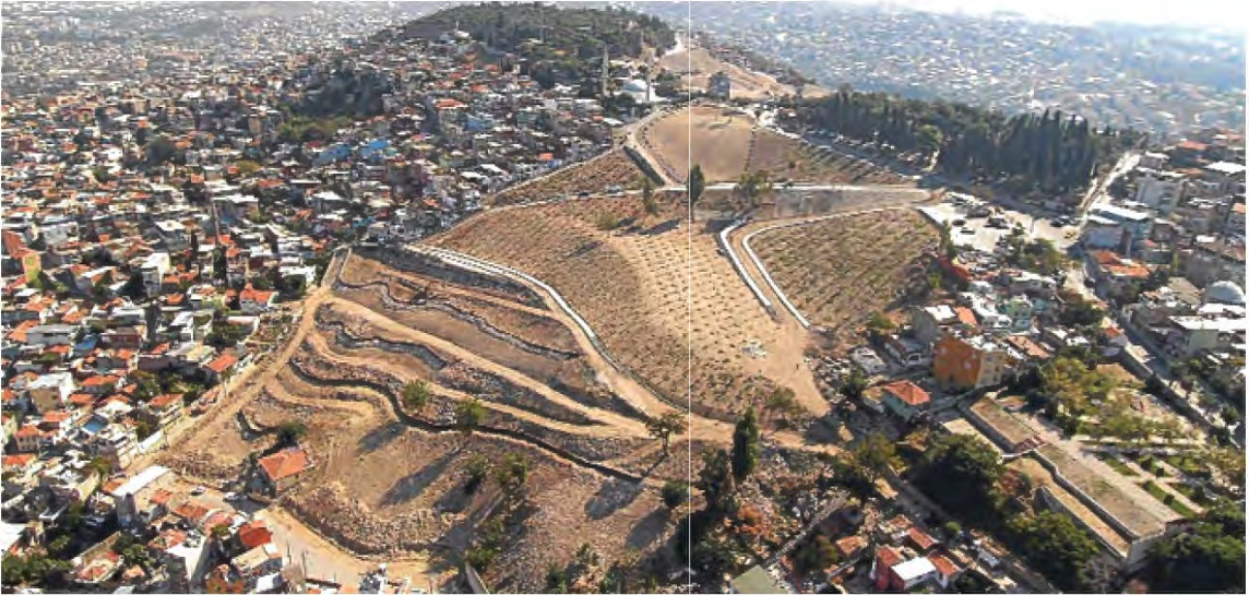
Görsel 2.16. Kadifekale kentsel yenileme projesi yıkım sonrası ( http-8 )
