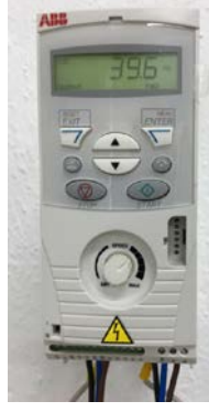
Görsel 4.3. Radyal Fan Kontrol Sürücüsü
