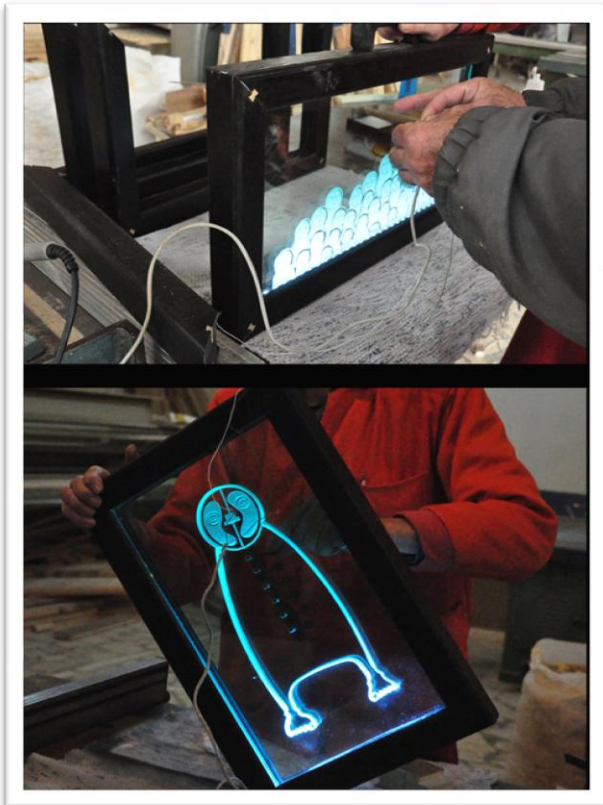
Görsel 89 – Montajı yapılmış çerçevelerin aydınlatma kontrolü
