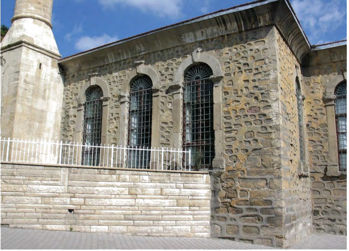
Fotoğraf 165: Tekirdağ Süleymanpaşa Orta Camii Güneybatı Cephesi (Harim,) Restorasyon Öncesi (Ani Mimarlık)
