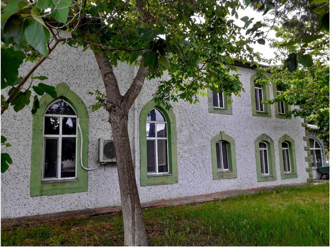
Fotoğraf 117: Tekirdağ Kapaklı Uzunhacı Mah. Camii Kuzeydoğu Cephe (2022)
