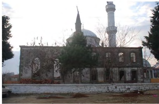
Fotoğraf 16: Günümüze Ulaşmayan İpsala Aliço Pehlivan Köyü'ndeki Camii (Murat Karademir'den)
