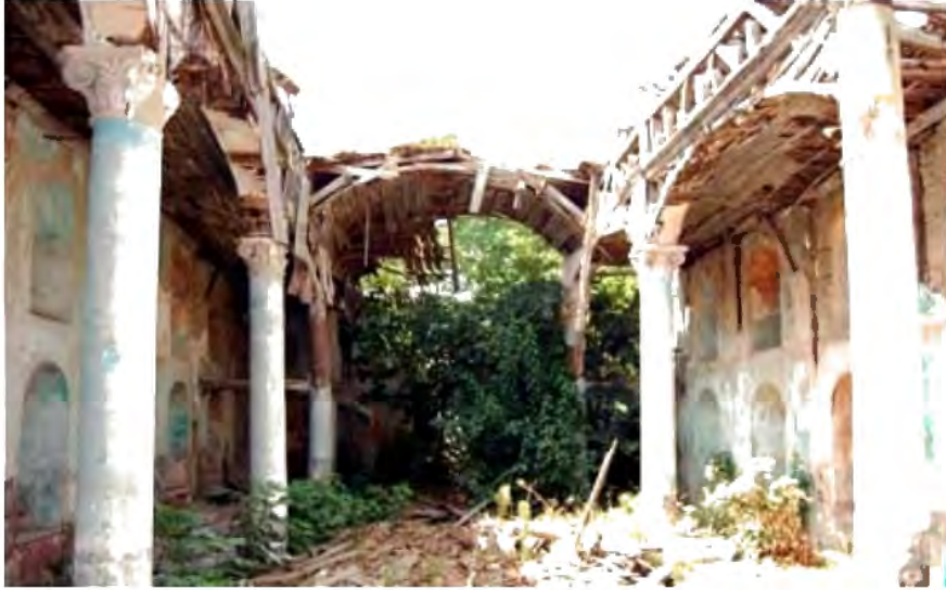
Fotoğraf 302: Tekirdağ Malkara Surp Toros Ermeni Kilisesi Ahşap Tonoz Örtüsü (Taksim Yapı)
