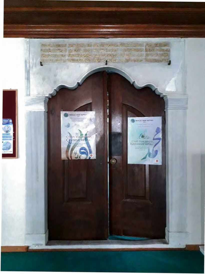
Fotoğraf 152: Tekirdağ Süleymanpaşa Orta Camii Harime Giriş Kapısı (2021)
