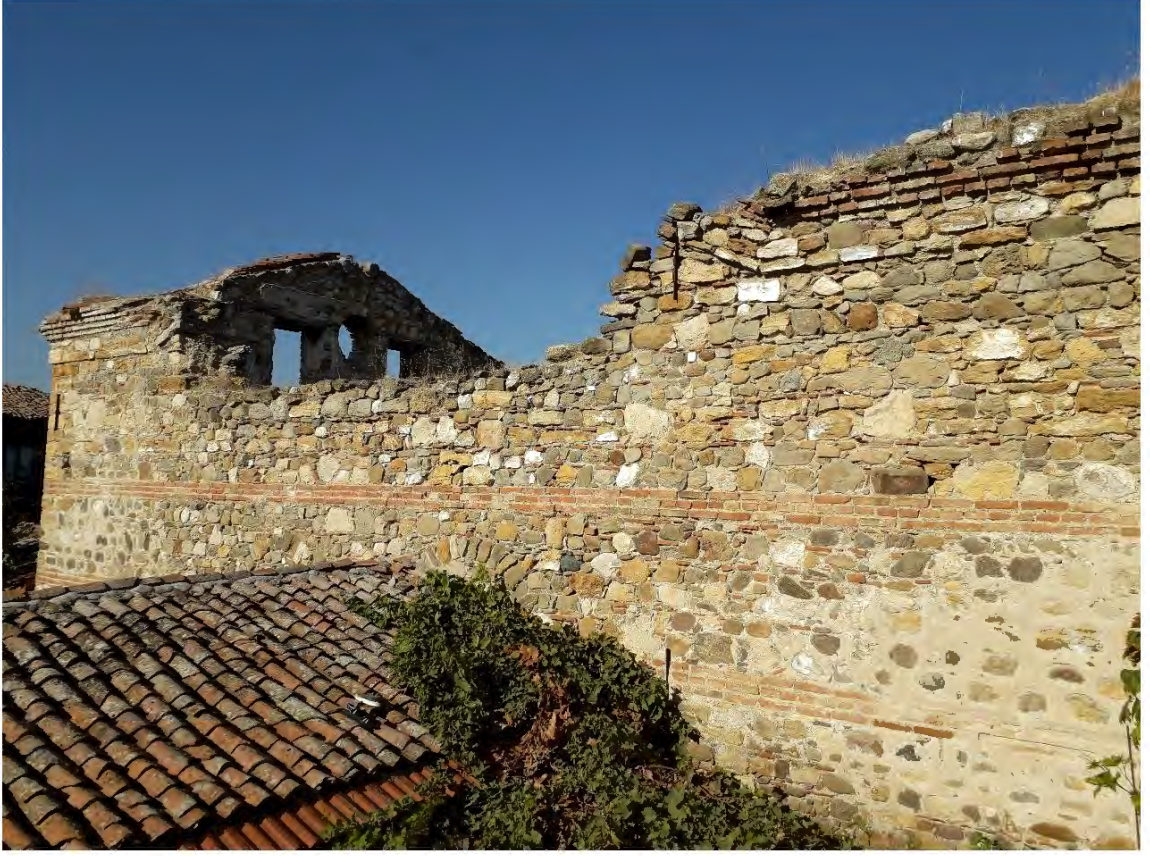
Fotoğraf 265: Şarköy Eriklice Mahallesi Aziz Theotokos Rum Kilisesi Güneybatı Cephesi (2022)
