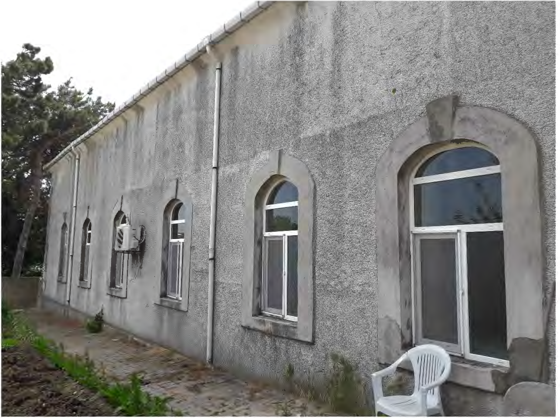
Fotoğraf 65: Tekirdağ Saray Göçerler Mah. Camii Kuzeydoğu Cephe (2022)
