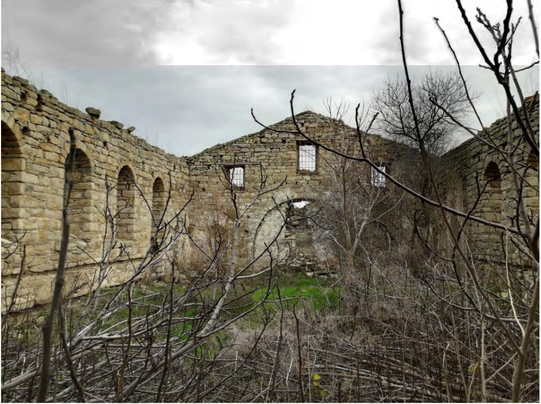
Fotoğraf 233: Malkara Şahin Mahallesi Kilisesi İç Mekanın Batıdan Görünümü (2022)
