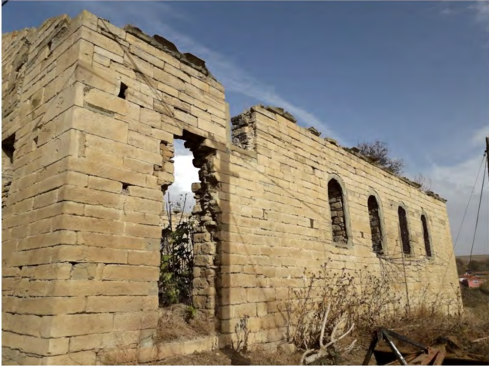
Fotoğraf 238: Malkara Şahin Mahallesi Kilisesi Güney Cephe (2022)
