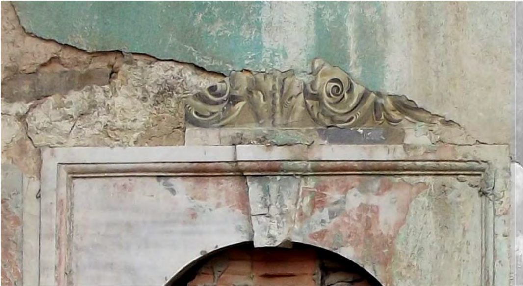
Fotoğraf 221: Tekirdağ Malkara Surp Toros Ermeni Kilisesi Güney Nef Kapısı Süslemeleri (Taksim Yapı)
