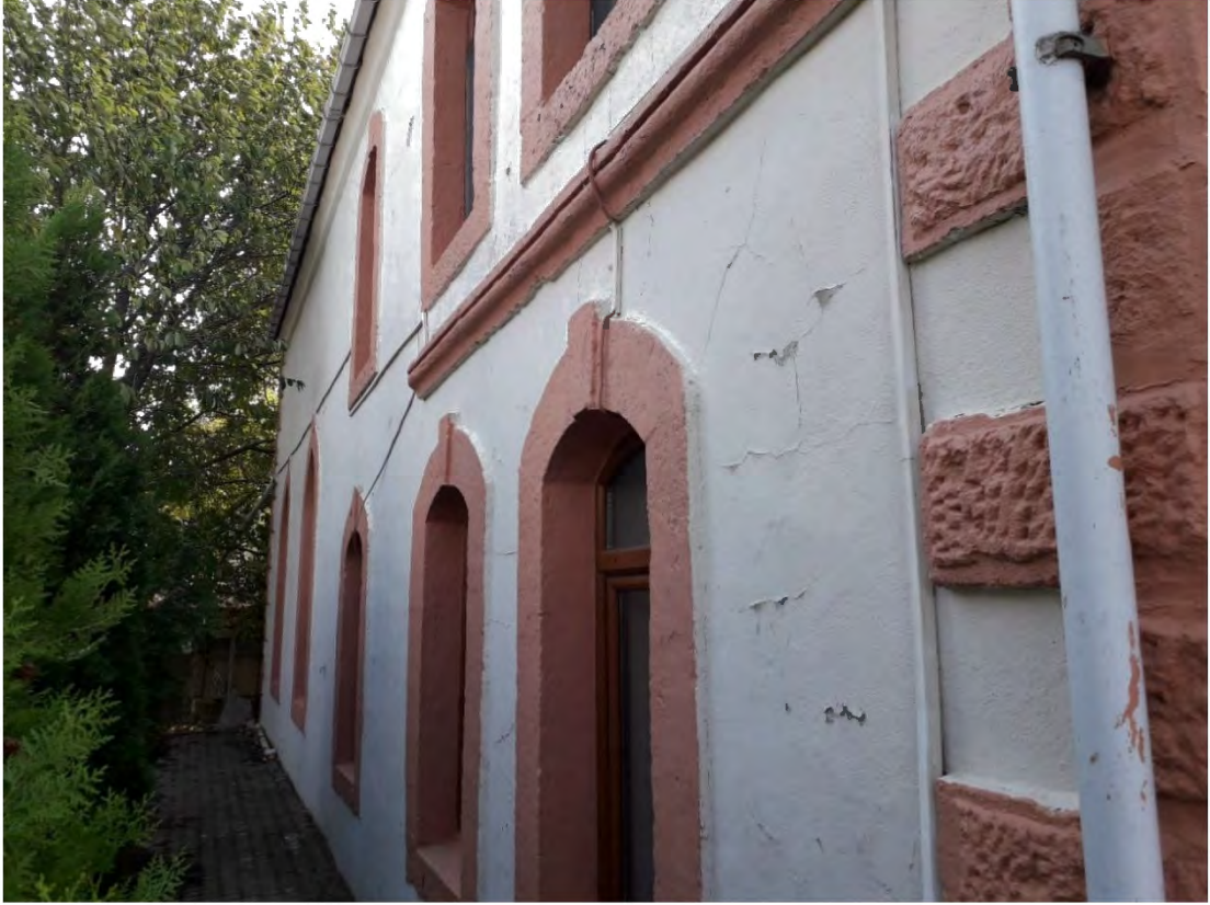
Fotoğraf 103: Tekirdağ Kapaklı Yanıkağul Mah. Camii Kuzeydoğu Cephe (2022)
