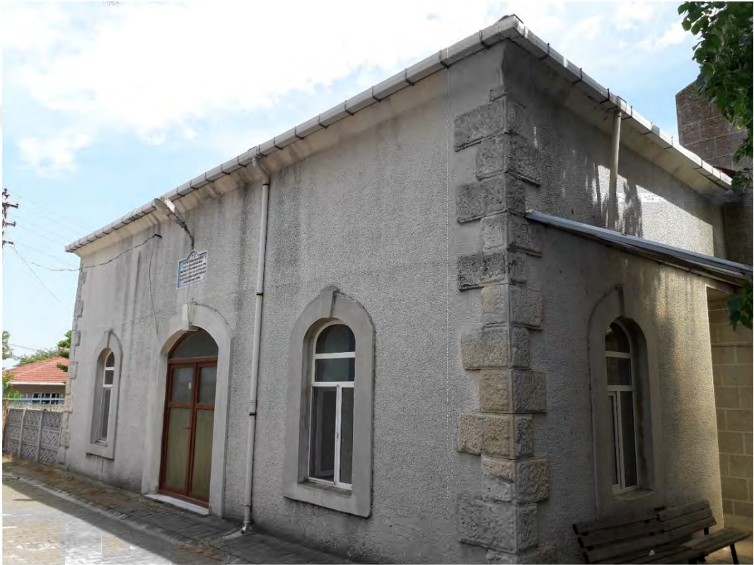
Fotoğraf 64: Tekirdağ Saray Göçerler Mah. Camii Kuzeybatı Cephe (2022)
