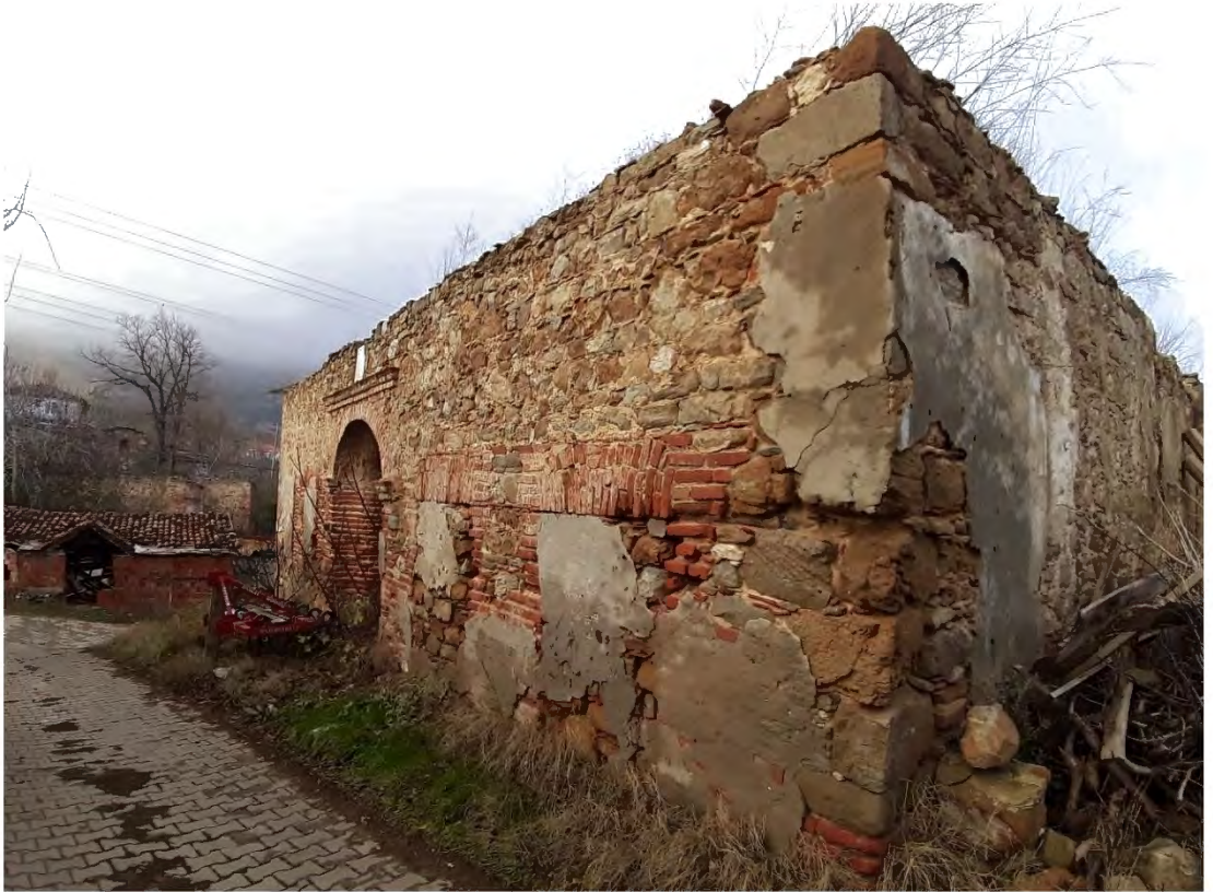
Fotoğraf 250: Şarköy Tepeköy Mahallesi Aziz Georgios Rum Kilisesi Batı Cephe (2021)
