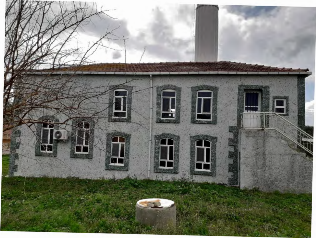
Fotoğraf 49: Tekirdağ Malkara Yörücek Mah. Camii Kuzeydoğu Cephesi (2023)
