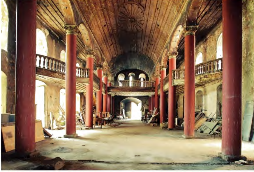
Fotoğraf 301: İstanbul Kumkapı Vortvots Vorodman Ermeni Kilisesi Ahşap Tonoz Örtüsü (K. Özkaragöz, 2009)
