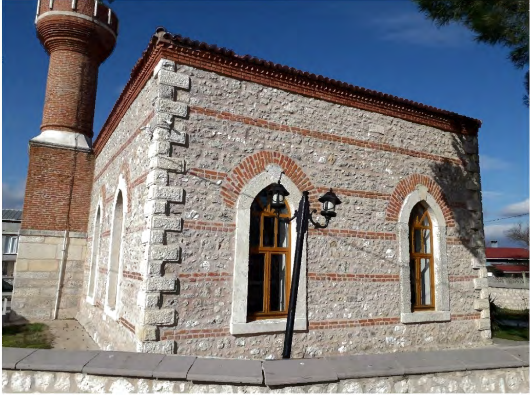
Fotoğraf 57: Tekirdağ Saray Kurtdere Mah. Camii Güneydoğu Cephe (2023)
