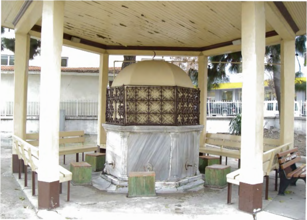
Fotoğraf 170: Tekirdağ Süleymanpaşa Orta Camii Şadırvanı, Restorasyon Öncesi (Ani Mimarlık)
