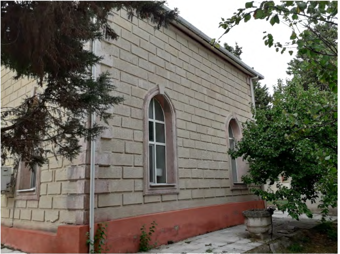
Fotoğraf 85: Tekirdağ Çorlu Şahpaz Mah. Camii Güneydoğu Cephe (2023)
