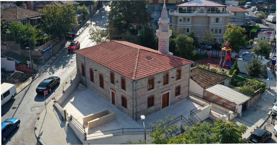
Fotoğraf 17: İstanbul Üsküdar Burhaniye Camii Genel Görünümü (1902) (Üsküdar Belediyesi)
