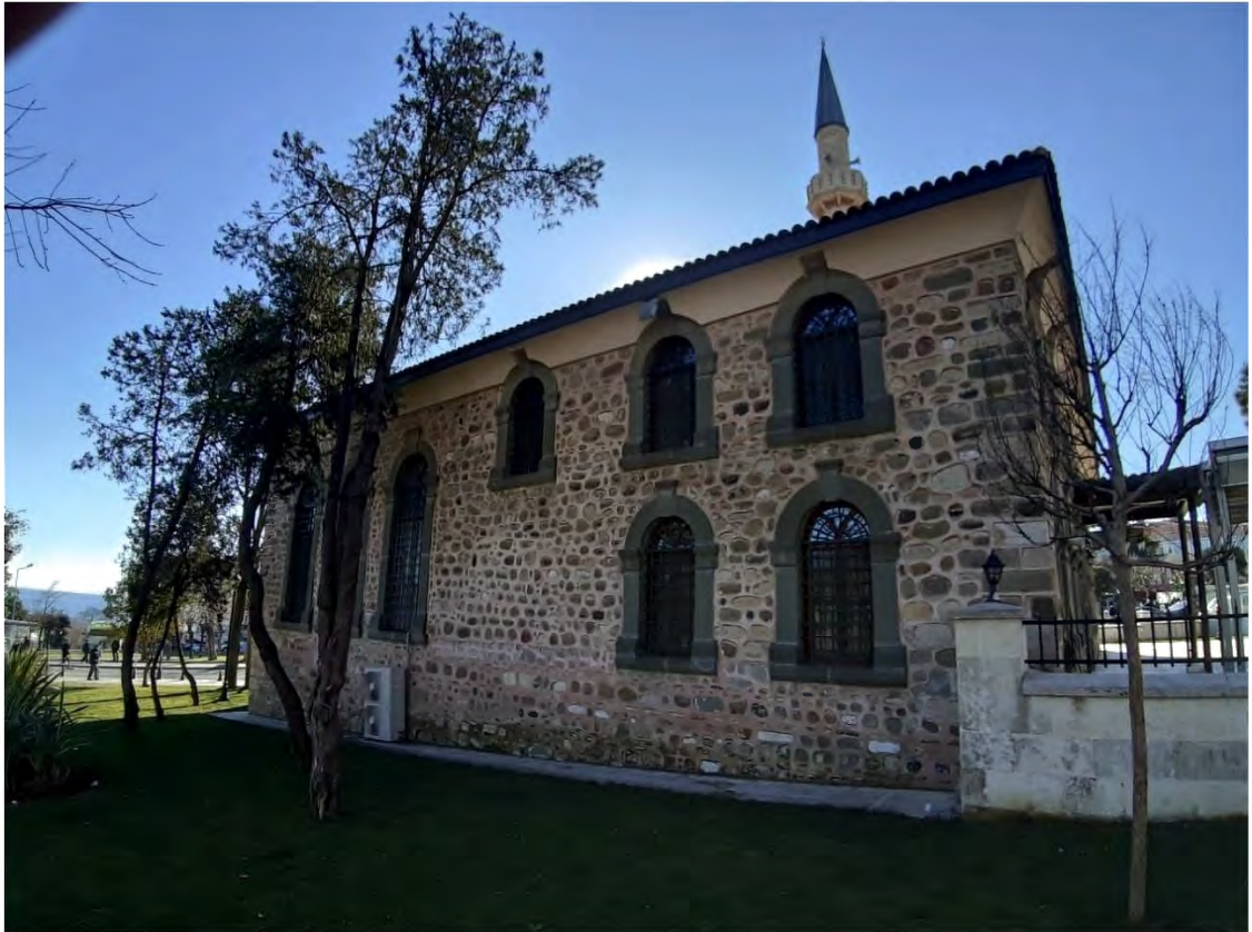
Fotoğraf 156: Tekirdağ Süleymanpaşa Orta Camii Kuzeydoğu Cephe (2021)
