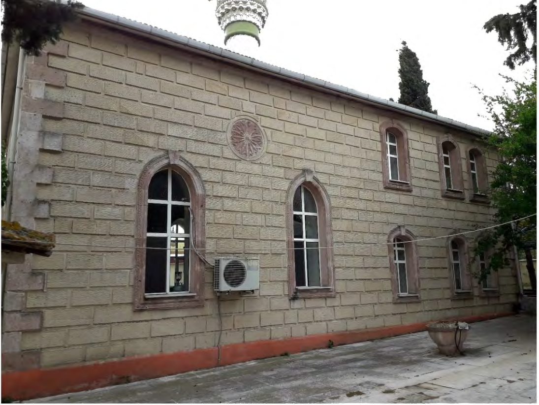
Fotoğraf 84: Tekirdağ Çorlu Şahpaz Mah. Camii Kuzeydoğu Cephe (2023)
