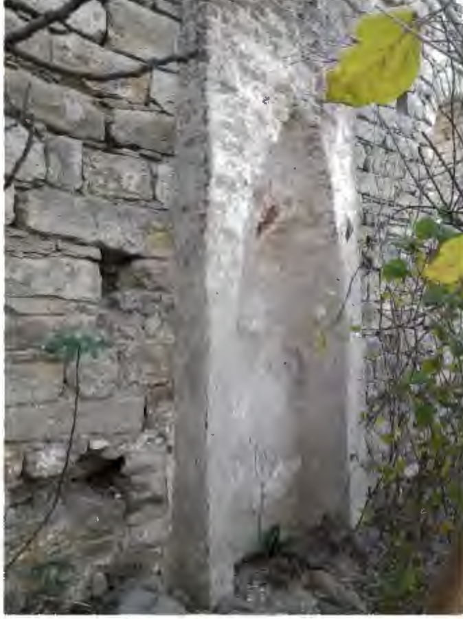
Fotoğraf 234: Malkara Şahin Mahallesi Kilisesi Güney Naos Duvarına Eklenen Mihrap (2022)
