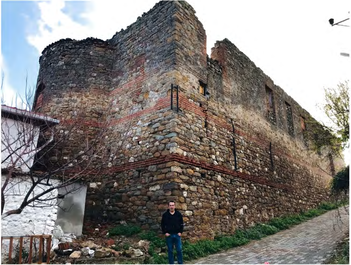
Fotoğraf 241: Şarköy Tepeköy Mahallesi Aziz Georgios Rum Kilisesi Genel Görünümü (2021)
