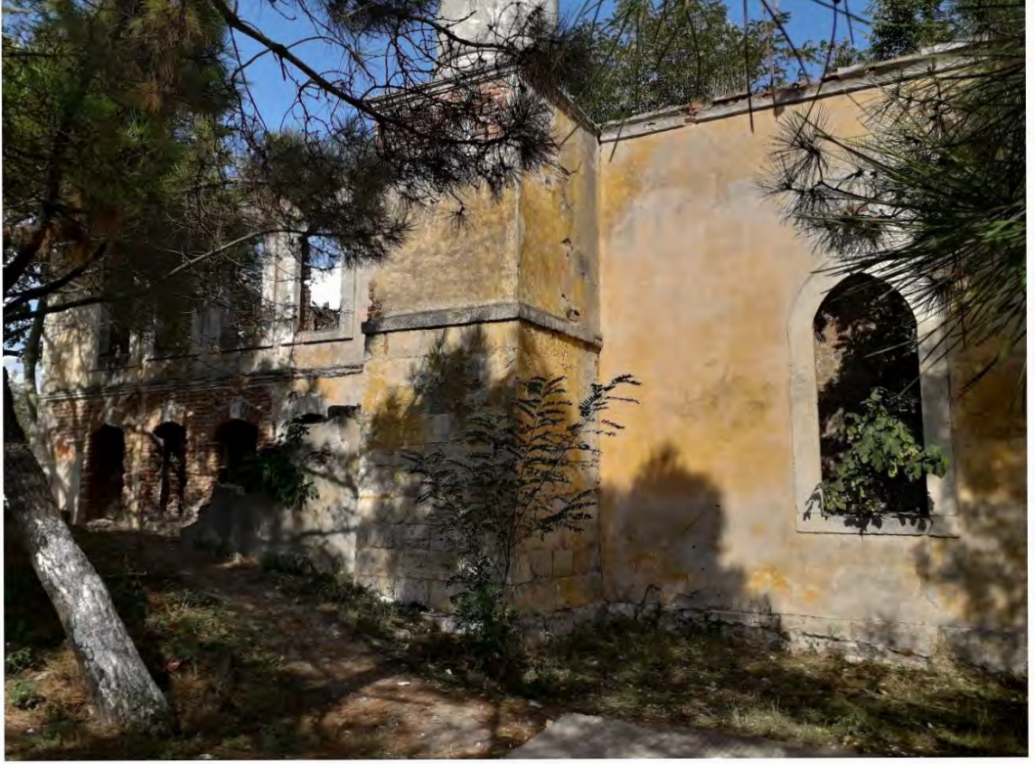
Fotoğraf 137: Tekirdağ Kapaklı Karaağaç Mah. Camii Güneybatı Cephe (2022)
