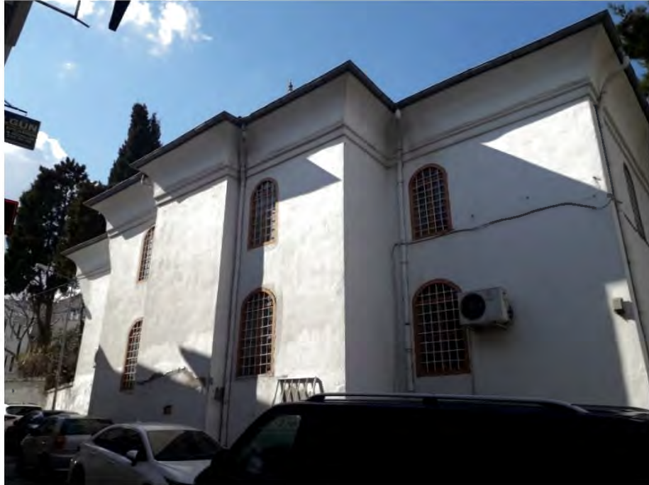
Fotoğraf 148: Tekirdağ Süleymanpaşa Eski Camii Güneydoğu Cephe (2022)
