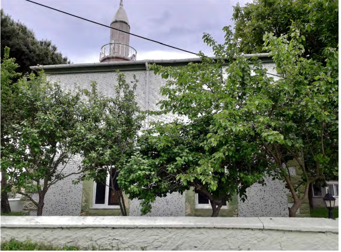
Fotoğraf 118: Tekirdağ Kapaklı Uzunhacı Mah. Camii Genel Güneydoğu Cephe (2022)
