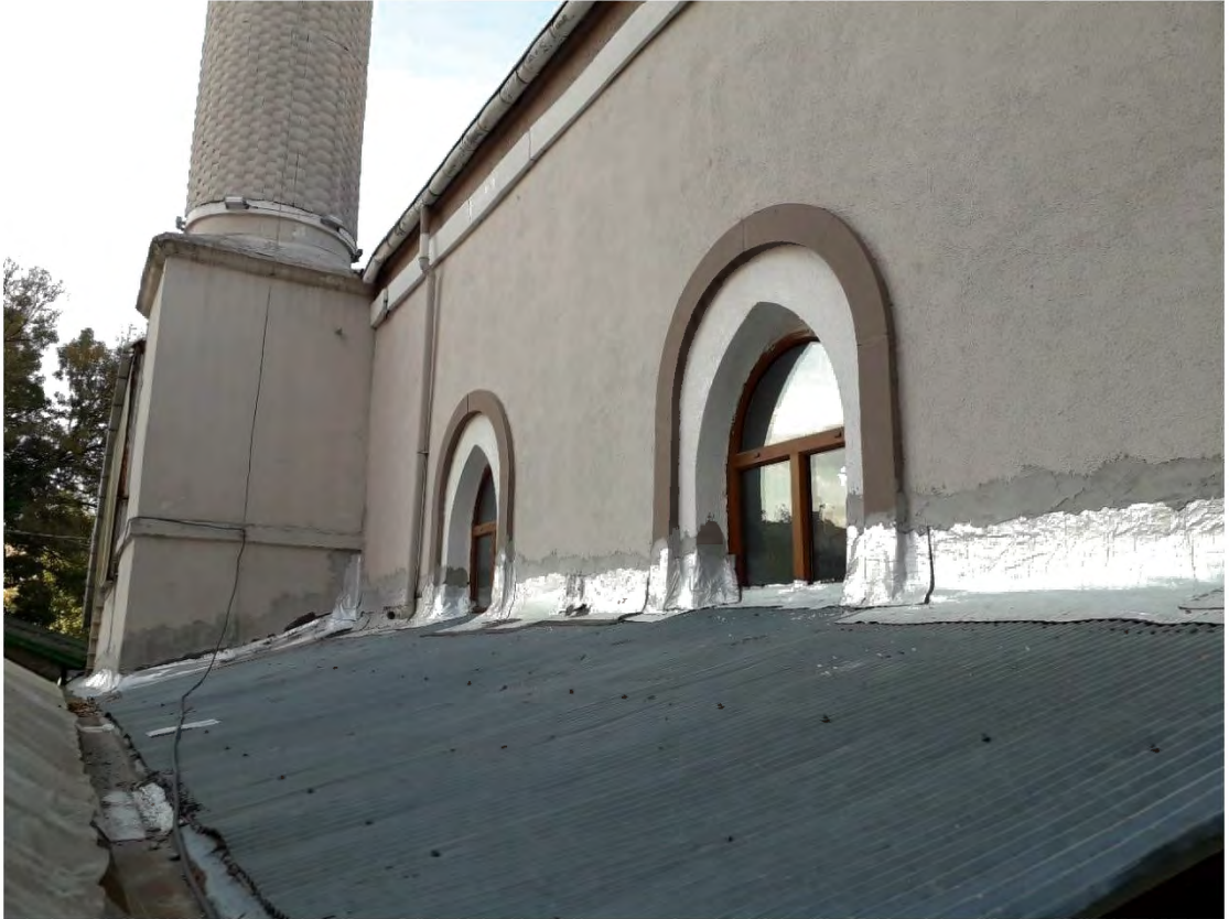
Fotoğraf 129: Tekirdağ Kapaklı Merkez Camii Güneybatı Cephe Pencereleri (2022)
