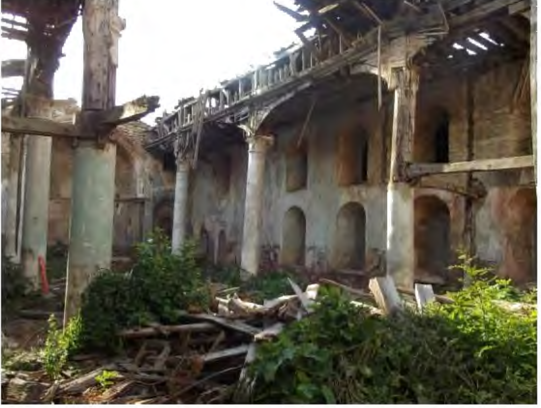
Fotoğraf 214: Tekirdağ Malkara Surp Toros Ermeni Kilisesi Neflerin Kuzeybatıdan Görünümü(Taksim Yapı)
