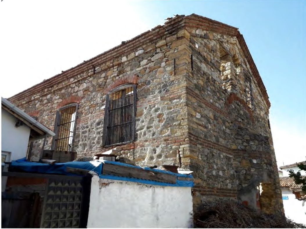
Fotoğraf 253: Şarköy Eriklice Mahallesi Aziz Theotokos Rum Kilisesinin Güneybatıdan Görünümü (2022)
