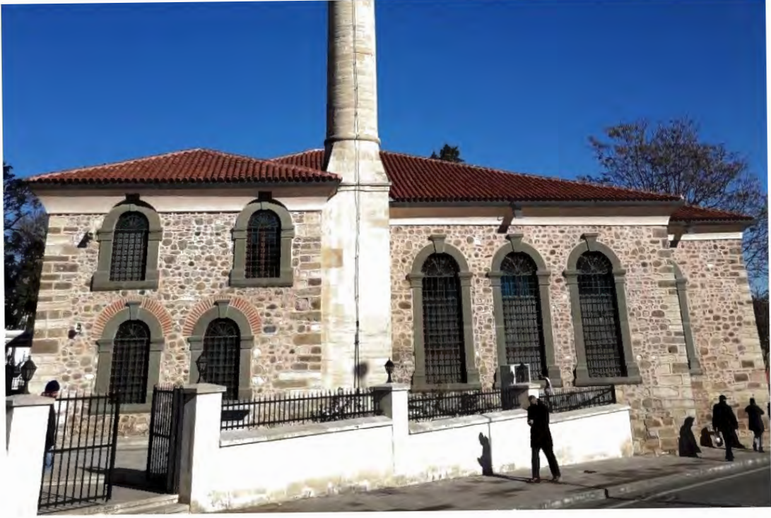
Fotoğraf 158: Tekirdağ Süleymanpaşa Orta Camii Güneybatı Cephe (2021)
