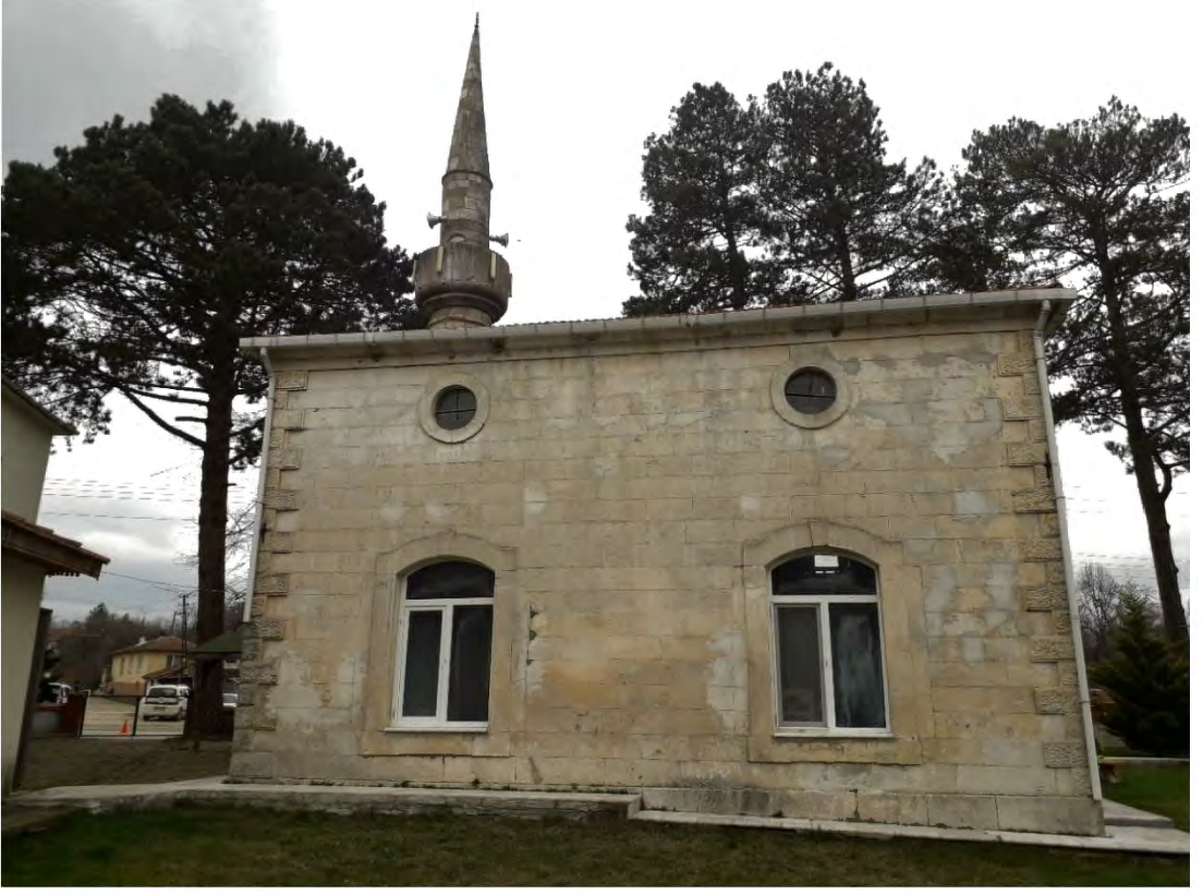
Fotoğraf 193: Tekirdağ Saray Bahçeköy Camii Güneydoğu Cephe (2023)
