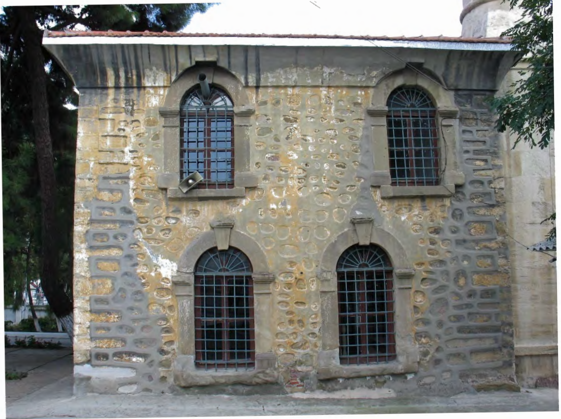
Fotoğraf 164: Tekirdağ Süleymanpaşa Orta Camii Güneybatı Cephesi (Son Cemaat Yeri), Restorasyon Öncesi (Ani Mimarlık)
