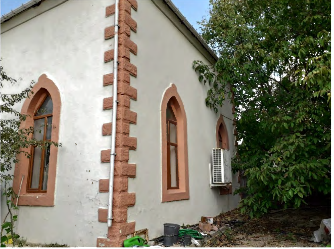
Fotoğraf 104: Tekirdağ Kapaklı Yanıkağıl Mah. Camii Güneydoğu Cephe (2022)
