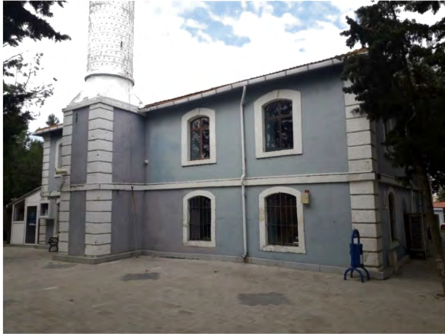
Fotoğraf 39: İstanbul Silivri Alipaşa Mah. Camii Genel Görünümü (2022)
