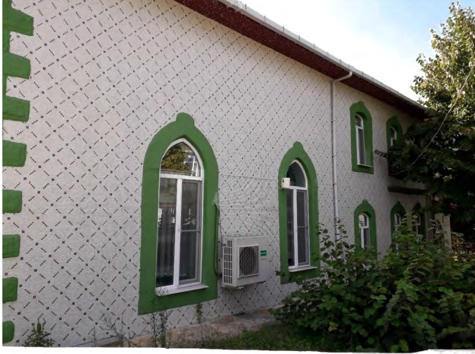
Fotoğraf 110: Tekirdağ Kapaklı Bahçeagül Mah. Camii Kuzeydoğu Cephe (2022)
