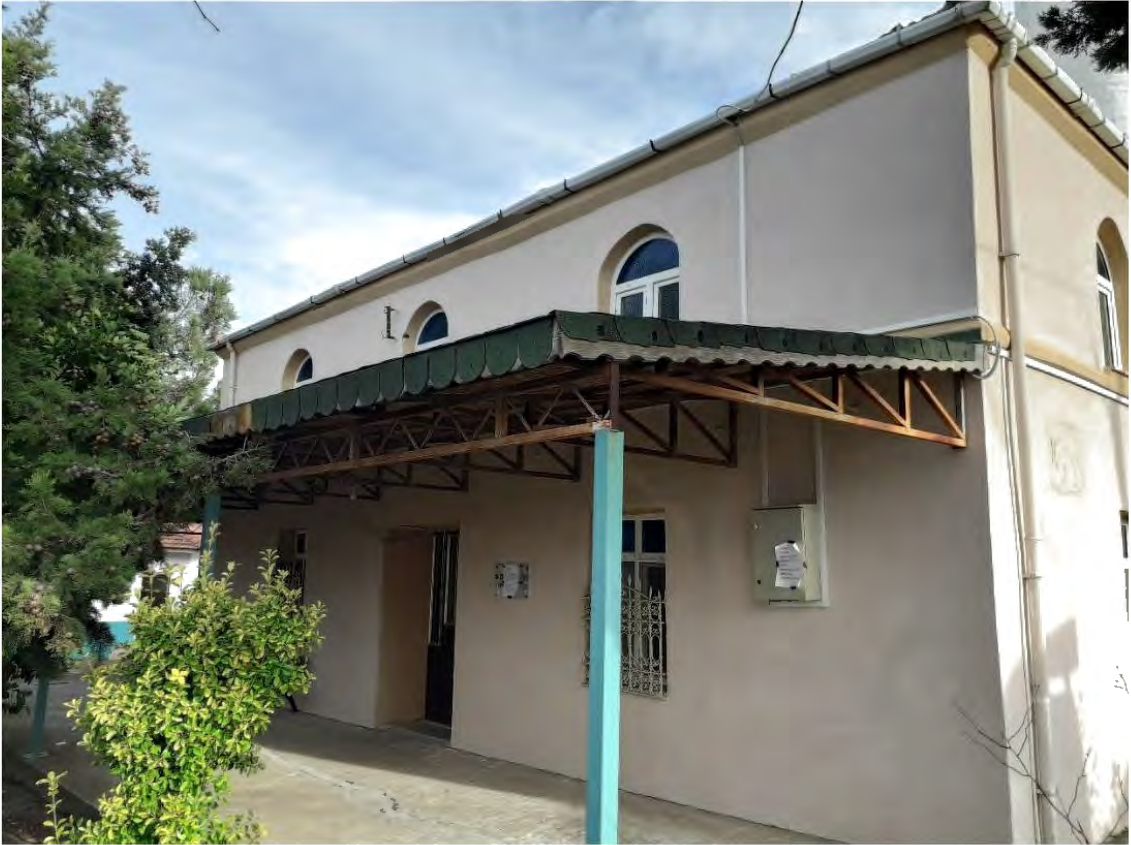
Fotoğraf 174: Tekirdağ Süleymanpaşa Kaşıkçı Mah. Camii Kuzeybatı Cephe (2023)
