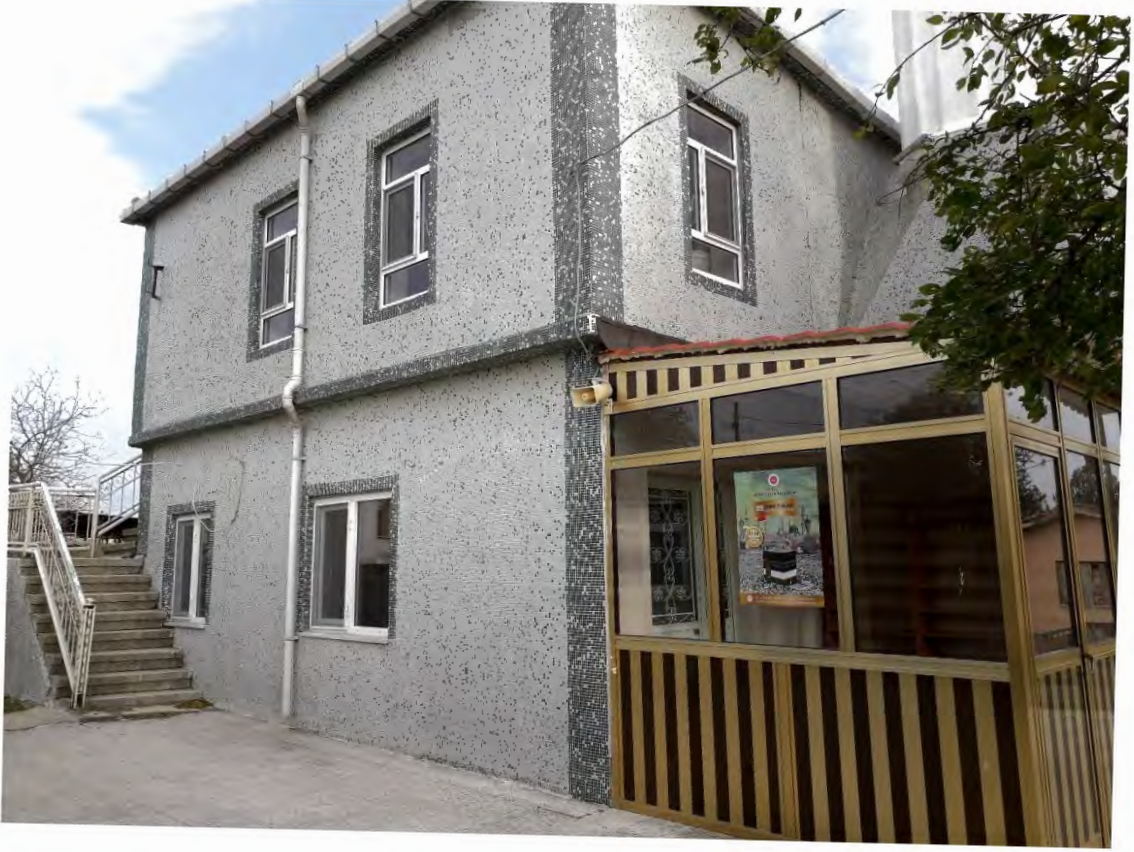
Fotoğraf 48: Tekirdağ Malkara Yörücek Mah. Camii Kuzeybatı Cephesi (2022)
