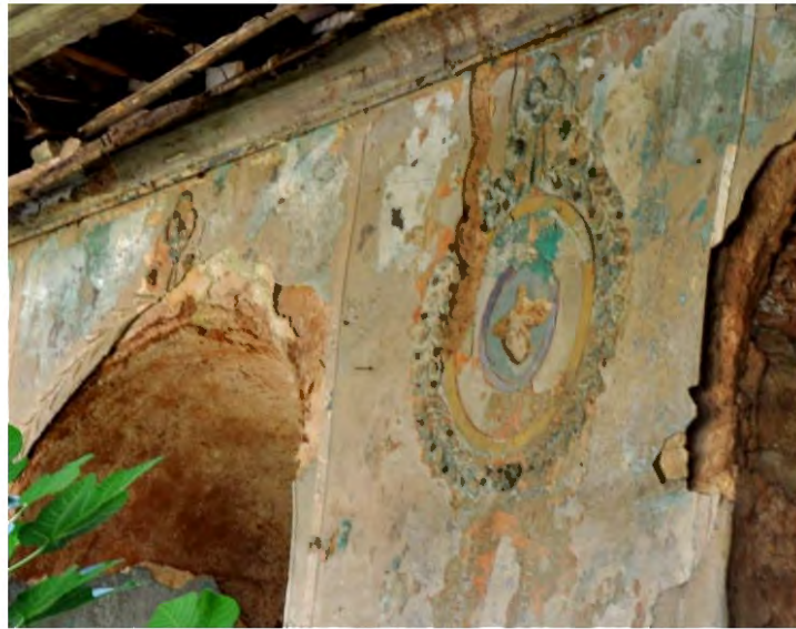
Fotoğraf 225: Tekirdağ Malkara Surp Toros Ermeni Kilisesi Güney Duvarı Bezemeleri Detay (Taksim Yapı)
