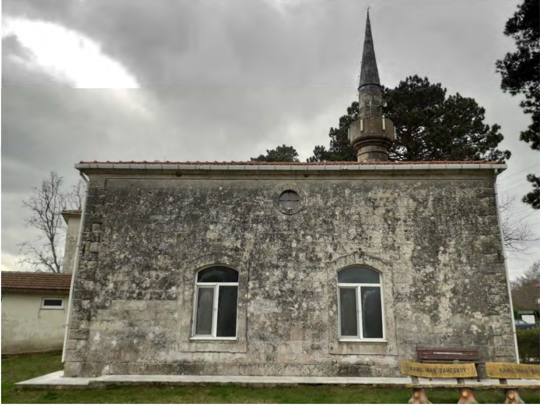
Fotoğraf 192: Tekirdağ Saray Bahçeköy Camii Kuzeydoğu Cephe (2023)
