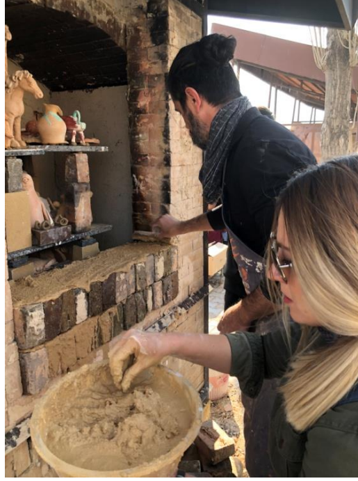
Görsel 2.36. Fırın Doldurma Kapısının Örülme Aşaması
