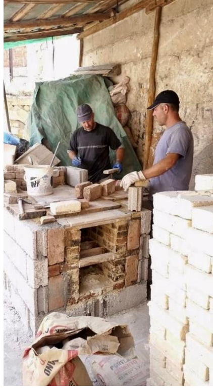
Görsel 2.54. Levent, Mehmet Düzgün ve Odun Yakıtlı Fırın İnşası (Mehmet Düzgün Kişisel Arşiv)
