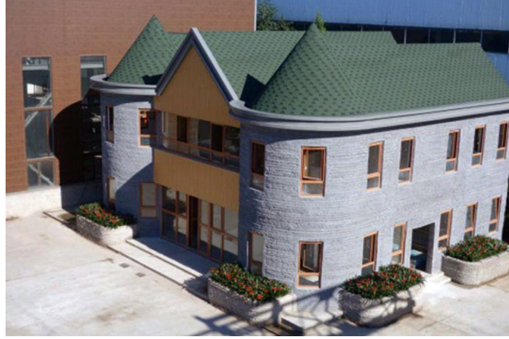
Görsel 2.16. Dünyada üç boyutlu yazıcı teknolojisi ile yapılmış ilk ev, 400 m 2 Huashang Tengda firması Kaynak: https://all3dp.com/1/3d-printed-house-homes-buildings-3d-printing-construction/
