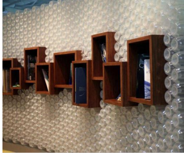
Görsel 3.2.4. Polli-Brick sistemi iç mekan yüzey uygulaması,
