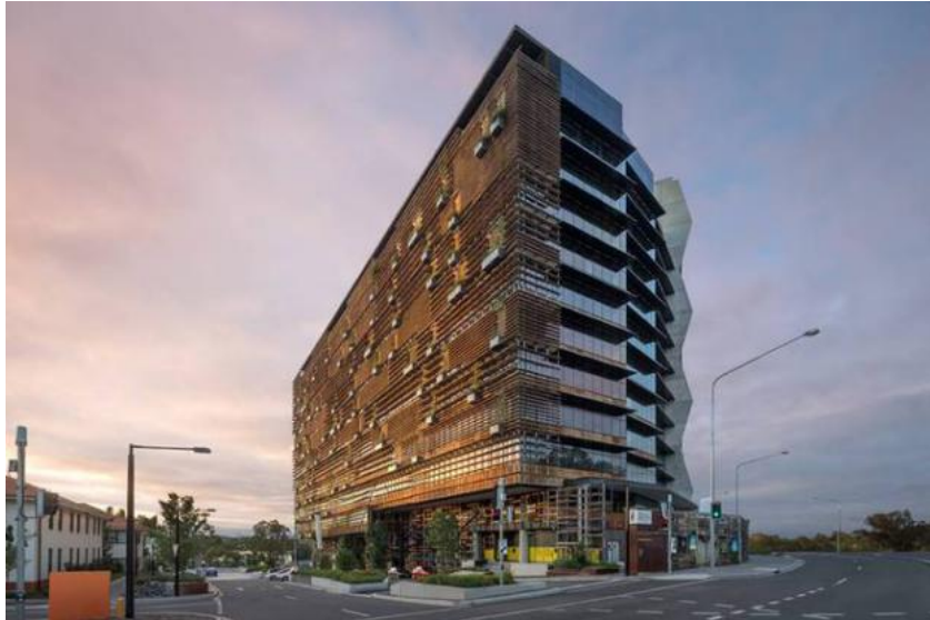
Görsel 3.5.11. Nishi & Hotel Hotel dış cephe görünüşü,
