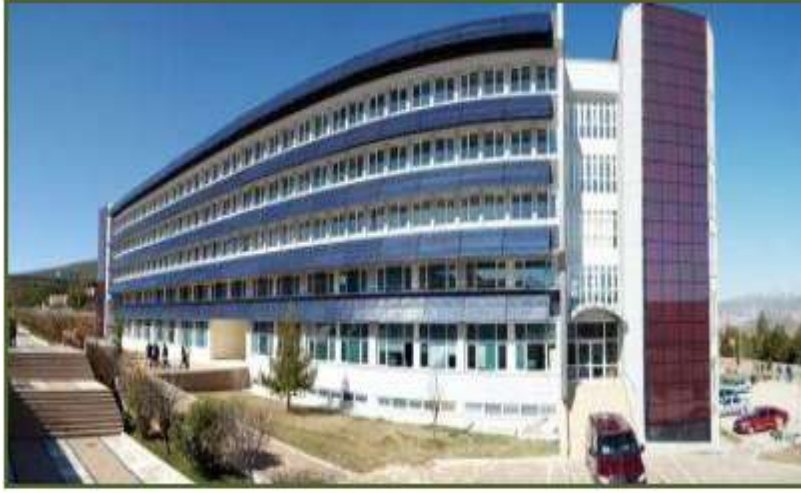
Şekil 4.10. Muğla Üniversitesi Rektörlük binasına entegre fotovoltaik sistem [36]
