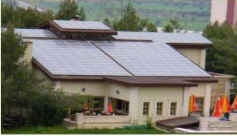
Şekil 4.8. Muğla Üniversitesi kafeterya çatısında fotovoltaiik sistem [36]
