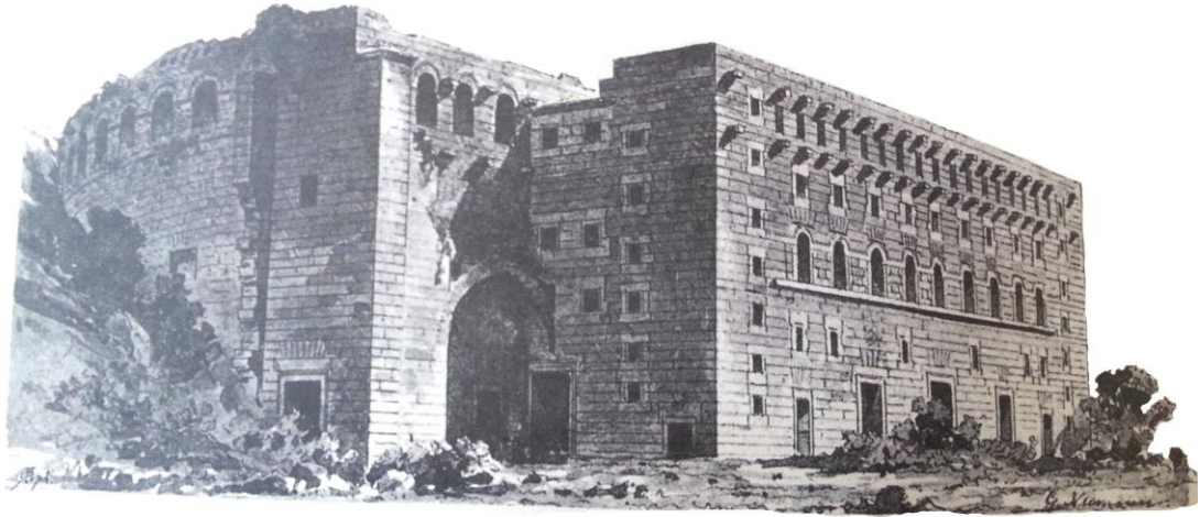
Resim 5: Aspendos Tiyatrosu Sahne Binası'nın Arkasındaki Konsollar.
