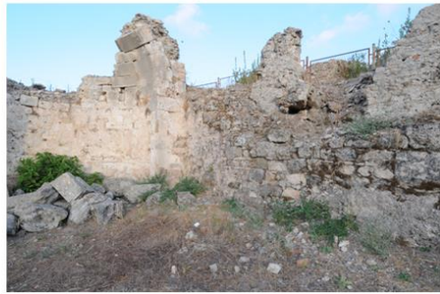
Resim 29: Agora'nın Doğu Duvarında Görülen Diletasyonlar ve Malzeme Farklılığı.
