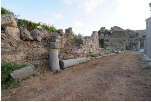
Resim 29: Agora'nın Doğu Duvarında Görülen Diletasyonlar ve Malzeme Farklılığı.
