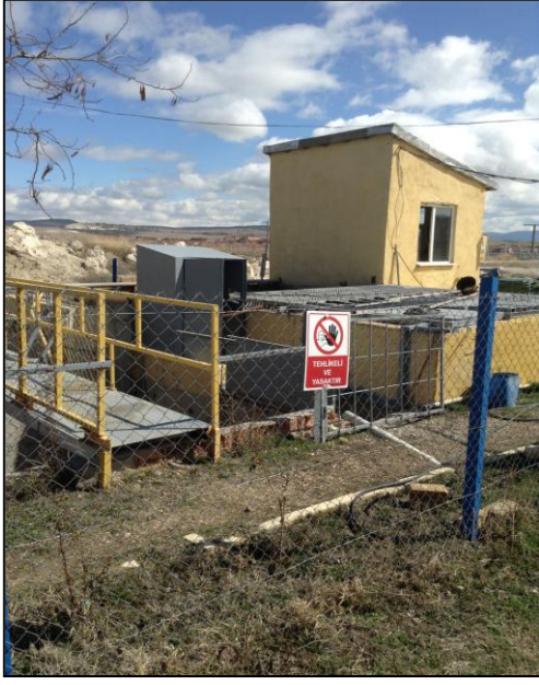
b. Evsel atık su arıtma tesisi
