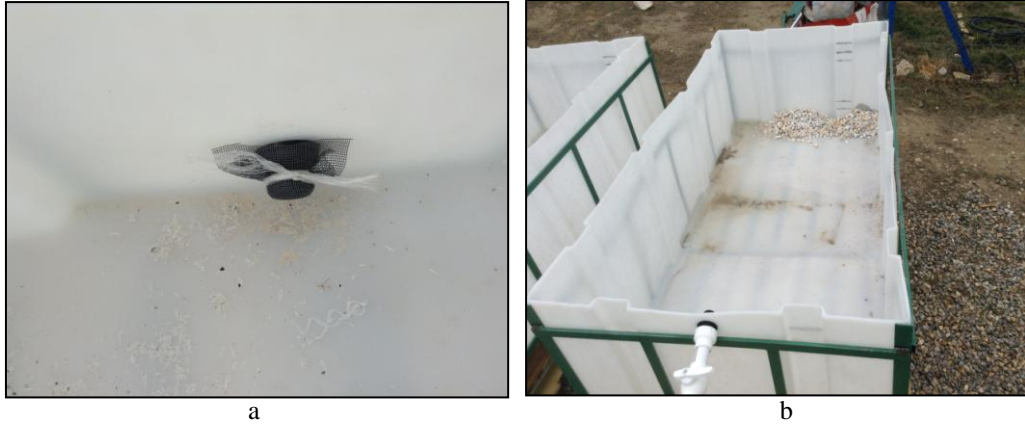
Şekil 2.7. Yapay sulak alanların giriş ve çıkış bölümlerinde sineklik ve çakıl taşlarının yerleştirilmesi
