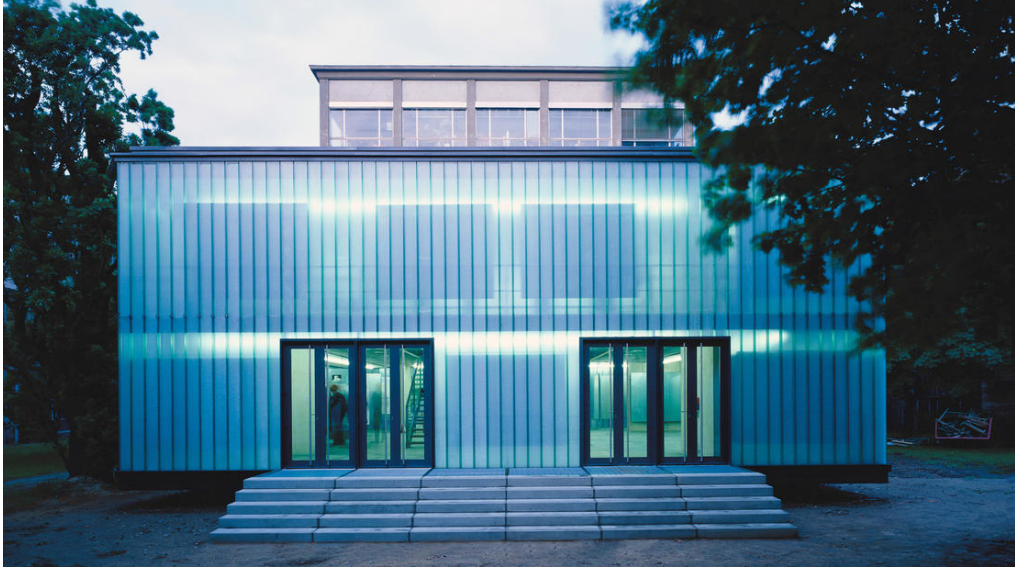
Görsel 2.3. Cam profiller kullanılarak oluşturulmuş Braunschweig Teknik Üniversitesi sergi köşkü, Braunschweig, Almanya
