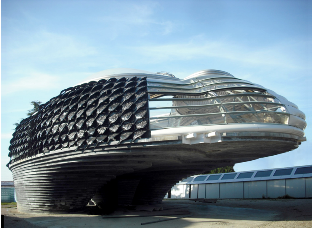
Görsel 2.28. Villa Nurbs cephe görüntüsü,2009,İspanya
