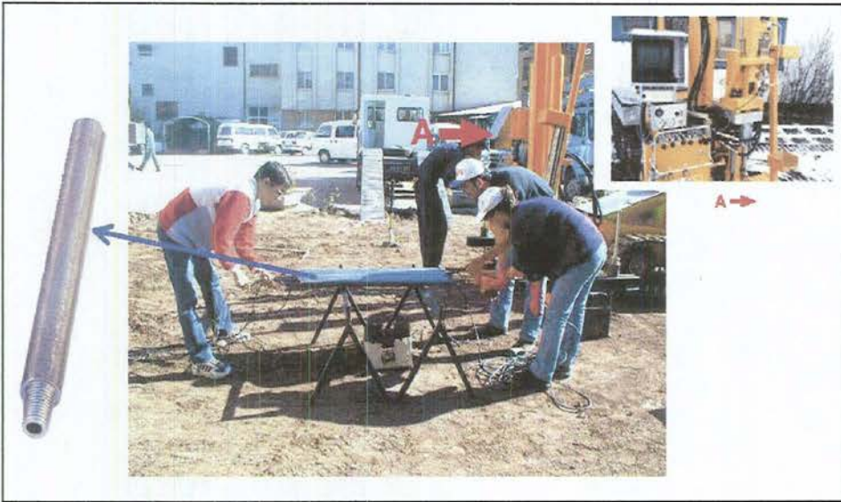
Şekil 4.11. Sismik kablosunun hazırlanması ve işlem kontrol ekranı
