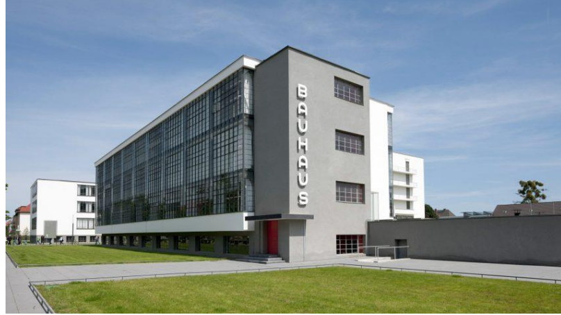
Görsel 1.9. Bauhaus Dessau Binası
