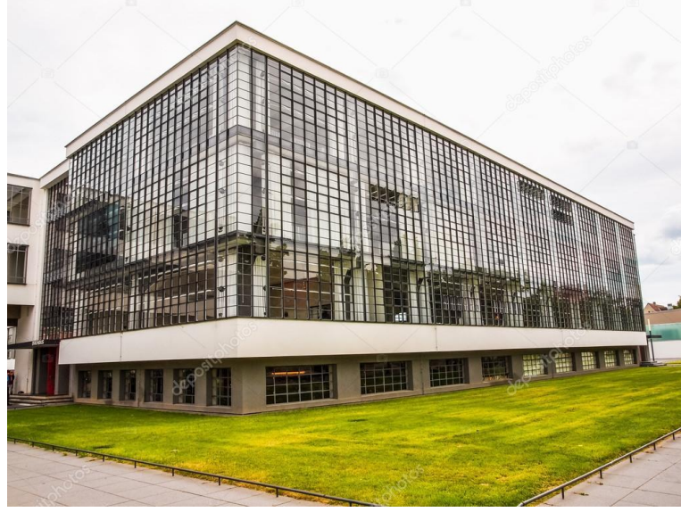
Görsel 2.11. Bauhaus Dessau Binası
