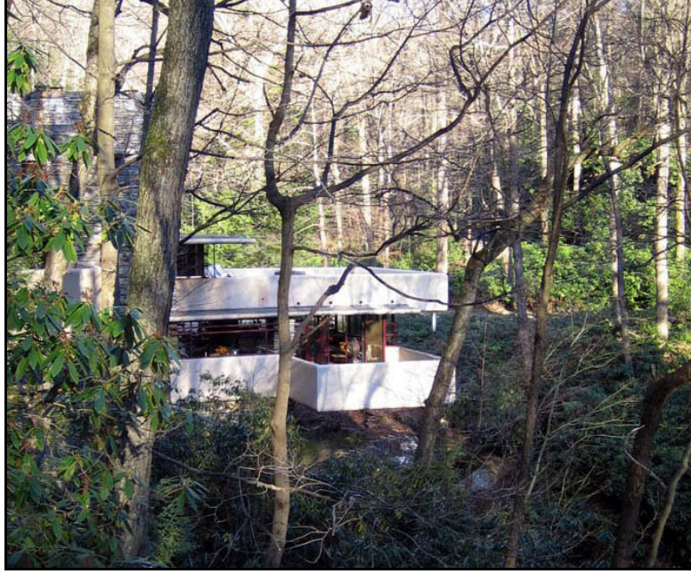
Şekil 5.8. Şelale Evi, Binanın çevresi ile uyumu (URL-8)
