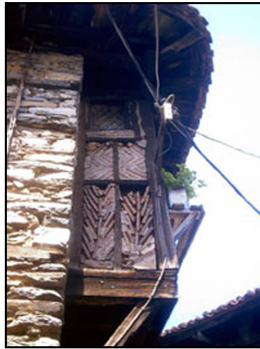
Şekil 4.21. Cumalıkızık Evleri Yapım Tekniği (URL-14)
