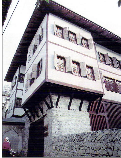
Şekil 4.17. Safranbolu Evleri ahşap çatkı yöntemi (Bektaş, 2007)
