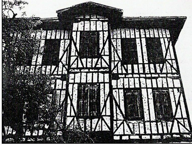
Şekil 4.18. Safranbolu Evleri ahşap çatki yöntemi (Günay, 1994)
