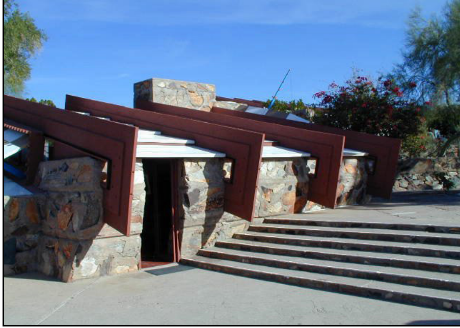
Şekil 3.50. Taliesin West, Çatı aralarında branda kullanımı (URL-6)
