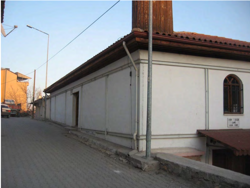
Fot. 567 Amasya Merzifon ilçesi Eyüp Çelebi Camii kuzey cephesinden genel görünüm
