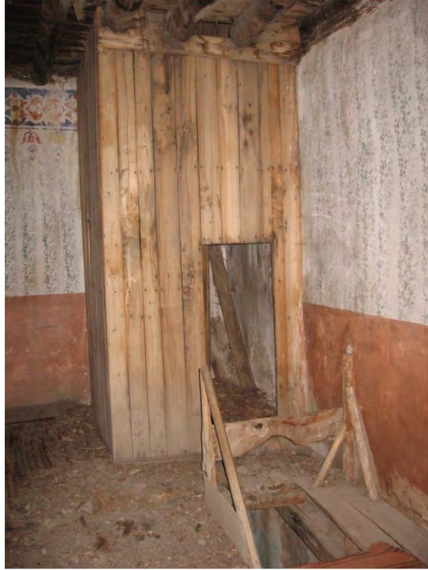
Fot. 86 Amasya merkez ilçe Kaleköy Camii minareye çıkışı sağlayan merdiven
