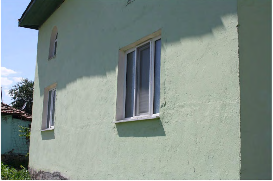
Fot. 230 Amasya merkez ilçe Dadı Köyü Camii güney cephesinden genel görünüm
