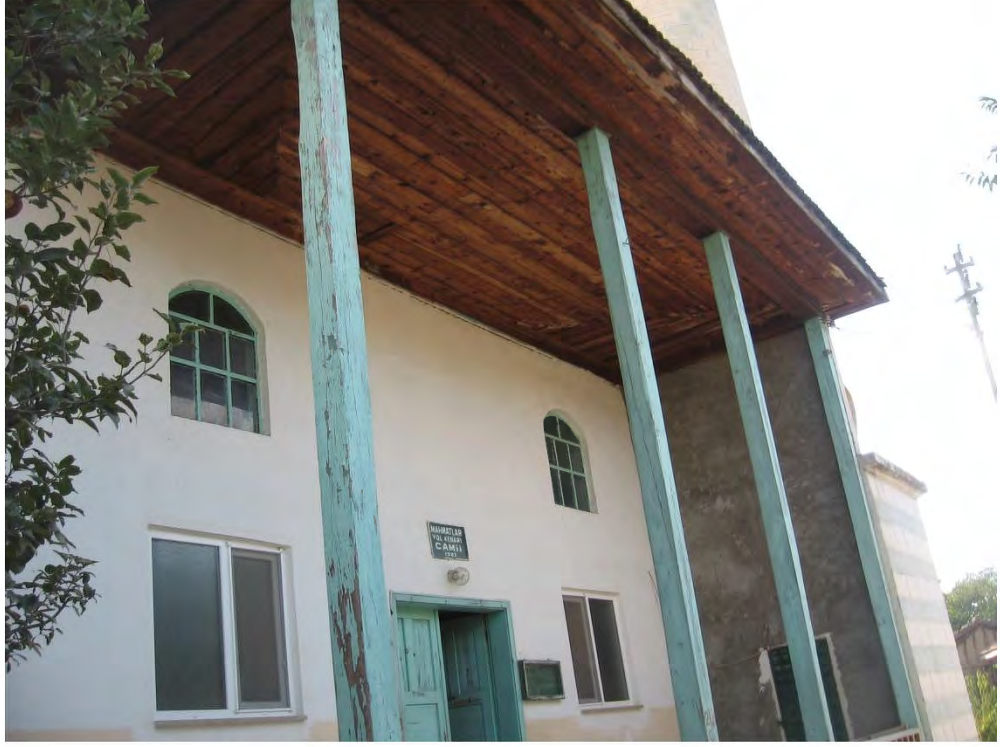
Fot. 240 Amasya merkeze bağı Mahmatlar Köyü Yol Kenarı Camii kuzey cephesinden genel görünüm
