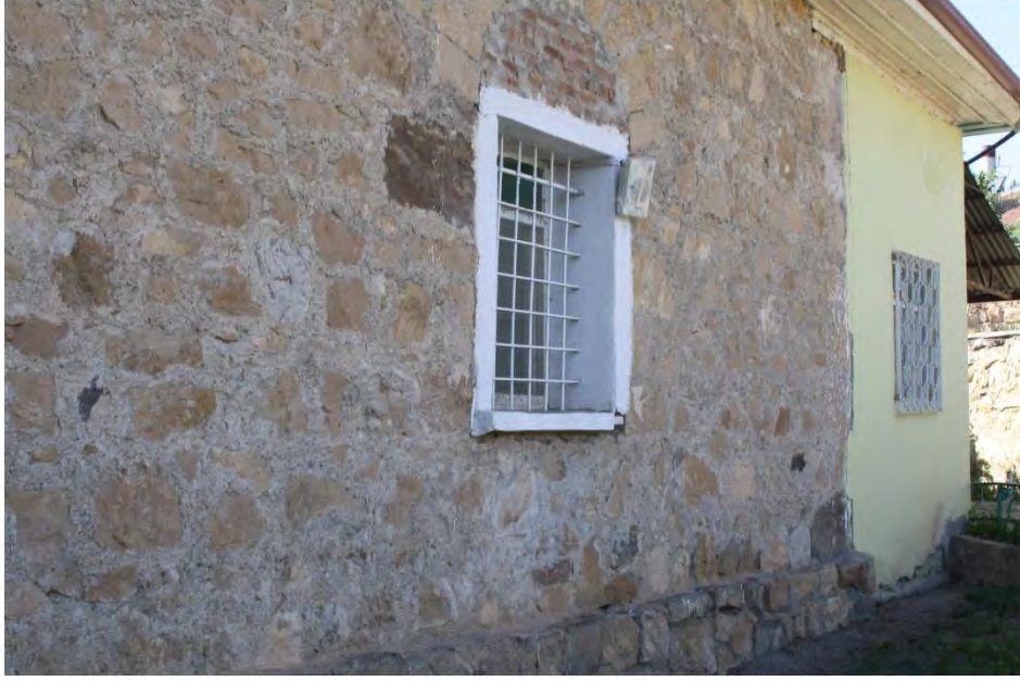
Fot. 326 Amasya merkez ilçe Yıldızköy Camii doğu cephesinden görünüm
