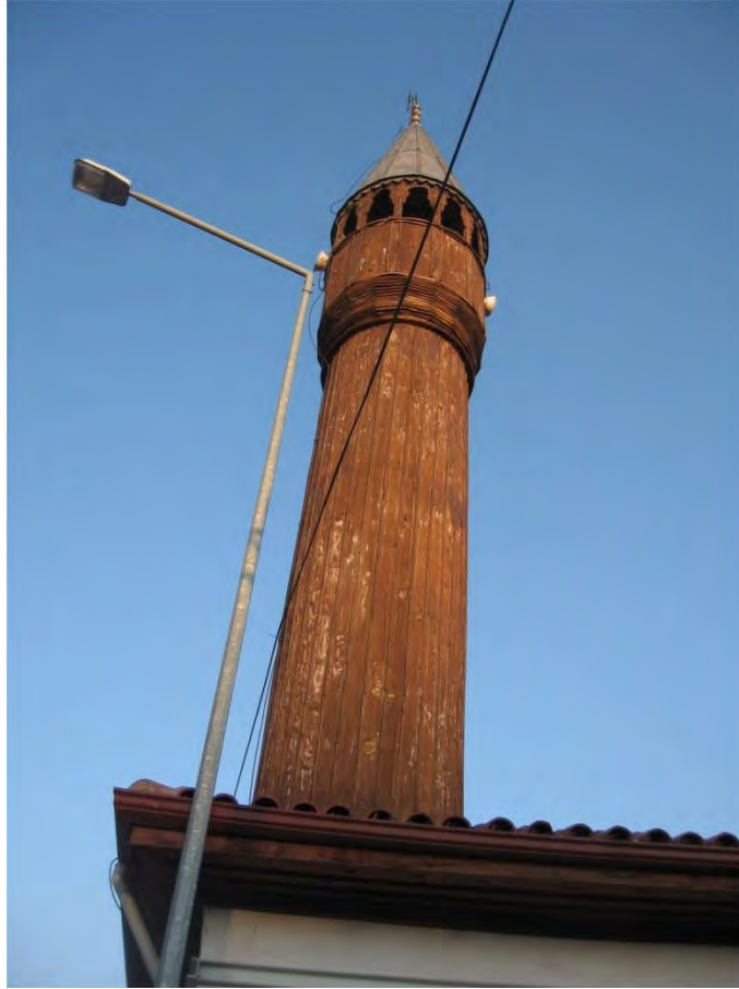
Fot. 563 Amasya Merzifon ilçesi Eyüp Çelebi Camii minaresi
