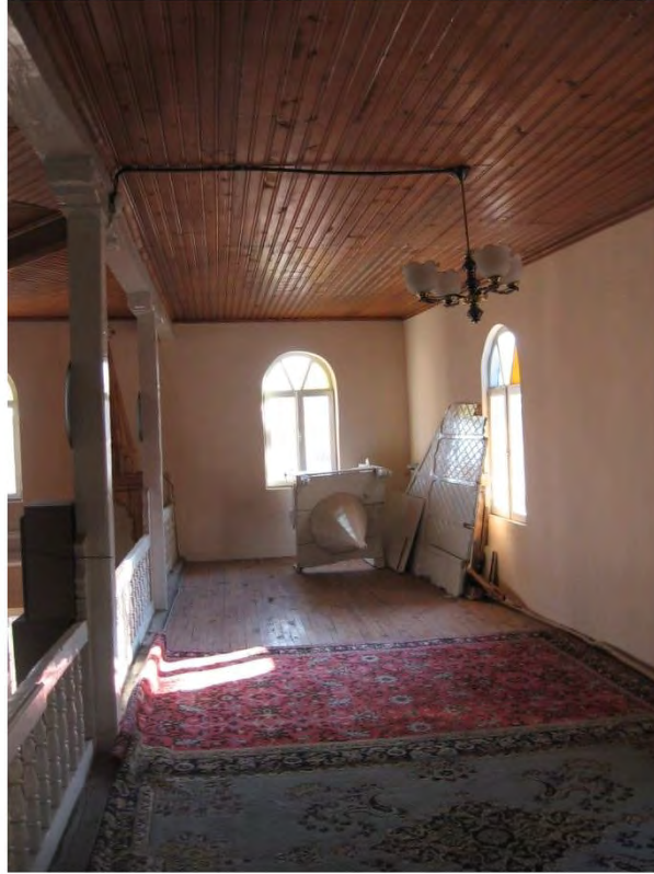
Fot. 269 Amasya Merzifon ilçesi Hanife Hatun Camii mahfilin kirişlemesi alttan kaplamalı tavanı
