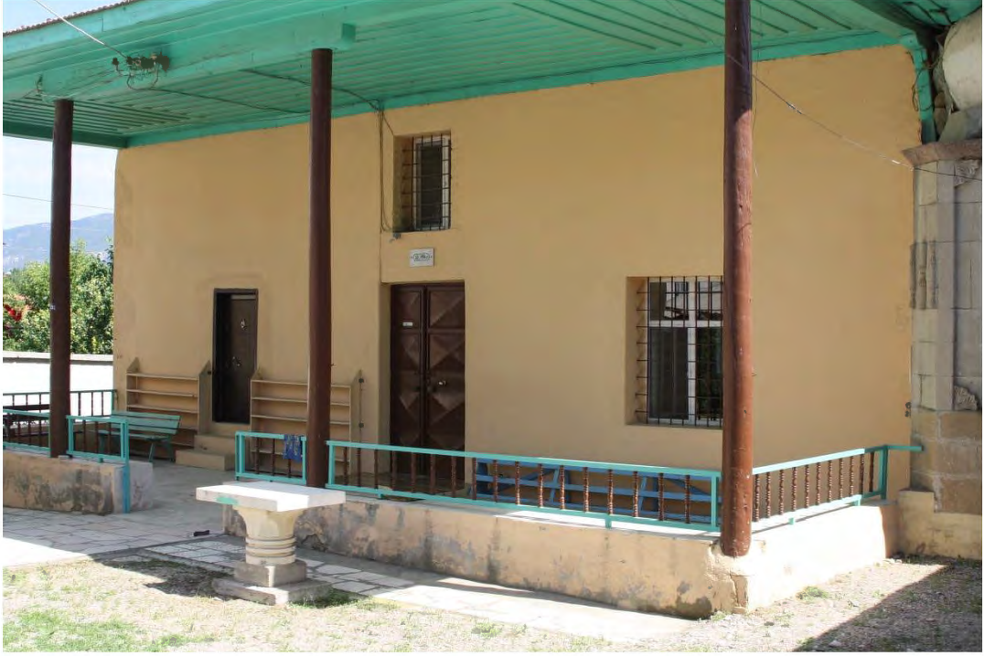
Fot. 315 Amasya merkez Kayabaşı Mahallesi Camii son cemaat yerinden görünüm
