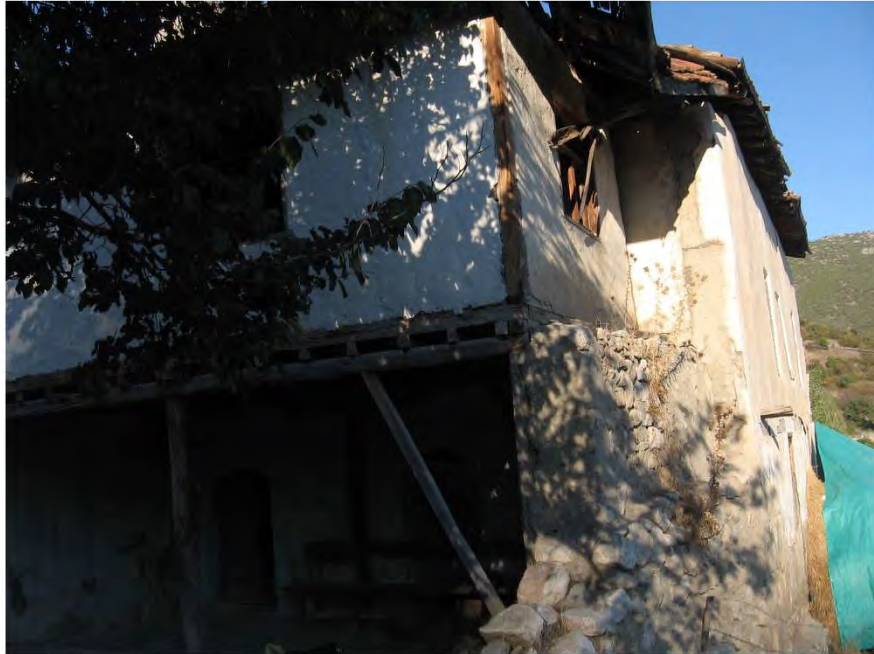
Fot. 72 Amasya merkez ilçe Kaleköy Camii son cemaat yerinin güneybatı köşesinden görünüm
