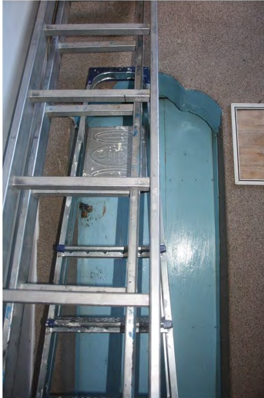
Fot. 399 Amasya Taşova ilçesi Yukarı Baraklı Camii minareye çıkışı sağlayan kapı açıklığı
