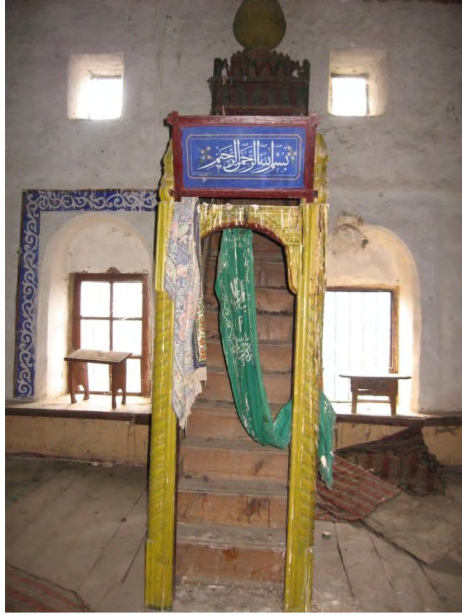
Fot. 159 Amasya merkez ilçe Kızılkışlacık Köyü Camii minber kapısı
