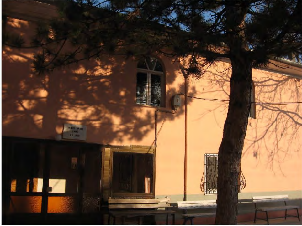
Fot. 260 Amasya Merzifon ilçesi Hanife Hatun Camii batı cephesinden görünüm
