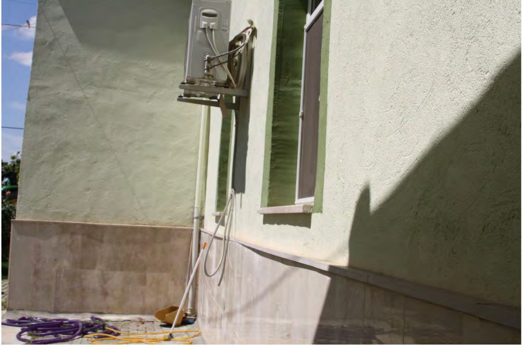
Fot. 185 Amasya merkez ilçe Belmebük Köyü Camii batı cephesinden görünüm
