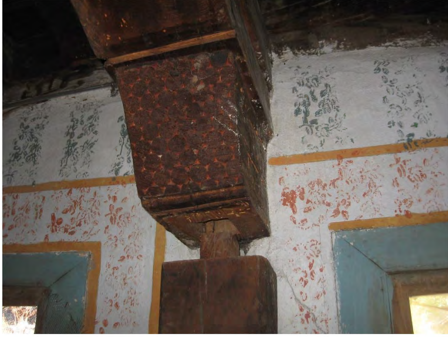
Fot. 85 Amasya merkez ilçe Kaleköy Camii kuzey duvarındaki desteklerden birinin başlığı
