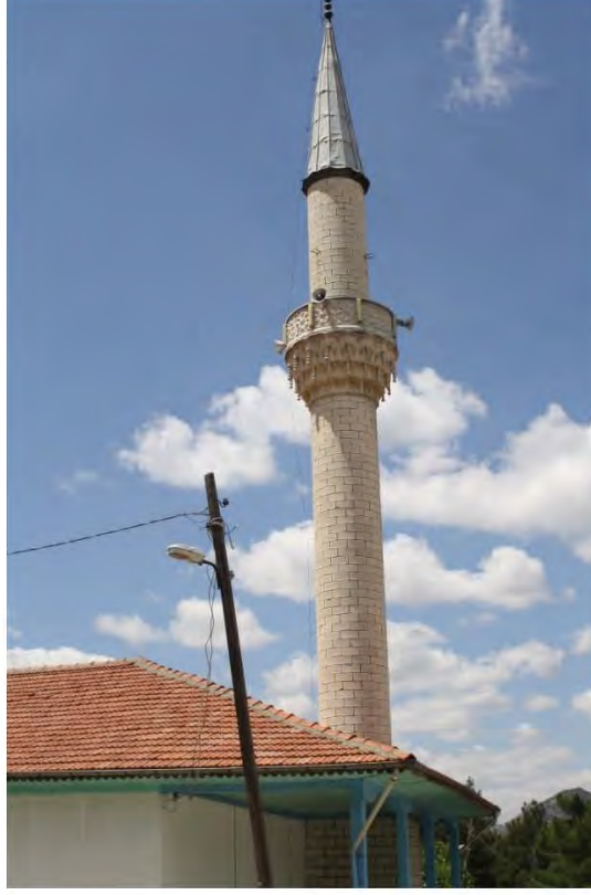
Fot. 218 Amasya merkez ilçe Sarılar Köyü Camii minaresinden genel görünüm
