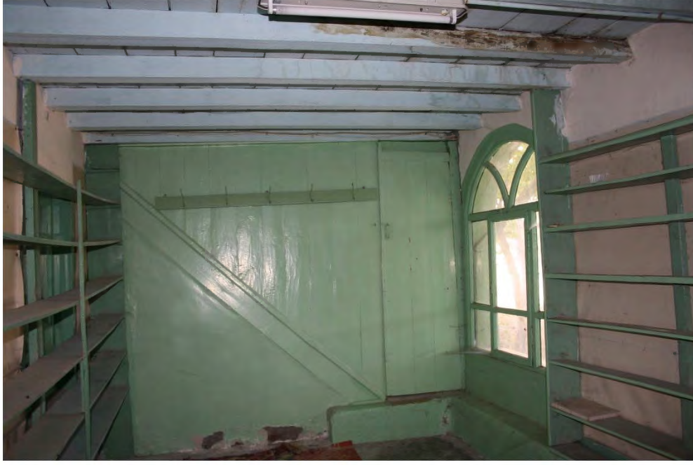
Fot. 278 Amasya Merzifon ilçesi Ortaova Köyü Camii son cemaat yerinin kirişlemesi üstten kaplamalı tavanı
