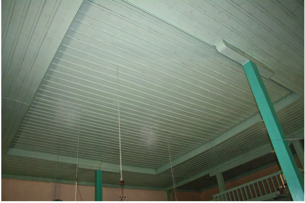
Fot. 322 Amasya merkez Kayabaşı Mahallesi Camii tavanından görünüm
