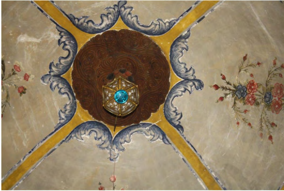
Fot. 429 Amasya Taşova ilçesi Yukarı Baraklı Camii tavan göbeği
