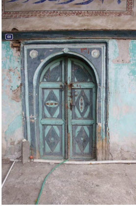
Fot. 436 Amasya Göynücek ilçesi Şıhlar Köyü Camii kuzey cephedeki kapı açıklığı
