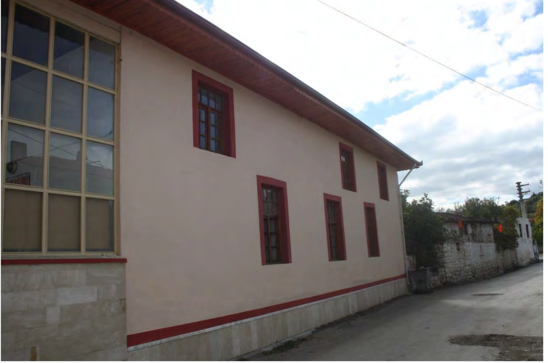
Fot. 197 Amasya merkez ilçe Aydınca Köyü Camii batı cepheden genel görünüm
