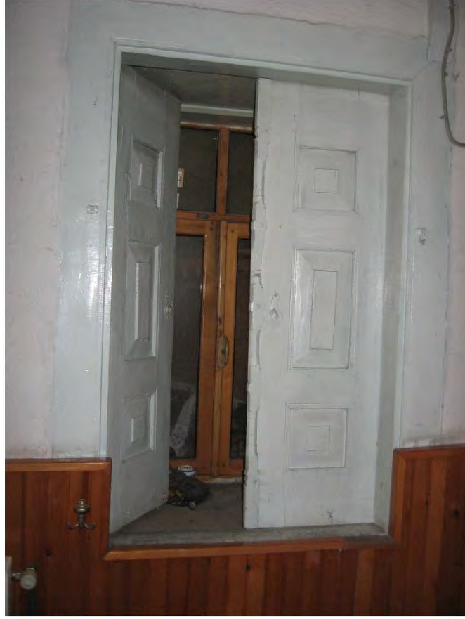
Fot. 137 Amasya merkez Üçler Camii doğu duvarındaki odunluğa bakan pencere
