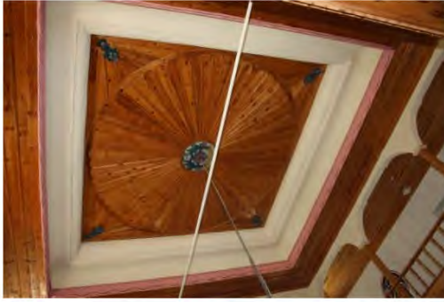
Fot. 682 Merkez ilçe Akyazı Köyü Camii tavanından genel görünüm
