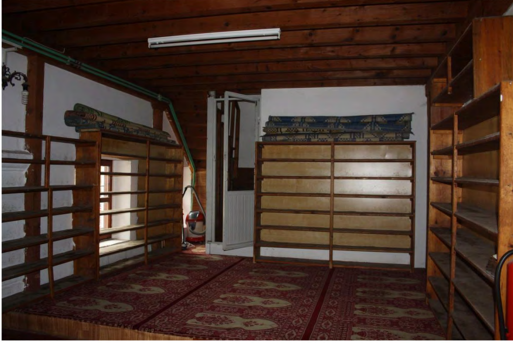
Fot. 31 Amasya Merzifon ilçesi Sultan II. Murad Camii son cemaat yerinin tavanından görünüm
