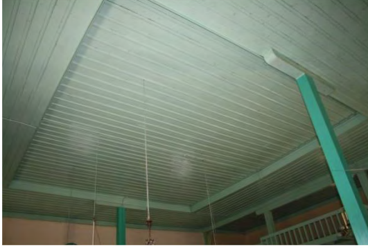
Fot. 641 Merkez Kayabaşı Mahallesi Camii tavanından genel görünüm
