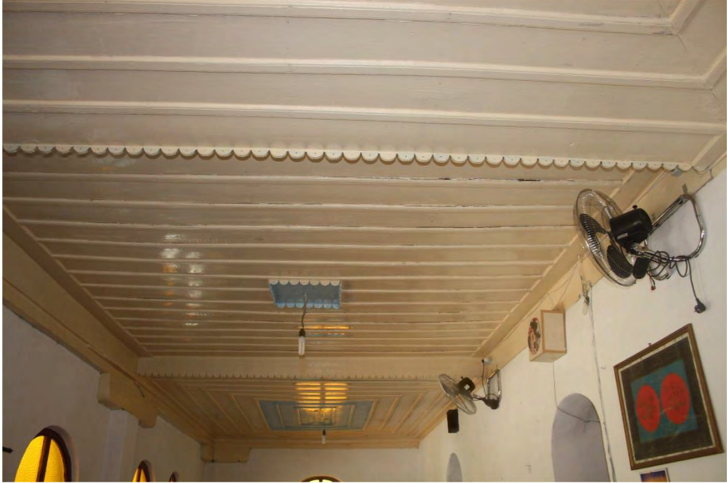
Fot. 361 Amasya merkez Karasenir Mahallesi Camii mahfilin güneyindeki bölümün tavanından görünüm
