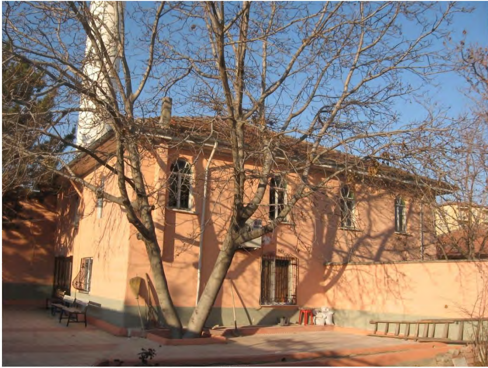
Fot. 261 Amasya Merzifon ilçesi Hanife Hatun Camii güney cephesinden genel görünüm
