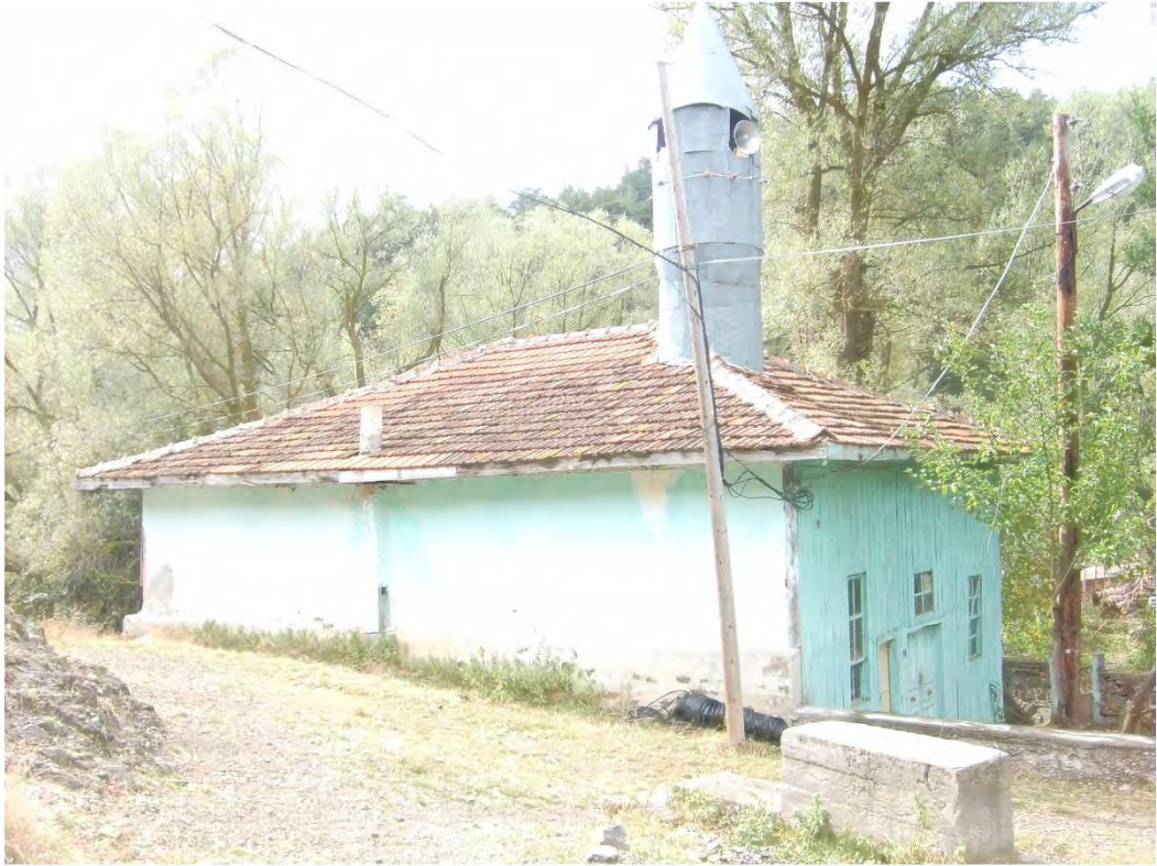
Fot. 389 Amasya merkez ilçe Karakise Köyü Camii doğu cephesinden genel görünüm
