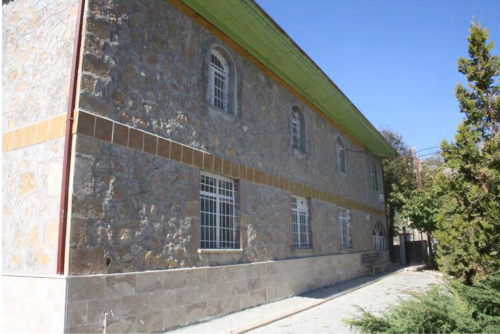
Fot. 353 Amasya merkez Karasenir Mahallesi Camii doğu cephesinden görünüm
