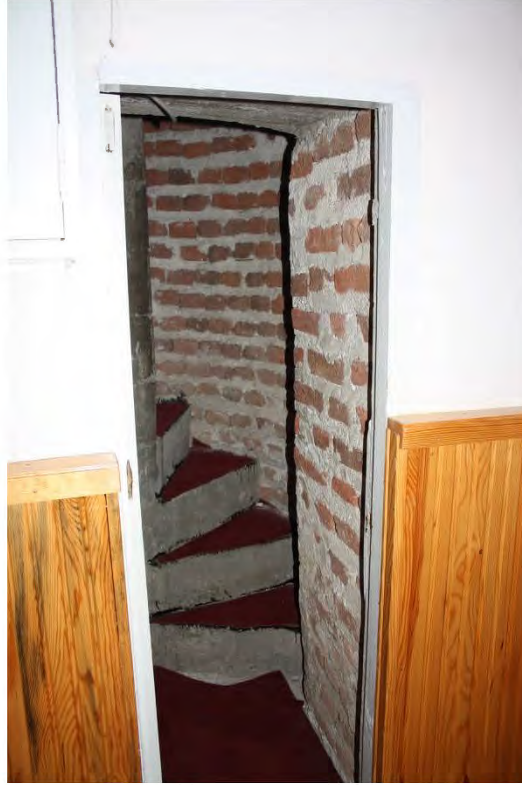
Fot. 347 Amasya Merzifon ilçesi Yeşilören Köyü Camii mahfile ve minareye çıkışı sağlayan merdiven
