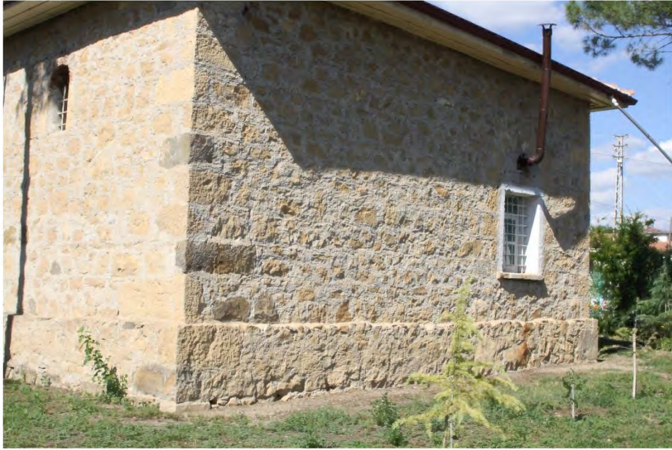
Fot. 327 Amasya merkez ilçe Yıldızköy Camii güney cephesinden görünüm
