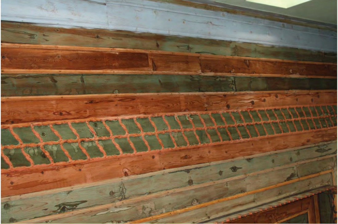
Fot. 519 Amasya merkez ilçe Büyük Kızılca Köyü İstasyon Camii bindirme tavanının dışında kalan yan kısımlar
