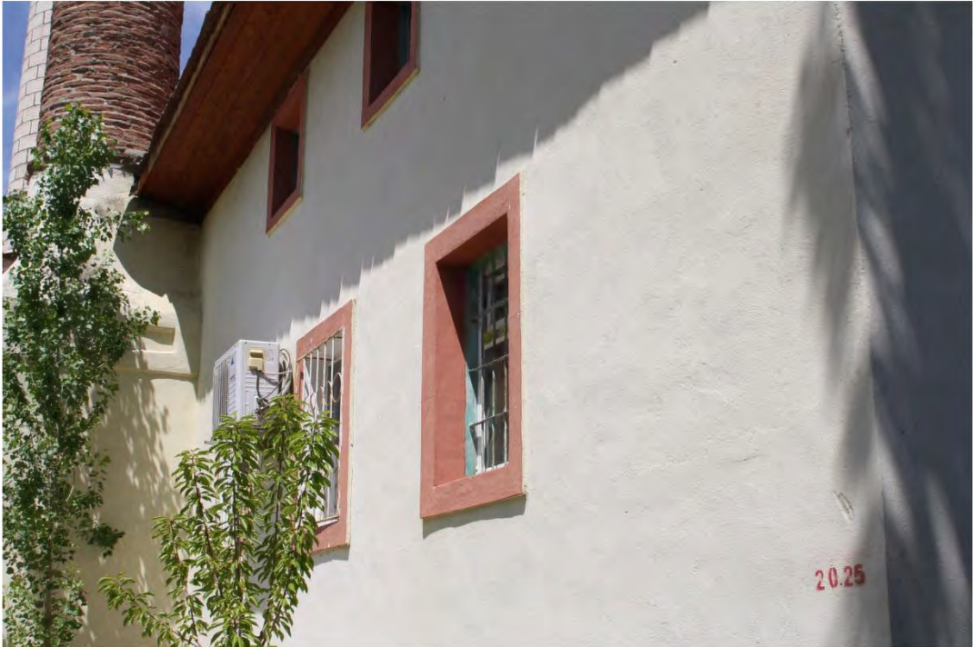
Fot. 504 Amasya merkez ilçe Büyük Kızılca Köyü İstasyon Camii batı cephesinden görünüm
