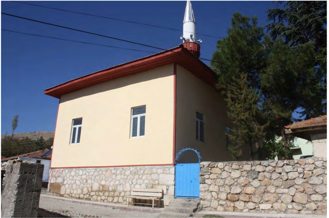
Fot. 287 Amasya Merzifon ilçesi Ortaova Köyü Camii güney cephesinden genel görünüm
