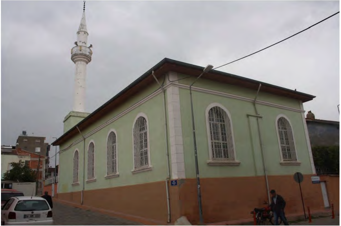
Fot. 544 Amasya Merzifon ilçesi Büyük Hacı Hasan Camii güney ve batı cephelerden görünüm
