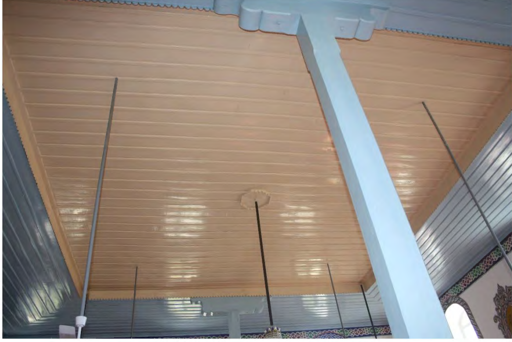
Fot. 364 Amasya merkez Karasenir Mahallesi Camii tavanından görünüm
