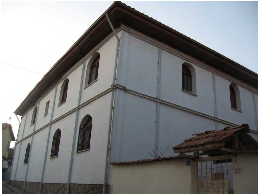
Fot. 565 Amasya Merzifon ilçesi Eyüp Çelebi Camii güney cephesinden genel görünüm
