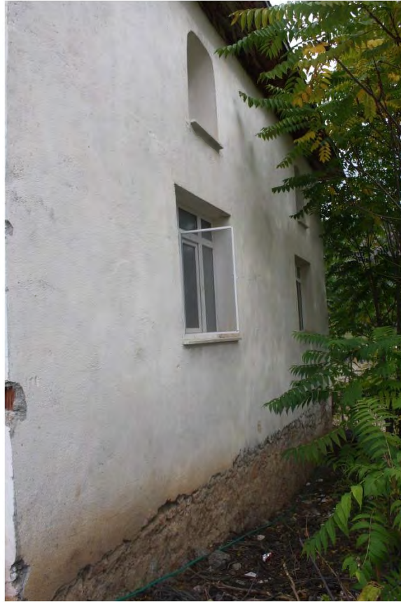
Fot. 251 Amasya merkeze bağı Kavaklıağıl Mezrası Camii güney cephesinden genel görünüm
