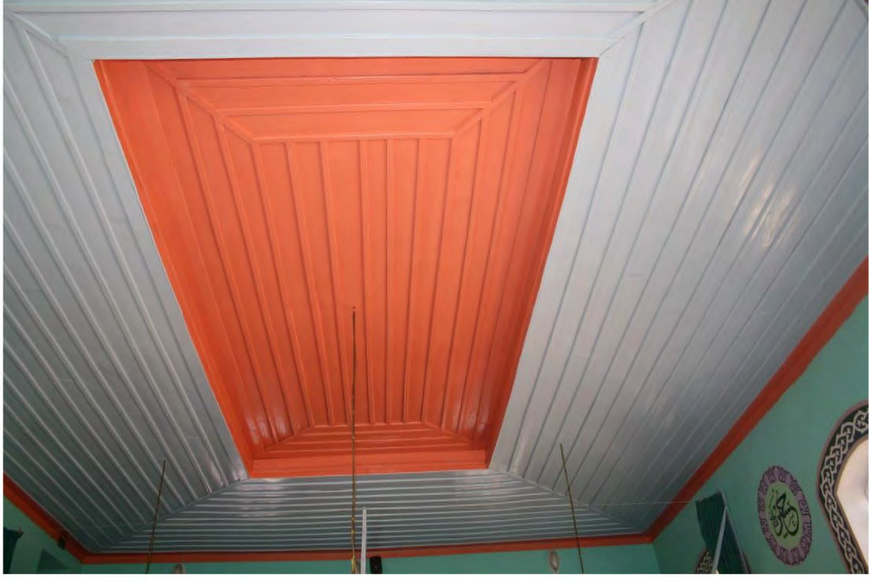
Fot. 374 Amasya merkez Karasenir Mahallesi Serçoban Tamlar Camii tavanından görünüm
