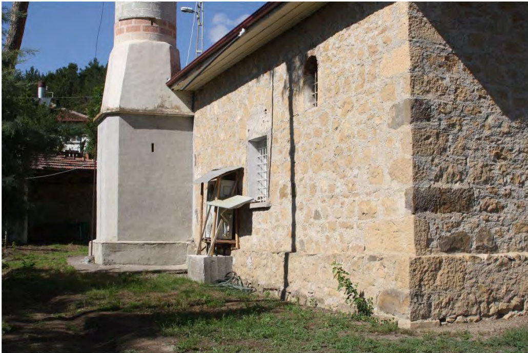
Fot. 325 Amasya merkez ilçe Yıldızköy Camii batı cephesinden görünüm
