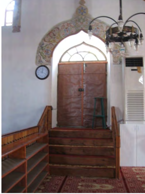
Fot. 23 Amasya Merzifon ilçesi Sultan II. Murad Camii onarım sonrası harimden batı girişinin görünümü
