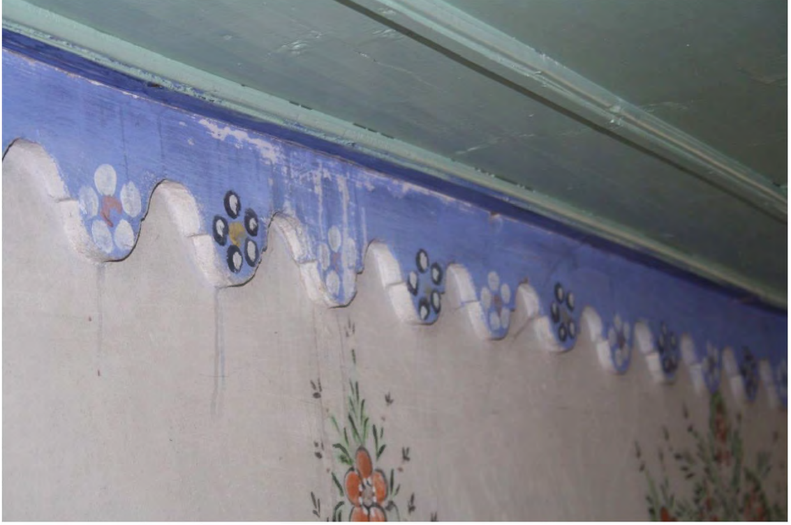
Fot. 313 Amasya merkez ilçe Çavuş Köyü Camii ahşap tavan eteği
