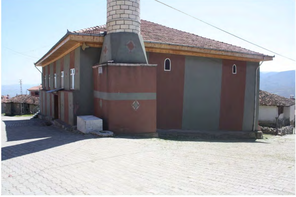
Fot. 396 Amasya Taşova ilçesi Yukarı Baraklı Camii batı cephesinden görünüm
