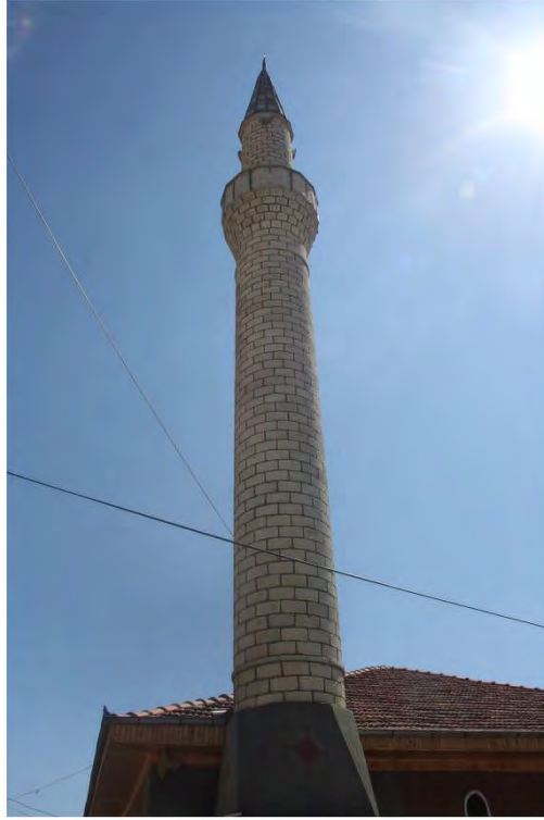
Fot. 394 Amasya Taşova ilçesi Yukarı Baraklı Camii minaresi
