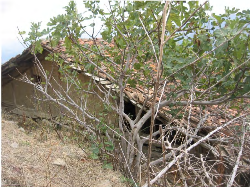
Fot. 144 Amasya merkez ilçe Kızılkışlacık Köyü Camii kuzey cepheden görünüm
