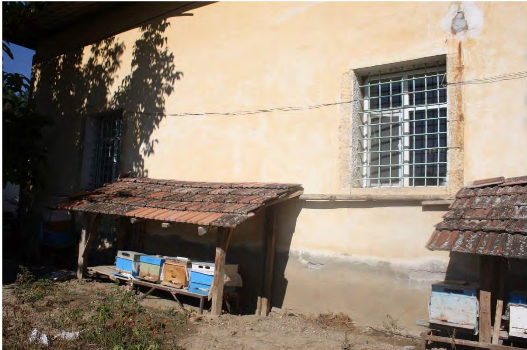
Fot. 318 Amasya merkez Kayabaşı Mahallesi Camii güney cephesinden görünüm
