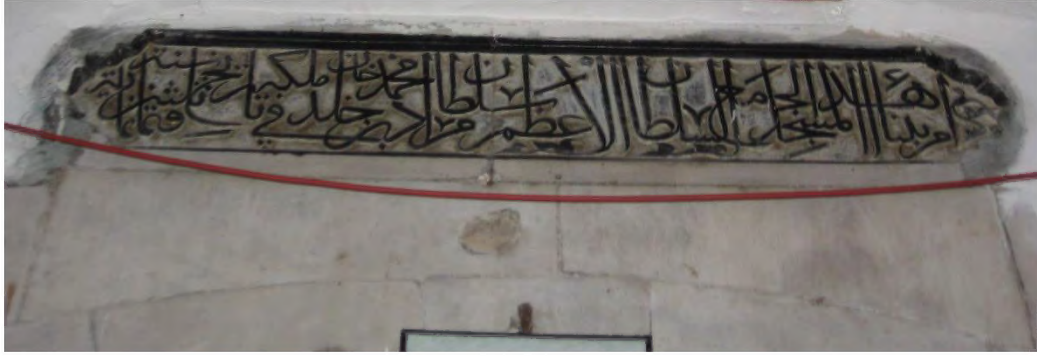
Fot. 20 Amasya Merzifon ilçesi Sultan II. Murad Camii kuzey girişi üzerinde yer alan kitabe
