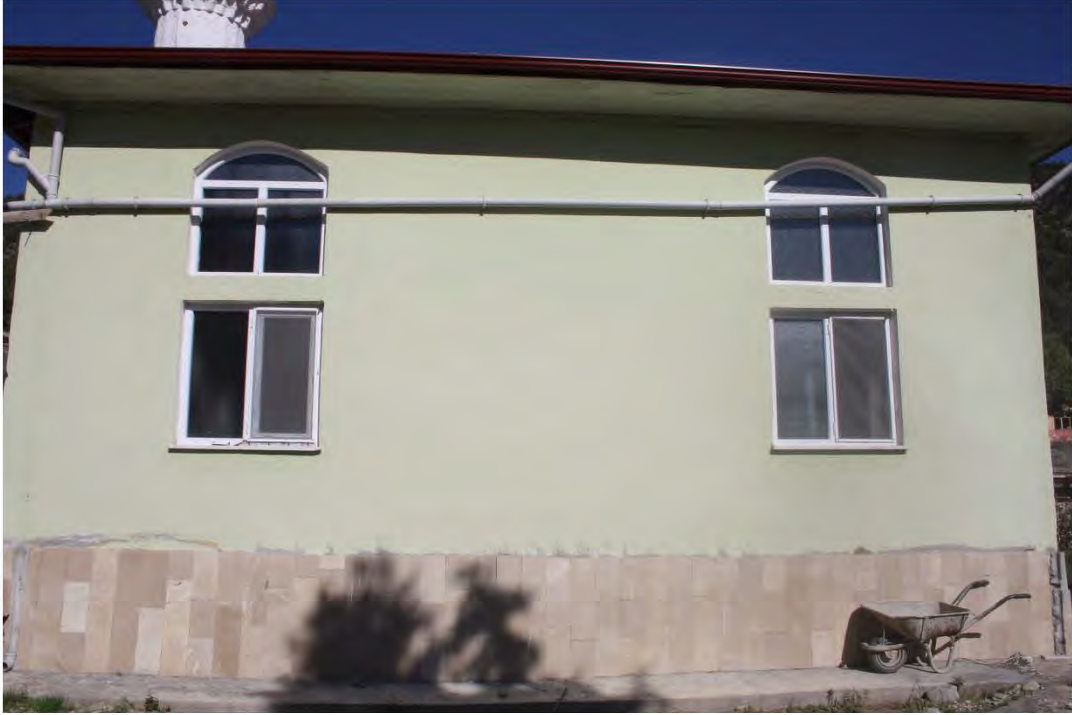
Fot. 378 Amasya merkez Sarıyar Köyü Aşağıova Camii güney cephesinden görünüm
