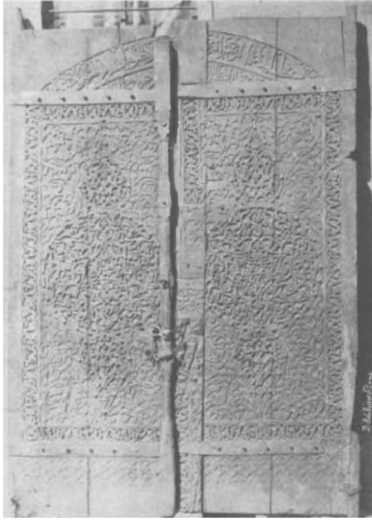
Fot. 49 Amasya Merzifon ilçesi Sultan II. Murad Camii doğu kapısının önceki durumu
