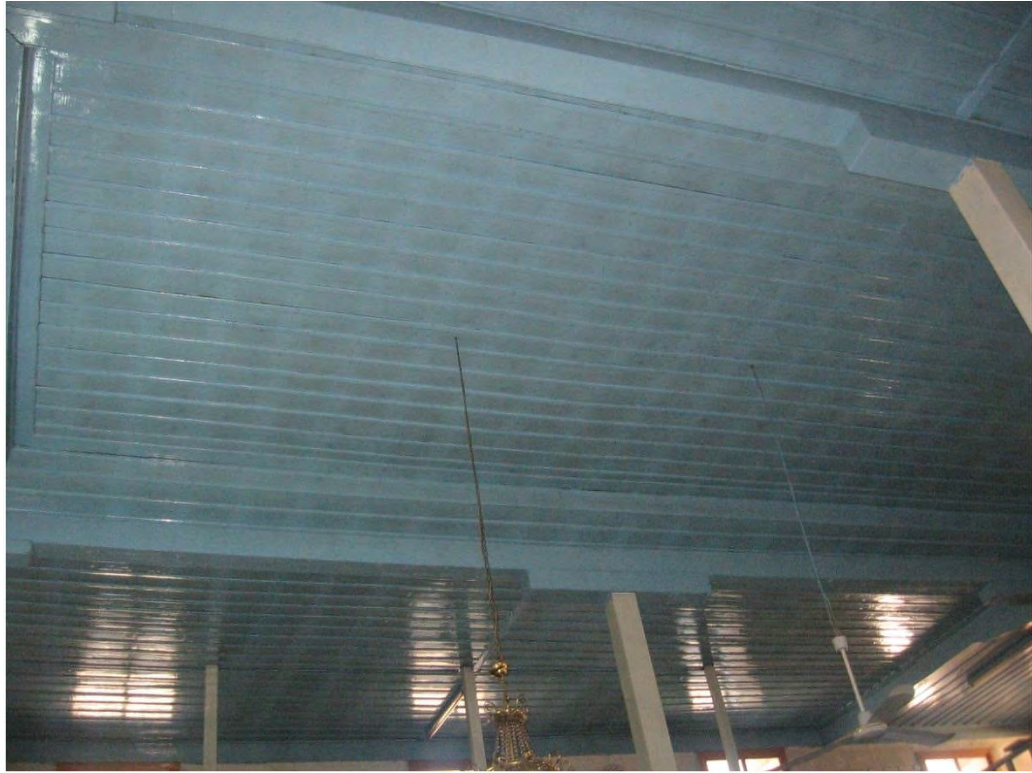
Fot. 124 Amasya merkez Üçler Camii harimdeki desteklerin taşıdığı ana kirişler
