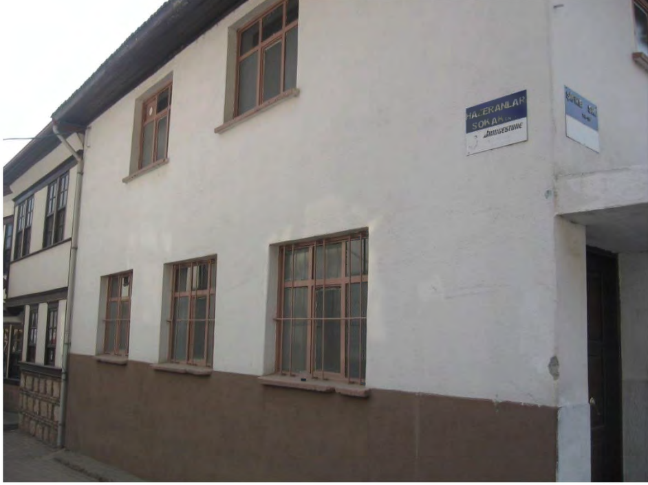
Fot. 466 Amasya merkez Köprübaşı Camii günümüzdeki yapının kuzey cephesinden genel görünüm
