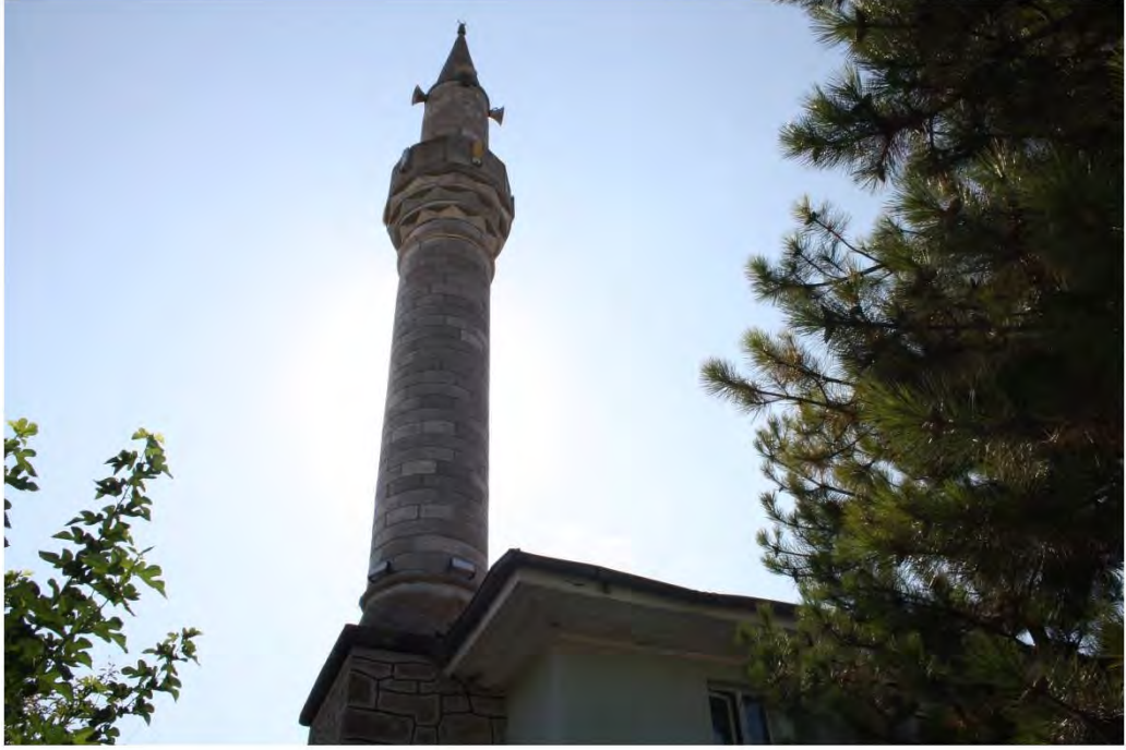
Fot. 473 Amasya Merzifon ilçesi Aktarla Köyü Camii minaresi
