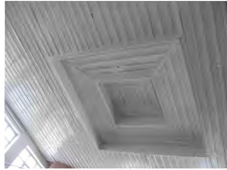
Fot. 665 Merkez Köprübaşı Camii tavanından genel görünüm
