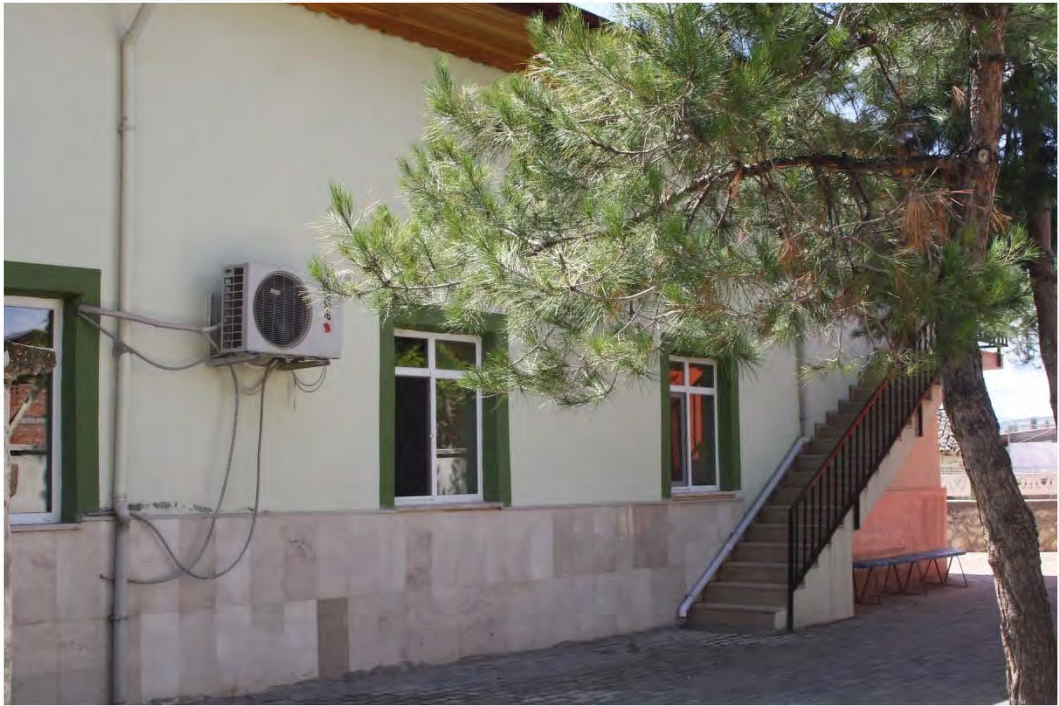
Fot. 184 Amasya merkez ilçe Belmebük Köyü Camii doğu cephesinden genel görünüm
