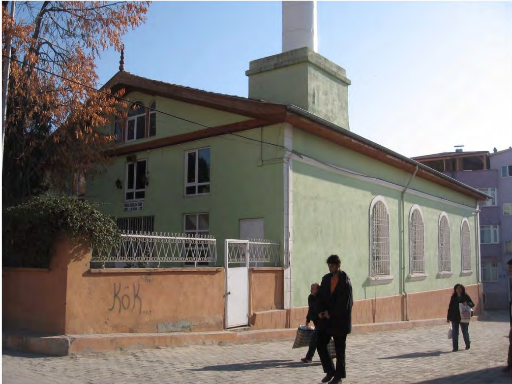
Fot. 542 Amasya Merzifon ilçesi Büyük Hacı Hasan Camii batı cephesinden görünüm
