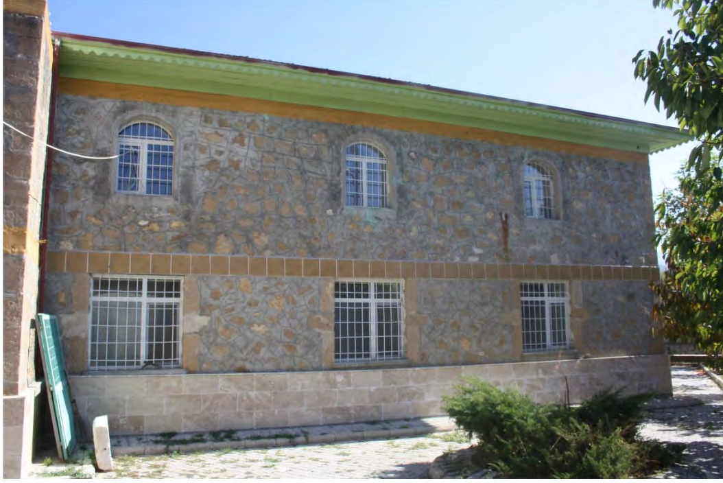
Fot. 354 Amasya merkez Karasenir Mahallesi Camii batı cephesinden görünüm
