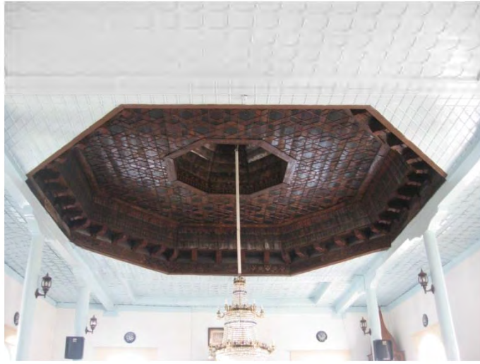
Fot. 684 Merzifon ilçesi Büyük Hacı Hasan Camii tavanından genel görünüm
