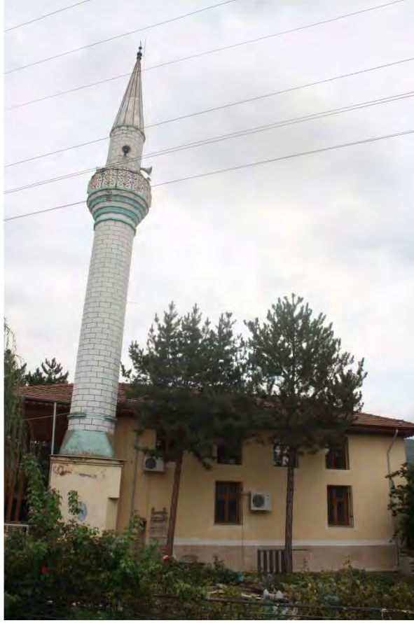
Fot. 335 Amasya merkez ilçe İpekköy Camii batı cephesinden genel görünüm
