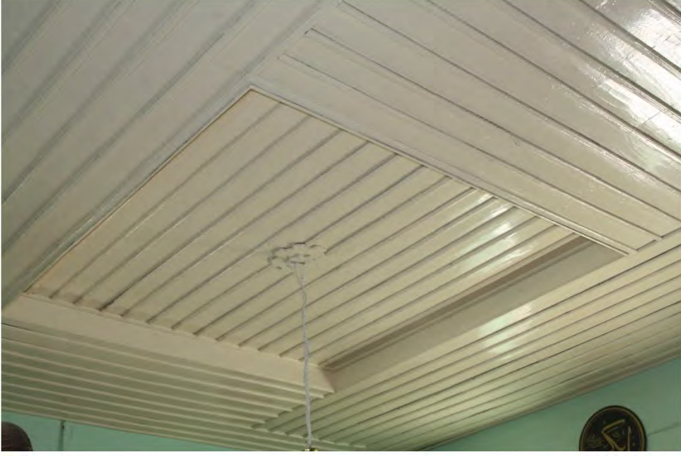
Fot. 331 Amasya merkez ilçe Yıldızköy Camii tavanından görünüm
