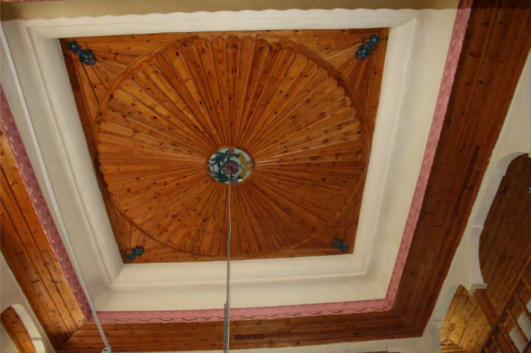
Fot. 496 Amasya merkez ilçe Akyazı Köyü Camii tavanından görünüm
