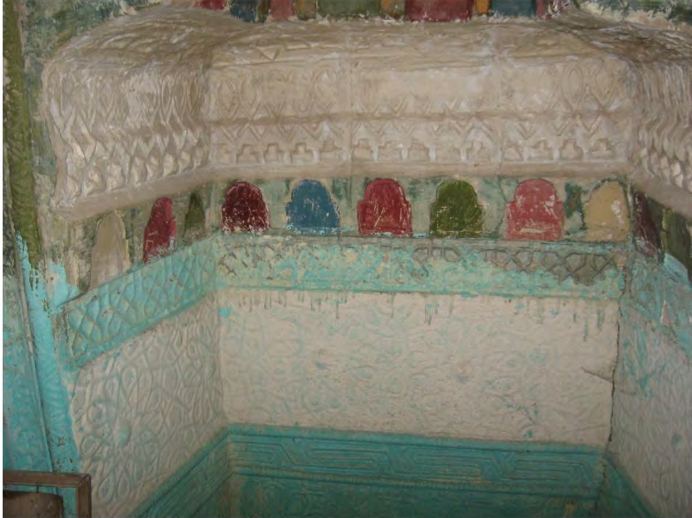
Fot. 100 Amasya merkez ilçe Kaleköy Camii mihrap nişinin alt kısmındaki bezemeler
