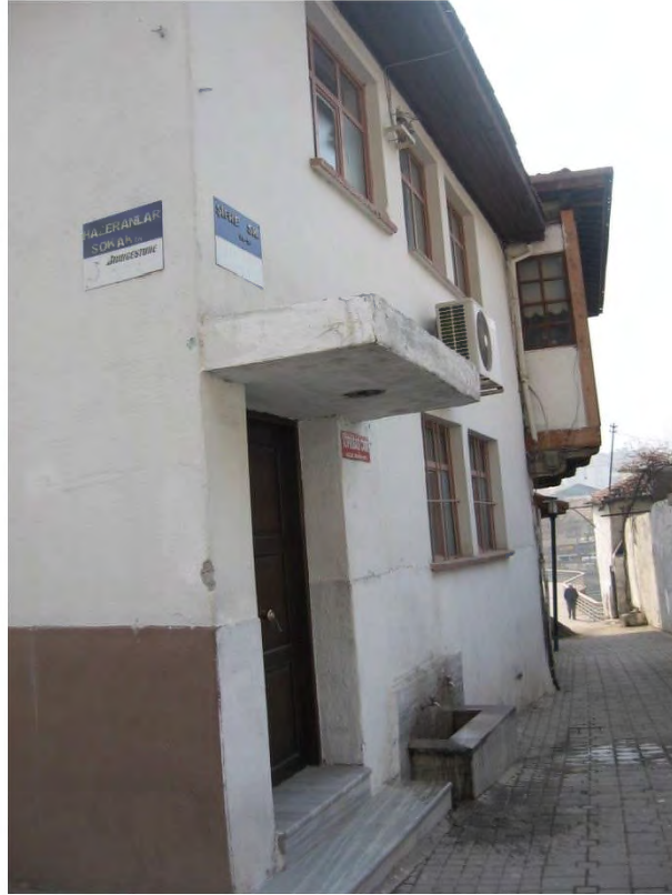
Fot. 467 Amasya merkez Köprübaşı Camii günümüzdeki yapının batı cephesinden genel görünüm
