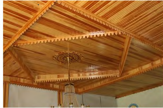
Fot. 621 Merkez ilçe Belmebük Köyü Camii tavanından genel görünüm
