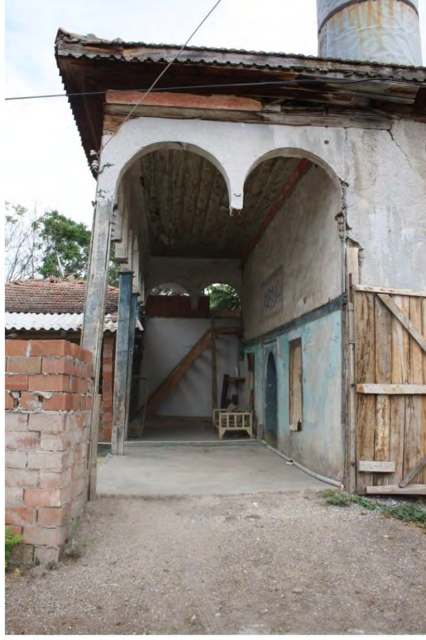
Fot. 434 Amasya Göynücek ilçesi Şıhlar Köyü Camii son cemaat yerinden görünüm
