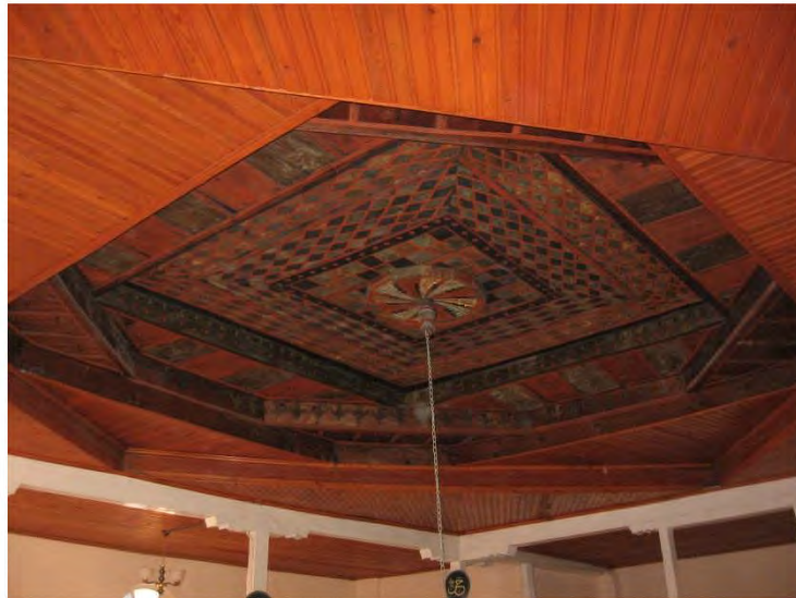
Fot. 628 Merzifon ilçesi Hanife Hatun Camii tavanından genel görünüm
