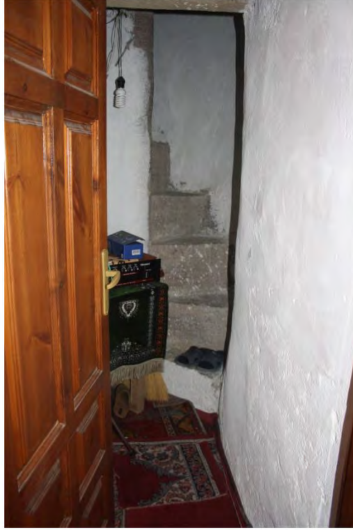
Fot. 358 Amasya merkez Karasenir Mahallesi Camii minareye çıkışı sağlayan kapı açıklığı
