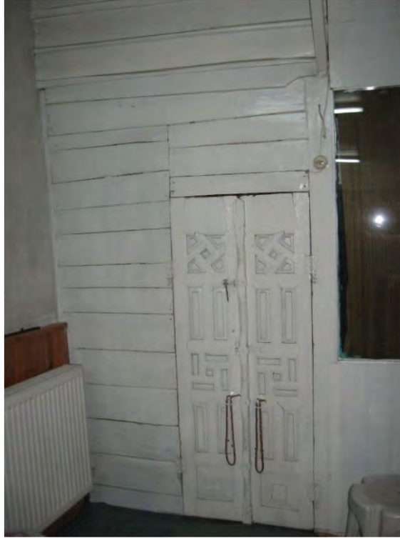
Fot. 136 Amasya merkez Üçler Camii mahfil merdiveni altındaki bölümün kapı kanatları
