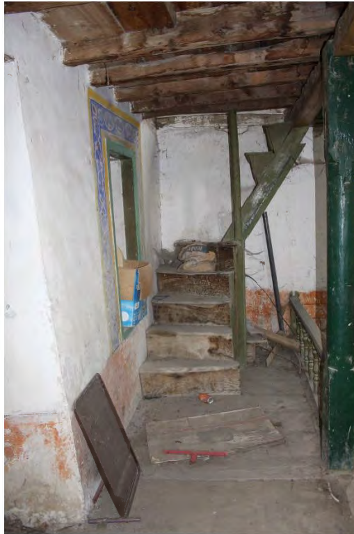
Fot. 443 Amasya Göynücek ilçesi Şıhlar Köyü Camii mahfile çıkışı sağlayan merdiven
