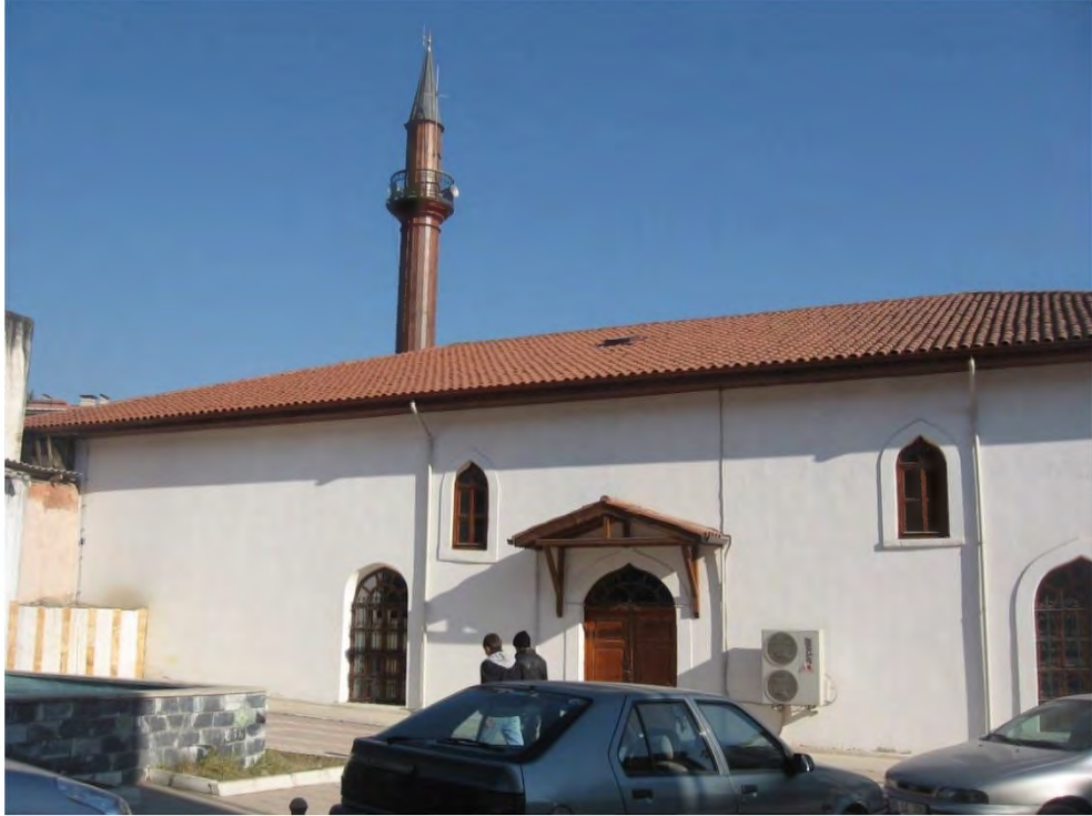
Fot. 28 Amasya Merzifon ilçesi Sultan II. Murad Camii batı cephesinden genel görünüm
