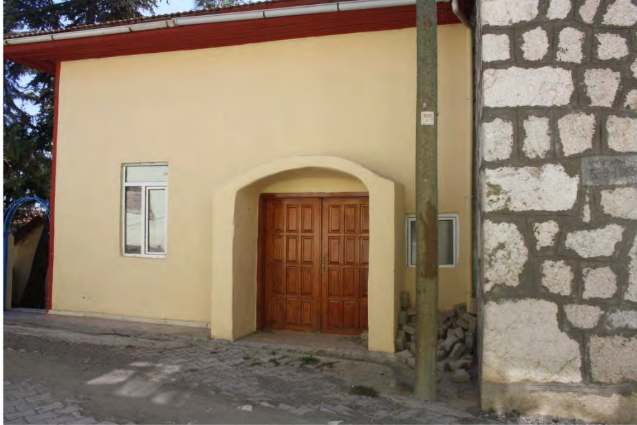
Fot. 283 Amasya Merzifon ilçesi Ortaova Köyü Camii son cemaat yerine geçişi sağlayan kuzey kapısı
