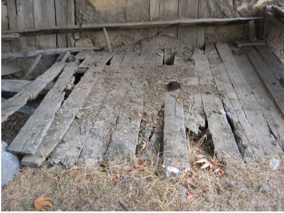
Fot. 143 Amasya merkez ilçe Kızılkışlacık Köyü Camii son cemaat yerinin tabanından görünüm
