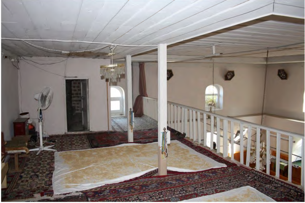
Fot. 348 Amasya Merzifon ilçesi Yeşilören Köyü Camii mahfilden görünüm
