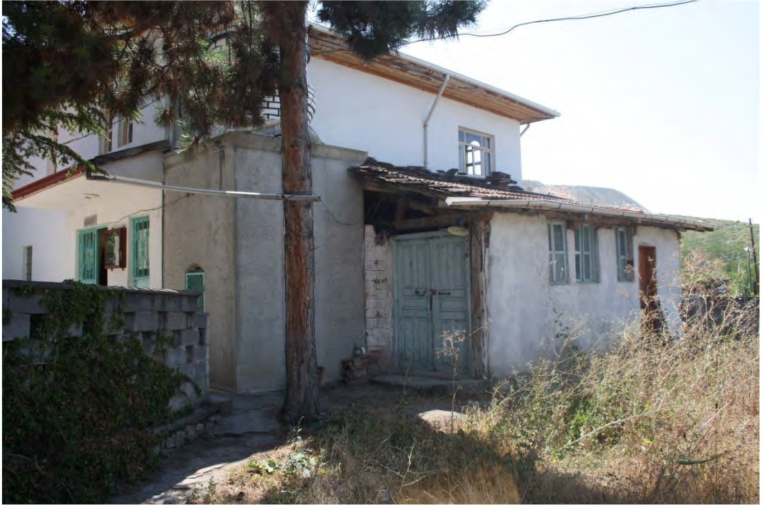
Fot. 488 Amasya merkez ilçe Akyazı Köyü Camii kuzey cephesinden görünüm
