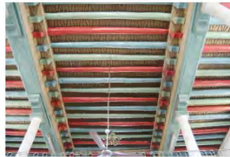
Fot. 598 Kayseri Hasinli Camii tavanı ( Kaynak: Özbek ve Arslan, 2008: 187)
