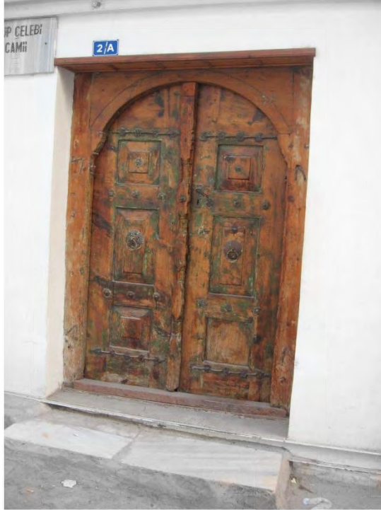
Fot. 582 Amasya Merzifon ilçesi Eyüp Çelebi Camii kuzey cephedeki çift kanatlı ahşap kapı
