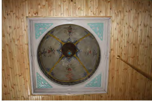
Fot. 658 Taşova Yukarı Baraklı Camii tavanından genel görünüm
