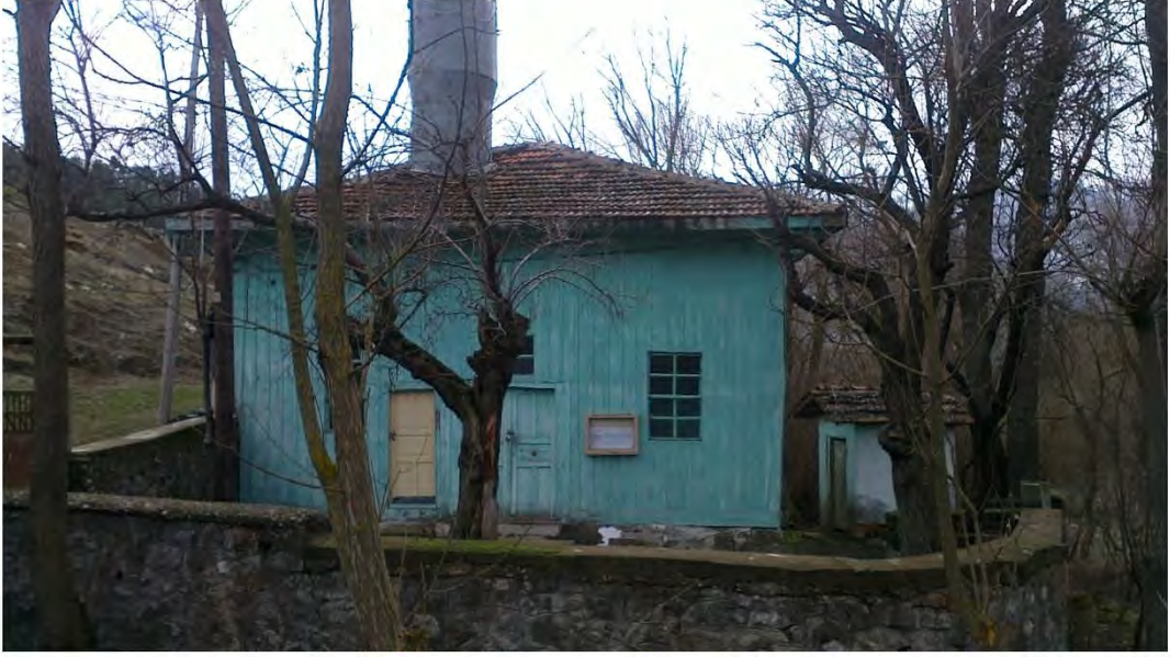
Fot. 386 Amasya merkez ilçe Karakise Köyü Camii kuzey cephesinden genel görünüm
