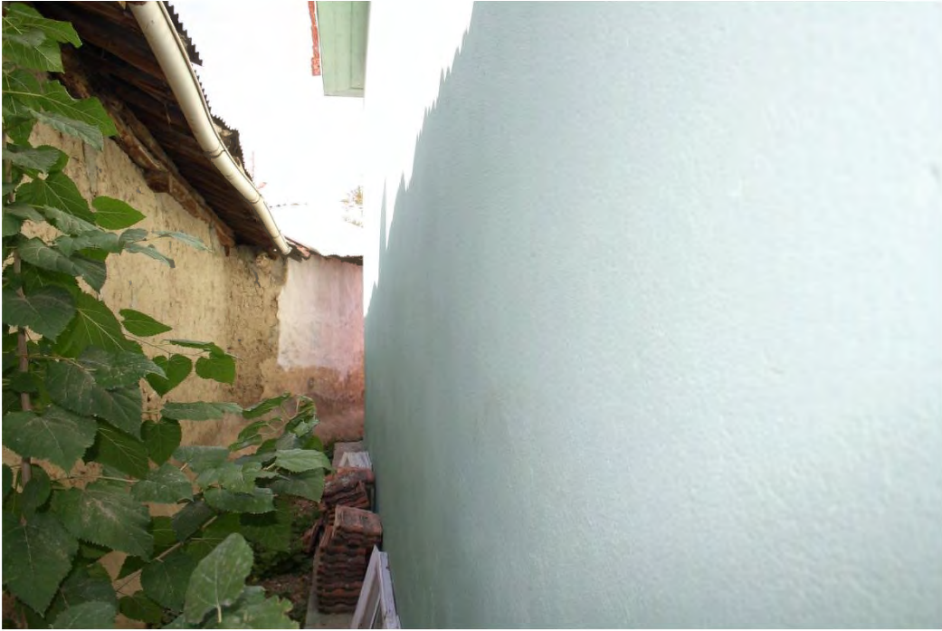
Fot. 343 Amasya Merzifon ilçesi Yeşilören Köyü Camii batı cephesinden genel görünüm
