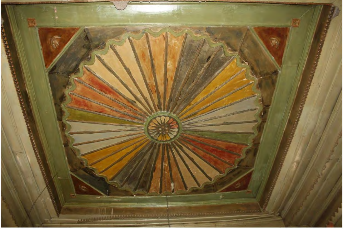
Fot. 446 Amasya Göynücek ilçesi Şıhlar Köyü Camii tavanından görünüm
