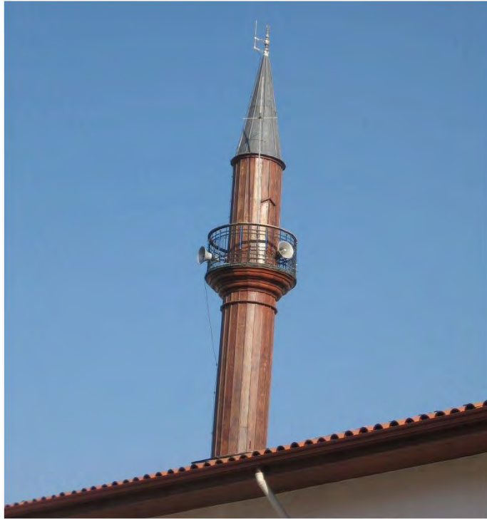
Fot. 24 Amasya Merzifon ilçesi Sultan II. Murad Camii kuzeybatı köşedeki minareten görünüm
