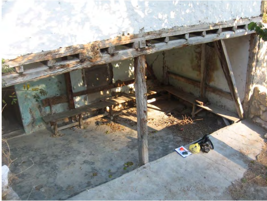
Fot. 74 Amasya merkez ilçe Kaleköy Camii son cemaat yerinin batı sınırındaki destekler
