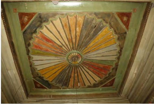
Fot. 664 Göynücek ilçesi Şıhlar Köyü Camii tavanından genel görünüm
