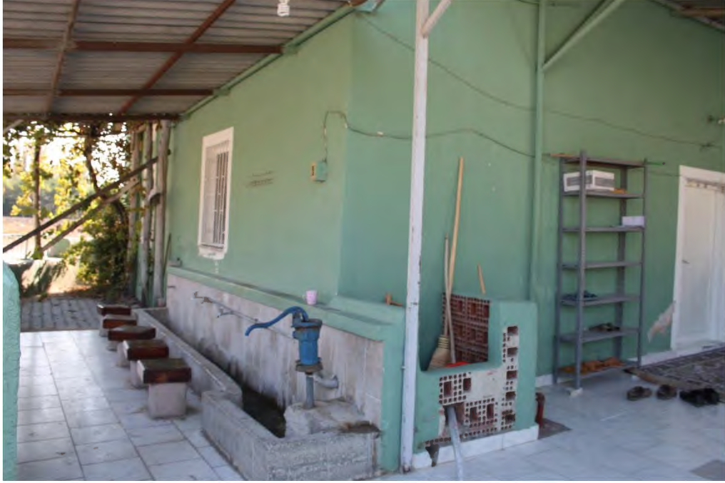
Fot. 344 Amasya Merzifon ilçesi Yeşilören Köyü Camii doğu cephesinden genel görünüm
