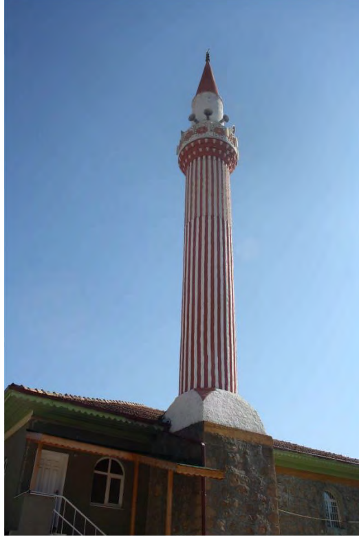
Fot. 351 Amasya merkez Karasenir Mahallesi Camii minaresi
