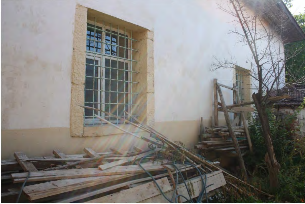
Fot. 317 Amasya merkez Kayabaşı Mahallesi Camii batı cephesinden görünüm
