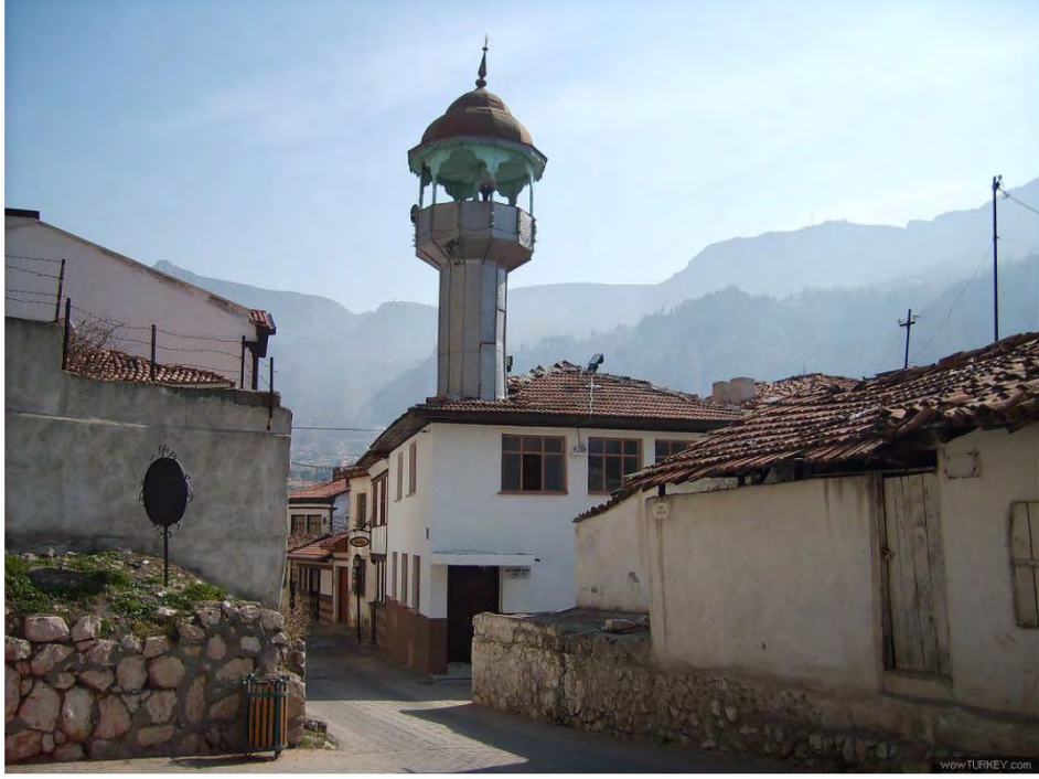
Fot. 464 Amasya merkez Köprübaşı Camii günümüzdeki yapının genel görünümü
