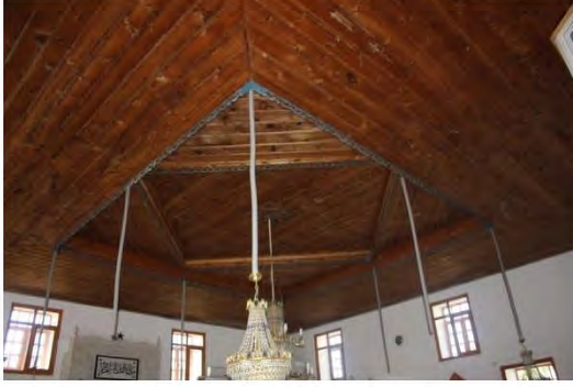
Fot. 622 Merkez ilçe Aydınca Köyü Camii tavanından genel görünüm
