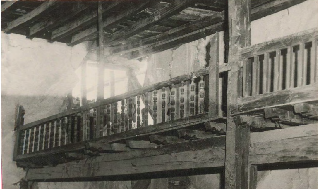
Fot. 459 Amasya merkez Köprübaşı Camii orijinal yapının kadınlar mahfilinden genel görünüm ( Kaynak: VGM arşivi)
