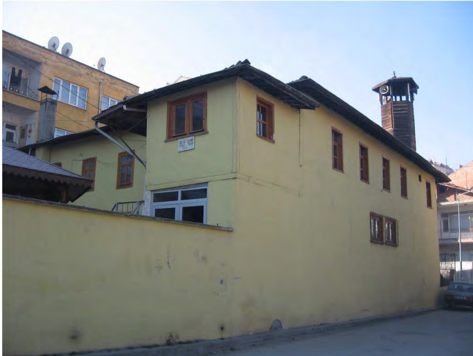
Fot. 120 Amasya merkez Üçler Camii kuzey cepheden genel görünüm
