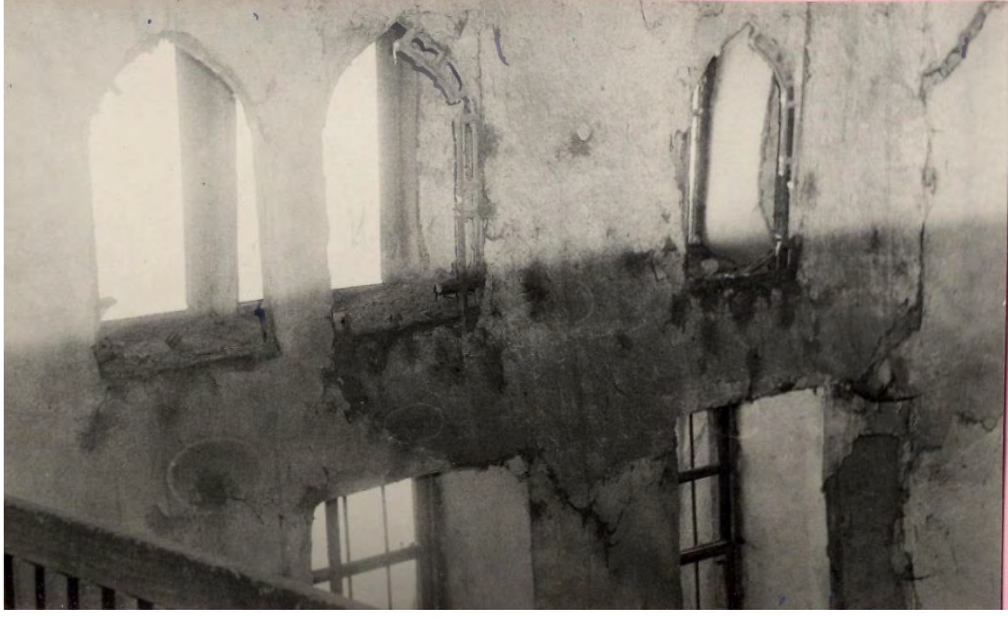
Fot. 460 Amasya merkez Köprübaşı Camii orijinal yapının batı duvarındaki pencere açıklıkları ( Kaynak: VGM. arşivi)
