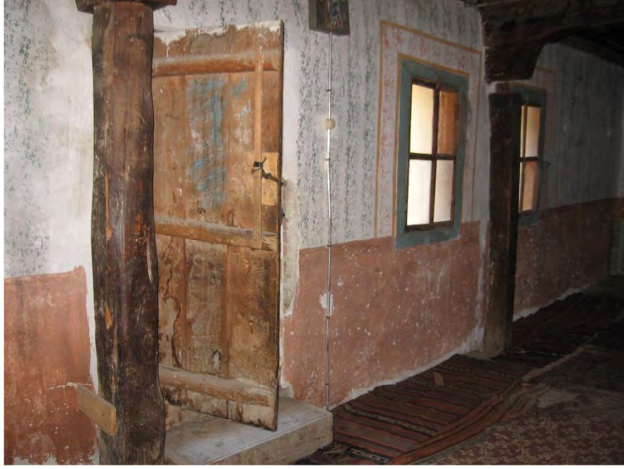
Fot. 87 Amasya merkez ilçe Kaleköy Camii kuzey duvarındaki kapı ve pencere açıklıkları
