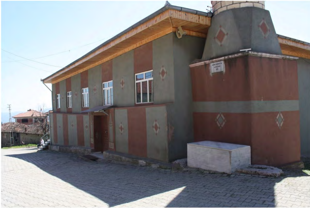
Fot. 395 Amasya Taşova ilçesi Yukarı Baraklı Camii kuzey cephesinden görünüm
