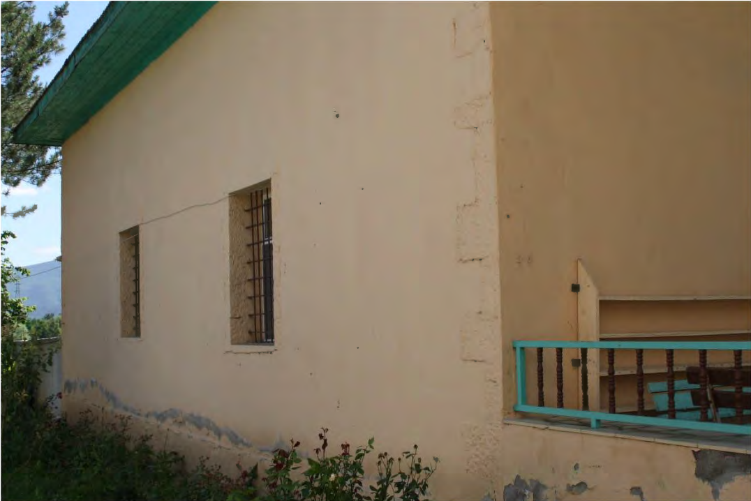
Fot. 316 Amasya merkez Kayabaşı Mahallesi Camii doğu cephesinden görünüm
