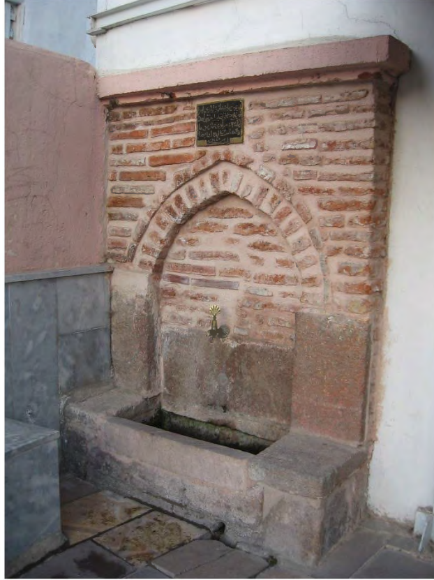
Fot. 561 Amasya Merzifon ilçesi Eyüp Çelebi Camii batı cephesindeki çeşme
