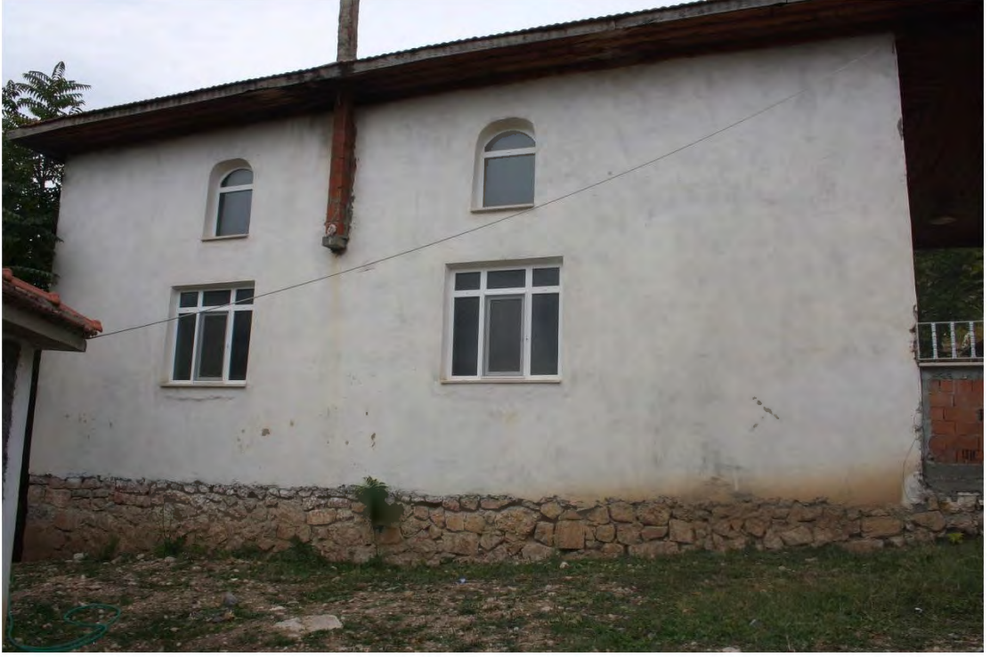
Fot. 252 Amasya merkeze bağı Kavaklıağıl Mezrası Camii doğı cephesinden genel görünüm
