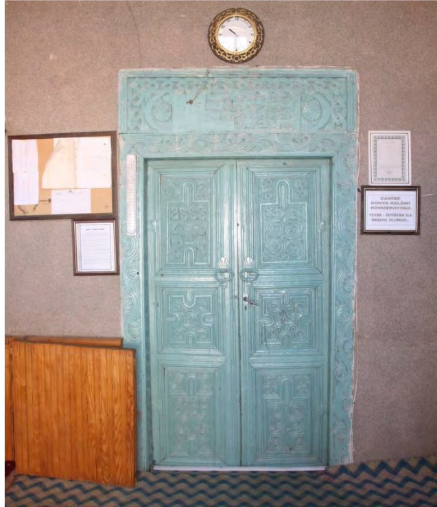
Fot. 403 Amasya Taşova ilçesi Yukarı Baraklı Camii harime geçişi sağlayan orijinal kapısı
