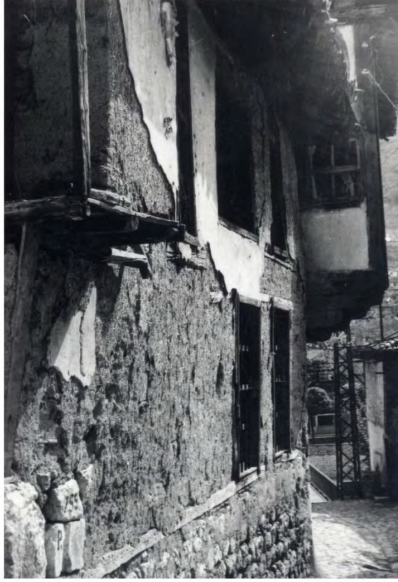
Fot. 456 Amasya merkez Köprübaşı Camii orijinal yapının batı cephesindeki pencere açıklıkları ( Kaynak: VGM arşivi)
