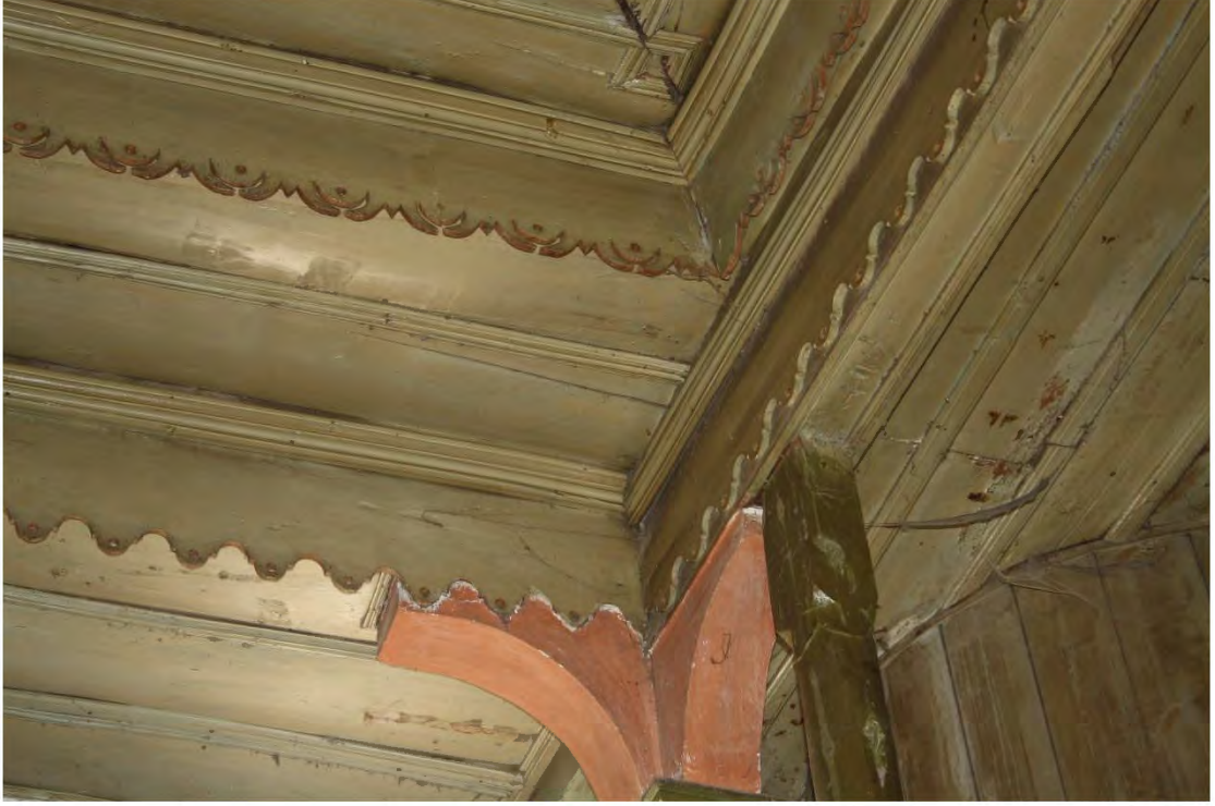
Fot. 452 Amasya Göynücek ilçesi Şıhlar Köyü Camii eksen kenarlarındaki süslemeler
