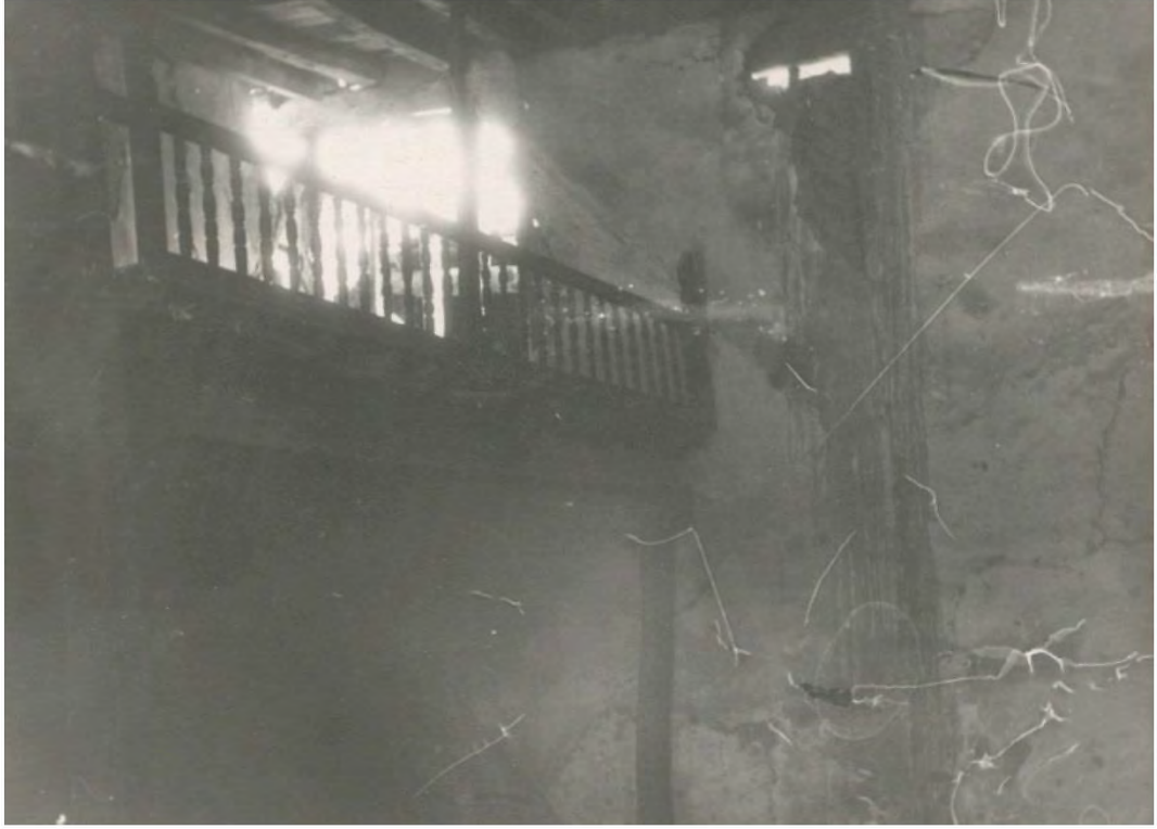
Fot. 458 Amasya merkez Köprübaşı Camii orijinal yapının hariminden doğu duvarına bakış ( Kaynak: VGM arşivi)
