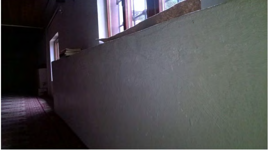
Fot. 33 Amasya Merzifon ilçesi Sultan II. Murad Camii son cemaat yerinin üst katından görünüm
