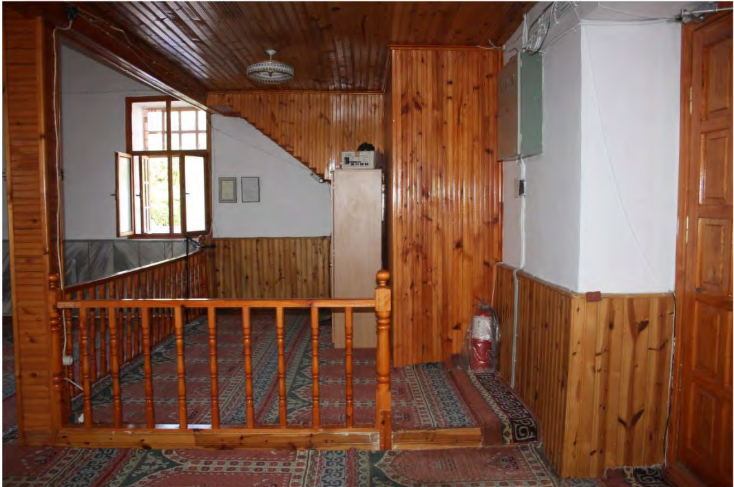
Fot. 200 Amasya merkez ilçe Aydınca Köyü Camii girişlemesi alttan kaplamalı mahfil tabanı
