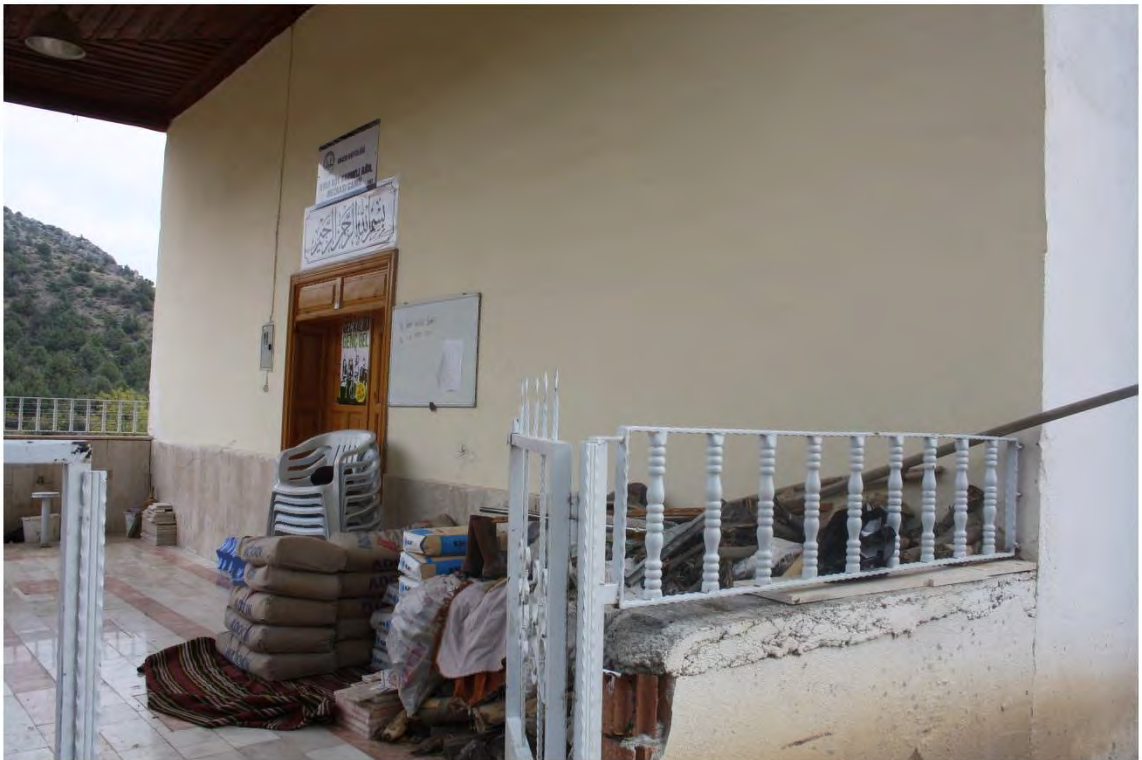
Fot. 249 Amasya merkeze bağı Kavaklıağıl Mezrası Camii kuzey cephesinden görünüm
