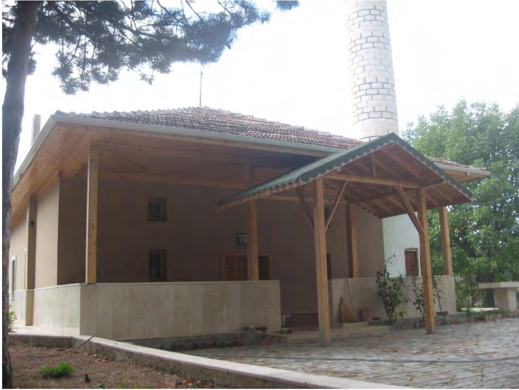
Fot. 208 Amasya merkez ilçe Mahmatlar Köyü Camii kuzey cepheden genel görünüm
