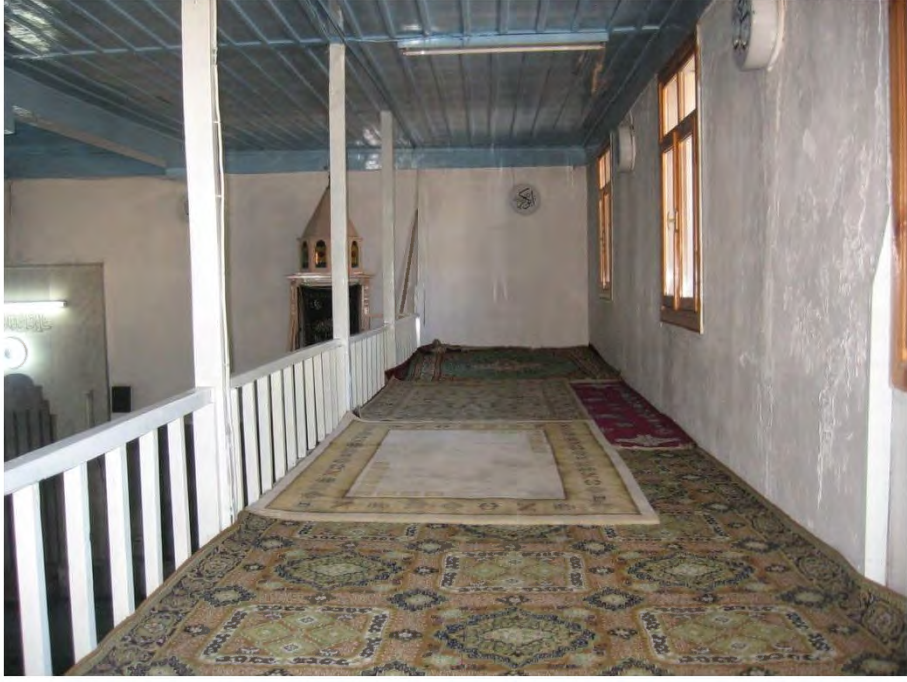
Fot. 127 Amasya merkez Üçler Camii kadınlar mahfilinin batı sınırındaki destekler
