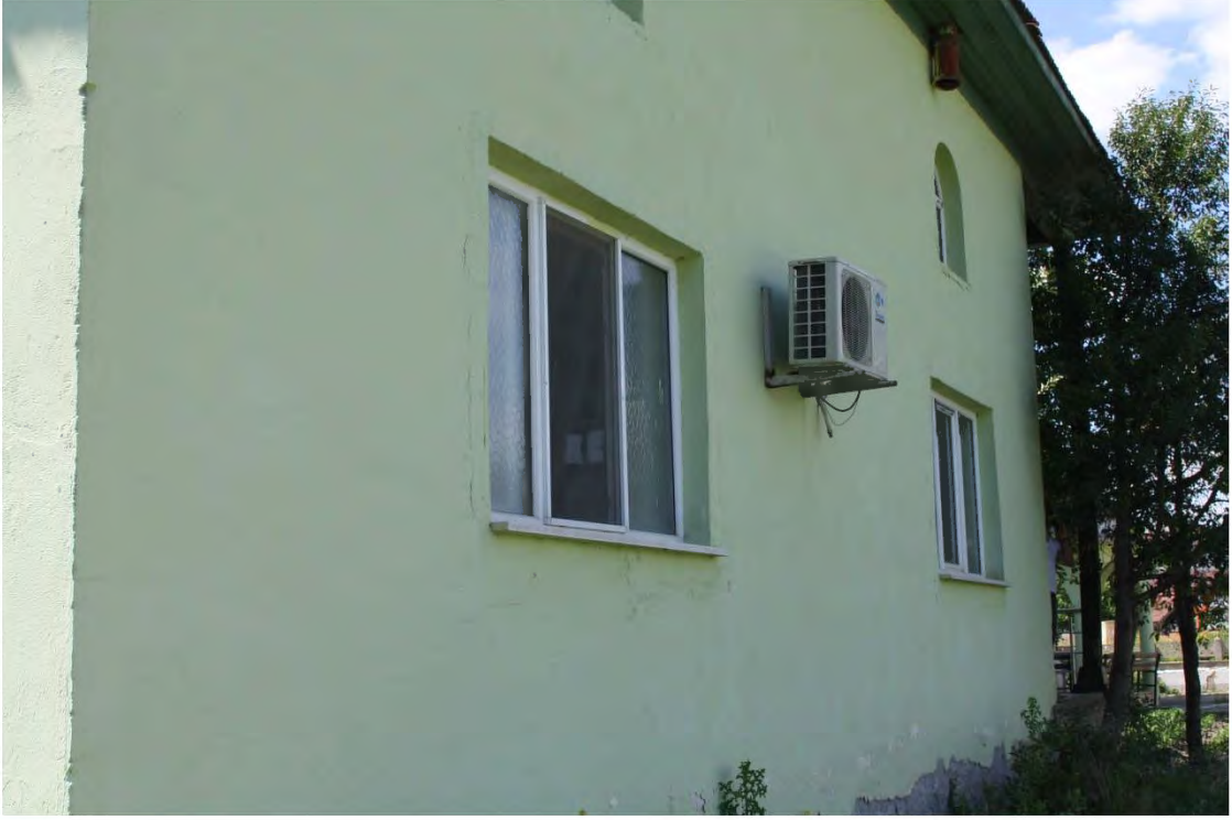
Fot. 228 Amasya merkez ilçe Dadı Köyü Camii doğu cephesinden genel görünüm
