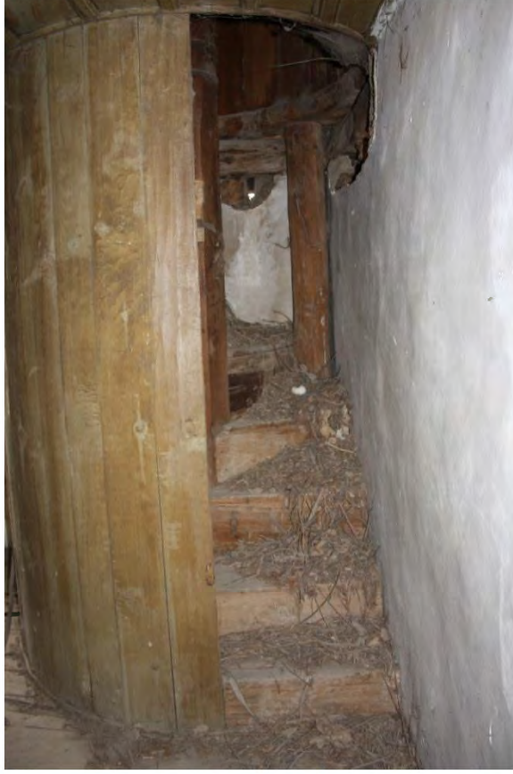
Fot. 444 Amasya Göynücek ilçesi Şıhlar Köyü Camii minareye çıkışı sağlayan merdiven
