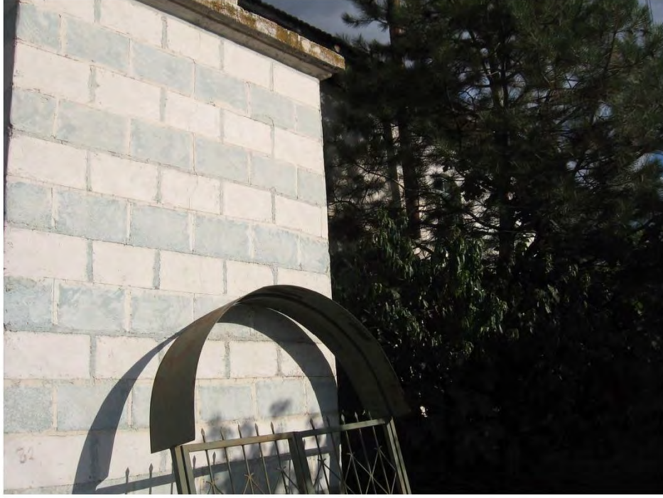
Fot. 242 Amasya merkeze bağı Mahmatlar Köyü Yol Kenarı Camii batı cephesinden genel görünüm
