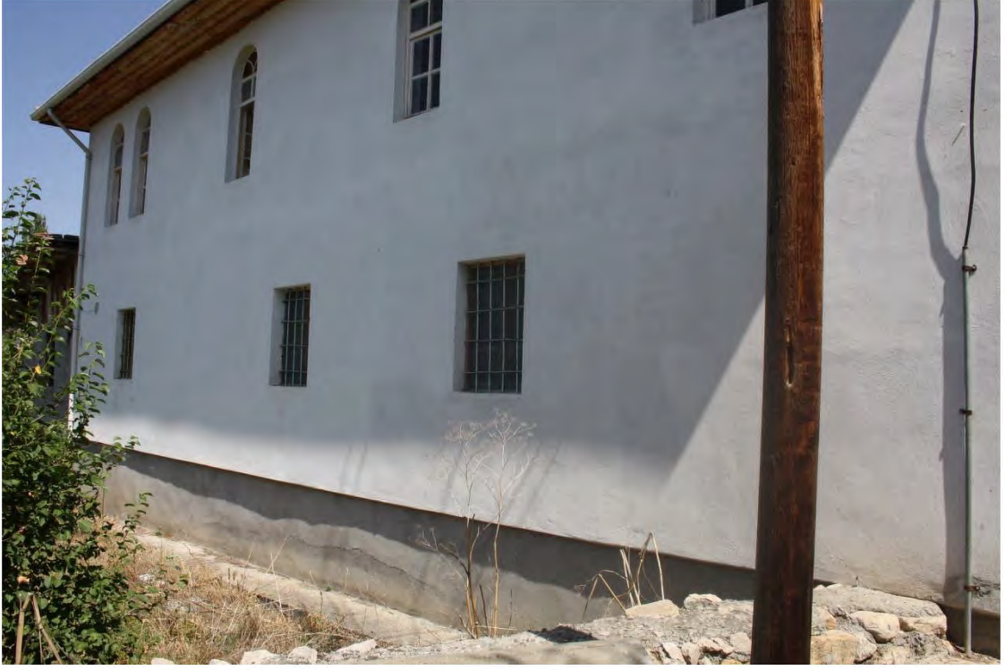
Fot. 489 Amasya merkez ilçe Akyazı Köyü Camii batı cephesinden görünüm
