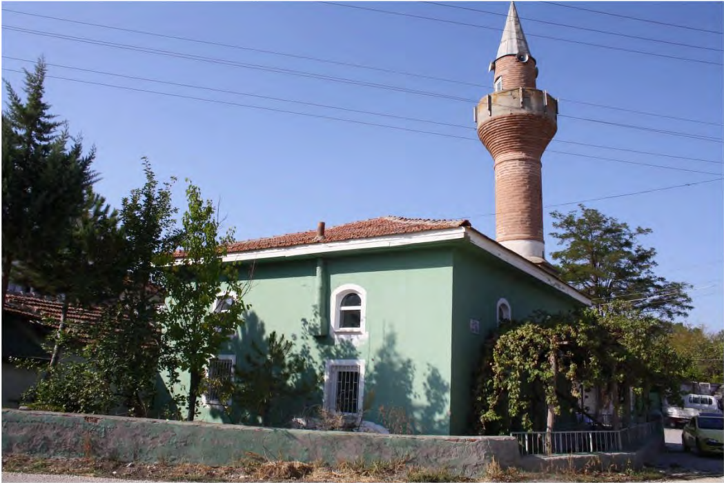
Fot. 345 Amasya Merzifon ilçesi Yeşilören Köyü Camii güney cephesinden genel görünüm
