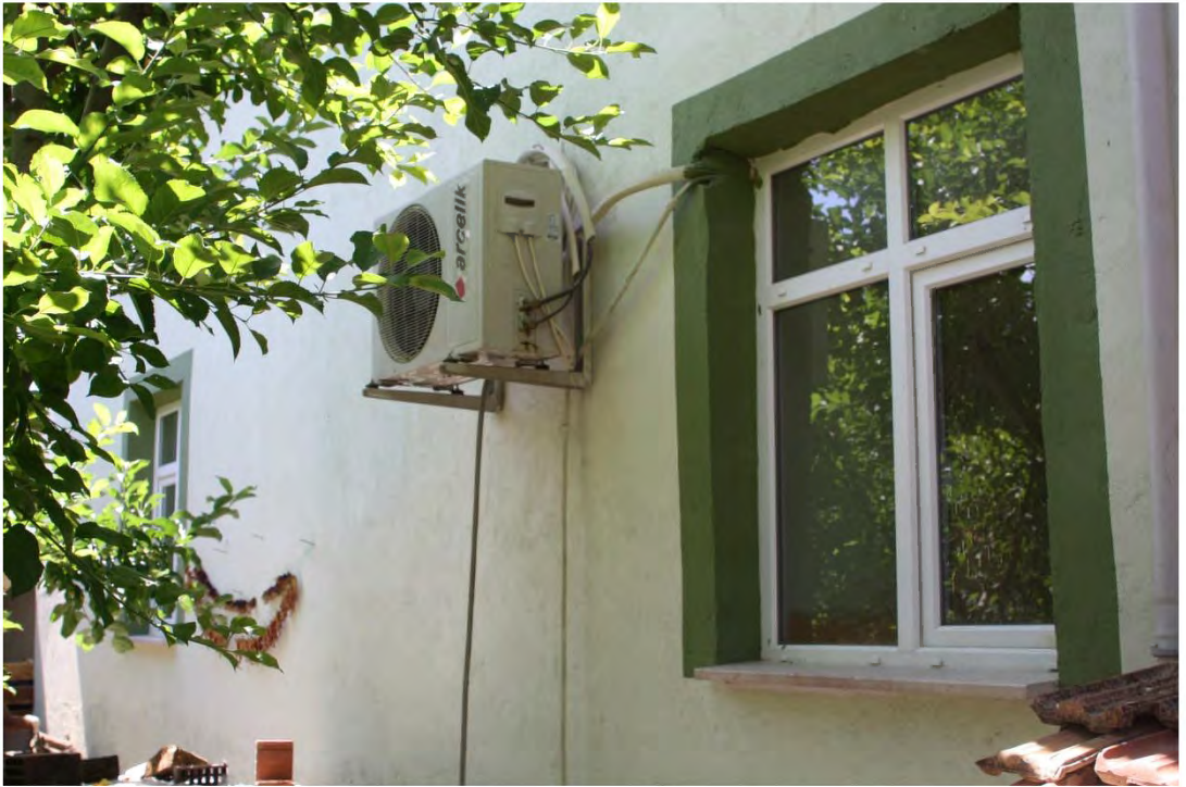
Fot. 186 Amasya merkez ilçe Belmebük Köyü Camii güney cephesinden genel görünüm
