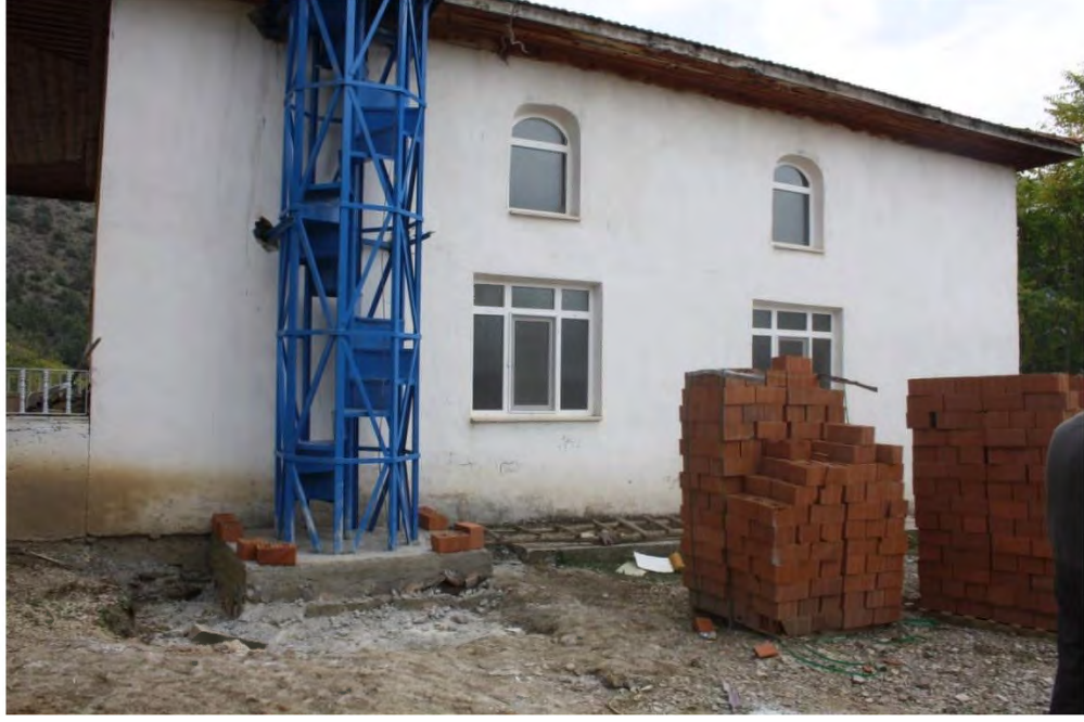
Fot. 250 Amasya merkeze bağı Kavaklıağıl Mezrası Camii batı cephesinden genel görünüm
