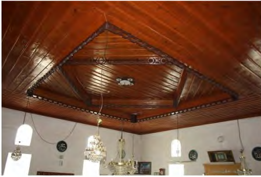
Fot. 620 Merkez ilçe İlyasköy Camii tavanından genel görünüm
