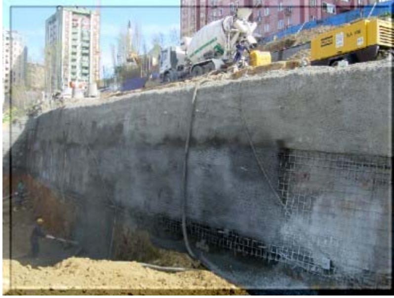
Şekil 3.12. Şatkrit ve zemin çivileri ile desteklenmiş kazı yüzeyi
