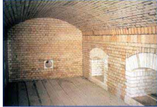
Şekil 1.17. Rejeneratör tavanı. (Silimanit veya mullit tuğla).
