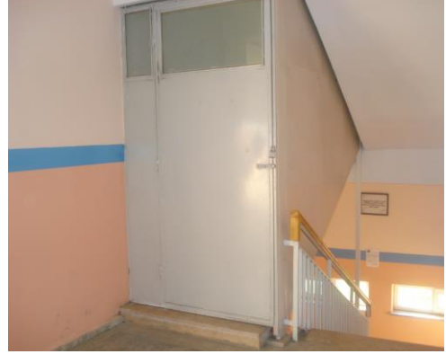
Fotoğraf 2.49. B-Blok 3. Kat Çatı Merdiveni
