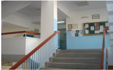
Fotoğraf 2.21. A-Blok B-Katına Çıkan Merdiven
