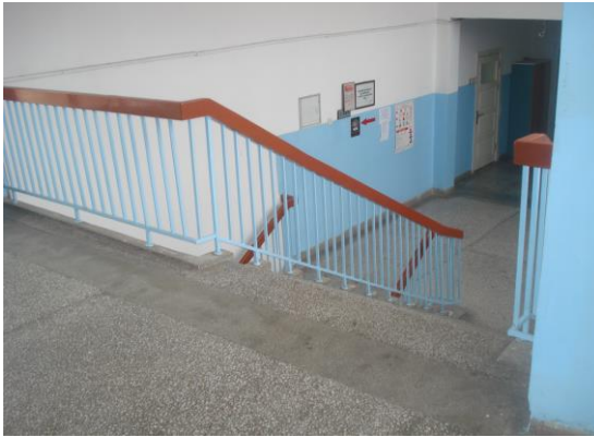
Fotoğraf 2.29. A-Blok D-Katına Çıkan Merdiven
