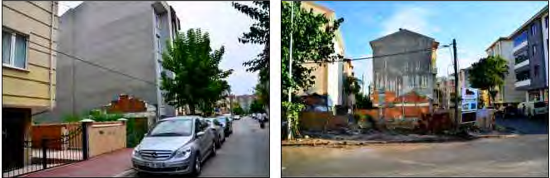
Görsel 45. 46. Bölgenin Güncel Durumunda Bahçeli evlerin yıkılarak yerlerine apartmanların yapıldığı süreci gösteren fotoğraflar
