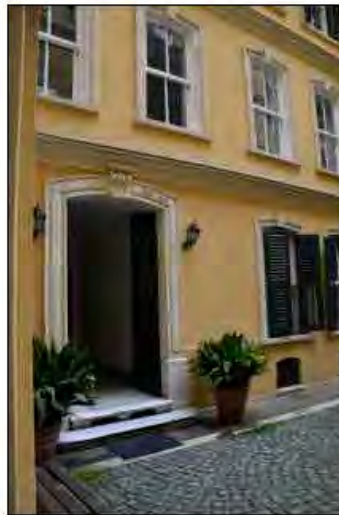
Görsel 16. Doğan Apartmanı bahçeye açılan apartman girişleri
