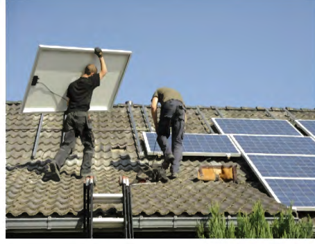
Görsel 2.2. Fotovoltaik Panel Uygulama
