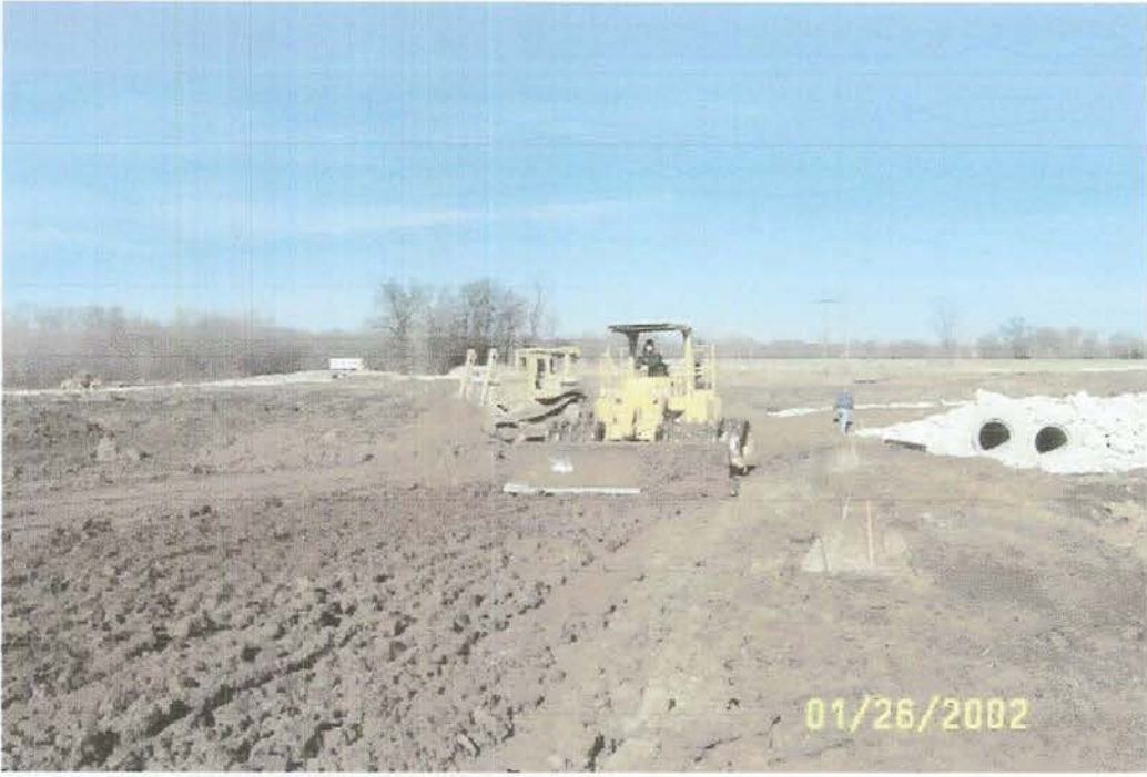
Şekil 2.1. Dolgu malzemesinin serilmesi
