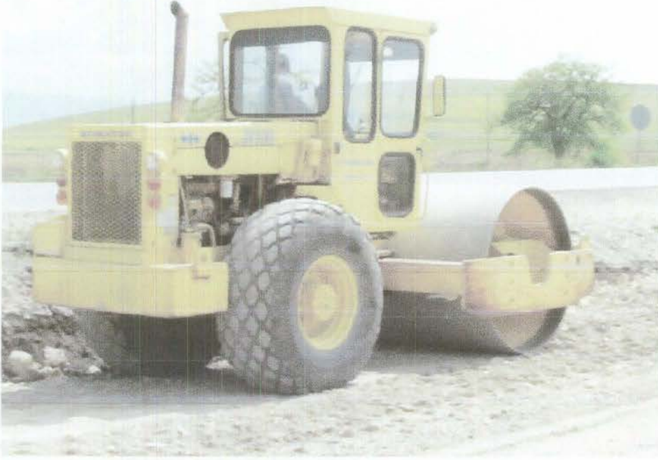
Şekil 3.6. Alttemel Tabakasının Sıkıştırılması
