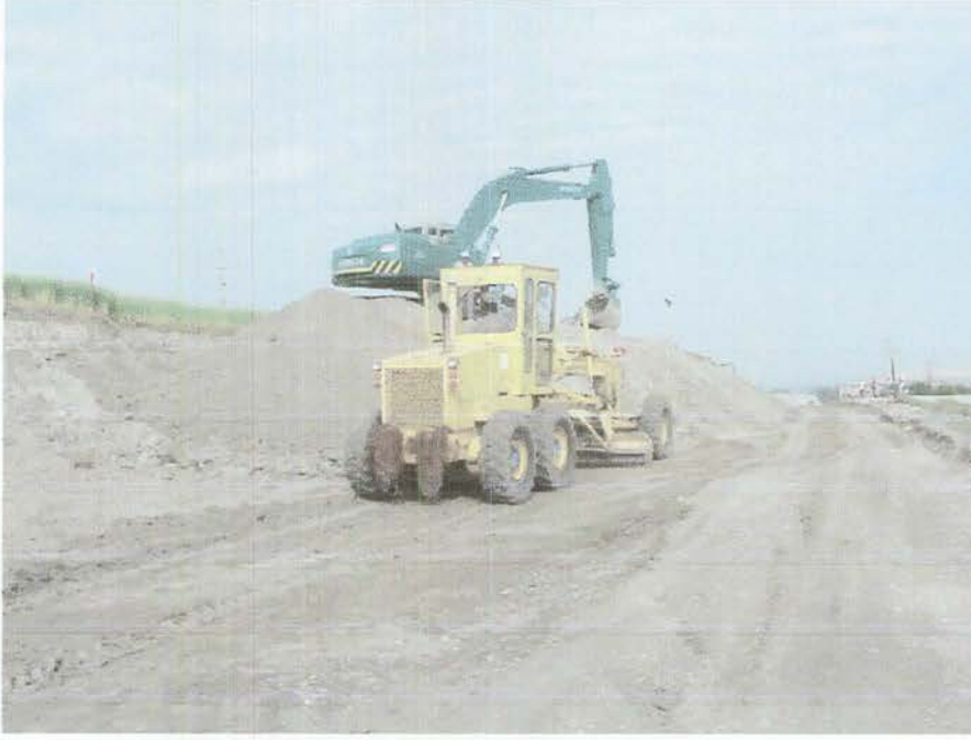
Şekil 3.5. Alttemel Malzemesinin Greyderle Tesviyesi
