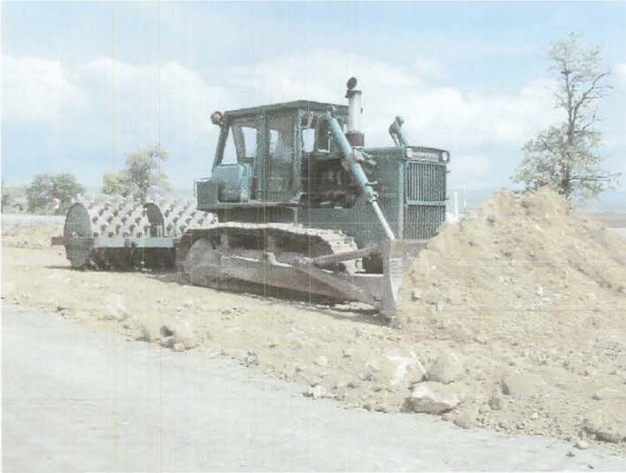
Şekil 3.4 Alttemel Serilmesi
