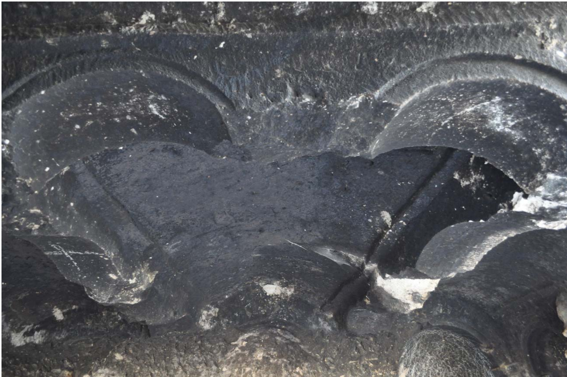
Resim 2: Ayazın D Kilisesi, örtü sistemi
