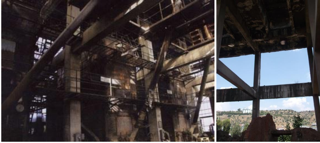
ekil 5.11. Kazan dairesinin içeriden bir fotoğrafı, (Karatosun ve Ar, tan, 2010), Kazan dairesinin 2014 yılındaki içeriden bir fotoğrafı, (Yazarın kişisel arşivi)
