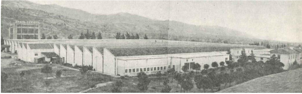
ekil 5.1. Ayd,n Tekstil Yerle kesi genel görünümü- ana üretim binas,ndan kazan dairesine do ru bak, . Foto raf,n sa ,ndaki yapı, idari bina (Anonim, 1967, s:277)
