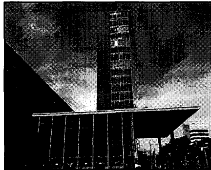
Şekil 3.4. Büro-İstasyon Binası, Freiburg, Almanya [27]
