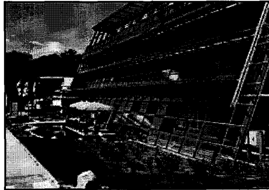
Şekil 3.3. Solar Fabrik, Freiburg /Almanya [29]
