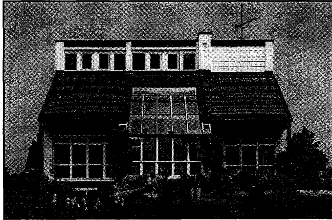
Şekil 2.10. Konutlarda fotovoltaik uygulamasına örnek [22]
