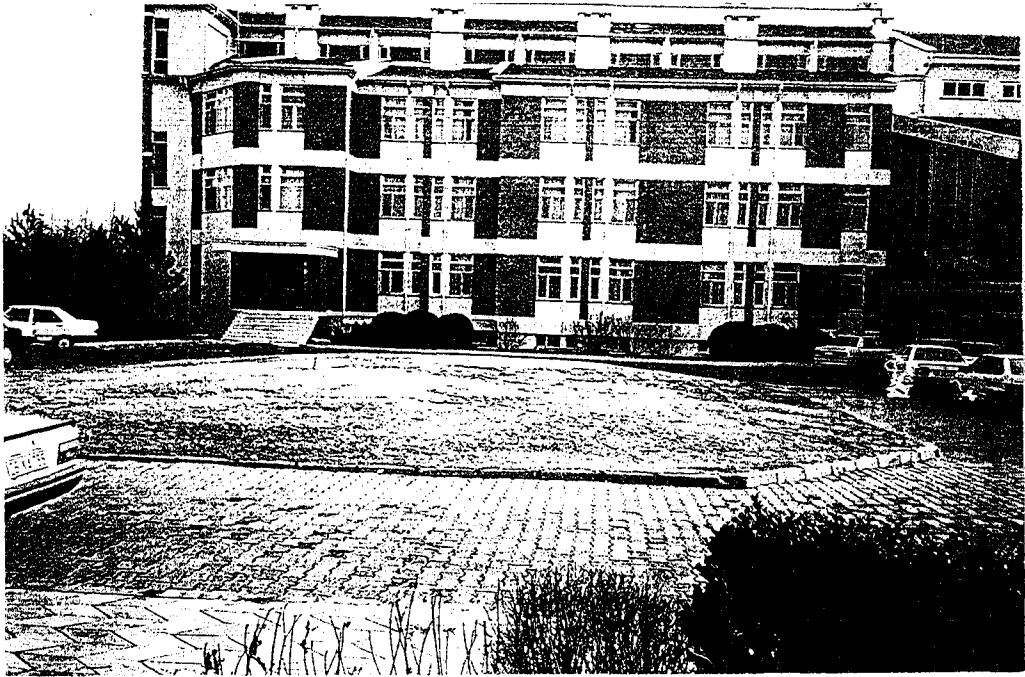
Mozaik Havuz Uygulama Mekanı
