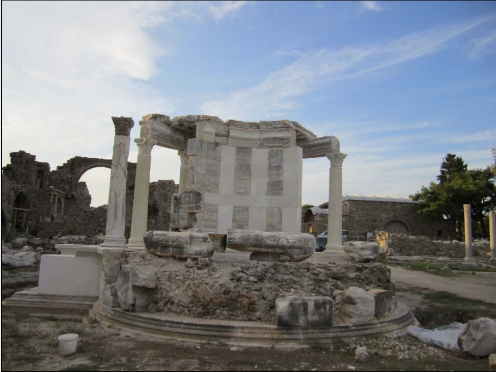
2. Tykhe Tapınağı Ayağa Kaldırma Uygulaması
