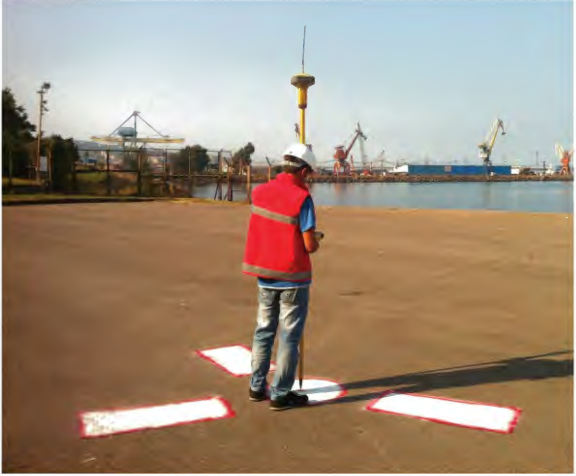
Görsel 2.1. YKN tesisi ve ölçümü
