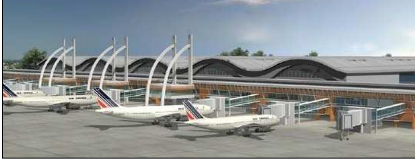
Şekil 25. Sabiha Gökçen Havalimanı Dış Hatlar Terminali
