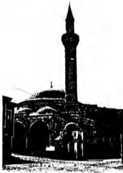
Fotoğraf No:1 Kurşunlu Cami Kuzey ve Batı Cephe Bölümü (1988) (Erol ALTINSAPAN)
