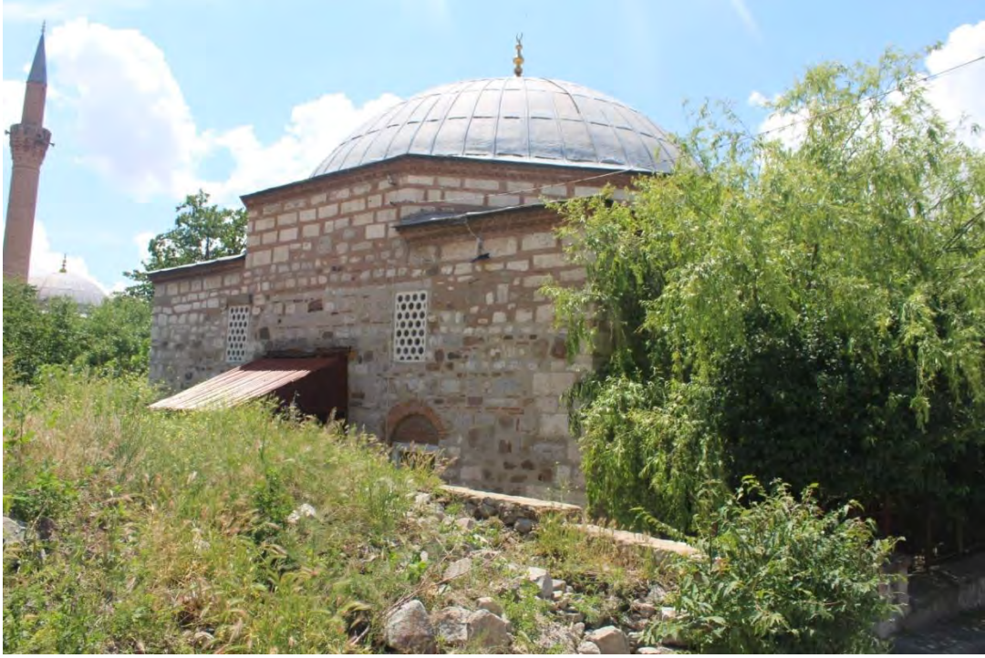
Fotoğraf No:21 Hazinedar Cami Kuzey Cephe Bölümü(2017) (Sinan ÜNAL)
