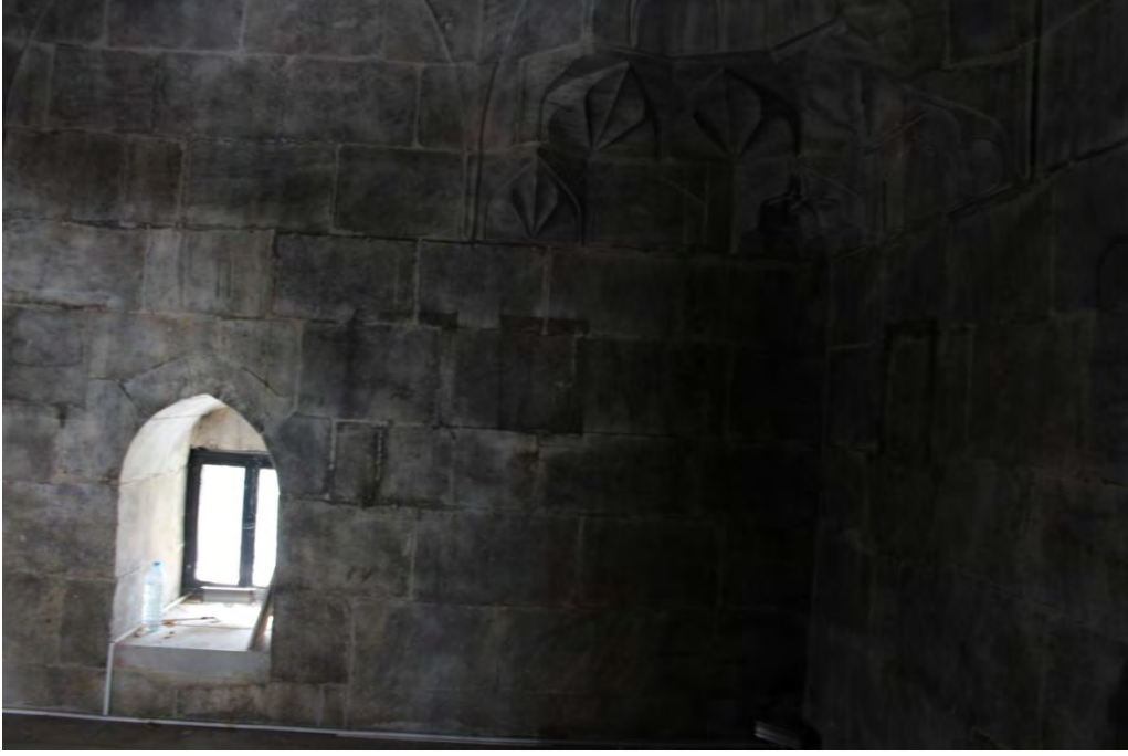
Fotoğraf No:16 Alemşah Türbesi Mescid Kuzey Cephe Bölümü(2017) (Sinan ÜNAL)
