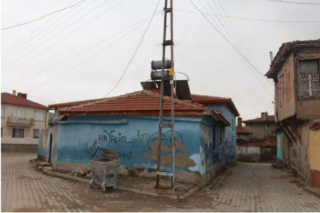
Fotoğraf No:6 Elmalı Cami Kuzey Ve Batı Cephe Bölümü(2017) (Sinan ÜNAL)
