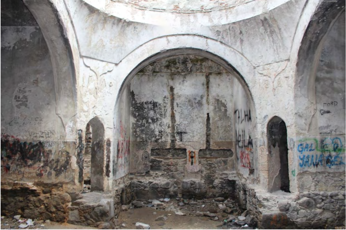
Fotoğraf No:10 Gavur(Ermeni) Hamamı Sıcaklık Bölümü (2017) (Sinan ÜNAL)
