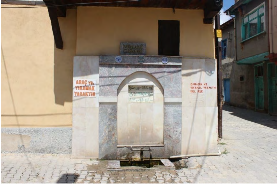
Fotoğraf No:1 Nemane Çeşme Güney Cephe Bölümü(2017) (Sinan ÜNAL)
