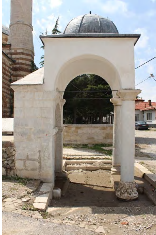
Fotoğraf No:5 Kurşunlu Çeşme Güney Cephe Bölümü (2017) (Sinan ÜNAL)
