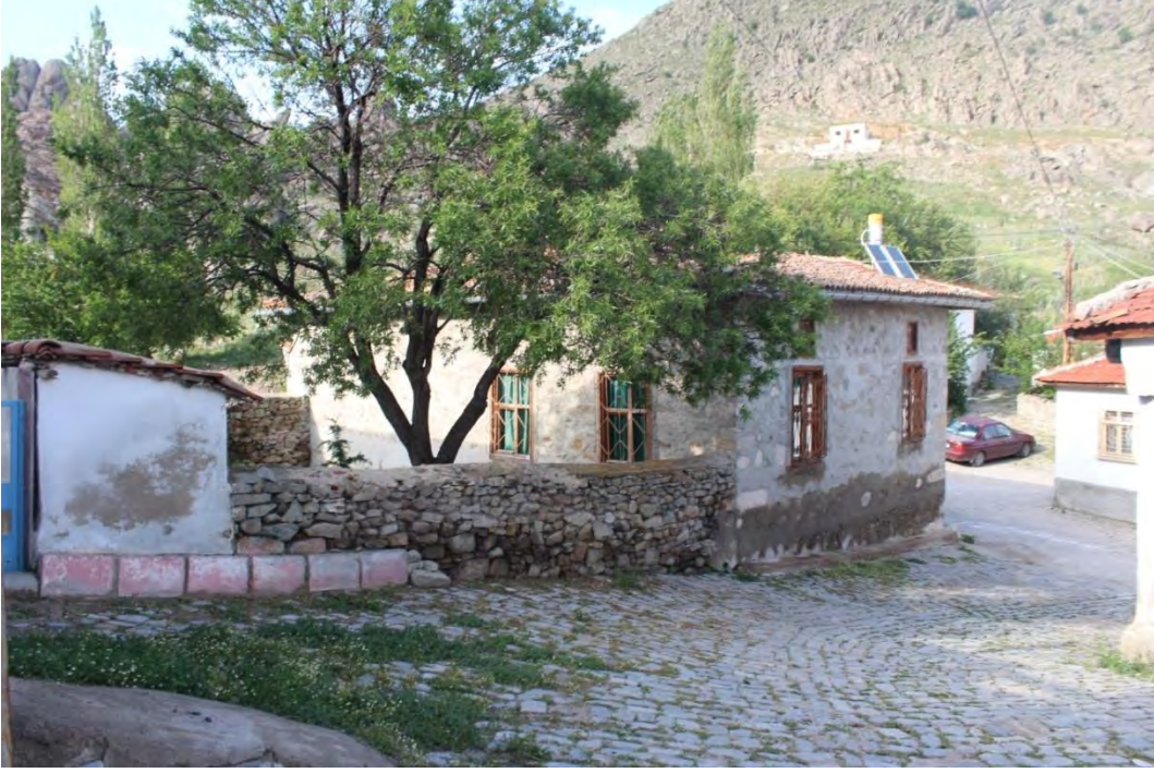
Fotoğraf No:16 Akdoğan Mescidi Batı Ve Güney Cephe Bölümü İle Avlu Bölümü(2017) (Sinan ÜNAL)
