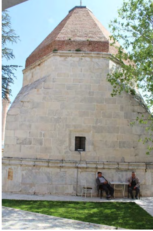
Fotoğraf No:10 Alemşah Türbesi Kuzey Cephe Bölümü (2017) (Sinan ÜNAL)
