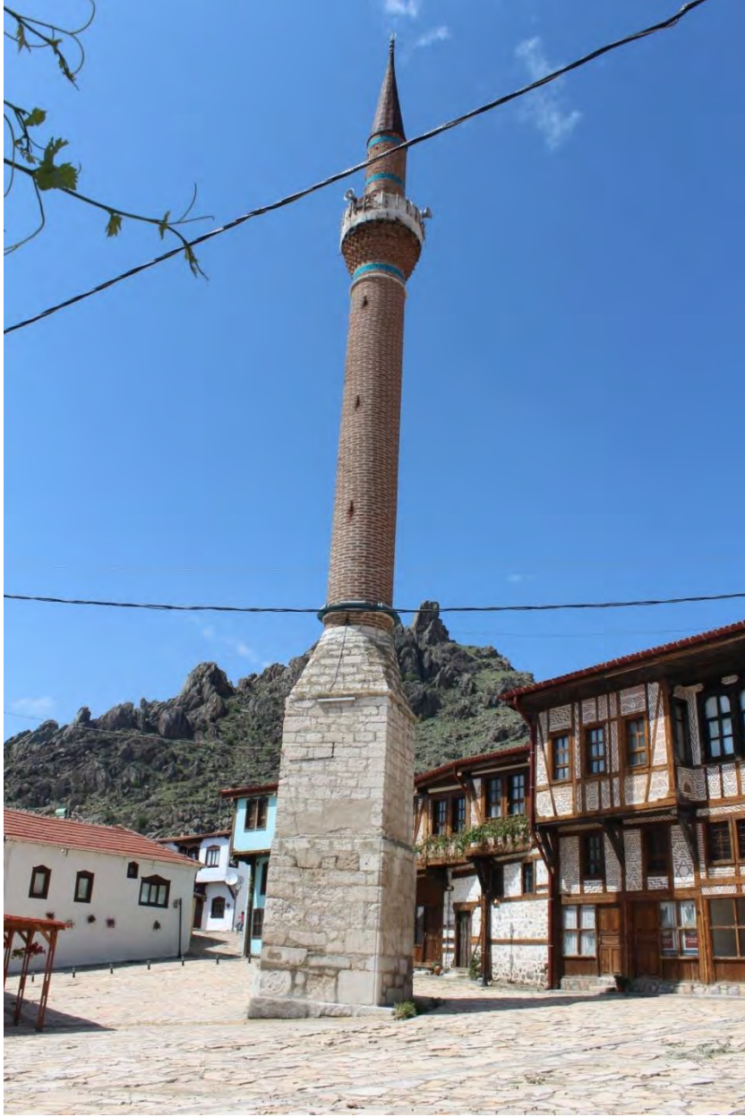
Fotoğraf No:8 Kılıç Mescit Minaresi Doğu Cephe Bölümü(2017) (Sinan ÜNAL)
