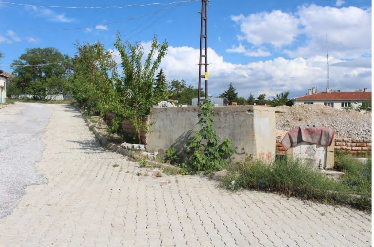
Fotoğraf No:4 Acı Çeşme Güney Ve Doğu Cephe Bölümü(2017) (Sinan ÜNA)
