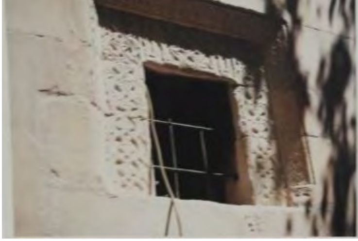
Fotoğraf No:5 Alemşah Türbesi Batı Cephe Pencere Bölümü(2000) (EKVKBKMA)
