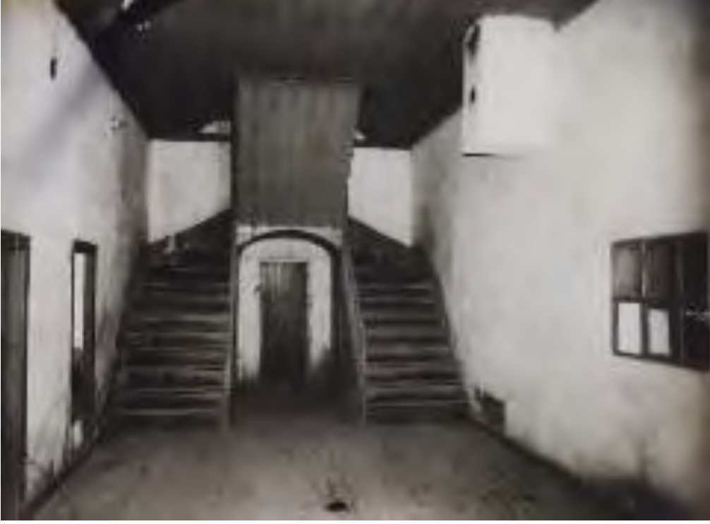
Fotoğraf No:3 Askerlik Şubesi 2 Nolu Yapı Zemin Kat(1987) (EKVKBKMA)
