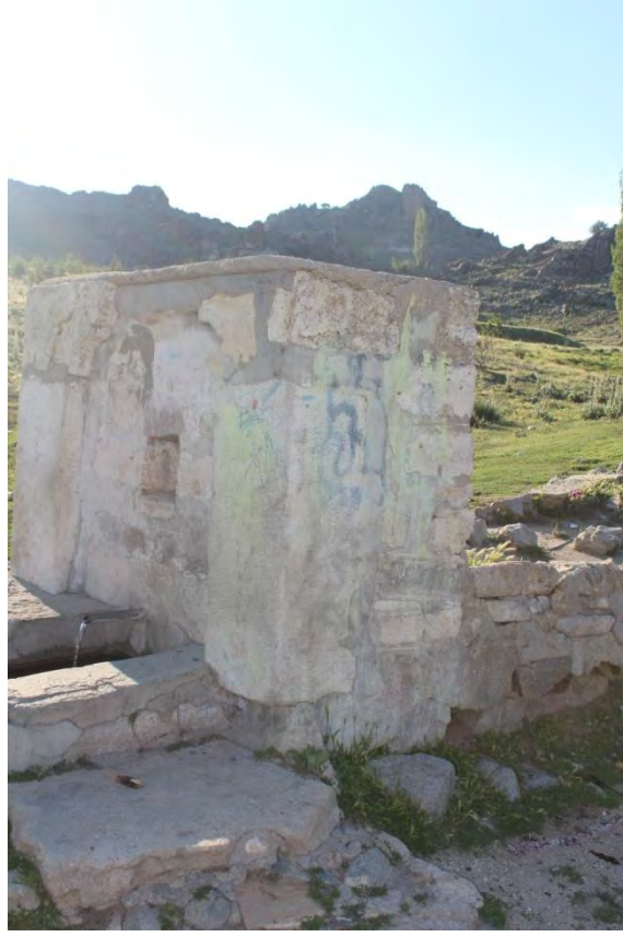
Fotoğraf No:2 Çoban Çeşmesi Ön Cephe İle Yan Cephe Bölümü(2018) (Sinan Ünal)
