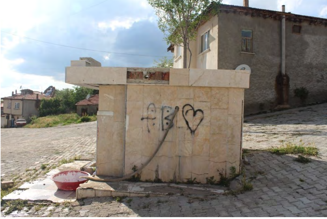
Fotoğraf No:4 Garip Çeşme Doğu Cephesi (2017) (Sinan ÜNAL)
