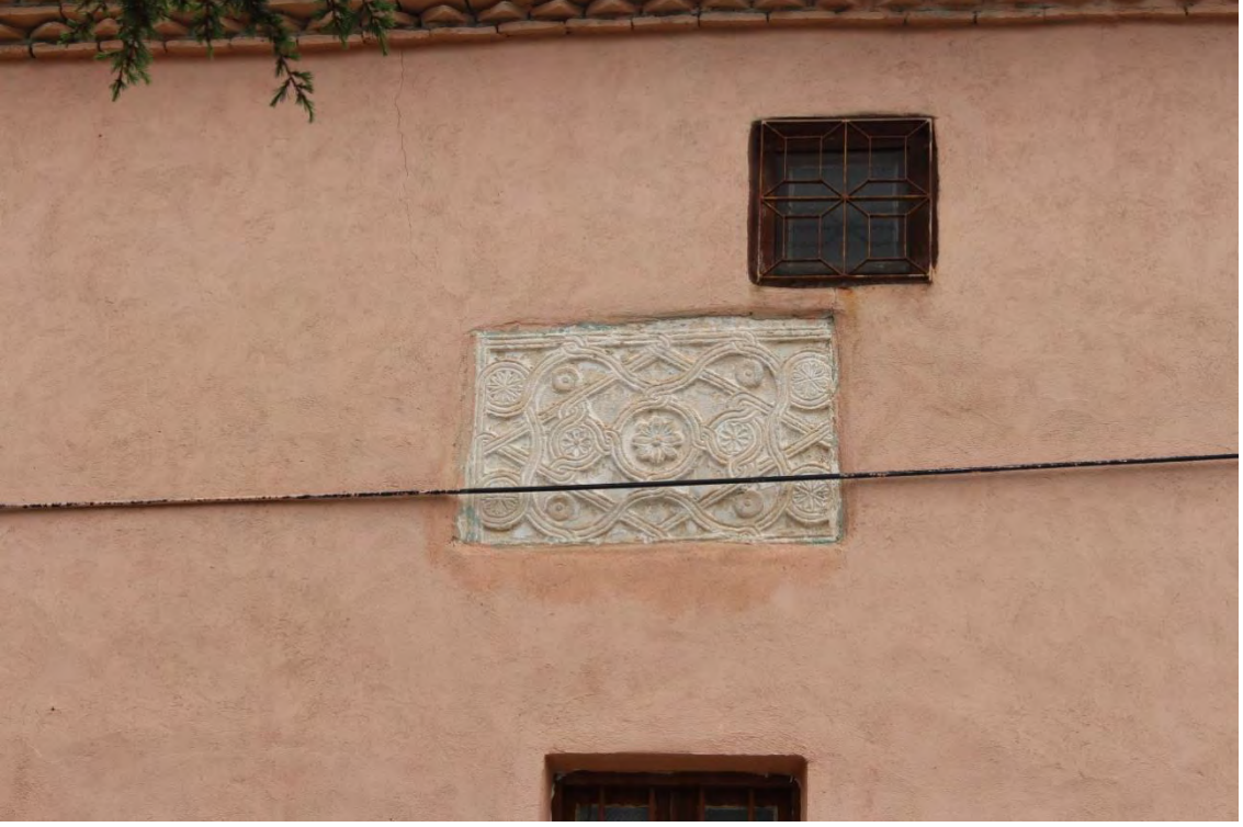
Fotoğraf No:31 Balaban Cami Güney Cephe Bölümü Devşirme Malzeme(2017) (Sinan ÜNAL)
