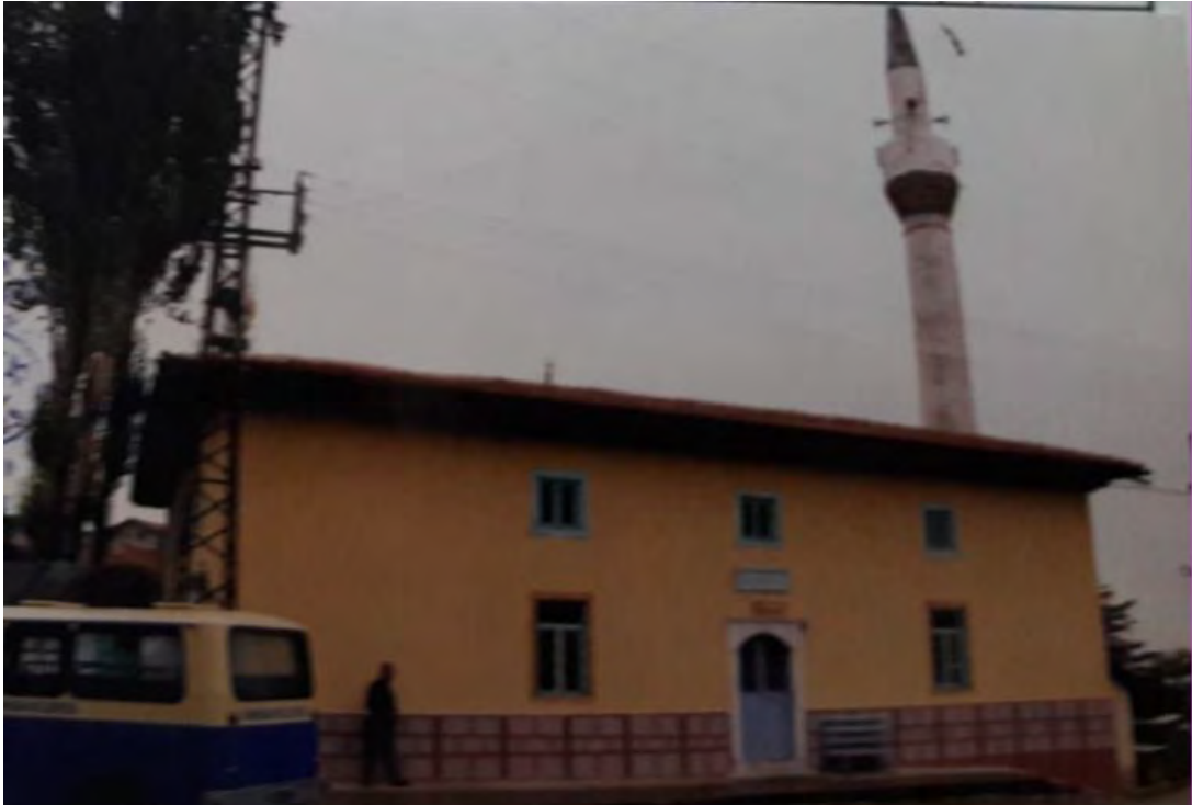
Fotoğraf No:5 Yenice Cami Kuzey Cephe Bölümü (2003) (EKVKBKMA)
