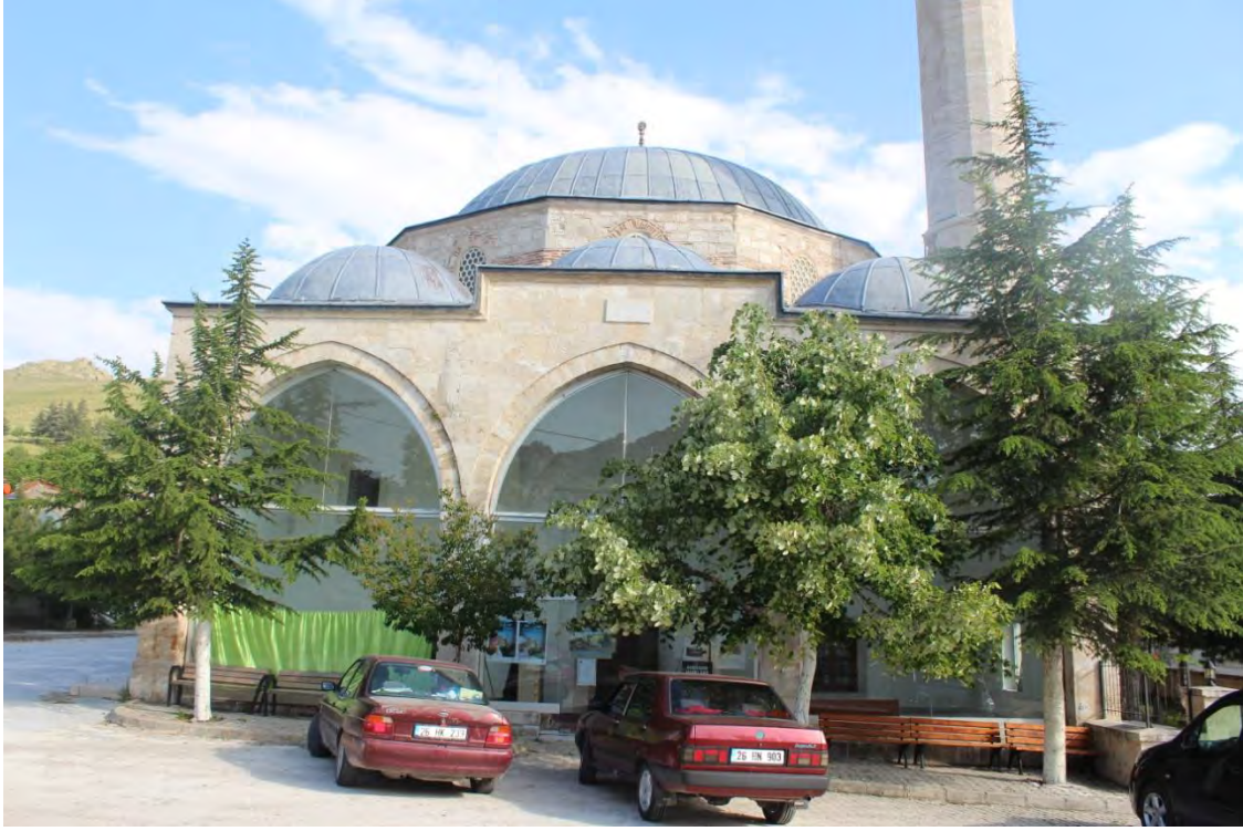
Fotoğraf No:24 Kurşunlu Cami Kuzey Cephe Bölümü (2017) (Sinan ÜNAL)
