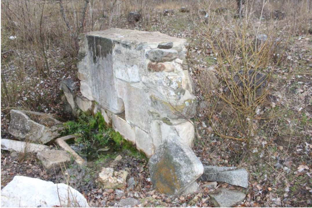
Fotoğraf No:4 Porsuk Çeşmesi Ön Cephe ve Yan Cephe Görünümü(2018) (Sinan Ünal)
