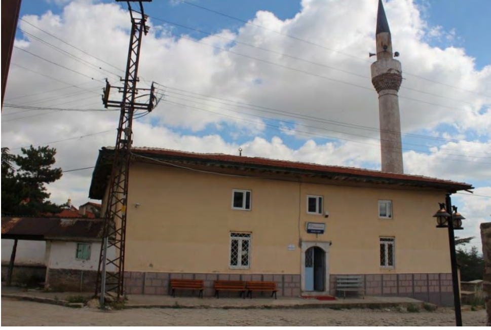
Fotoğraf No:6 Yenice Cami Kuzey Cephe Bölümü (2017) (Sinan ÜNAL)
