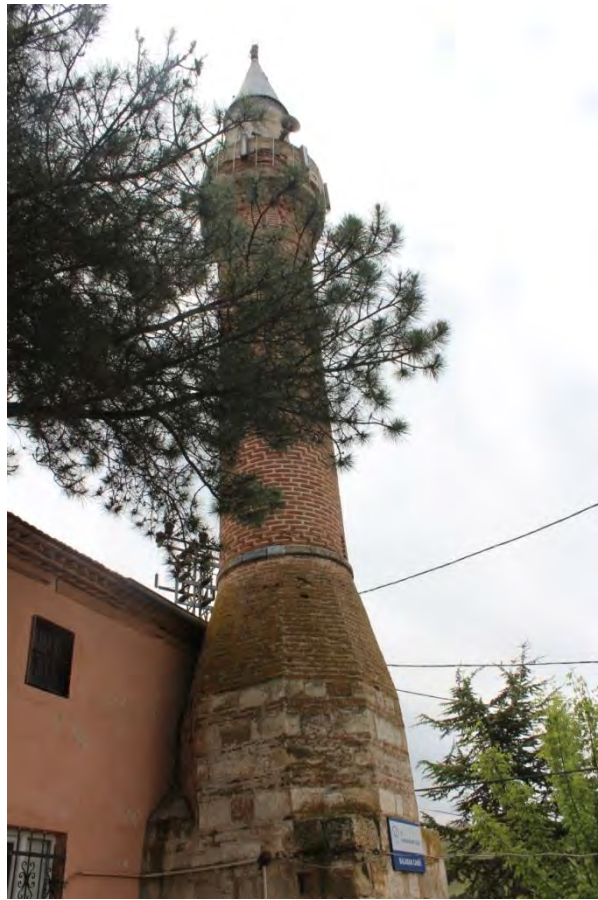
Fotoğraf No:16 Balaban Cami Minare Bölümü (2017) (Sinan ÜNAL)
