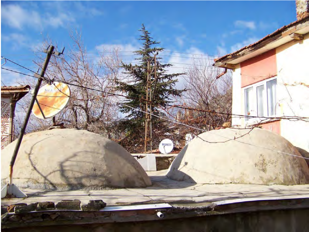
Fotoğraf No:3 Sinan Paşa Hamamı Kubbe Bölümleri (2017) (Koray Faydacı)
