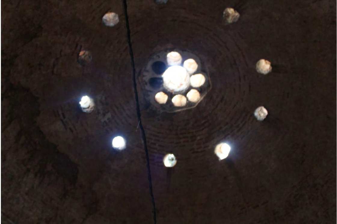
Fotoğraf No:7 Yeni(Çifte)Hamam Sıcaklık Bölümü Kubbesi (2017) (Sinan ÜNAL)
