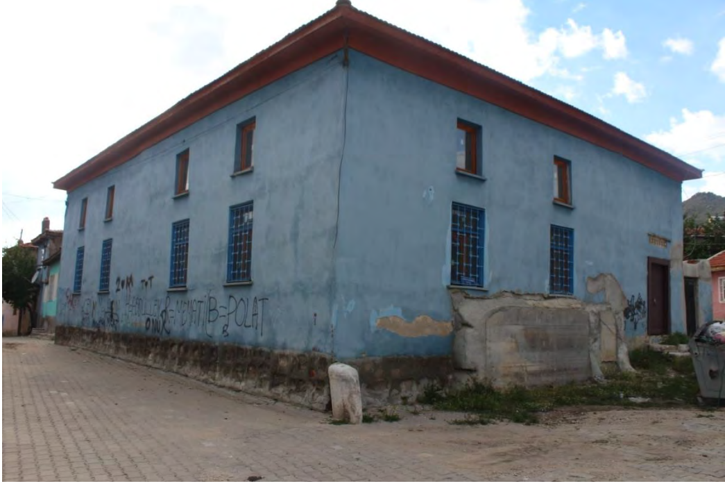
Fotoğraf No:5 Elmalı Cami Doğu ve Kuzey Cephe Bölümü(2017) (Sinan ÜNAL)
