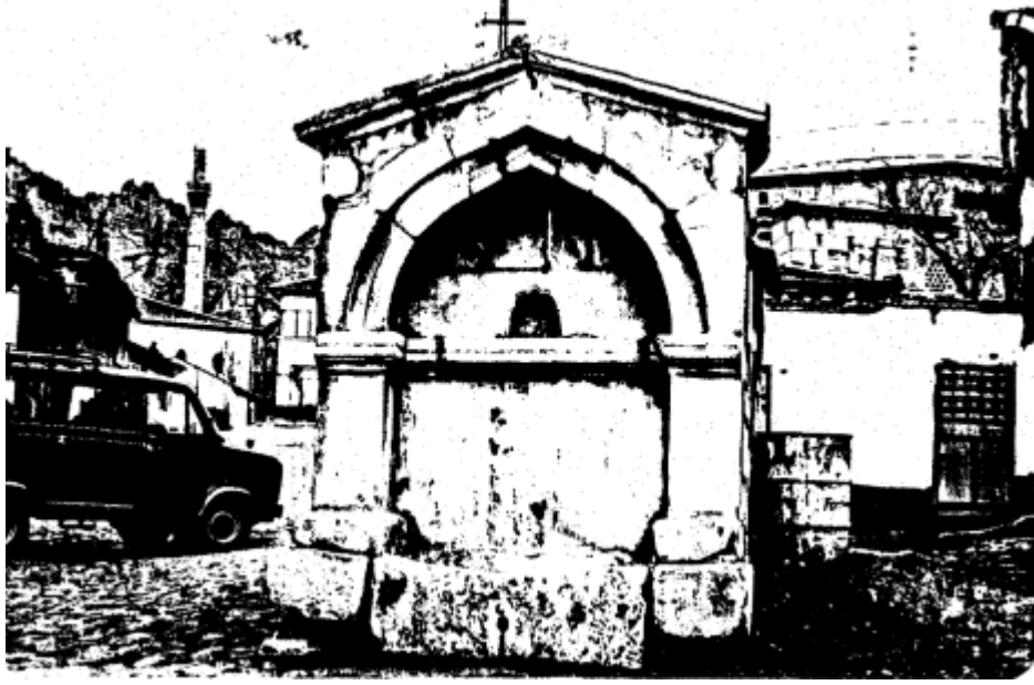
Fotoğraf No:1 Ak Çeşme Kuzey Cephe Bölümü(1988) (Erol ALTINSAPAN)
