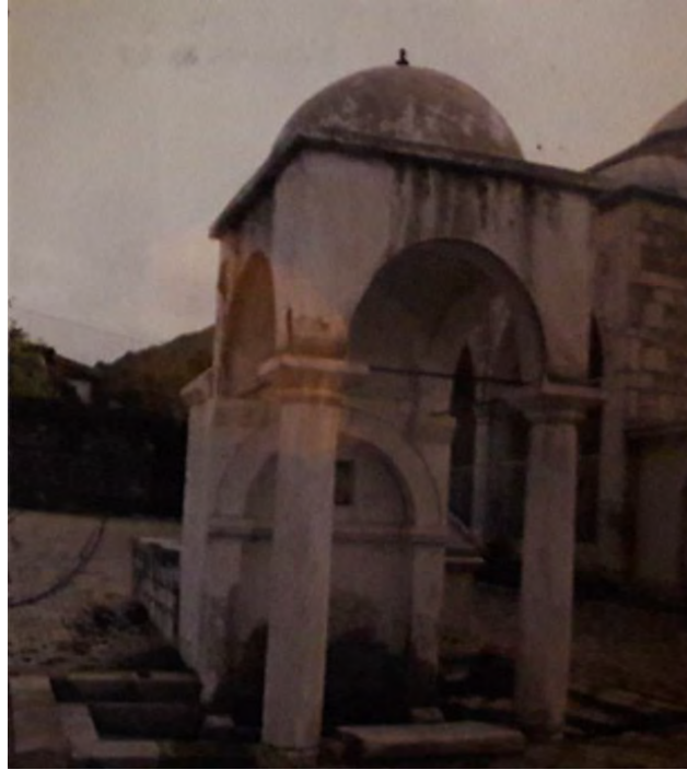
Fotoğraf No:3 Kurşunlu Çeşmesi Doğu Cephe Bölümü(2003) (EKVKBKMA)
