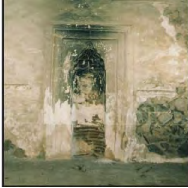
Fotoğraf No:9 Mahmud Suzani Türbesi Mihrap Cephe Bölümü(2006) (Erol ALTINSAPAN)
