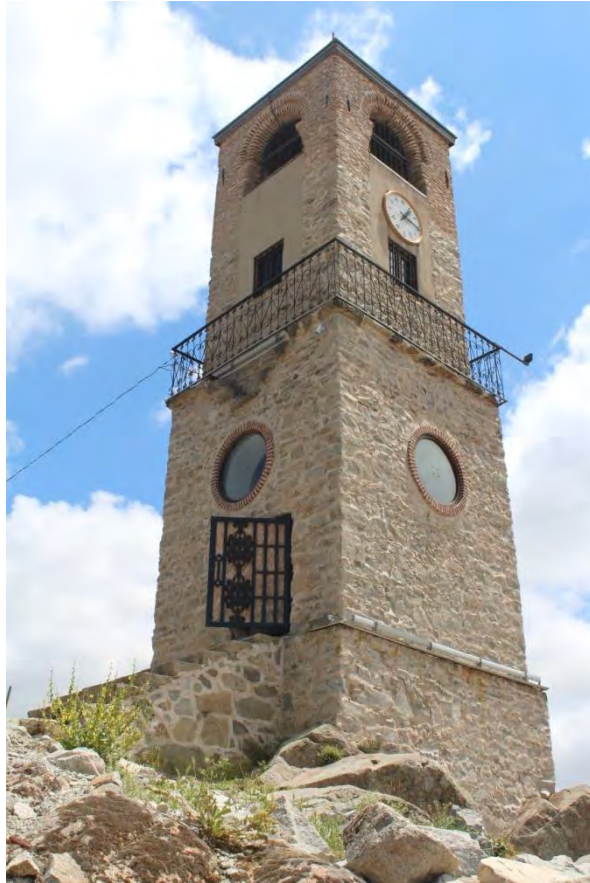
Fotoğraf No:13 Sivrihisar Saat Kulesi Kuzey ve Batı Cephe Bölümü(2017) (Sinan ÜNAL)
