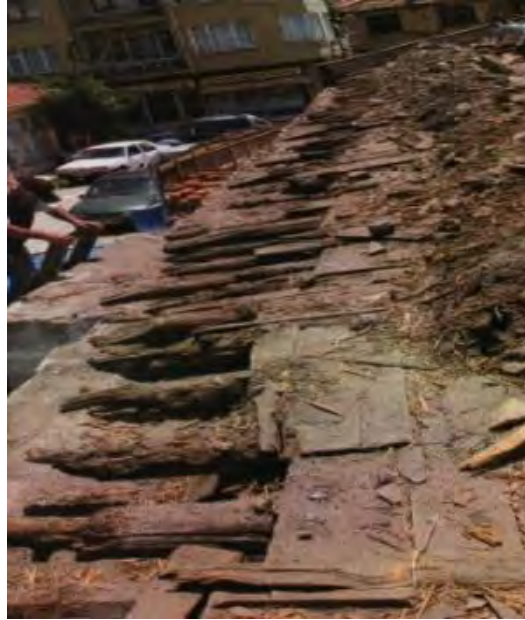
Fotoğraf No:14 Ulu Cami Çatı Örtü Sistemi Tahribatlarının Giderilmesi(2013) (EKVKBKMA)
