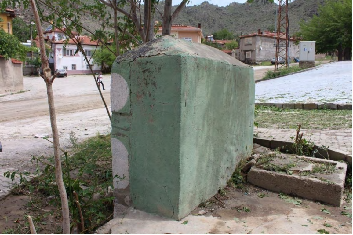
Fotoğraf No:5 Demirci eşme Batı-Kuzey Cephe İle Su Deposu (2017) (Sinan ÜNAL)
