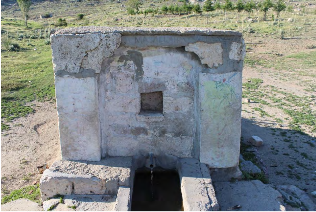
Fotoğraf No:1 Çoban Çeşmesi Ön Cephe Bölümü(2018) (Sinan Ünal)
