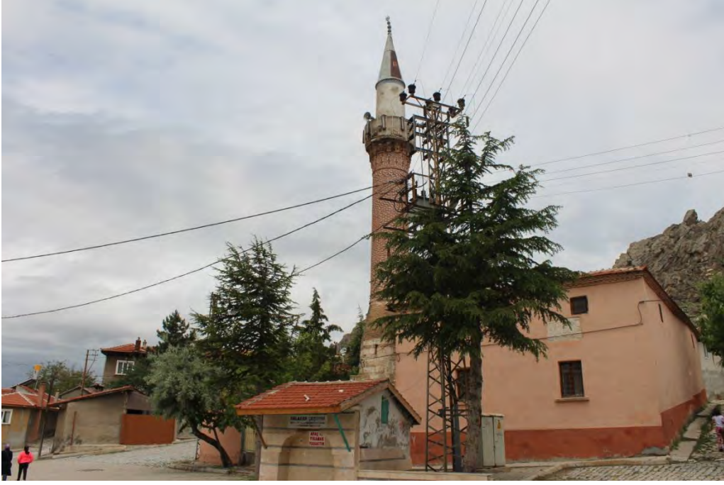
Fotoğraf No:13 Balaban Cami Doğu ve Güney Cephe Bölümü (2017) (Sinan ÜNAL)
