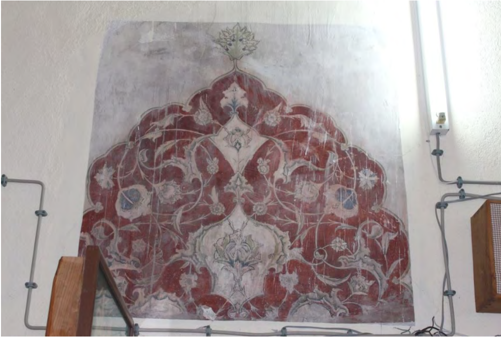
Fotoğraf No:38 Hazinedar Cami Harim Batı Cephe Bölümü Kalem İşi(Minber Sağ Üst)(2017) (Sinan ÜNAL)
