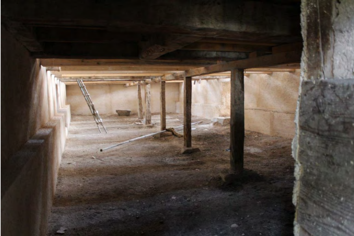
Fotoğraf No:10 Askerlik Şubesi 2 Nolu Yapı Bodrum Bölümü(2017) (Sinan ÜNAL)
