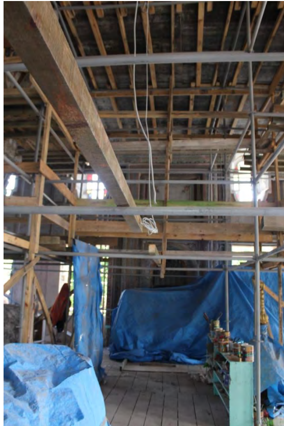
Fotoğraf No:23 Yeni Cami Harim Güney Cephe Bölümü(2017) (Sinan ÜNAL)
