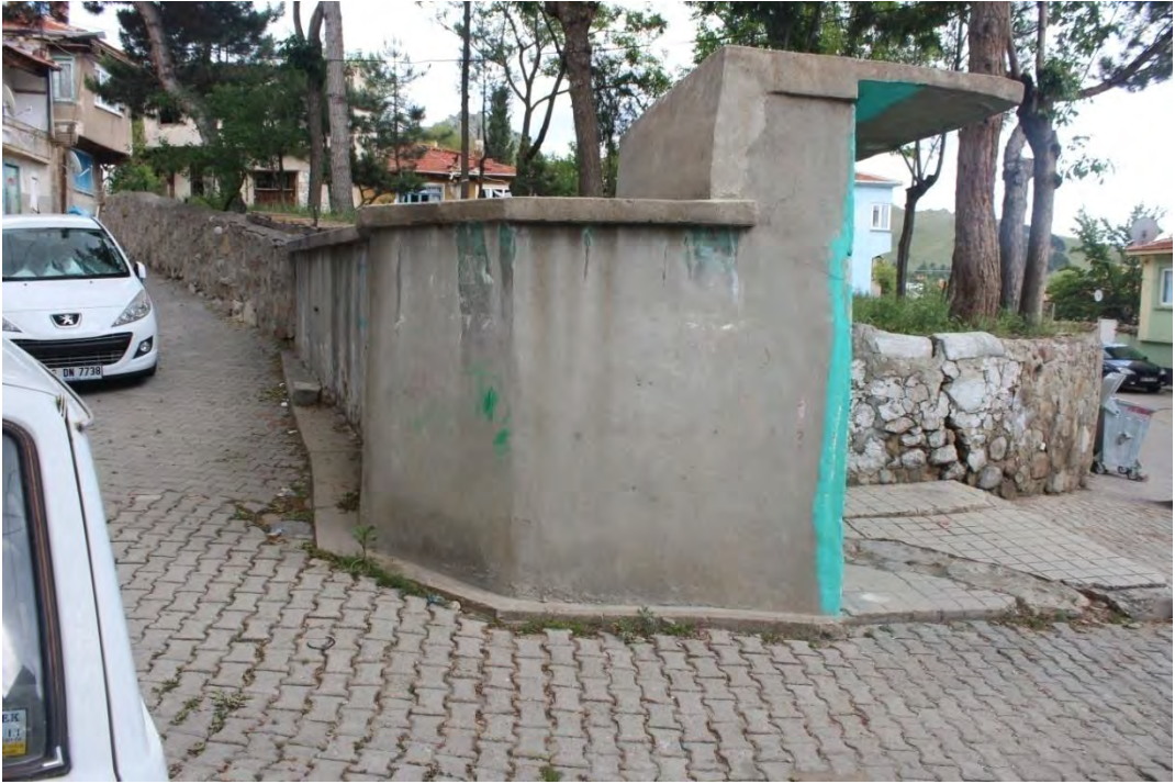
Fotoğraf No:7 Mavi Kadın Çeşmesi Batı Cephesi (2017) (Sinan ÜNAL)
