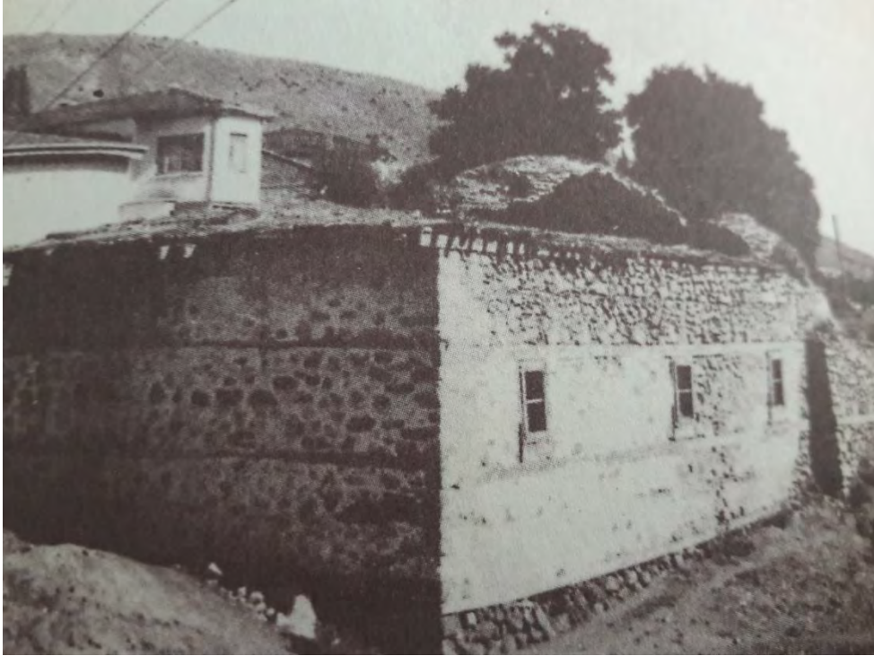
Fotoğraf No:2 Seydiler Hamamı Restorasyon Öncesi(1965) (Orhan KESKİN)
