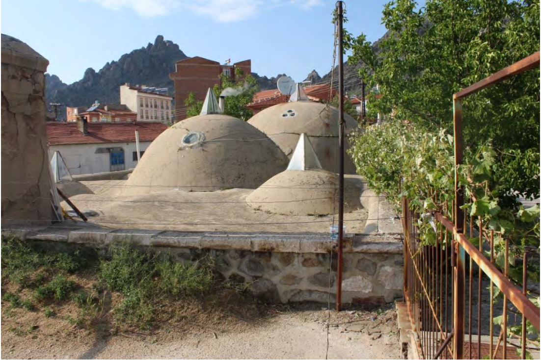
Fotoğraf No:10 Seydiler Hamamı Örtü Sistemleri (2017) (Sinan ÜNAL)
