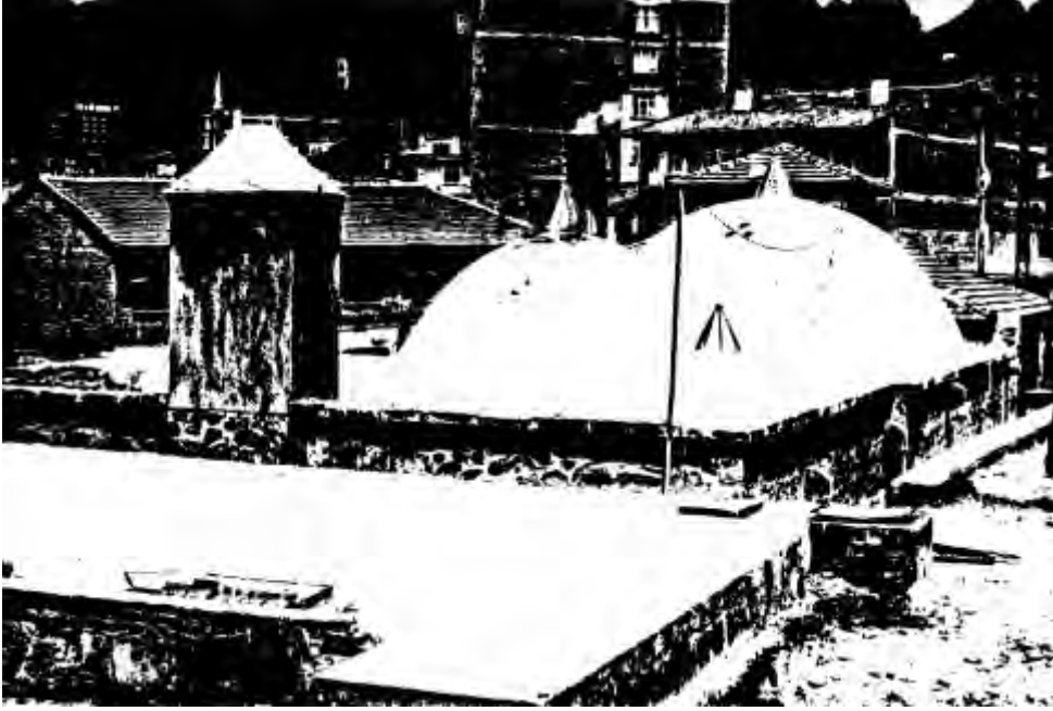
Fotoğraf No:6 Seydiler Hamamı Doğu Ve Güney Cephe Bölümü(1988) (Erol ALTINSAPAN)
