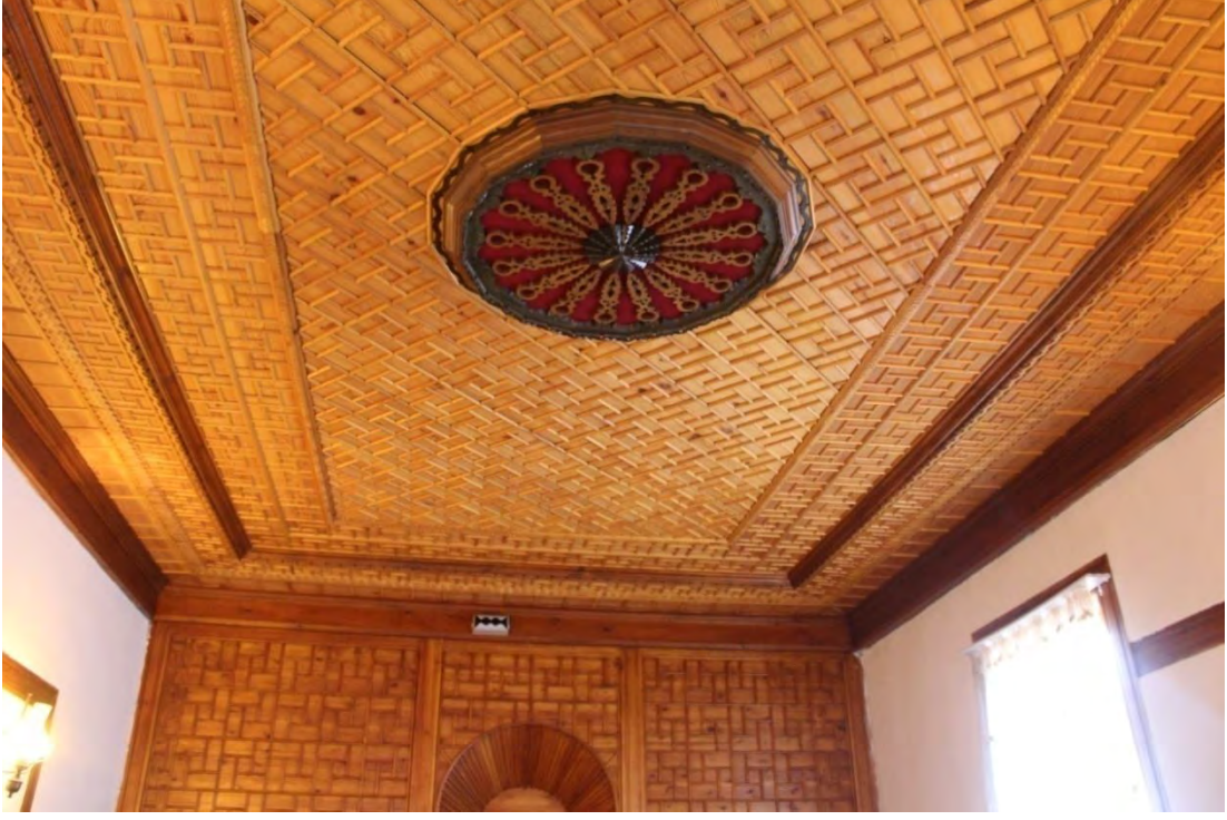
Fotoğraf No:23 Zaim Ağa Konağı Birinci Kat Kuzeybatı Oda Bölümü 2017) (Sinan ÜNAL)
