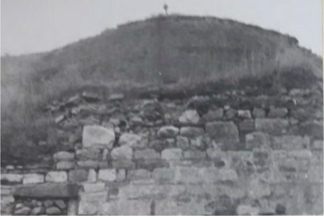
Fotoğraf No:3 Hazinedar Cami Kubbe Bölümü(1964) (EKVKBKMA)
