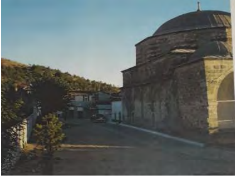
Fotoğraf No:6 Kurşunlu Cami Doğu Cephe Bölümü Onarım Öncesi(2008) (EKVKBKMA)
