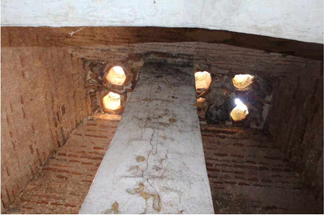
Fotoğraf No:8 Yeni(Çifte)Hamam Baca Bölümü Ve Fil Gözleri (2017) (Sinan ÜNAL)
