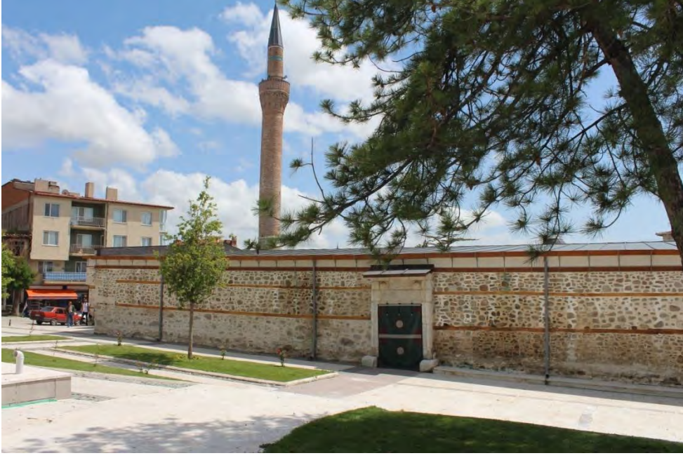
Fotoğraf No:16 Ulu Cami Kuzey Cephe Bölümü (2017) (EKVKBKMA)
