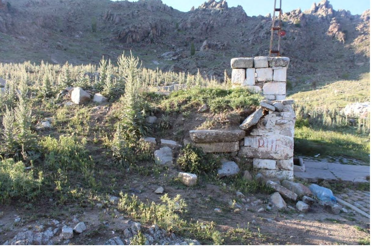
Fotoğraf No:4 Üçpınar Çeşmesi Güney Cephe Ve Su Deposu Bölümü(2017) (Sinan ÜNAL)
