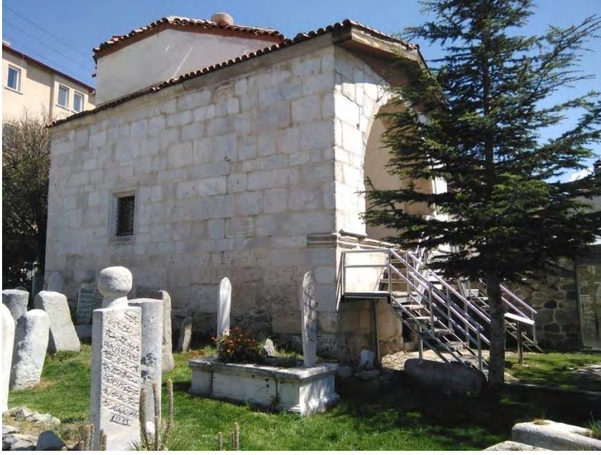
Fotoğraf No:13 Mahmud Suzani Türbesi Kuzey Ve Batı Cephe Bölümü (2017) (Sinan ÜNAL)
