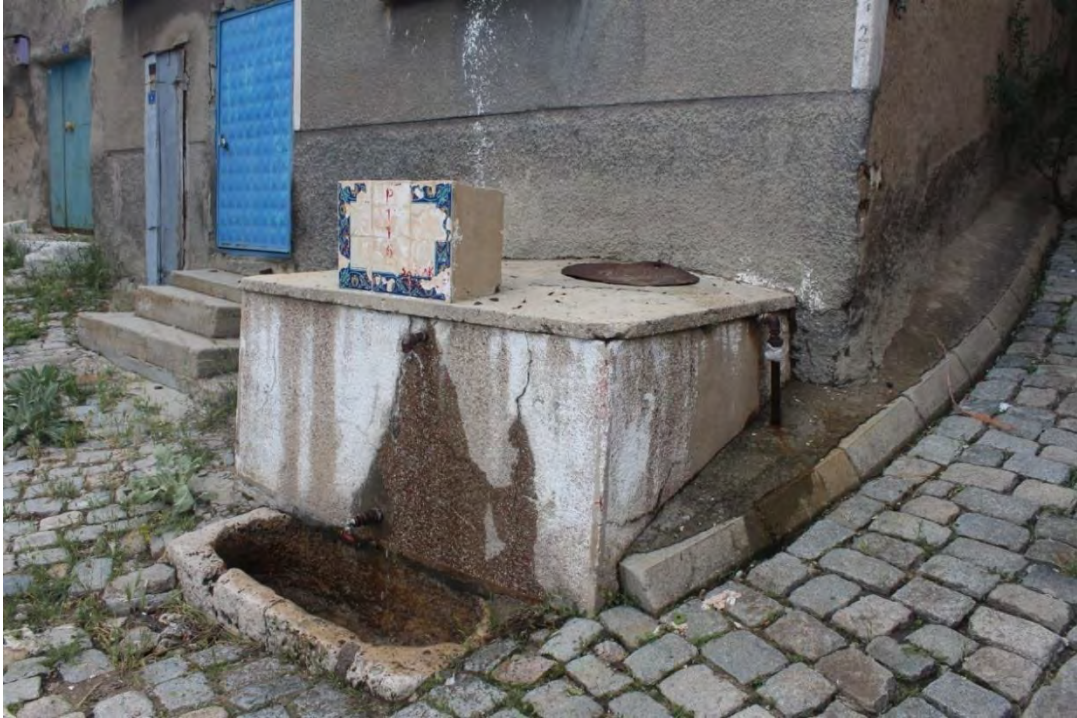
Fotoğraf No:4 Hörhör Çeşmesi Kuzey,Doğu Cepheleri Ve Su Deposu(2017) (Sinan ÜNAL)
