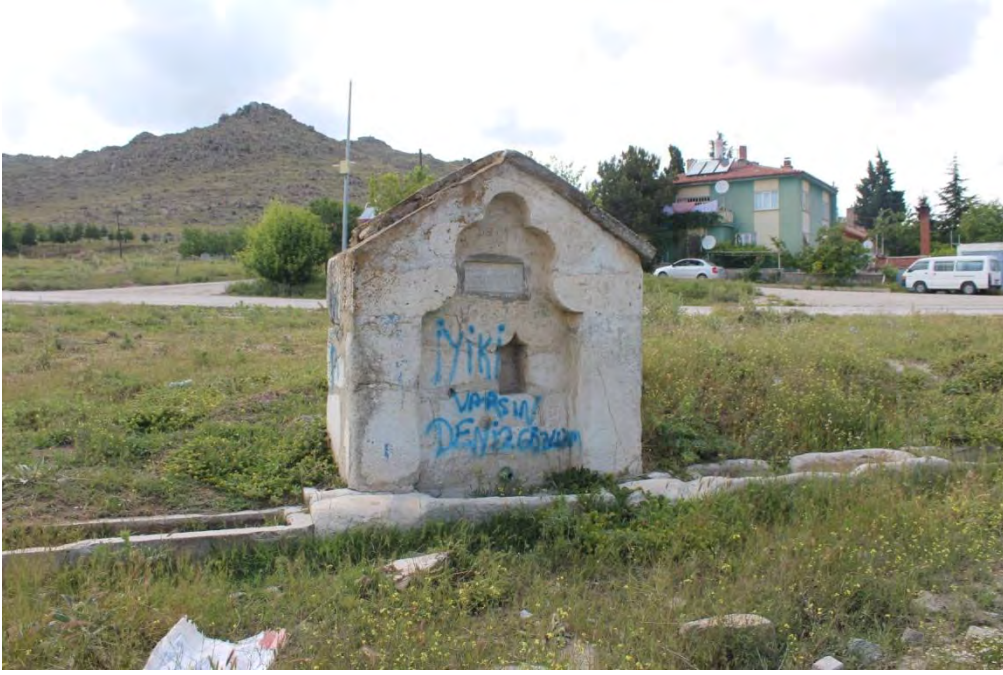
Fotoğraf No:2 Garipçe Çeşme Doğu Cephe Bölümü(2017) (Sinan ÜNAL)
