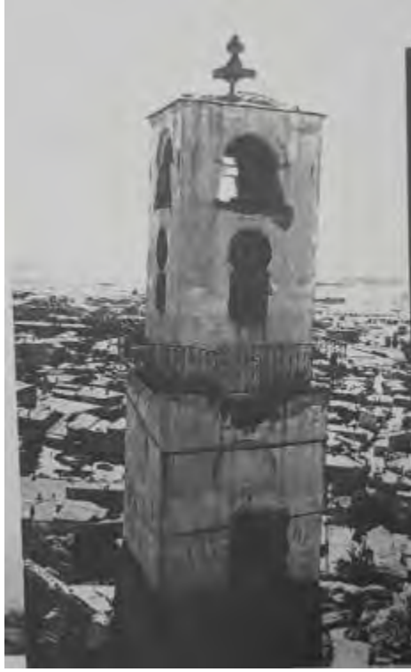
Fotoğraf No:2 Sivrihisar Saat Kulesi Kuzey Cephe Bölümü(1988) (EKVKBKMA)
