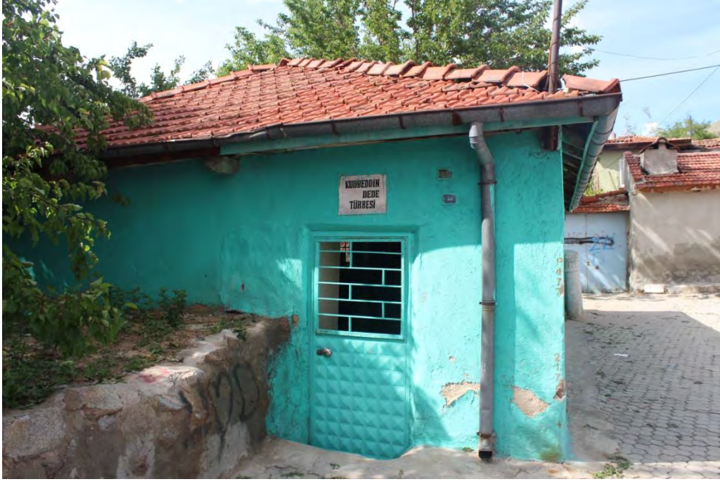
Fotoğraf No:2 Kudbeddin Dede Türbesi Güney Cephe Bölümü(2017) (Sinan ÜNAL)
