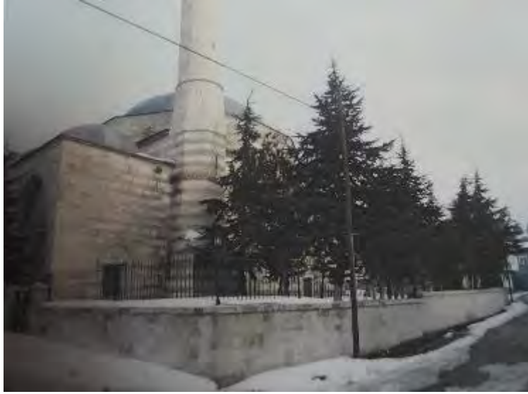
Fotoğraf No:11 Kurşunlu Cami Batı Cephe Bölümü Muhdes Yapı Onarım Sonrası(2012) (EKVKBKMA)
