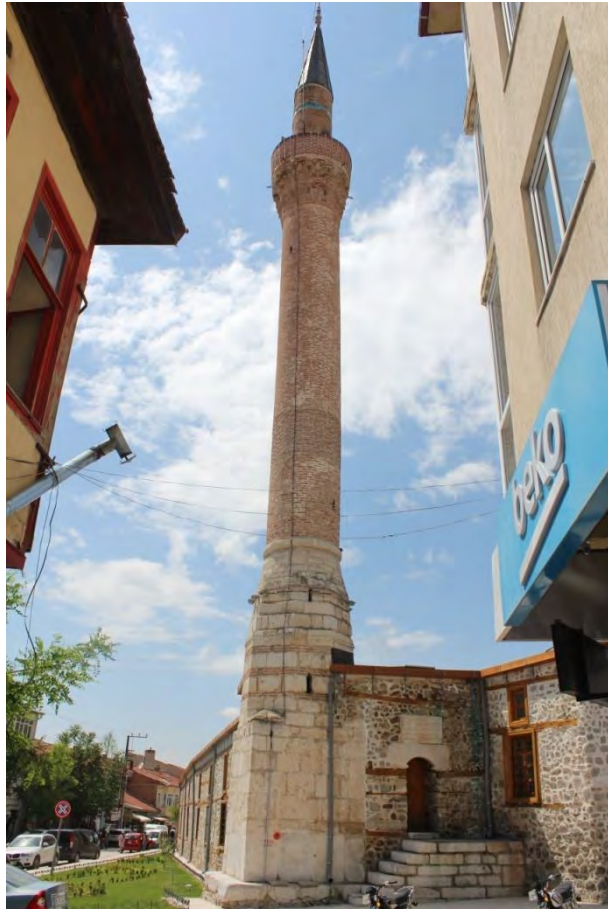
Fotoğraf No:27 Ulu Cami Minare Bölümü(2017) (Sinan ÜNAL)
