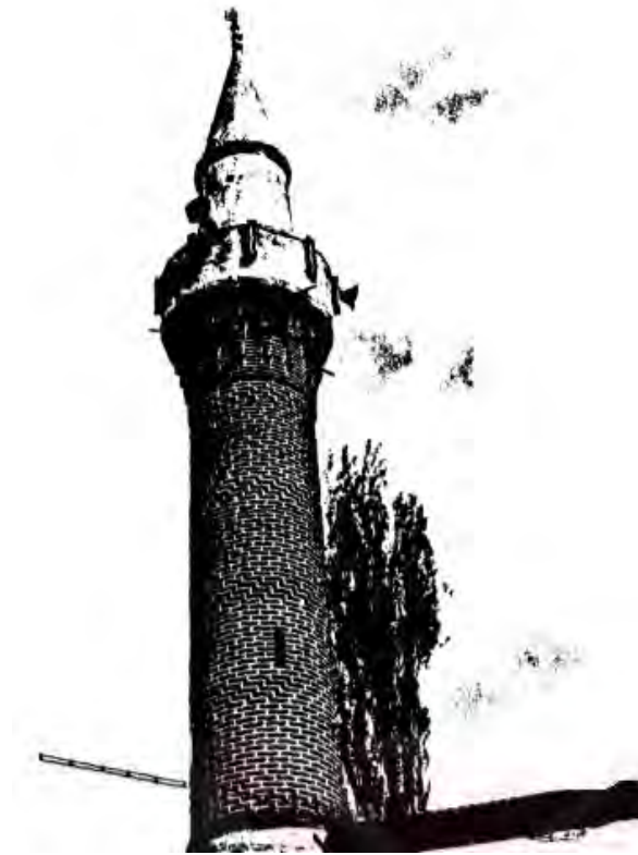
Fotoğraf No:4 Balaban Cami Minare Bölümü (1988) (Erol ALTINSAPAN)
