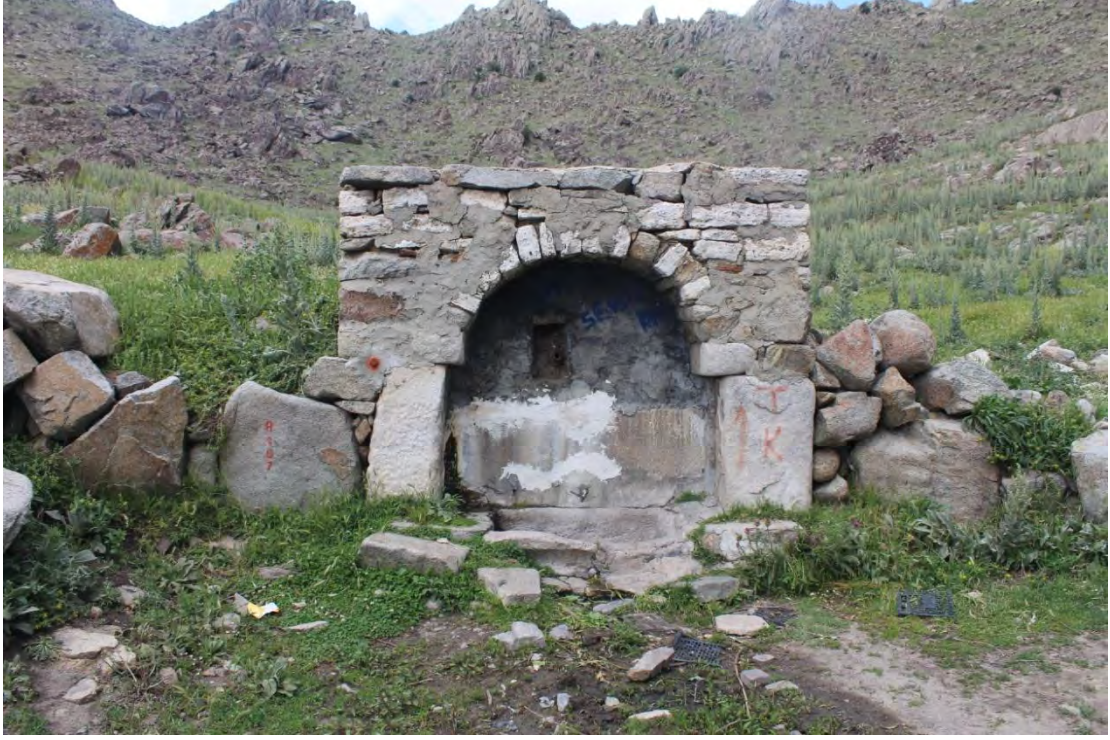
Fotoğraf No:1 Hasancık Çeşme Güney Cephe Bölümü(2017) (Sinan ÜNAL)
