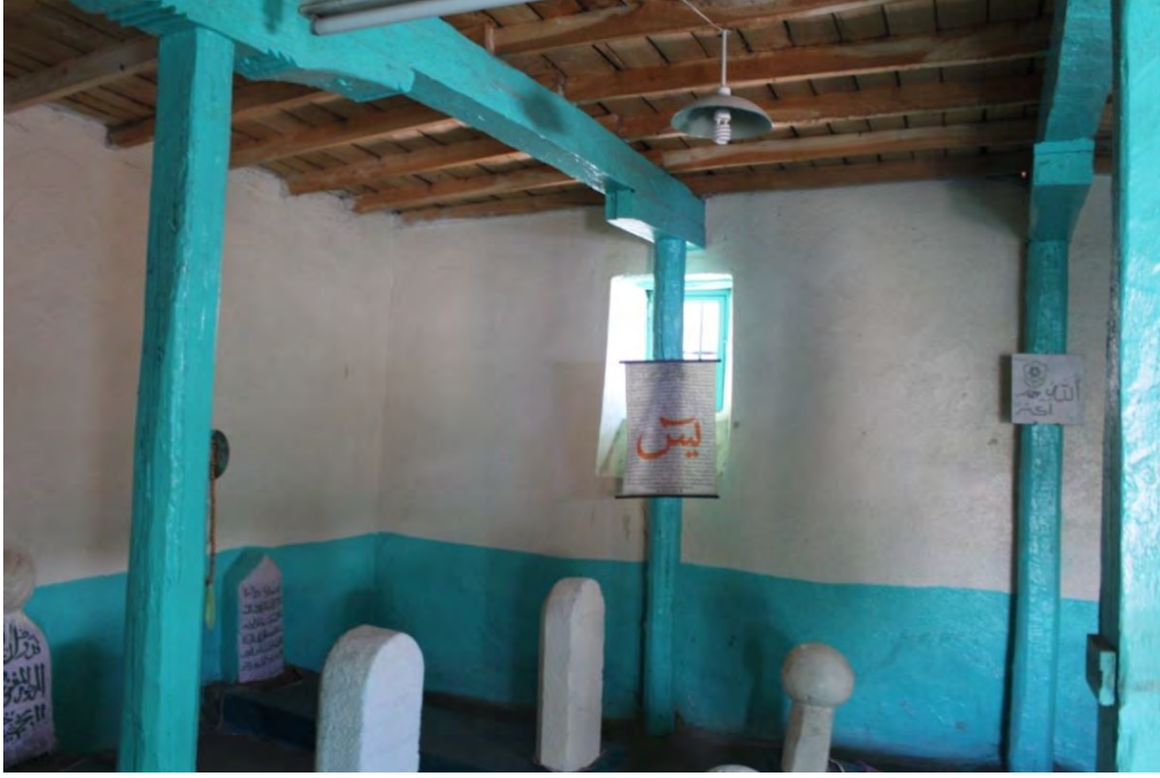
Fotoğraf No:4 Kudbeddin Dede Türbesi Kuzey Ve Batı Cephe Bölümü(2017) (Sinan ÜNAL)
