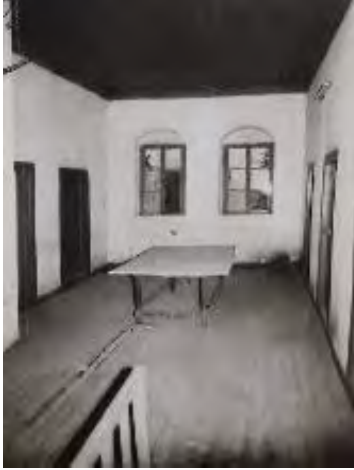
Fotoğraf No:5 Askerlik Şubesi 2 Nolu Yapı Birinci Kat Kuzey Yönde Yer Alan Oda(1987) (EKVKBKMA)
