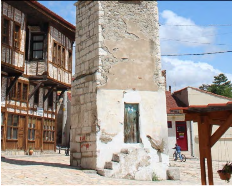
Fotoğraf No:7 Kılıç Mescit Minaresi Güney Cephe Giriş Açıklığı Bölümü (1997) (Sinan ÜNAL)
