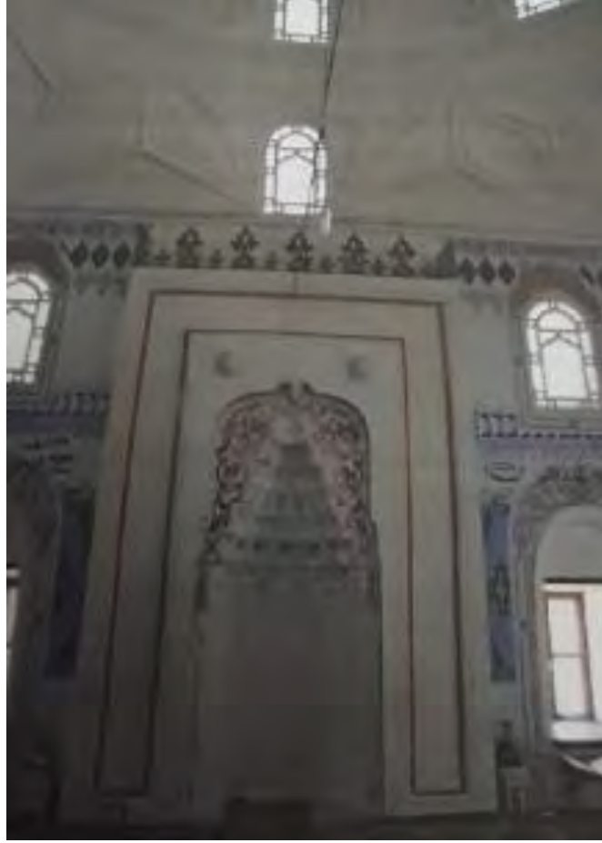
Fotoğraf No:17 Kurşunlu Cami Mihrap Bölümü Onarım Sonrası(2012) (EKVKBKMA)
