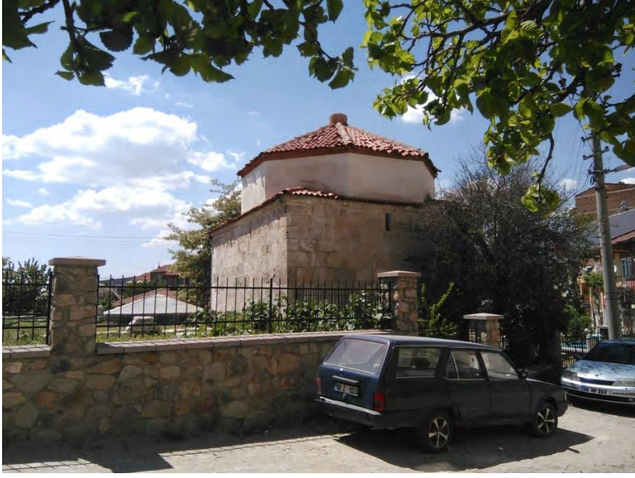
Fotoğraf No:15 Mahmud Suzani Türbesi Güney Ve Doğu Cephe Bölümü (2017) (Sinan ÜNAL)
