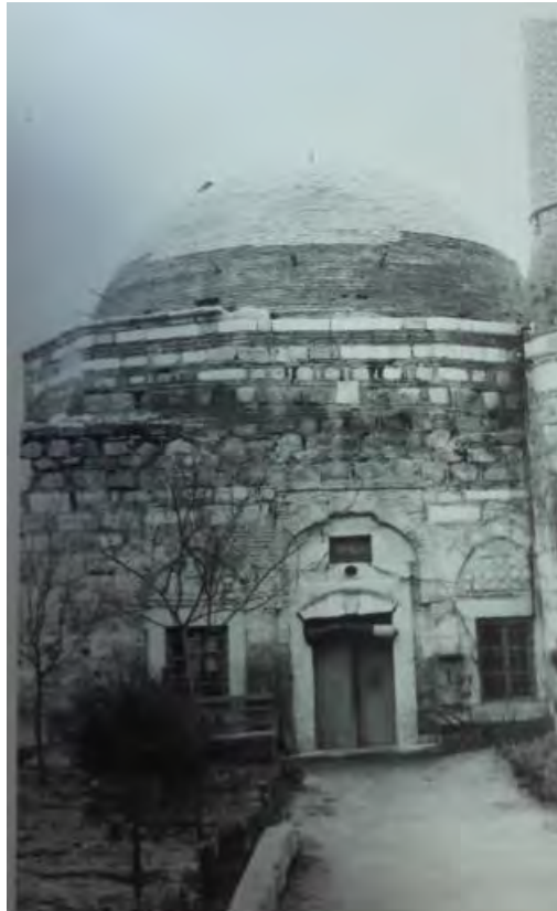
Fotoğraf No:1 Hoşkadem Cami Kuzey Cephe Bölümü(1952'lı Yıllar) (EKVKBKMA)
