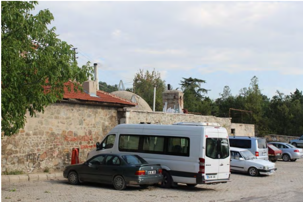
Fotoğraf No:8 Seydiler Hamamı Kuzey Cephe Bölümü(2017) (Sinan ÜNAL)
