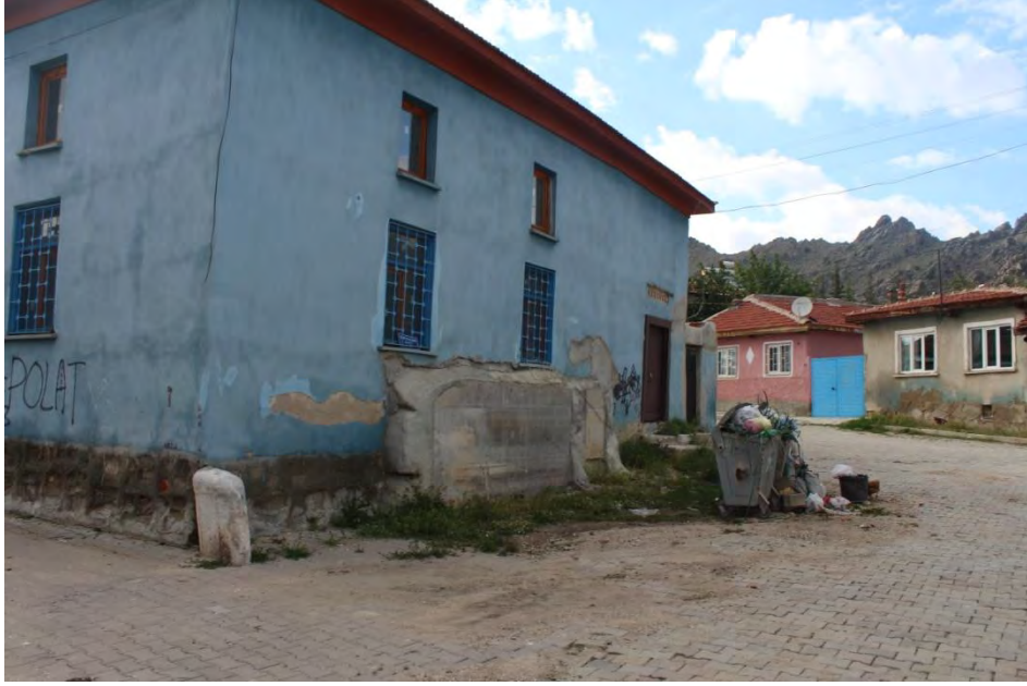
Fotoğraf No:2 Elmalı Çeşme Doğu Cephe Bölümü(2018) (Sinan ÜNAL)
