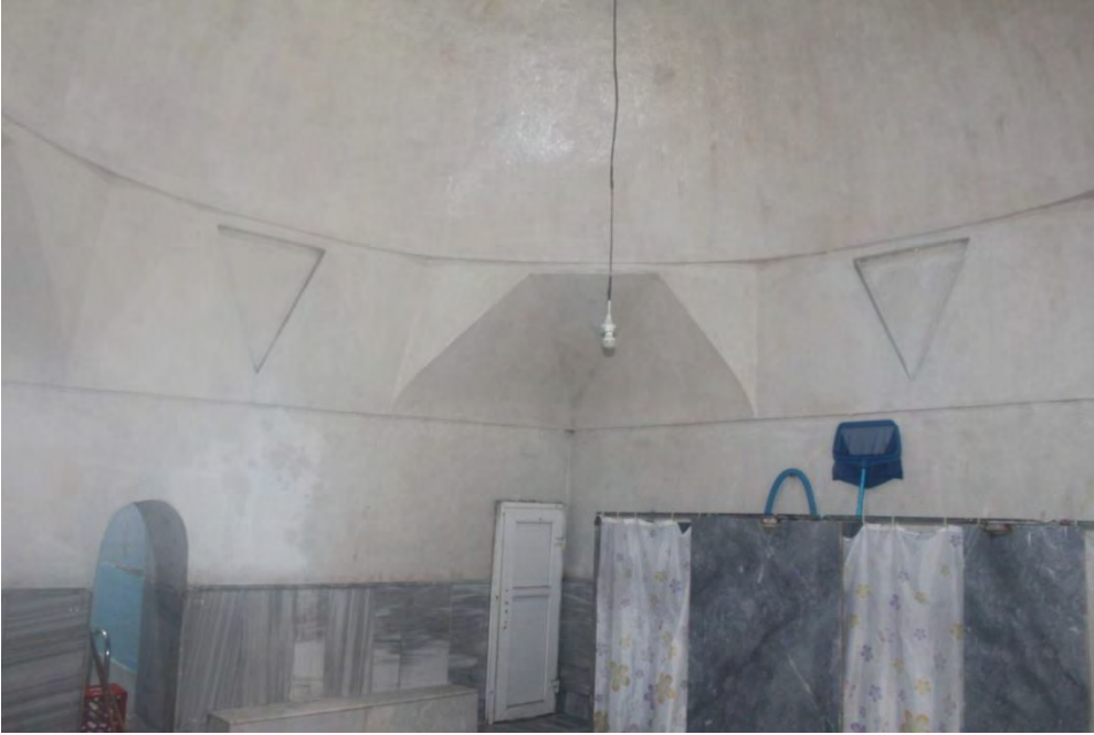
Fotoğraf No:14 Seydiler Hamamı Ilıklık Bölümü(2017) (Sinan ÜNAL)
