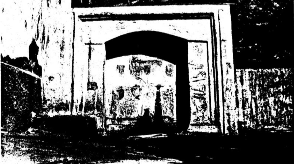
Fotoğraf No:2 Acem Çeşmesi Kuzey Cephe Bölümü(1988) (Erol ALTINSAPAN)
