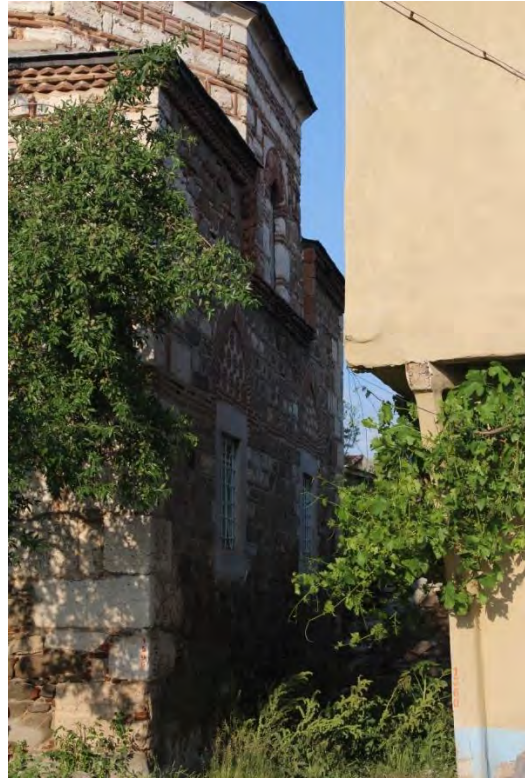
Fotoğraf No:22 Hoşkadem Cami Güney Cephe Bölümü (2017) (Sinan ÜNAL)
