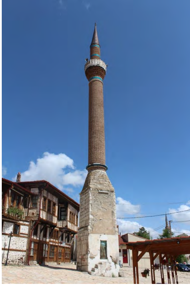
Fotoğraf No:6 Kılıç Mescit Minaresi Batı ve Güney Cephe Bölümü (1997) (Sinan ÜNAL)
