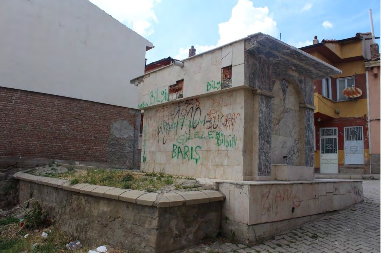
Fotoğraf No:4 Kurtlu Çeşme Kuzey Cephe Bölümü(2017) (Sinan ÜNAL)
