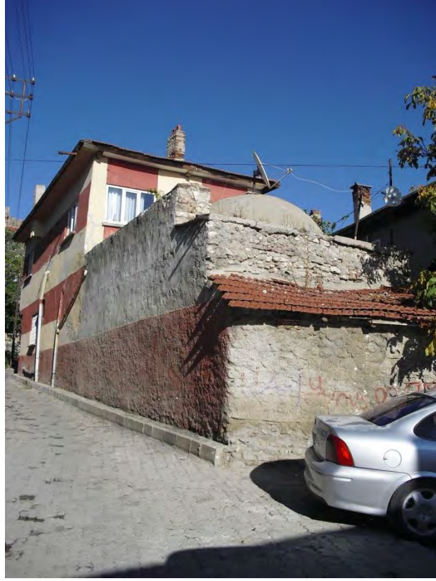
Fotoğraf No:2 Sinan Paşa Hamamı Batı ve Güney Cephe Bölümü (2017) (Koray Faydacı )
