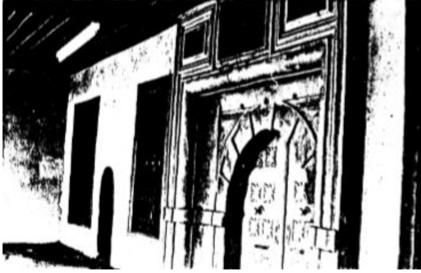
Fotoğraf No:5 Yeni Cami Kuzey Cephe Bölümü Son Cemaat Yeri ve Giriş Açıklığı (1988) (Erol ALTINSAPAN)
