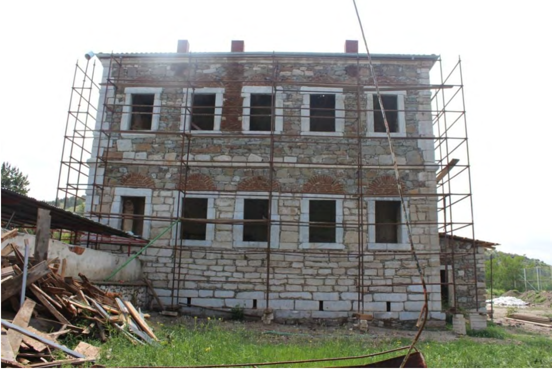
Fotoğraf No:9 Askerlik Şubesi 2 Nolu Yapı Batı Cephe Bölümü(2017) (Sinan ÜNAL)
