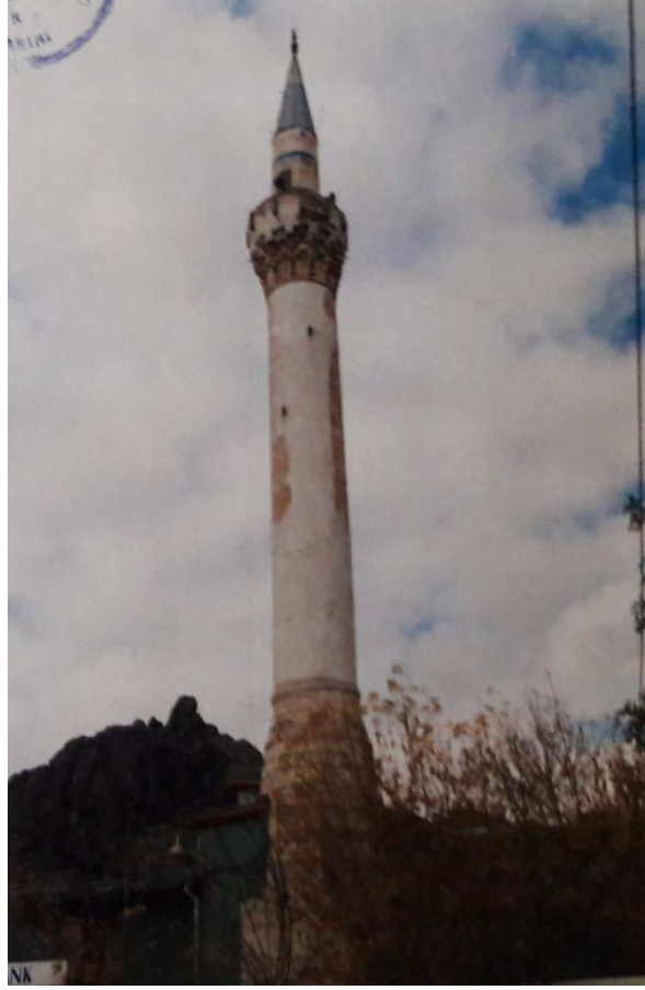
Fotoğraf No:11 Ulu Cami Minare Bölümü(2003) (EKVKBKMA)
