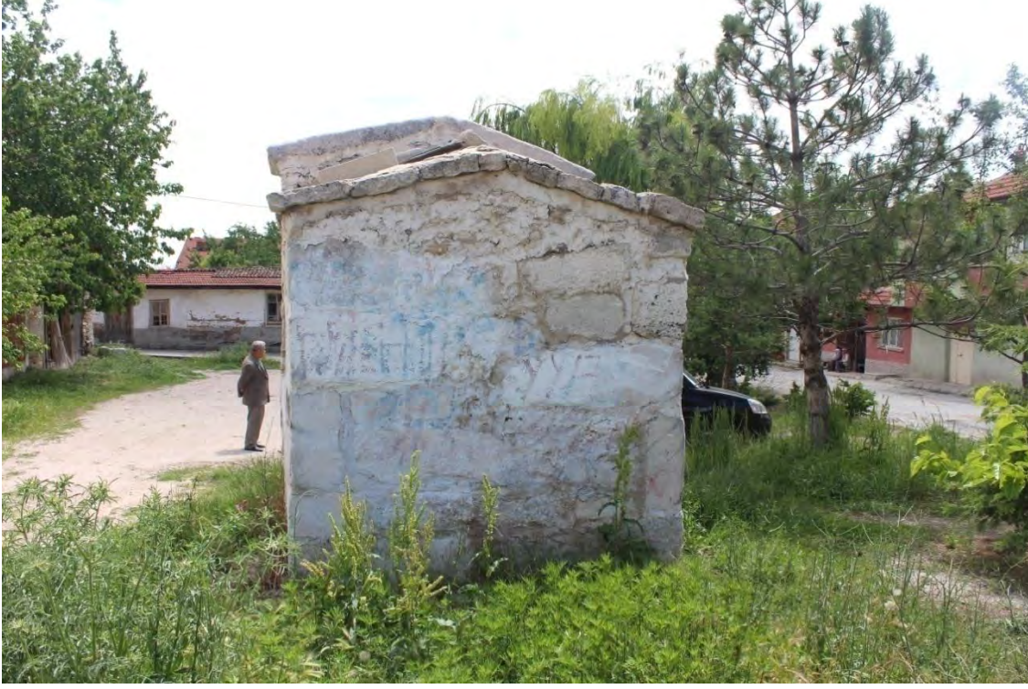
Fotoğraf No:9 Ak Çeşme Güney Cephe Ve Su Deposu Bölümü(2017) (Sinan ÜNAL)
