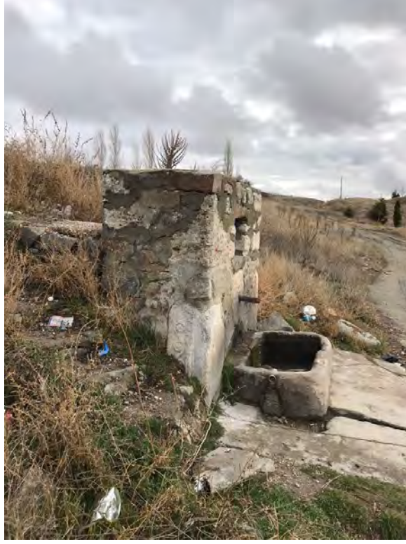
Fotoğraf No:3 Habib Çeşmesi Ön Cephe İle Yan Cephe Bölümü(2018) (Sinan Ünal)
