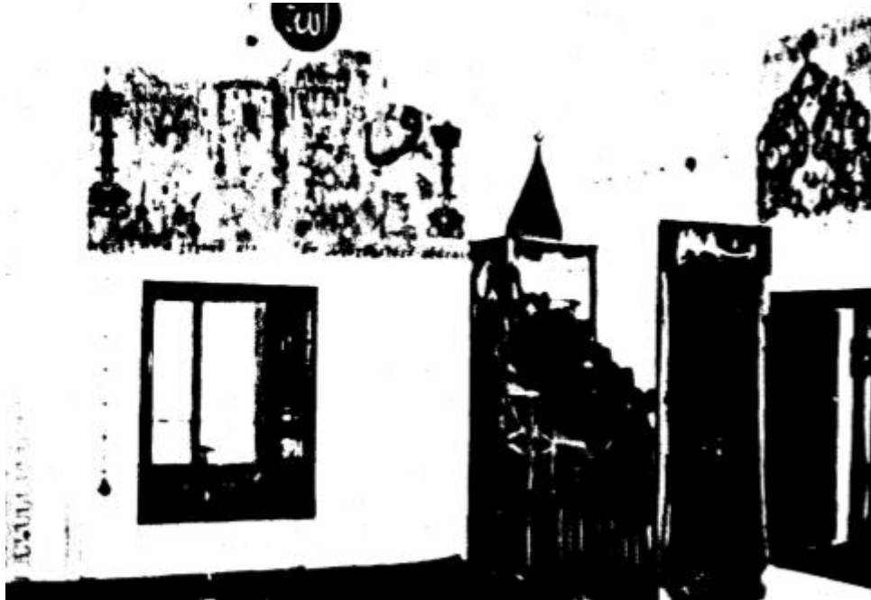
Fotoğraf No:10 Hazinedar Cami Güney Cephe Ve Batı Cephe Kalem İşleri ile Minber Bölümü (1988) (Erol ALTINSAPAN)
