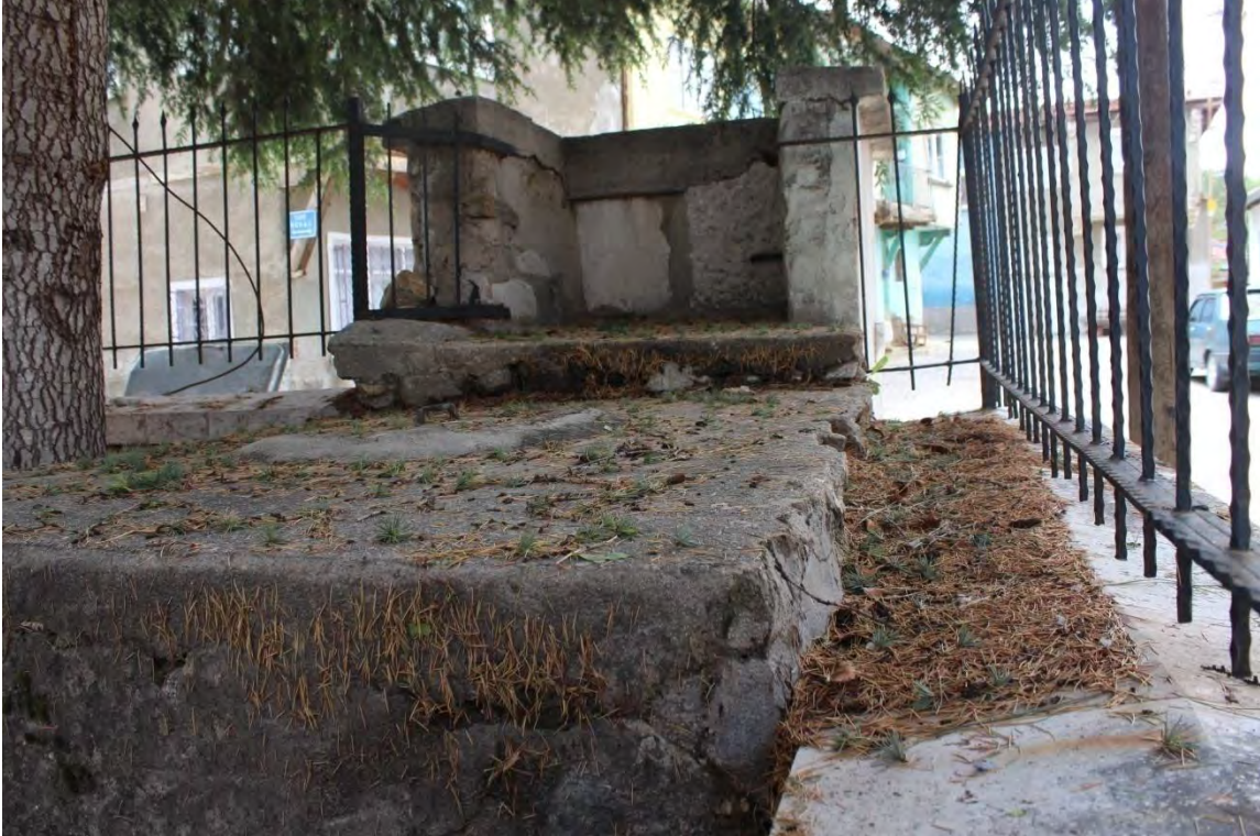
Fotoğraf No:4 Osmancık Çeşmesi Kuzey Cephe ve Su Deposu Bölümü (2017) (Sinan Ünal)
