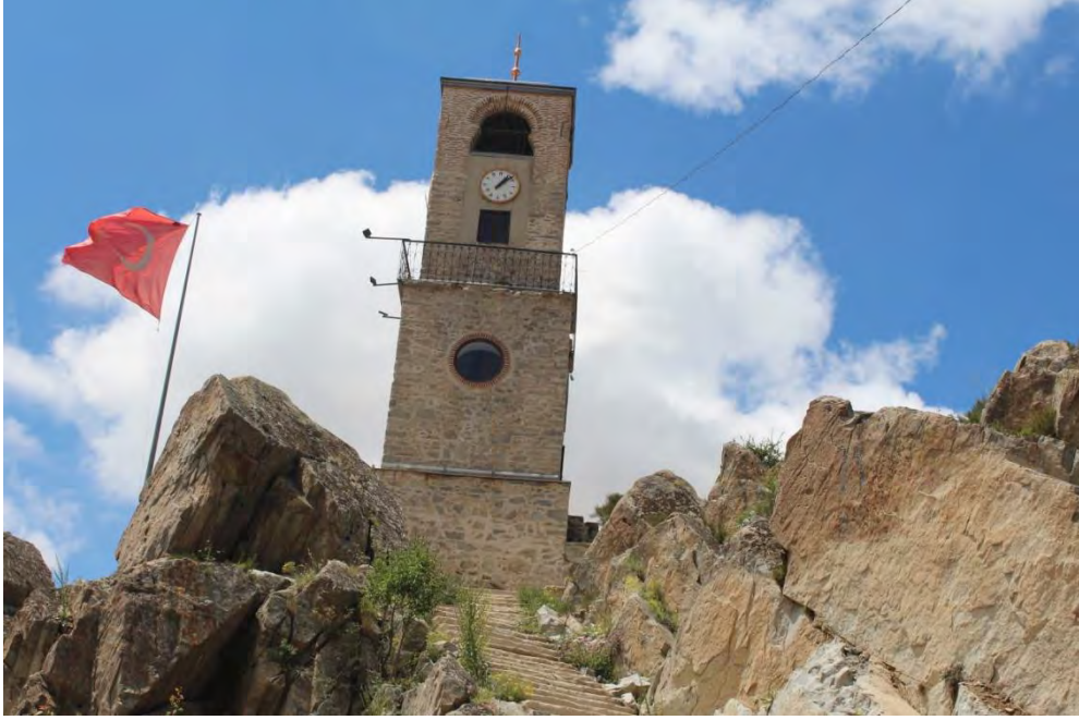
Fotoğraf No:12 Sivrihisar Saat Kulesi Doęu Cephe Bölümü(2017) (Sinan ÜNAL)
