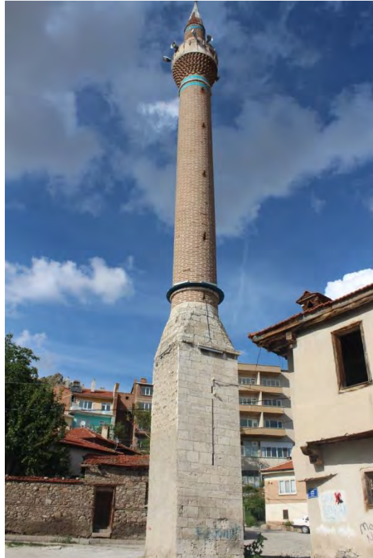
Fotoğraf No:4 Tek Minare Batı Cephe ve Güney Cephe Bölümü (2017) (Sinan ÜNAL)
