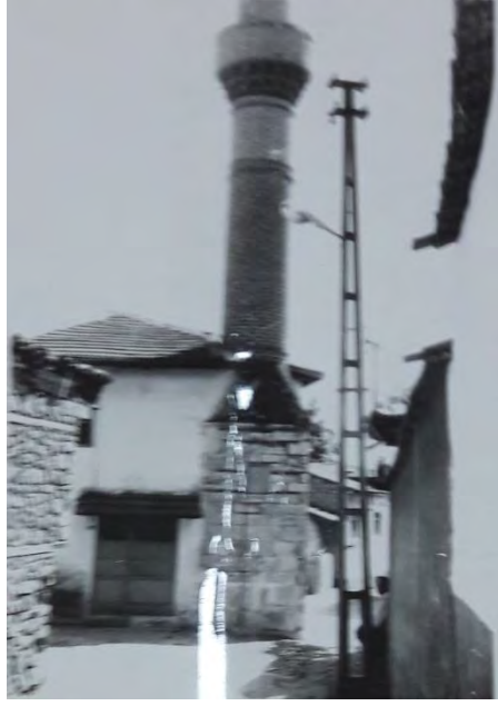
Fotoğraf No:1 Bodur Cami Kuzey Cephe Bölümü(1987) (EKVKBKMA)
