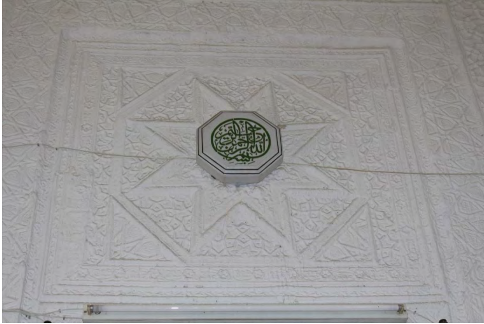
Fotoğraf No:32 Hazinedar Cami Harim Güney Cephe Mihrap Bölümü Detay(2017) (Sinan ÜNAL)
