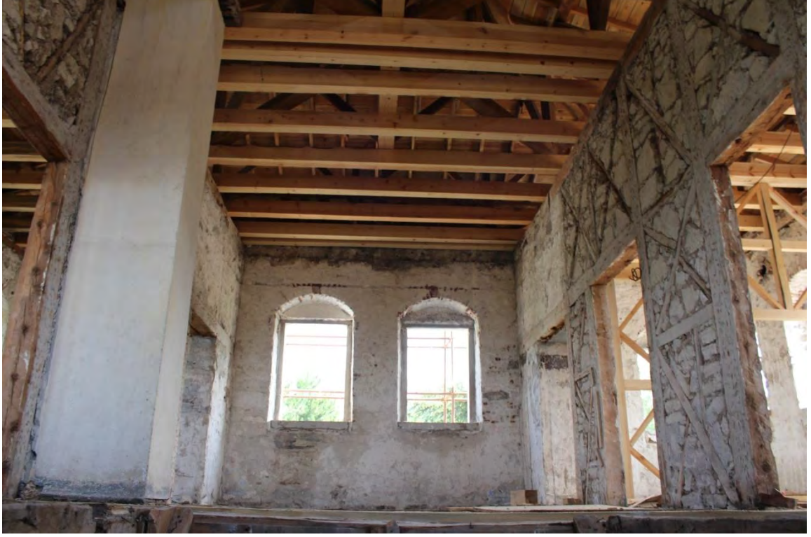
Fotoğraf No:13 Askerlik Şubesi 2 Nolu Yapı Binci Kat Bölümü(2017) (Sinan ÜNAL)
