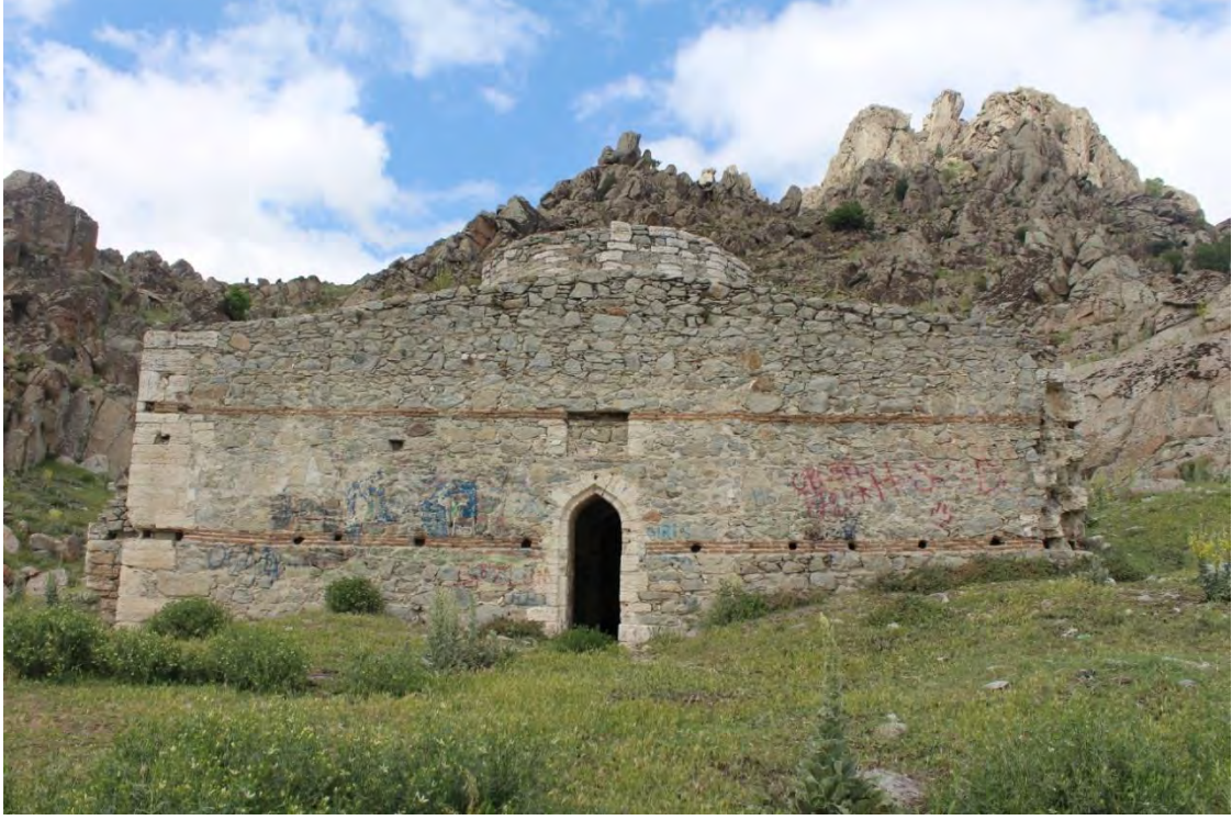
Fotoğraf No:6 Gavur(Ermeni) Hamamı Giriş Cephe Bölümü(2017) (Sinan ÜNAL)
