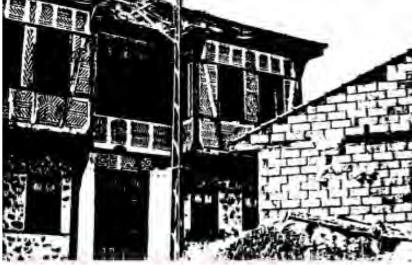
Fotoğraf No:1 Zaim Ağa Konağı Kuzey Cephe Bölümü(1988) (Erol ALTINSAPAN)
