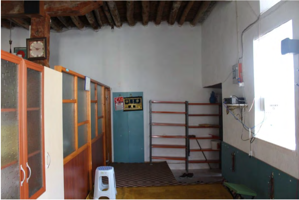
Fotoğraf No:21 Akdoğan Mescidi Kuzey Ve Doğu Cephe Bölümü(2017) (Sinan ÜNAL)
