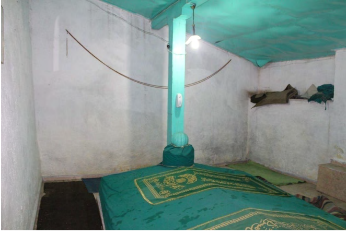
Fotoğraf No:4 Cafer Tayyar Türbesi Doğu Cephe ile Güney Cephe Bölümü (2017) (Sinan ÜNAL)
