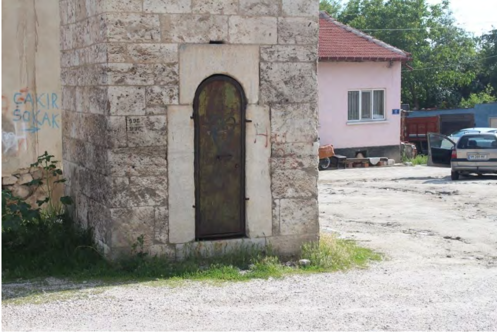
Fotoğraf No:3 Tek Minare Kuzey Cephe Giriş Açıklığı (2017) (Sinan ÜNAL)
