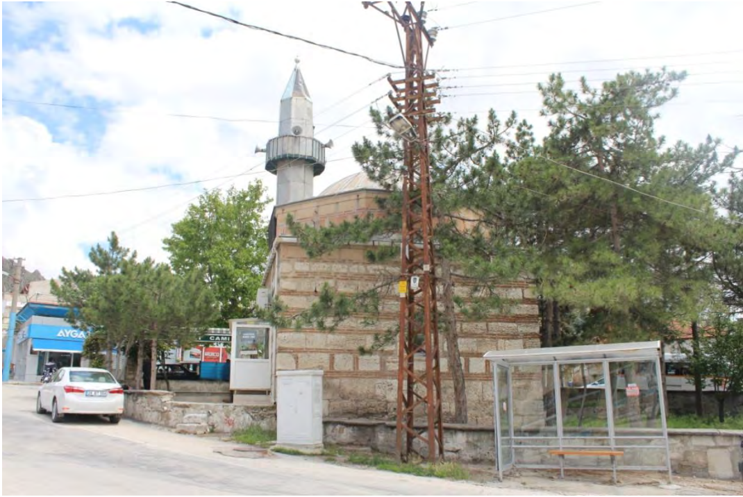
Fotoğraf No:8 Kümbet Cami Batı Cephe Bölümü (2017) (Sinan ÜNAL)
