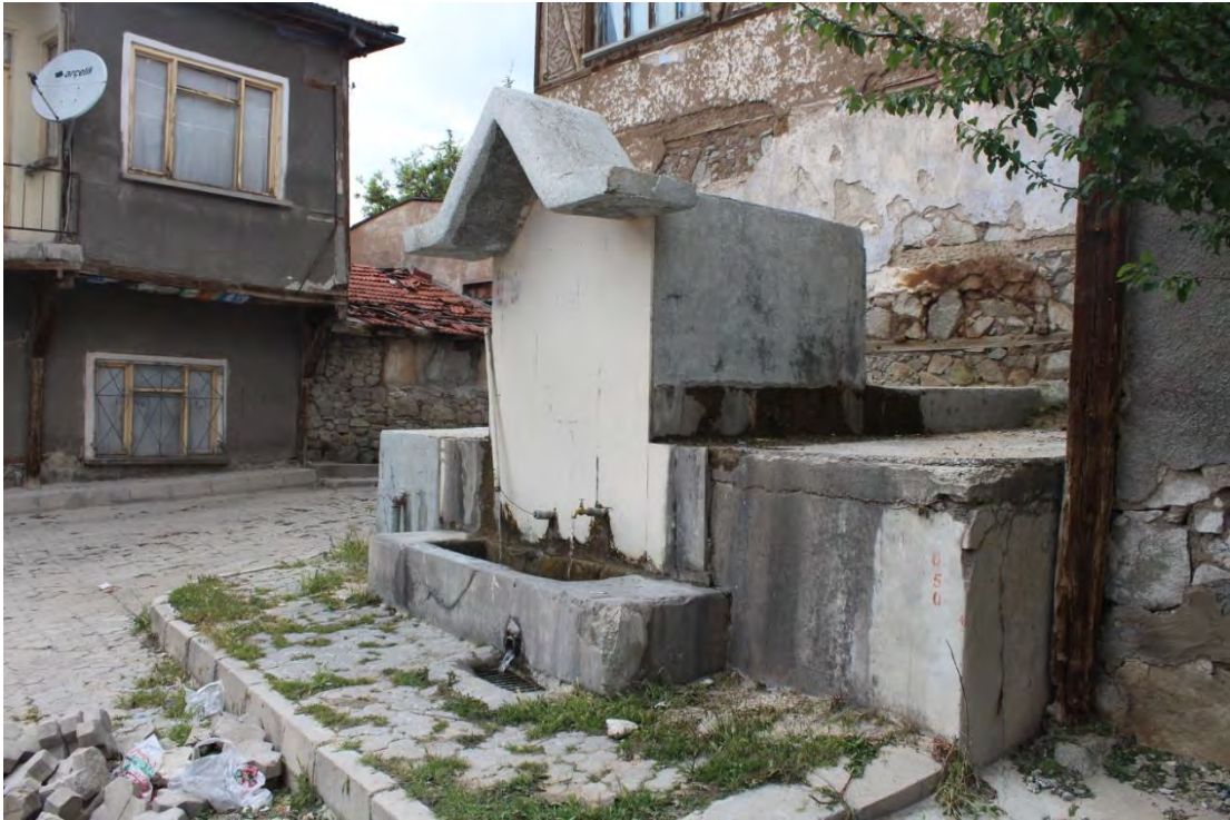
Fotoğraf No:3 Hacı Mut Çeşmesi Doğu Cephesi (2017) (Sinan ÜNAL)
