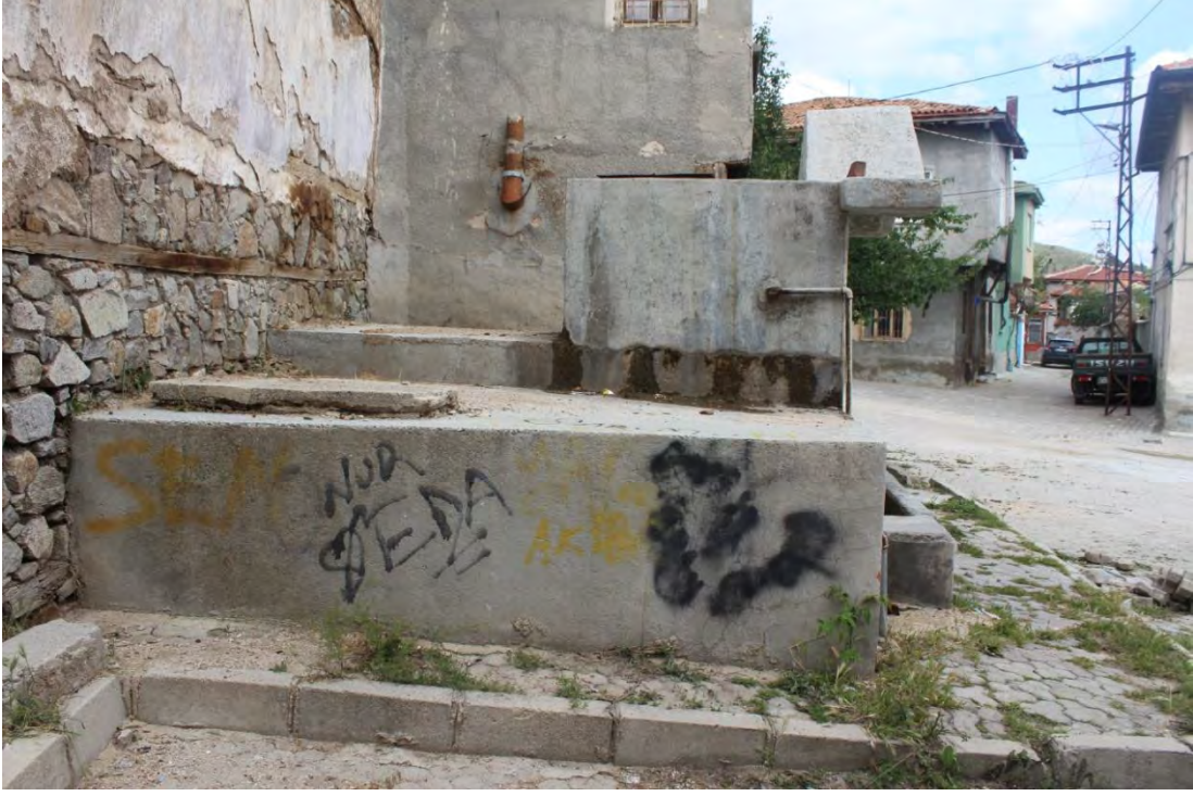
Fotoğraf No:4 Hacı Mut Çeşmesi Batı Cephesi (2017) (Sinan ÜNAL)
