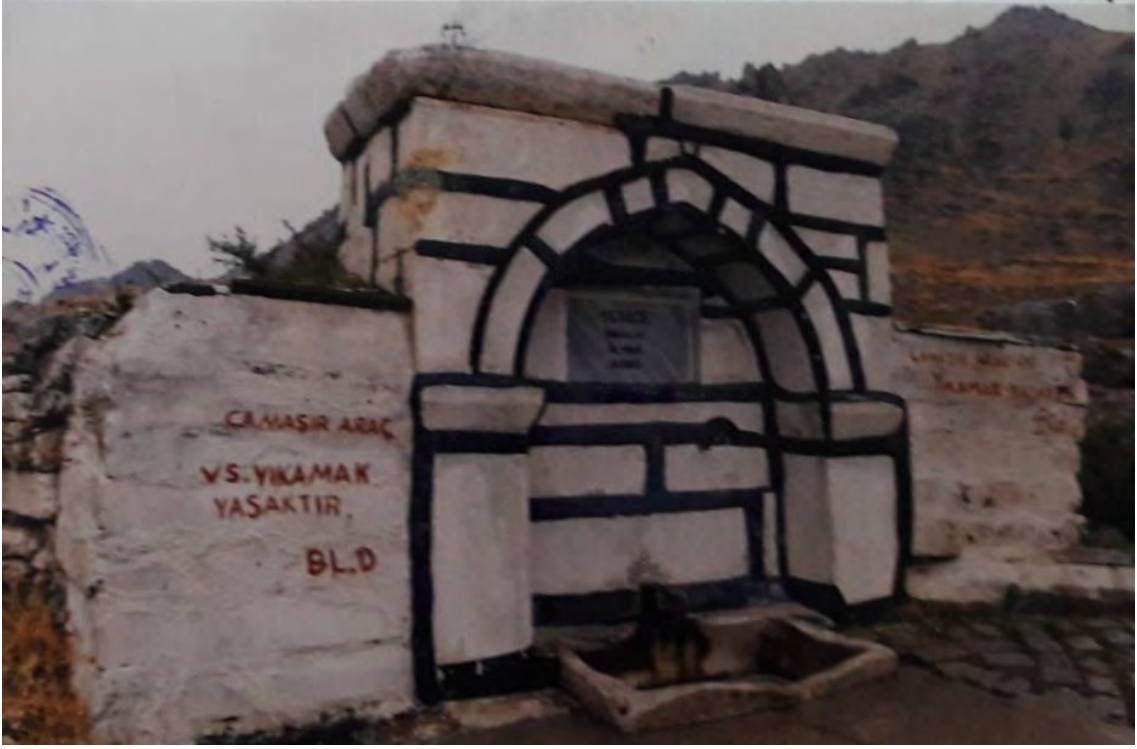
Fotoğraf No:2 Üçpınar Çeşmesi Doğu Cephe (2003) (EKVKBKMA)
