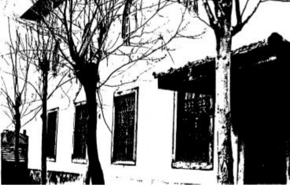
Fotoğraf No:2 Yeni Cami Batı Cephe Bölümü İle İkinci Kapı Açıklığı(1988) (Erol ALTINSAPAN)
