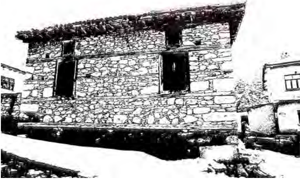
Fotoğraf No:4 Akdoğan Mescidi Güney Cephe Bölümü (1997) (Erol ALTINSAPAN)
