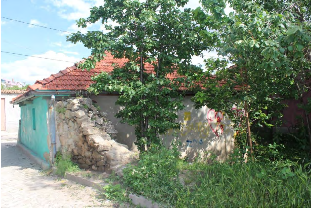
Fotoğraf No:3 Kudbeddin Dede Türbesi Batı Cephe Bölümü(2017) (Sinan ÜNAL)
