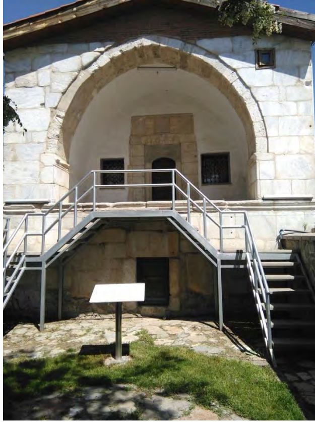
Fotoğraf No:11 Mahmud Suzani Türbesi Batı Cephe Bölümü (2017) (Sinan ÜNAL)
