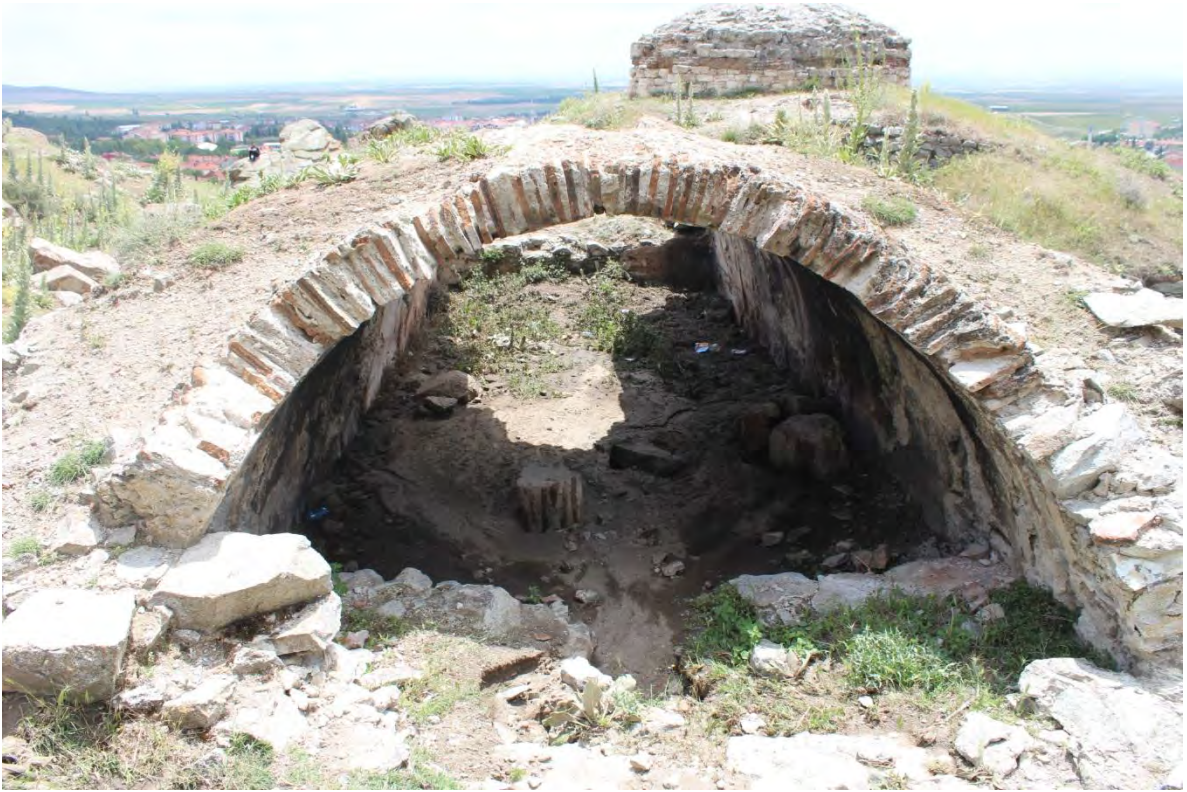
Fotoğraf No:11 Gavur(Ermeni) Hamamı Su Deposu Bölümü (2017) (Sinan ÜNAL)
