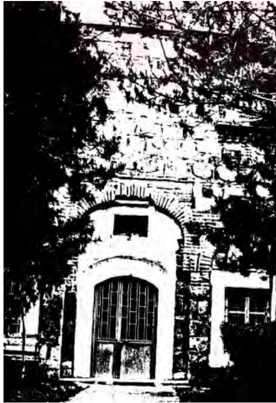
Fotoğraf No:5 Hoşkadem Cami Kuzey Cephe Giriş Açıklığı(1988) (Erol ALTINSAPAN)
