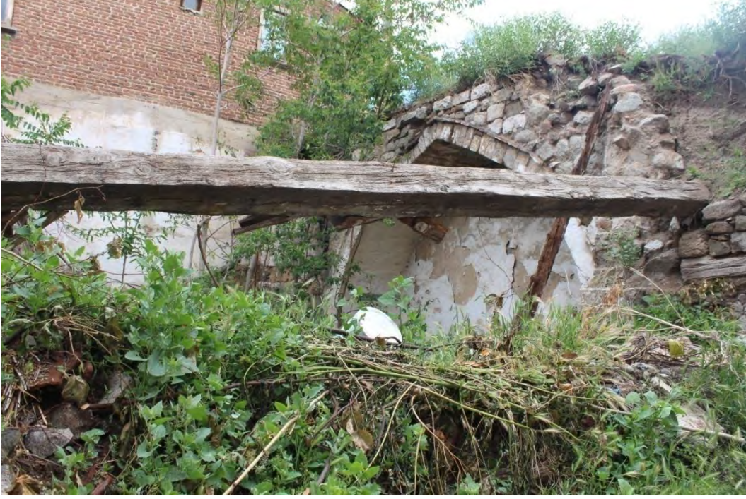
Fotoğraf No:5 Kumacık Hamamı Soğukluk Bölümü(2017) (Sinan ÜNAL)
