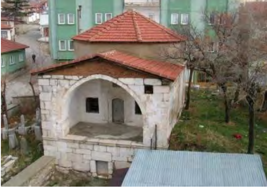
Fotoğraf No:3 Mahmud Suzani Türbesi Batı Ve Güney Cephe Bölümü(2006) (Erol ALTINSAPAN)
