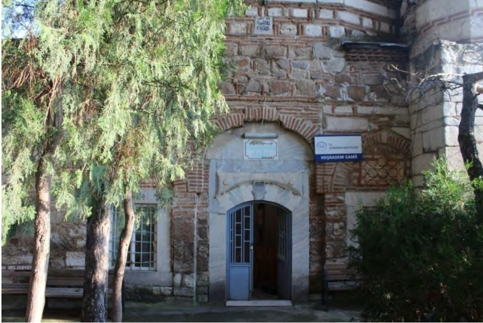
Fotoğraf No:24 Hoşkadem Cami Kuzey Cephe Giriş Açıklığı(2017) (Sinan ÜNAL)
