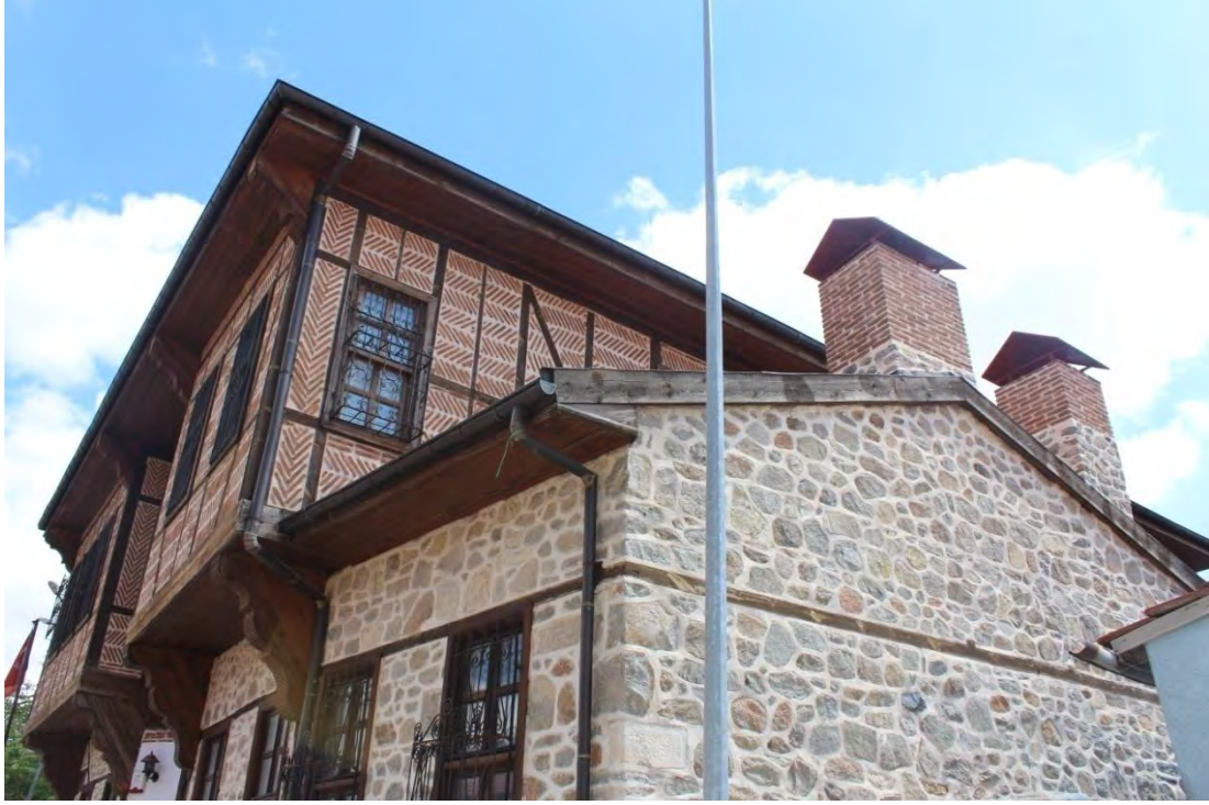
Fotoğraf No:13 Zaim Ağa Konağı Batı Cephe Bölümü(2017) (Sinan ÜNAL)
