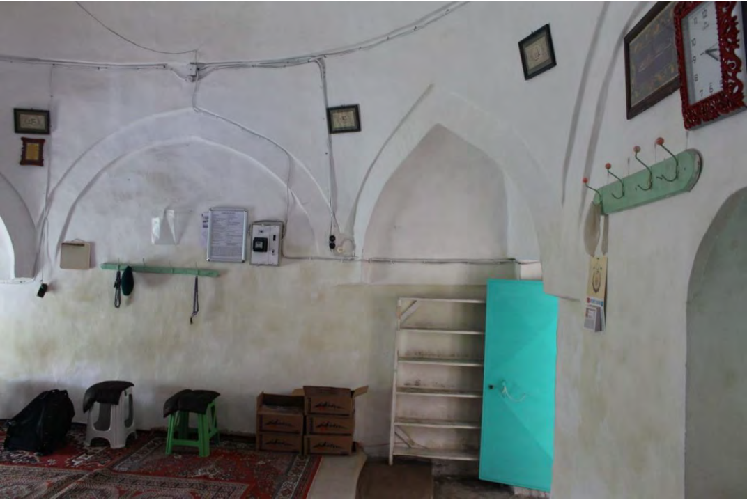
Fotoğraf No:13 Hızır Bey Kuzey Cephe Bölümü (2017) (Sinan ÜNAL)
