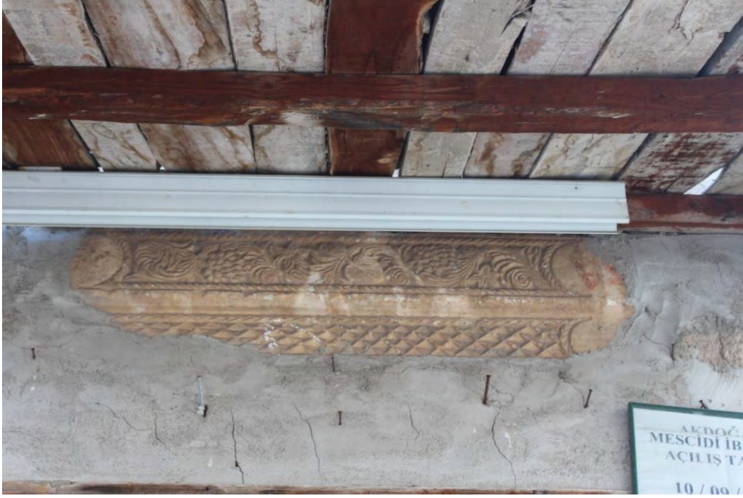
Fotoğraf No:24 Akdoğan Mescidi Giriş Açıklığı Üzerinde Yer Alan Devşirme Malzeme(2017) (Sinan ÜNAL)
