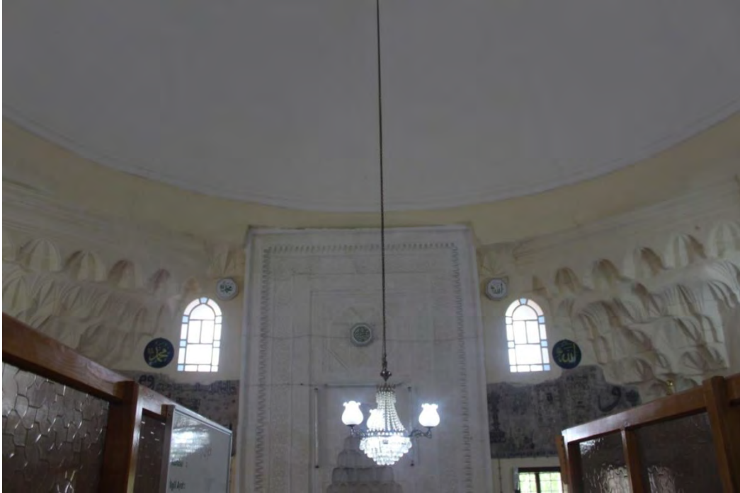
Fotoğraf No:30 Hazinedar Cami Harim Güney Cephe Kubbe Eteği (2017) (Sinan ÜNAL)
