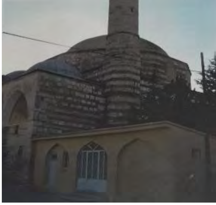
Fotoğraf No:10 Kurşunlu Cami Batı Cephe Bölümü Muhdes Yapı Onarım Öncesi(2008) (EKVKBKMA)
