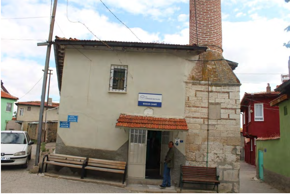
Fotoğraf No:5 Bodur Cami Kuzey Cephe Bölümü (2017) (Sinan ÜNAL)
