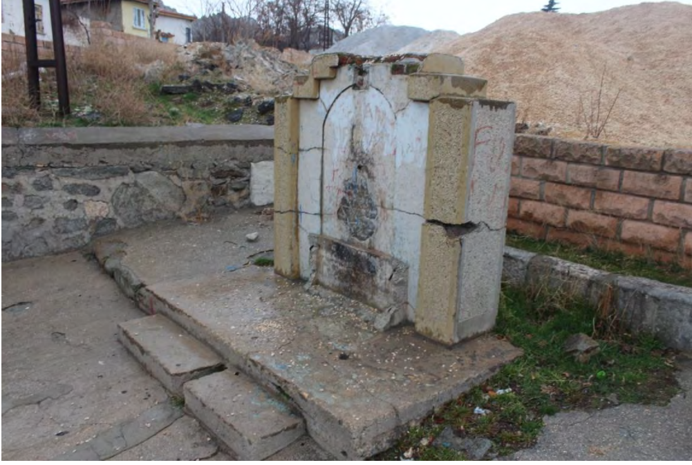
Fotoğraf No:2 Yenice Mahalle Çeşmesi Sekiler ve Ön Cephe Bölümü(2018) (Sinan Ünal)
