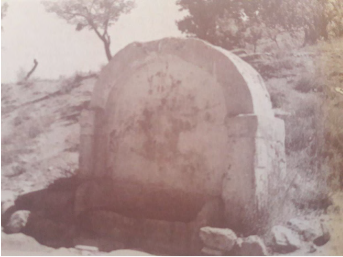
Fotoğraf No:1 Baba Çeşmesi Doğu Cephe Bölümü(2001) (Orhan KESKİN)
