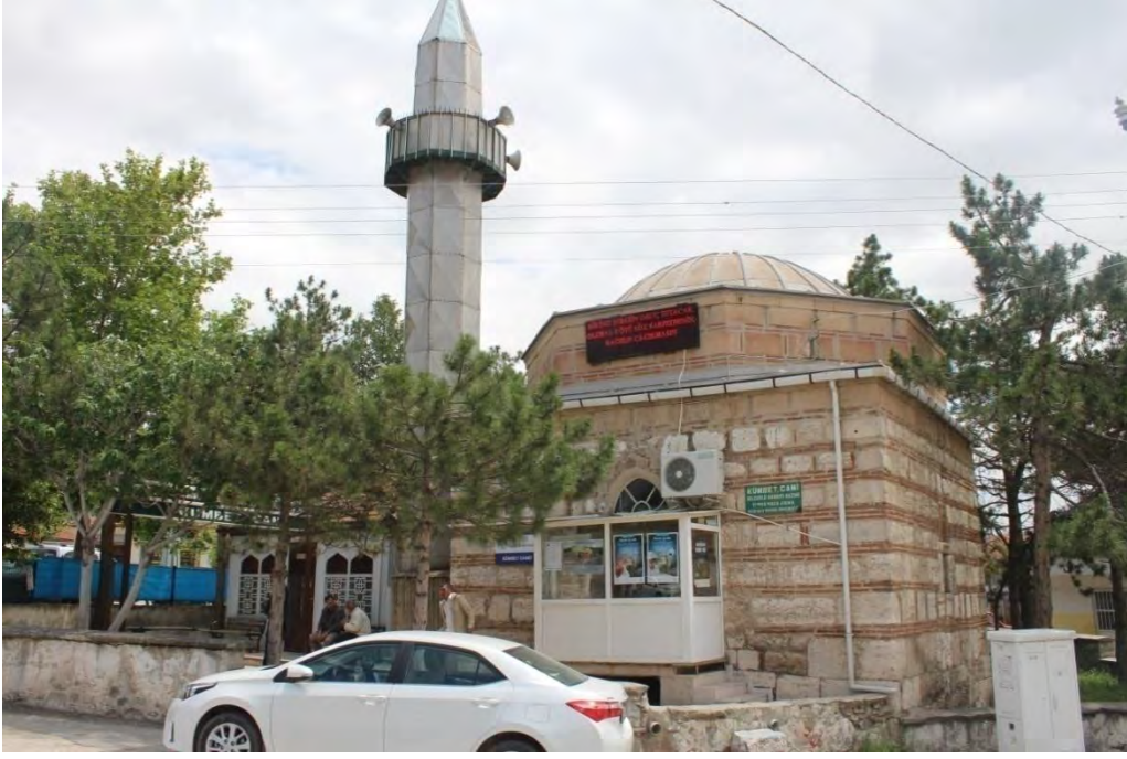
Fotoğraf No:7 Kümbet Cami Kuzey Cephe Bölümü (2017) (Sinan ÜNAL)
