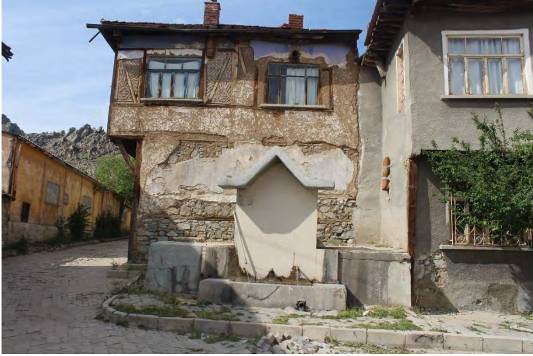
Fotoğraf No:2 Hacı Mut Çeşmesi Kuzey Cephesi (2017) (Sinan ÜNAL)
