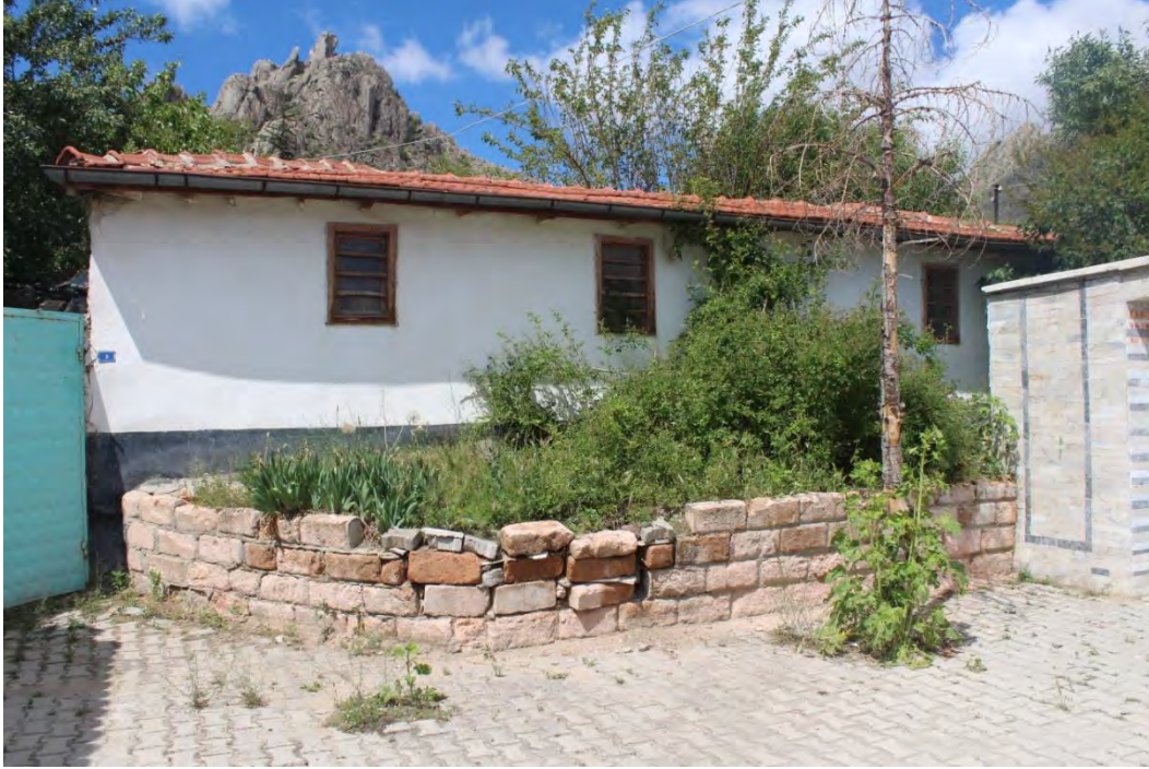
Fotoğraf No:4 Ali Dede Türbesi Güney Cephe Bölümü(2017) (Sinan ÜNAL)
