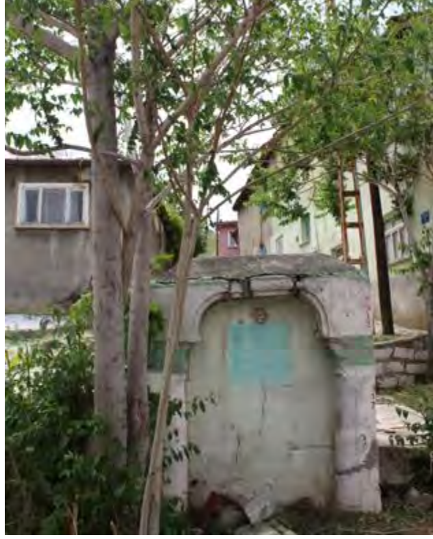
Fotoğraf No:3 Demirci Çeşme Güney Cephesi (2017) (Sinan ÜNAL)
