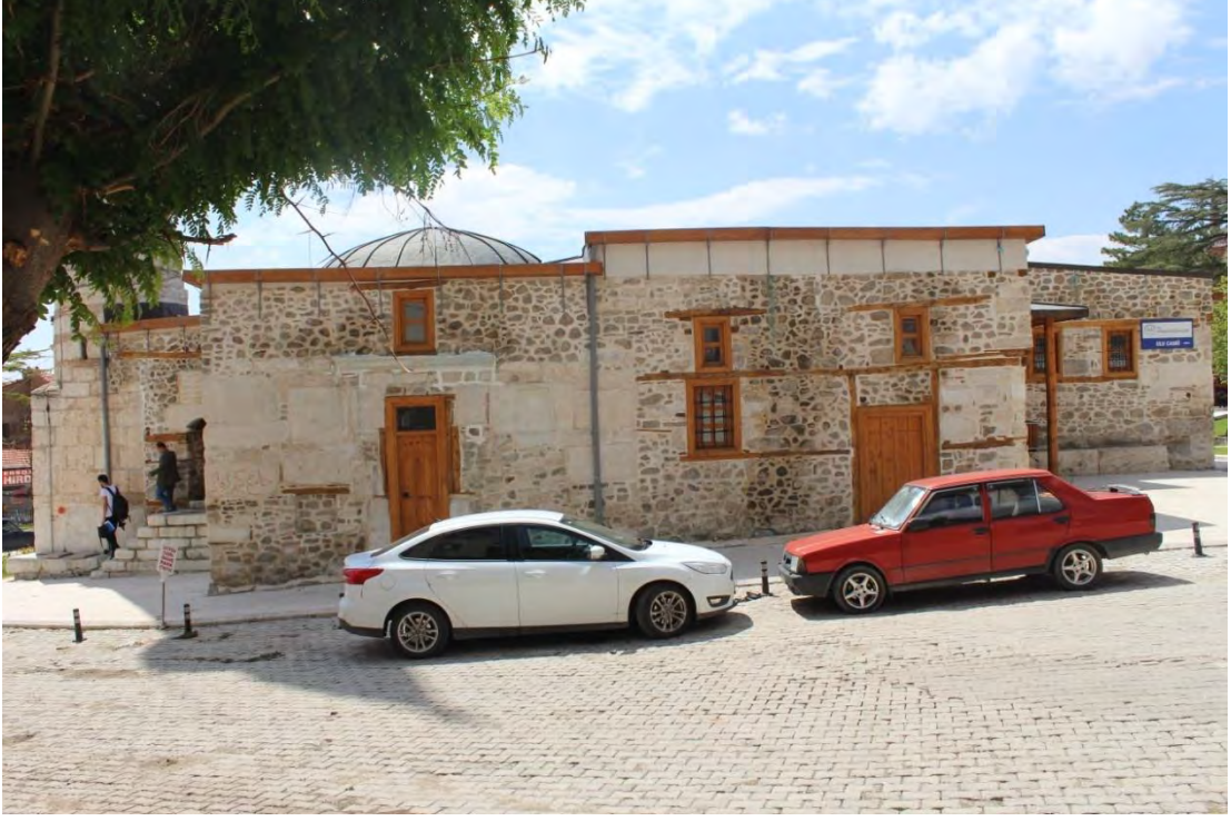
Fotoğraf No:22 Ulu Cami Doğu Cephe Bölümü(2017) (Sinan ÜNAL)
