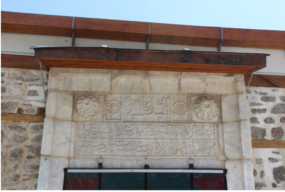
Fotoğraf No:18 Ulu Cami Kuzey Cephe Giriş Açıklığı Üzerinde Yer Alan II. İnşa Kitabesi(2017) (Sinan ÜNAL)
