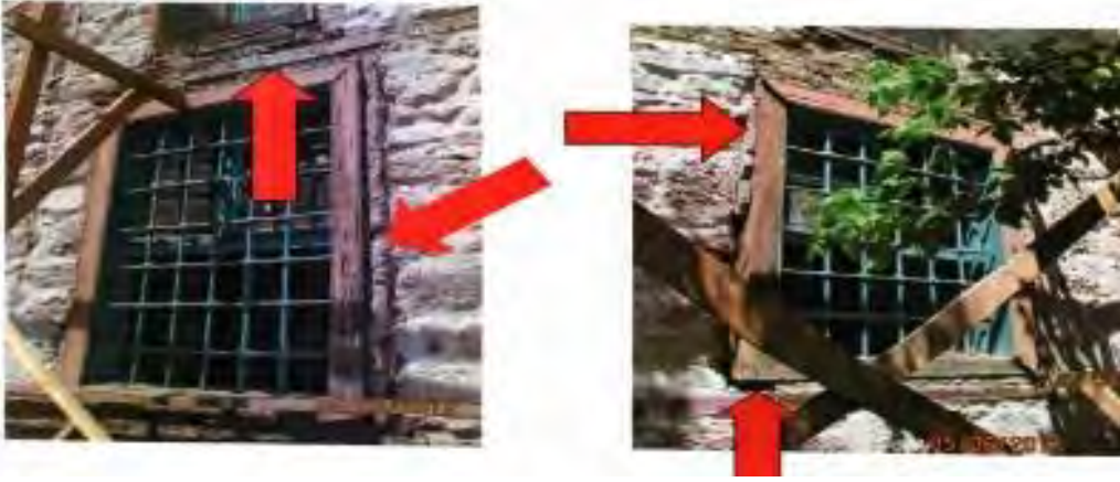
Fotoğraf No:13 Ulu Cami Pencere Bölümlerinin İncelenmesi Ve Tahribatların Giderilmesi(2013) (EKVKBKMA)
