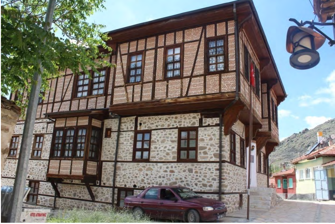
Fotoğraf No:11 Zaim Ağa Konağı Doğu Cephe Bölümü(2017) (Sinan ÜNAL)
