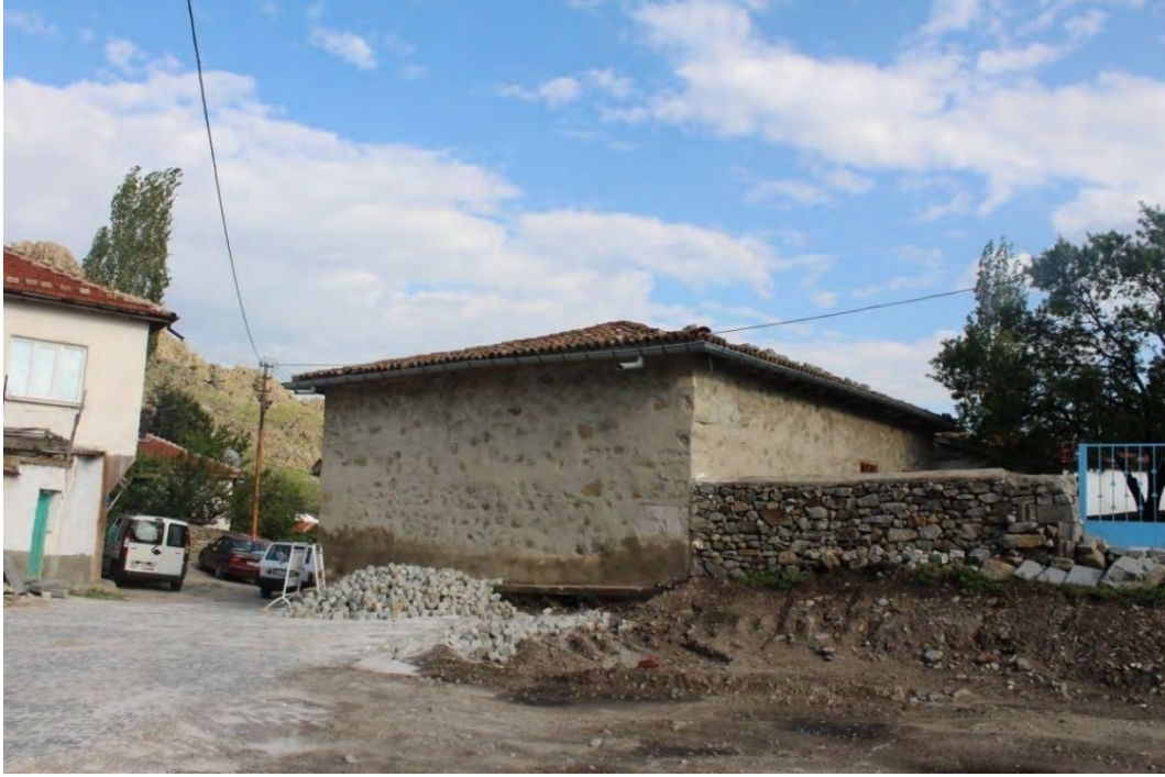
Fotoğraf No:17 Akdoğan Mescidi Batı Ve Kuzey Cephe Bölümü İle Avlu Bölümü(2017) (Sinan ÜNAL)
