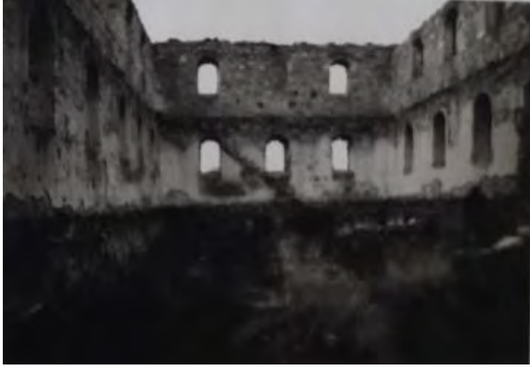
Fotoğraf No:2 Askerlik Şubesi 1 Nolu Yapı Kuzey Cephe Bölümü(1987) (EKVKBKMA)
