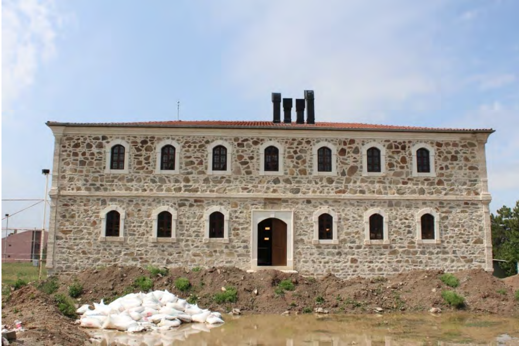
Fotoğraf No:7 Askerlik Şubesi 1 Nolu Yapı Kuzey Cephe Bölümü (2018) (Sinan ÜNAL)
