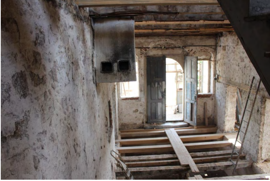
Fotoğraf No:11 Askerlik Şubesi 2 Nolu Yapı Zemin Kat Bölümü(2017) (Sinan ÜNAL)
