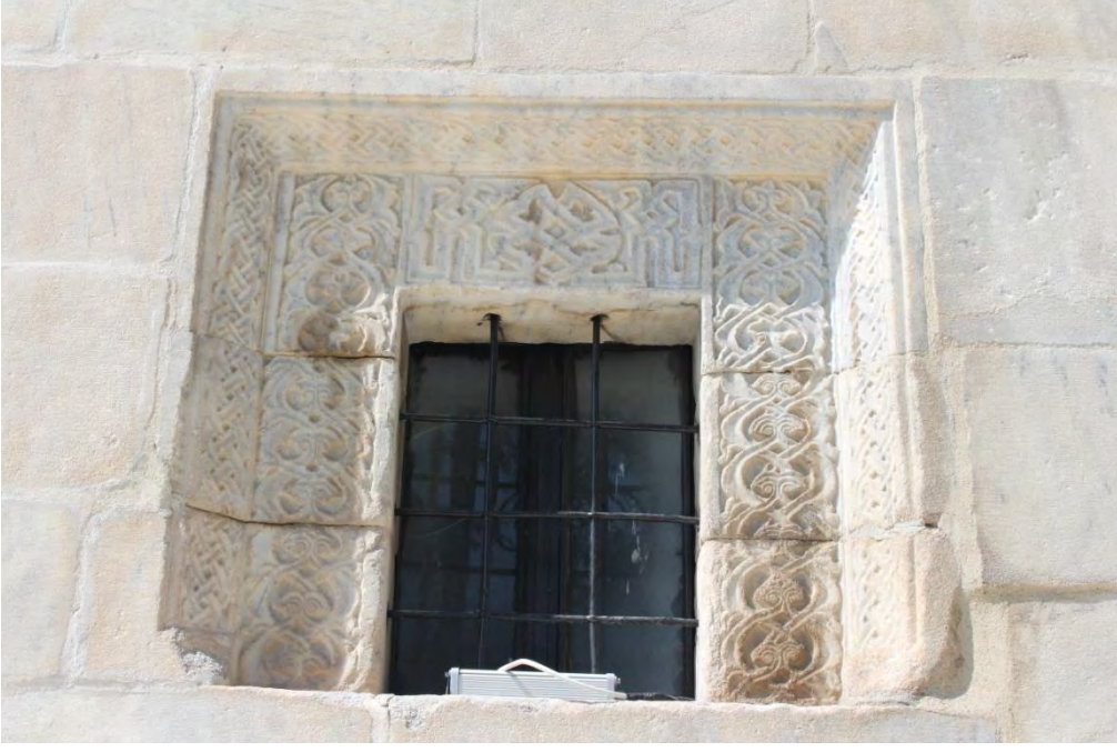
Fotoğraf No:12 Alemşah Türbesi Batı Cephe Pencere Bölümü(2000) (Sinan ÜNAL)
