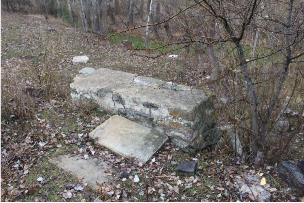
Fotoğraf No:5 Porsuk eşmesi Arka Cephe Görünümü(2018) (Sinan Ünal)
