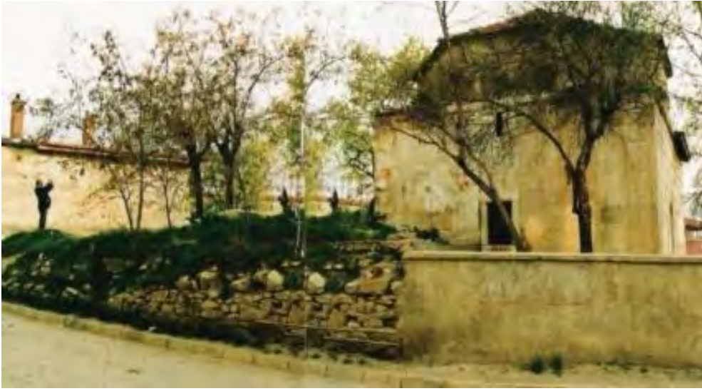
Fotoğraf No:4 Mahmud Suzani Türbesi Doğu Cephe Bölümü(2000?) (Erol ALTINSAPAN)
