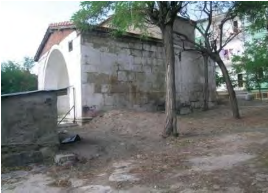
Fotoğraf No:6 Mahmud Suzani Türbesi Güney Cephe Bölümü(2006) (Erol ALTINSAPAN)
