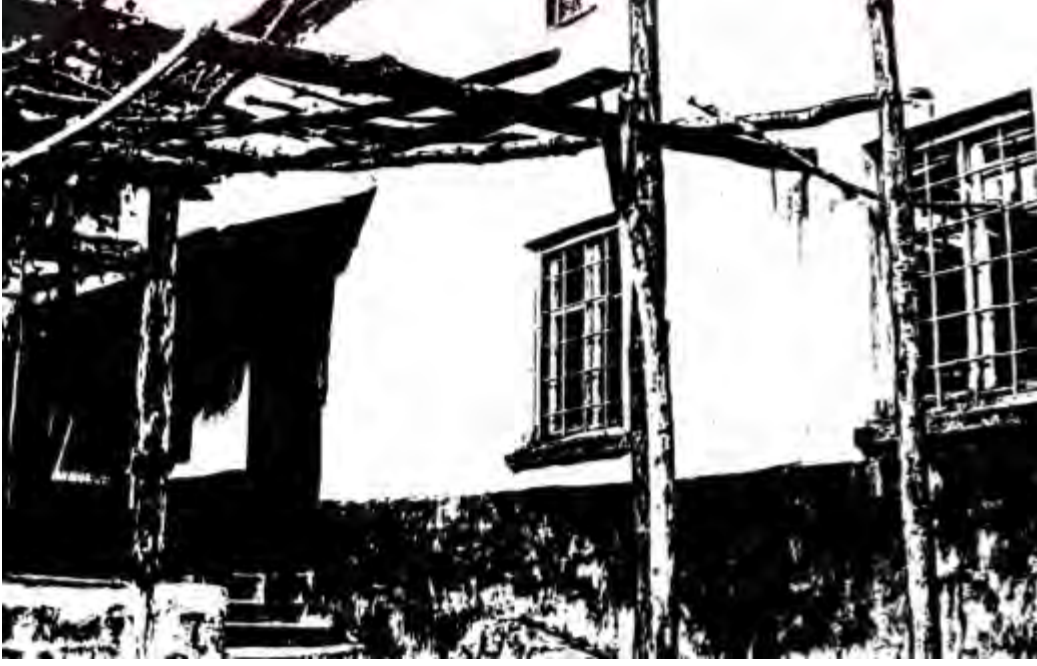
Fotoğraf No:1 Balaban Cami Batı Cephe Bölümü ile Giriş Açıklığı(1988) (Erol ALTINSAPAN)
