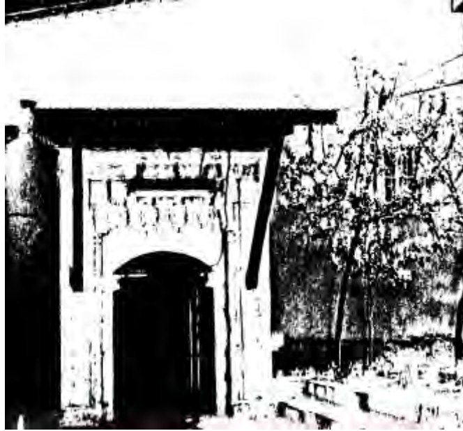
Fotoğraf No:1 Ulu Cami Batı Cephe Giriş Açıklığı(1988) (Erol ALTINSAPAN)
