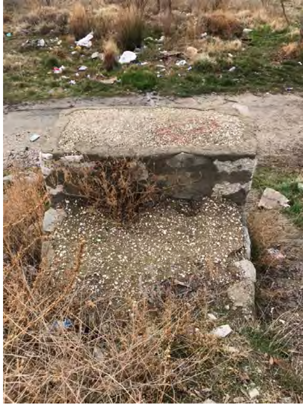
Fotoğraf No:4 Habib Çeşmesi Arka Cephe İle Su Deposu Bölümü(2018) (Sinan Ünal)
