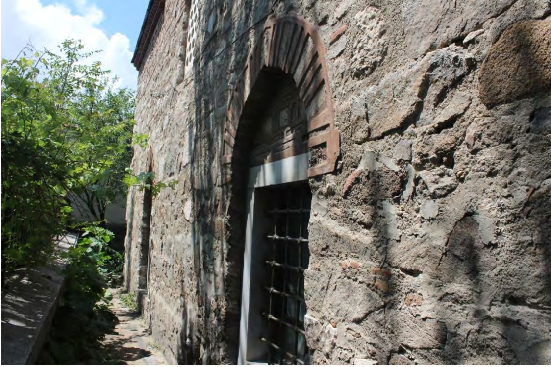
Fotoğraf No:25 Hazinedar Cami Doğu Cephe Pencere Bölümleri(2017) (Sinan ÜNAL)
