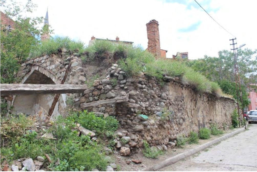
Fotoğraf No:2 Kumacık Hamamı Güney Cephe Giriş Bölümü(2017) (Sinan ÜNAL)
