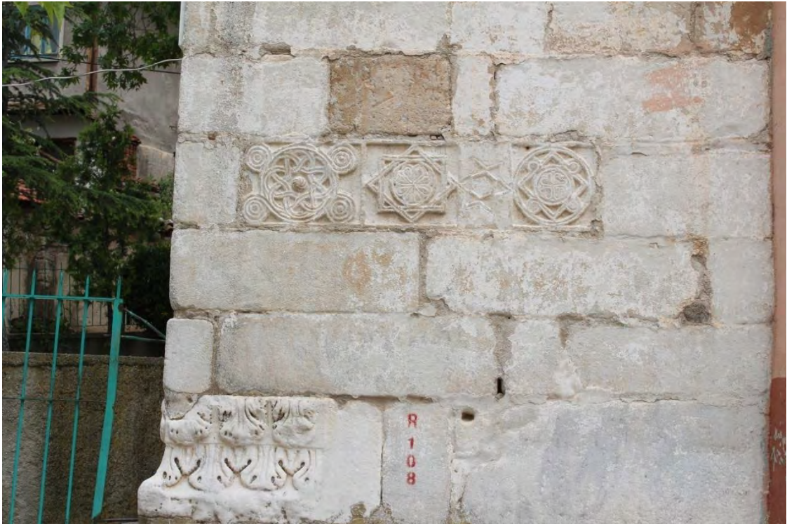
Fotoğraf No:30 Balaban Cami Minare Bölümü Güney Cephe Devşirme Malzemeler(2017) (Sinan ÜNAL)
