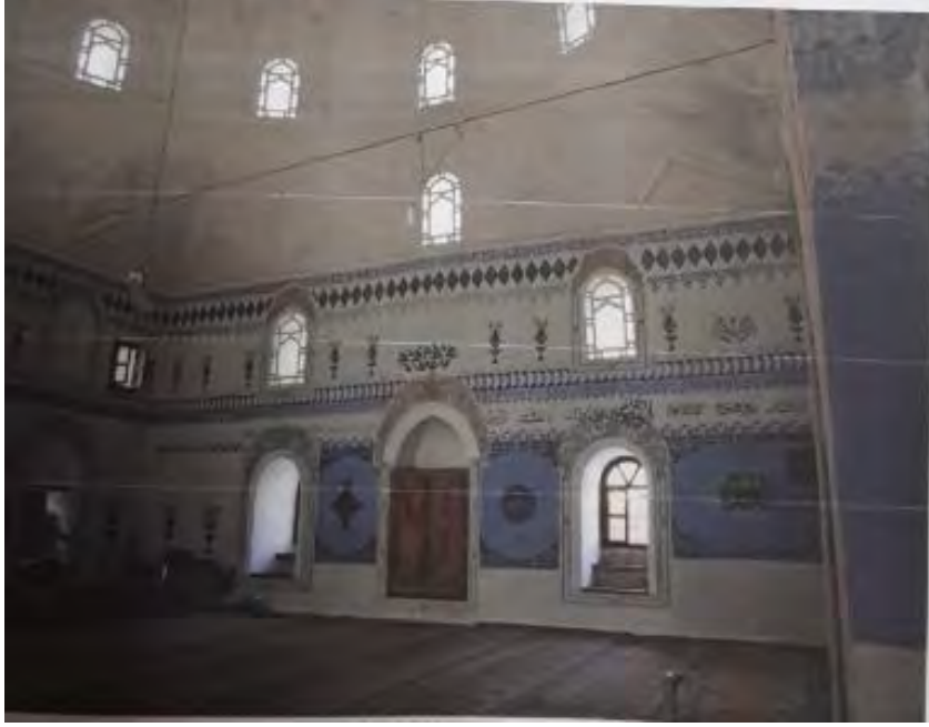
Fotoğraf No:21 Kurşunlu Cami Harim Doğu Cephe Bölümü Onarım Sonrası(2012) (EKVKBKMA)
