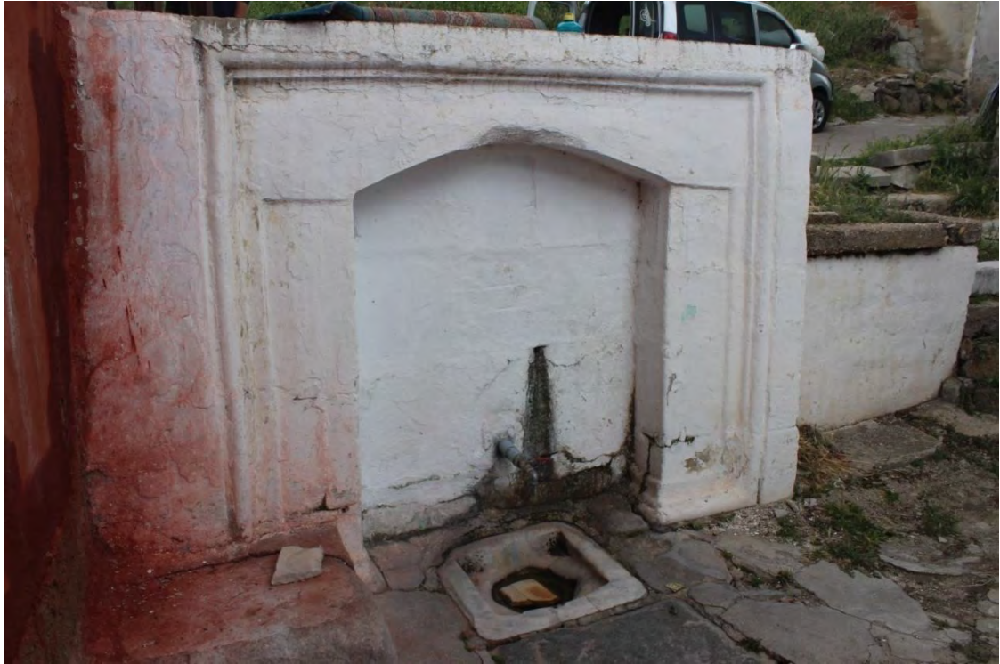
Fotoğraf No:3 Acem Çeşmesi Kuzey Cephe Bölümü(2017) (Sinan ÜNAL)
