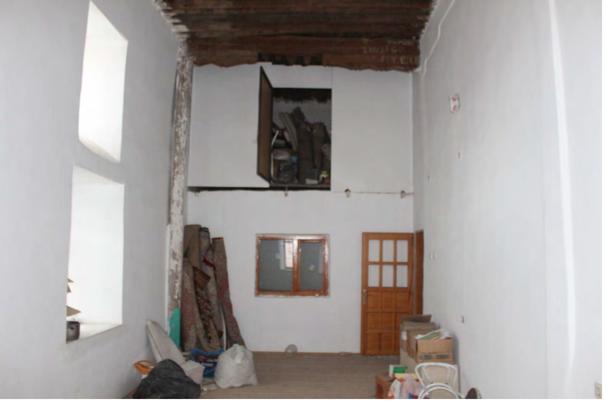
Fotoğraf No:15 Elmalı Cami Batı Cephe Bölümünde Yer Alan Oda(2018) (Sinan ÜNAL)
