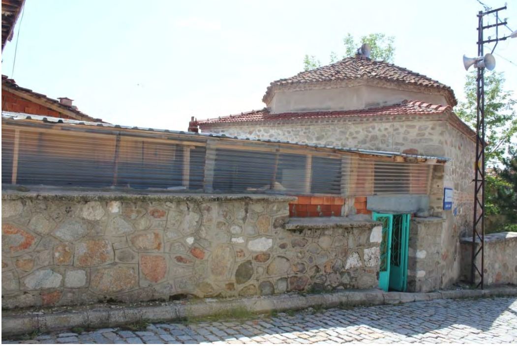
Fotoğraf No:8 Hızır Bey Mescidi Son Cemaat Yeri İle Kuzey Cephe Bölümü (2017) (Sinan ÜNAL)
