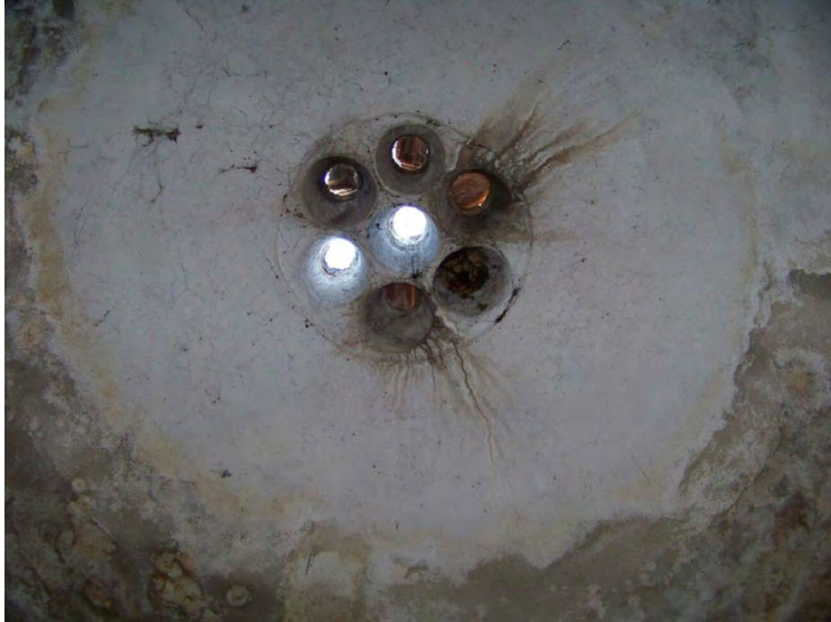
Fotoğraf No:7 Sinan Paşa Hamamı Kubbe fil gözleri(2018) (M.Soner Özdemir)
