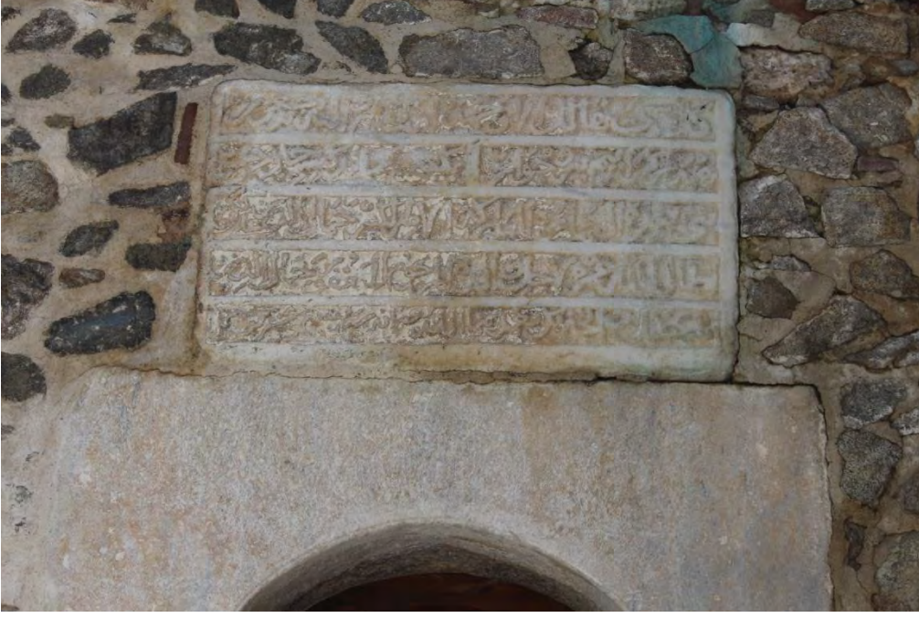
Fotoğraf No:28 Ulu Cami Minare Giriş Açıklığı Üzerinde Yer Alan I. İnşa Kitabesi(2017) (Sinan ÜNAL)
