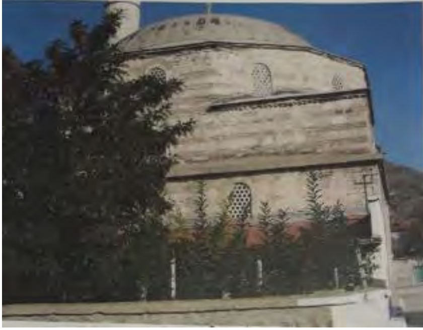
Fotoğraf No:8 Kurşunlu Cami Güney Cephe Bölümü Onarım Öncesi(2008) (EKVKBKMA)
