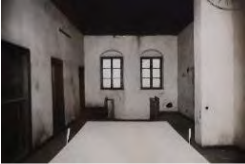
Fotoğraf No:4 Askerlik Şubesi 2 Nolu Yapı Birinci Kat(1987) (EKVKBKMA)
