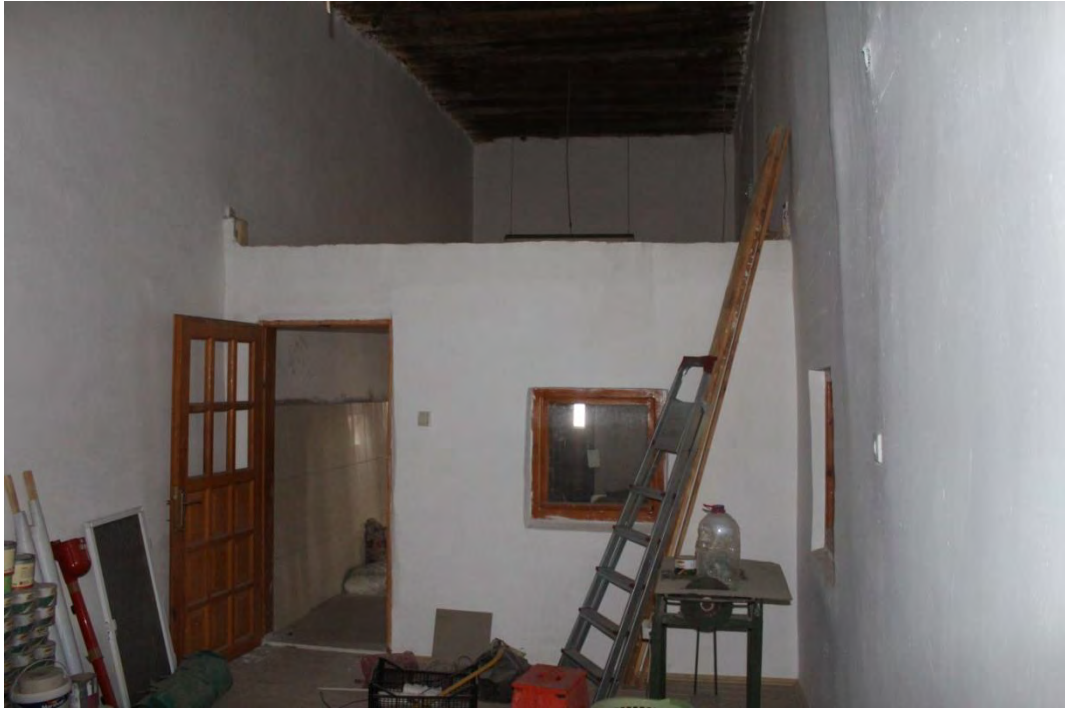
Fotoğraf No:8 Elmalı Cami Doğu Cephe Bölümüne Bakış(2018) (Sinan ÜNAL)
