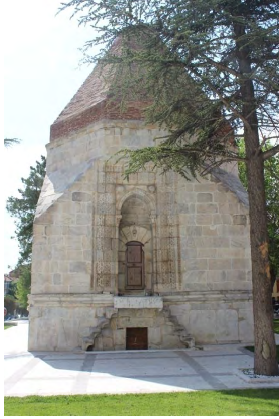
Fotoğraf No:8 Alemşah Türbesi Doğu Cephe Bölümü(2017) (Sinan ÜNAL)
