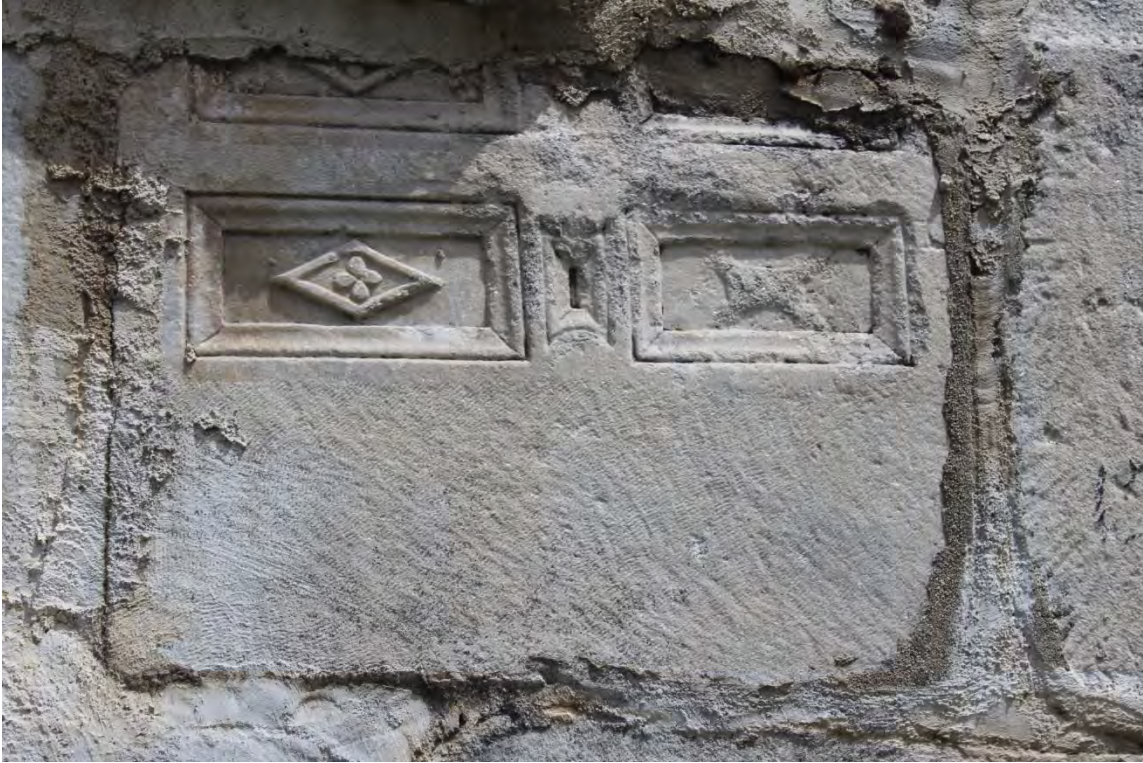
Fotoğraf No:8 Ak Çeşme Batı Cephe Bölümü Dikdörtgen Bezemeleri(2017) (Sinan ÜNAL)
