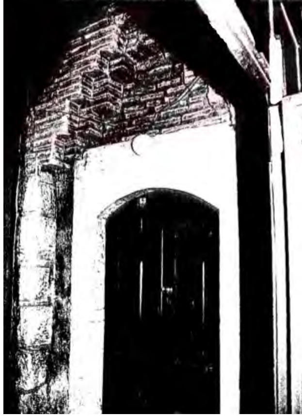
Fotoğraf No:15 Hazinedar Cami Kuzey Cephe Giriş Açıklığı (1997) (Erol ALTINSAPAN)
