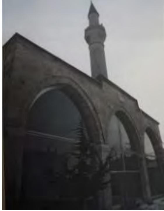
Fotoğraf No:5 Kurşunlu Cami Kuzey Cephe Bölümü Onarım Sonrası(2012) (EKVKBKMA)
