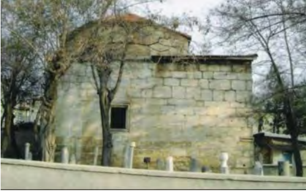
Fotoğraf No:5 Mahmud Suzani Türbesi Kuzey Cephe Bölümü(2000?) (Erol ALTINSAPAN)
