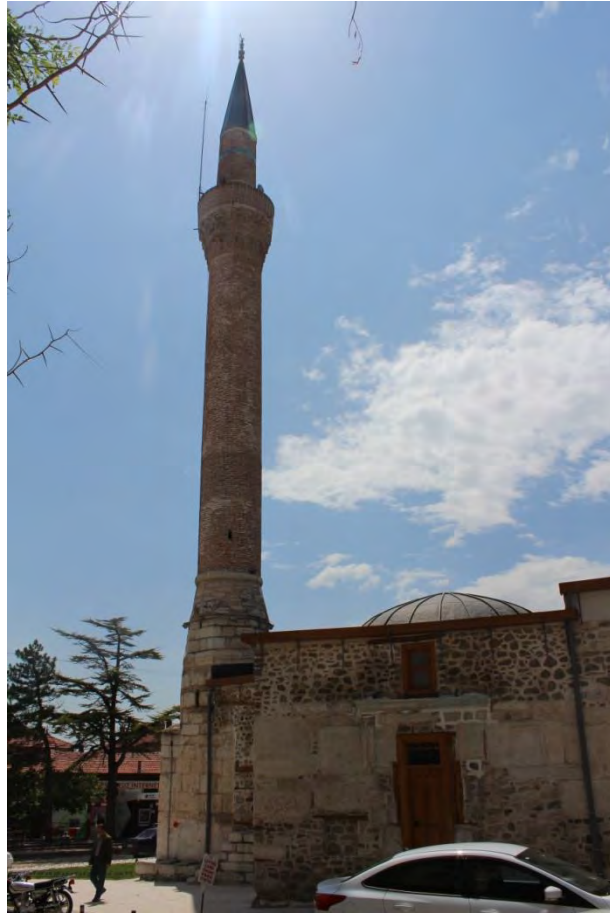
Fotoğraf No:25 Ulu Cami Minare Bölümü(2017) (Sinan ÜNAL)
