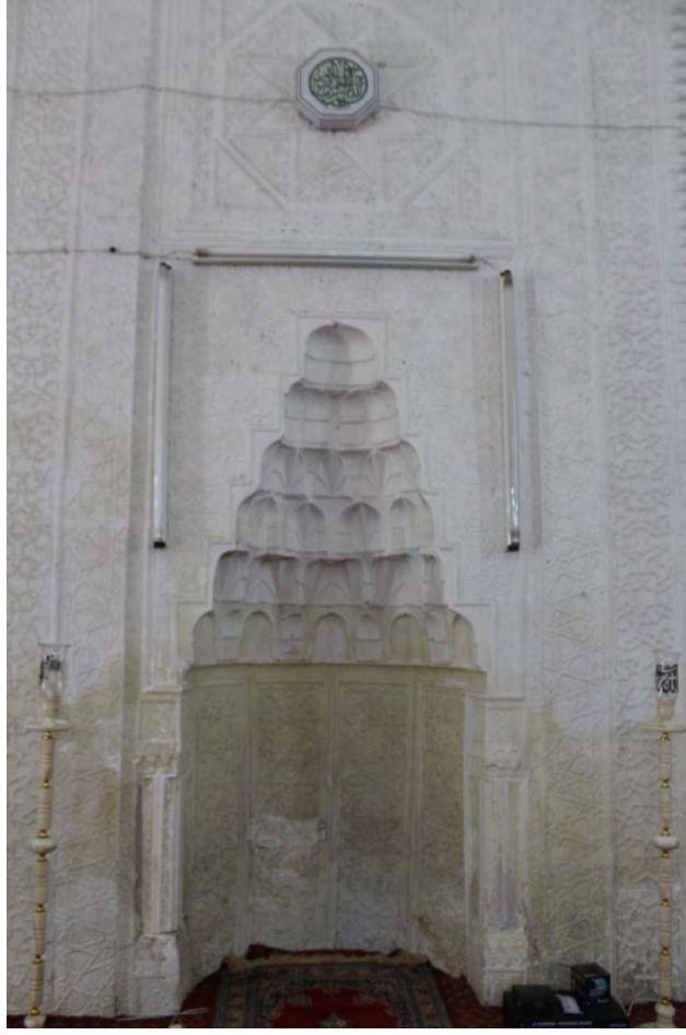
Fotoğraf No:31 Hazinedar Cami Harim Güney Cephe Mihrap Bölümü Detay(2017) (Sinan ÜNAL)
