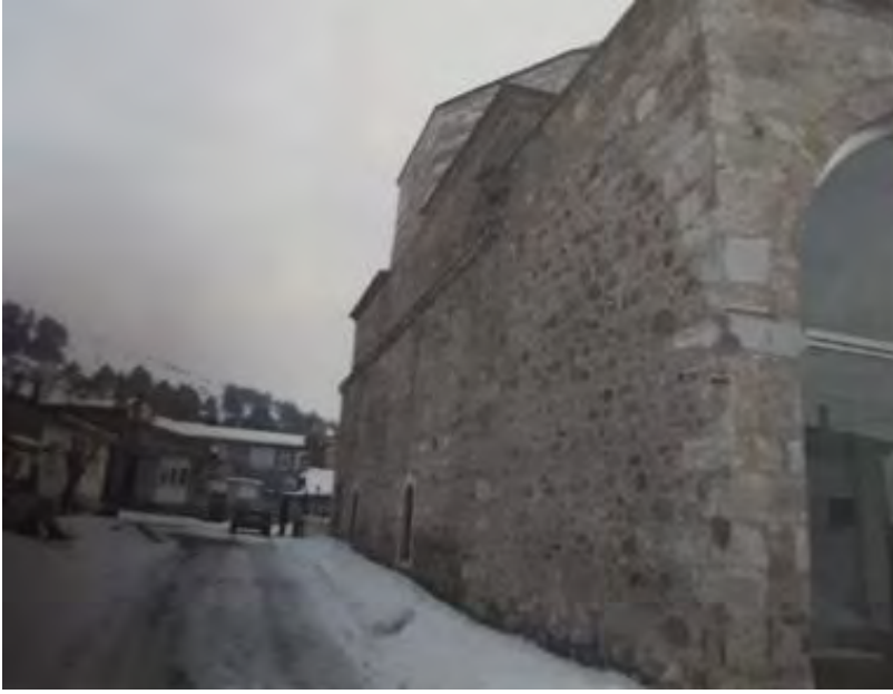
Fotoğraf No:7 Kurşunlu Cami Doğu Cephe Bölümü Onarım Sonrası(2012) (EKVKBKMA)
