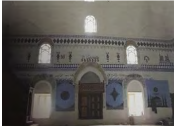
Fotoğraf No:23 Kurşunlu Cami Harim Batı Cephe Bölümü Onarım Sonrası(2012) (EKVKBKMA)
