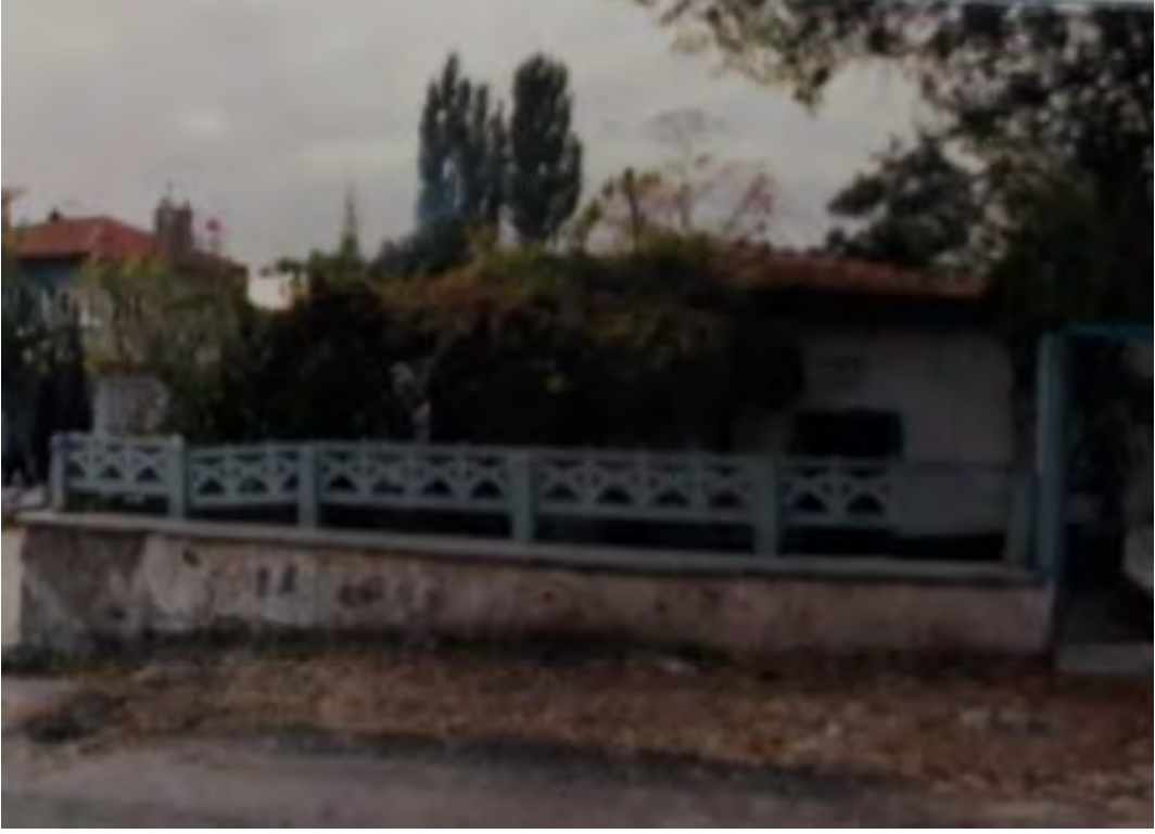
Fotoğraf No:2 Ali Dede Türbesi Doğu Cephe Bölümü(2003) (EKVKBKMA)
