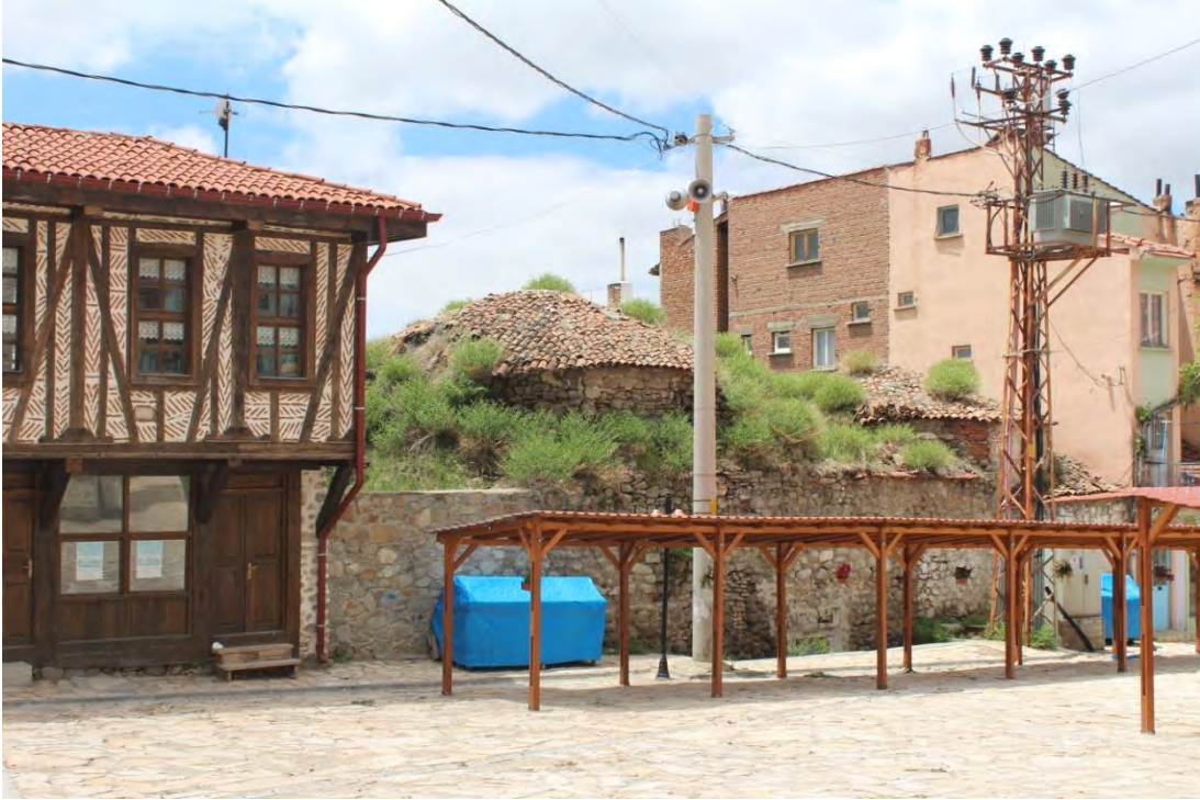
Fotoğraf No:3 Yeni(Çifte)Hamam Kuzey Cephe Bölümü(2017) (Sinan ÜNAL)
