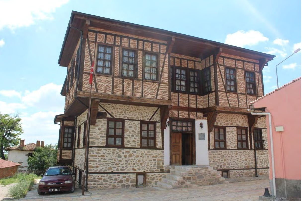
Fotoğraf No:10 Zaim Ağa Konağı Kuzey Cephe Bölümü(2017) (Sinan ÜNAL)
