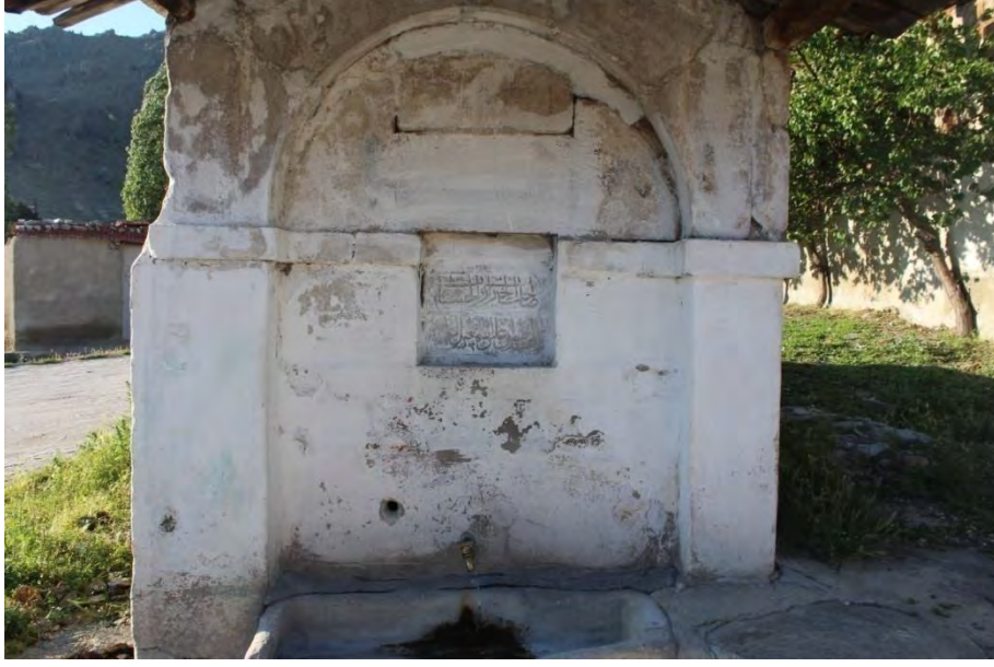
Fotoğraf No:2 Kavakdibi Çeşmesi Güney Cephe İle Kitabe Bölümü(2018) (Sinan ÜNAL)
