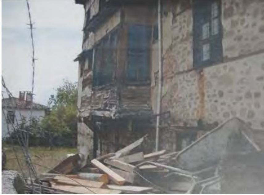
Fotoğraf No:4 Zaim Ağa Konağı Güney Cephe Bölümü(2007) (EKVKBKMA)
