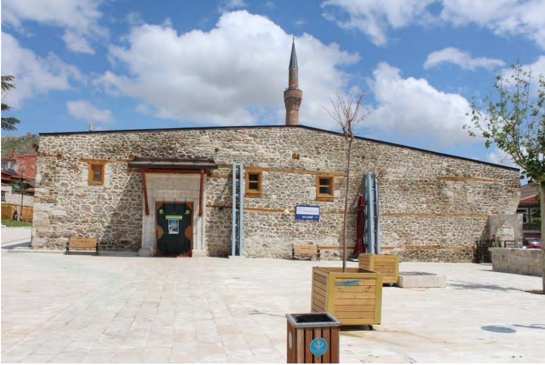
Fotoğraf No:21 Ulu Cami Batı Cephe Bölümü Giriş Açıklığı(2017) (Sinan ÜNAL)
