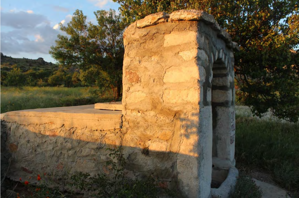
Fotoğraf No:2 Hisarbağı Çeşmesi Kuzey Cephe Ve Su Deposu Bölümü(2017) (Sinan ÜNAL)
