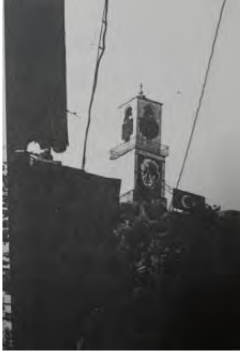
Fotoğraf No:3 Sivrihisar Saat Kulesi Güney ile Batı Cephe Bölümü(1988) (EKVKBKMA)
