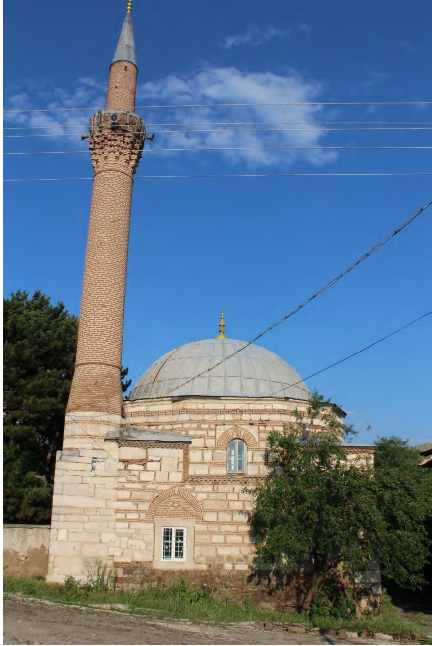
Fotoğraf No:20 Hoşkadem Cami Batı Cephe ile Minare (2017) (Sinan ÜNAL)
