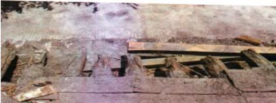
Fotoğraf No:15 Ulu Cami Çatı Örtü Sistemi Tahribatlarının Giderilmesi(2013) (Sinan ÜNAL)
