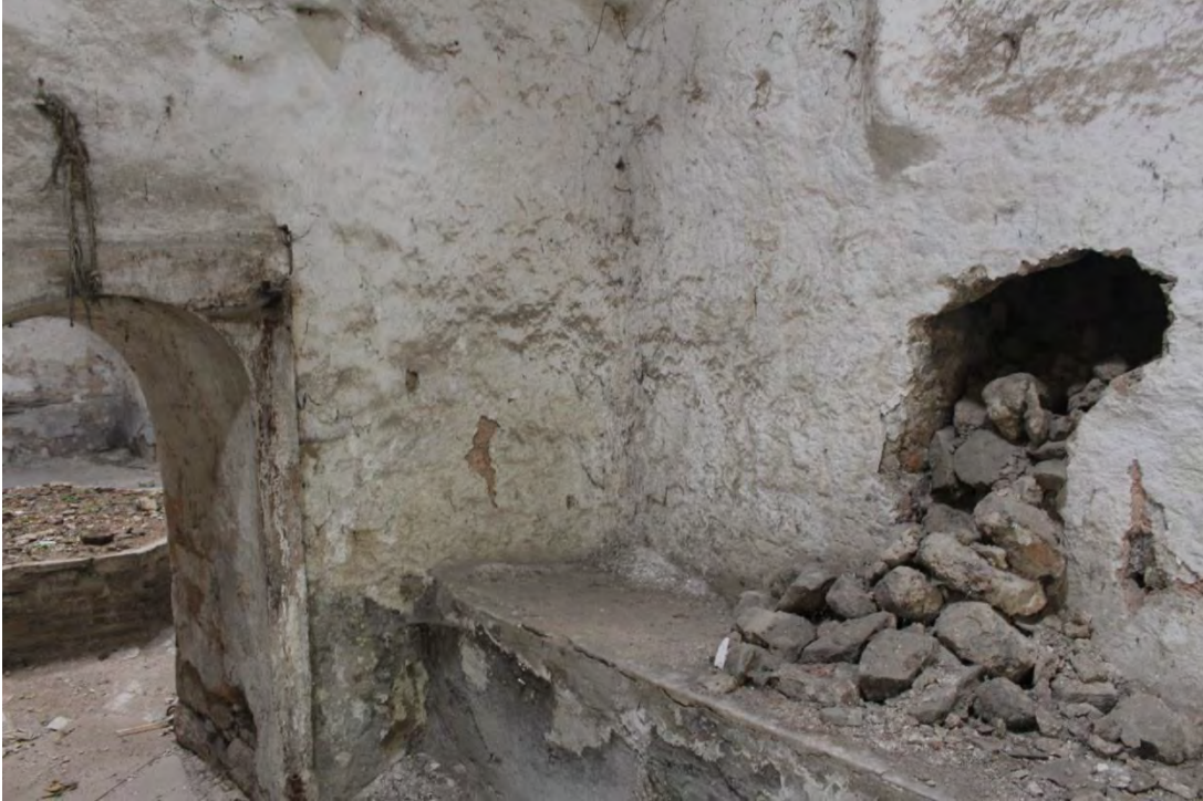
Fotoğraf No:6 Kumacık Hamamı Ilıklık Bölümü(2017) (Sinan ÜNAL)
