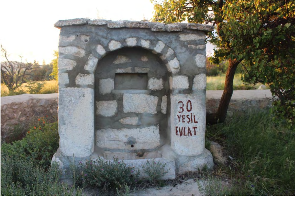
Fotoğraf No:1 Hisarbağı Çeşmesi Batı Cephe Bölümü(2017) (Sinan ÜNAL)
