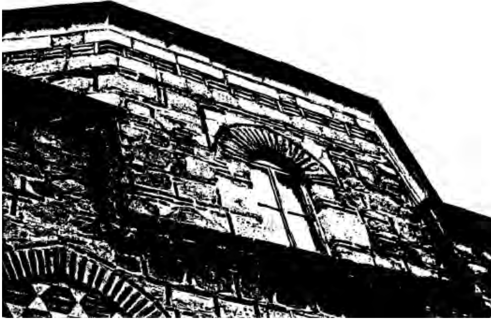
Fotoğraf No:9 Cami Batı Cephe Kubbe Kasmağı(1988) (Erol ALTINSAPAN)
