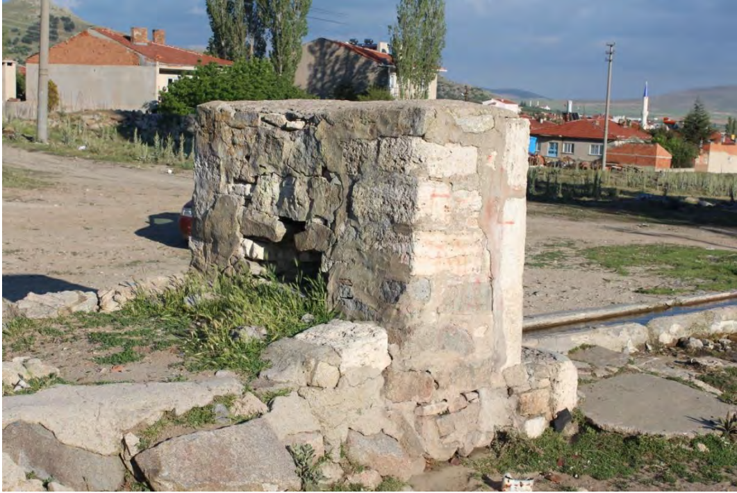
Fotoğraf No:3 Çoban Çeşmesi Yan Cephe İle Arka Cephe Bölümü(2018) (Sinan Ünal)
