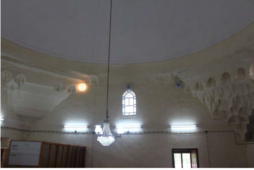
Fotoğraf No:29 Hazinedar Cami Harim Batı Cephe Kubbe Eteği(2017) (Sinan ÜNAL)
