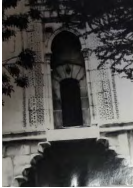
Fotoğraf No:2 Alemşah Türbesi Doğu Cephe Bölümü(1980) (EKVKBKMA)
