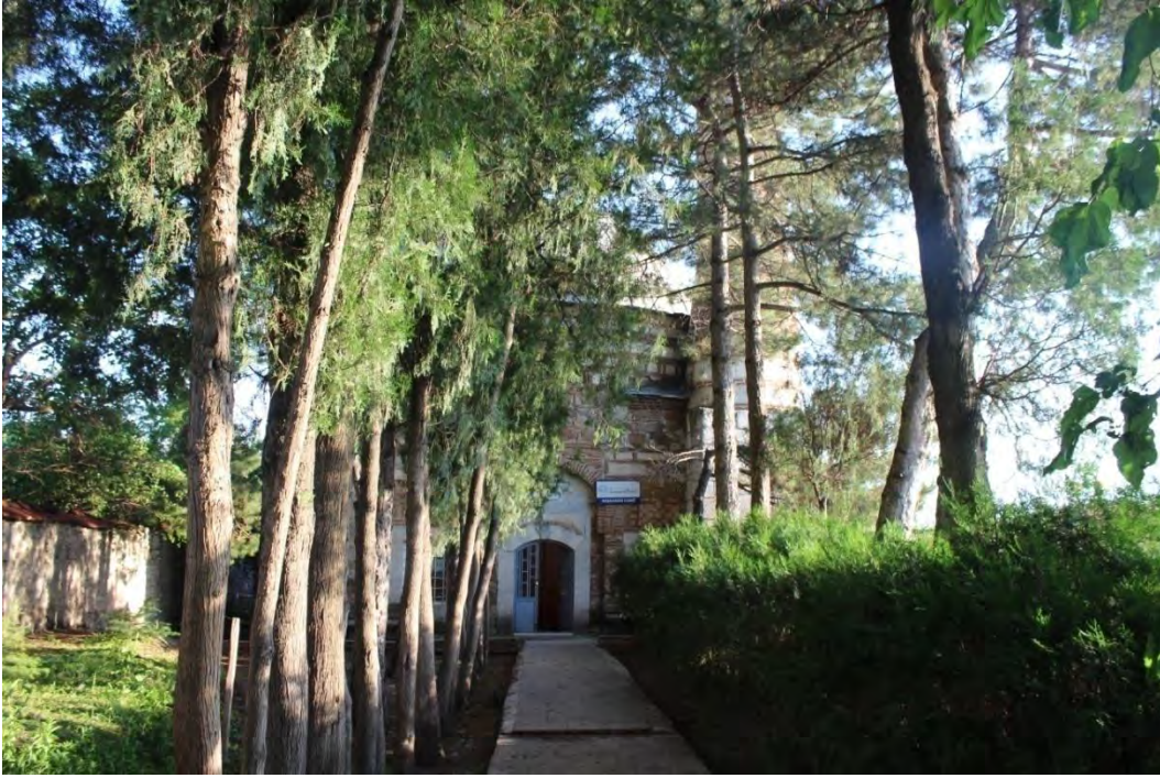
Fotoğraf No:19 Hoşkadem Cami Kuzey Cephe Bölümü(2017) (Sinan ÜNAL)
