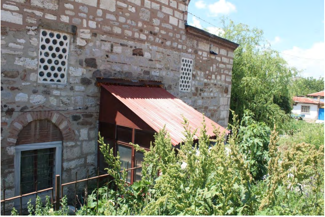
Fotoğraf No:23 Hazinedar Cami Kuzey Cephe Pencere Bölümleri(2017) (Sinan ÜNAL)
