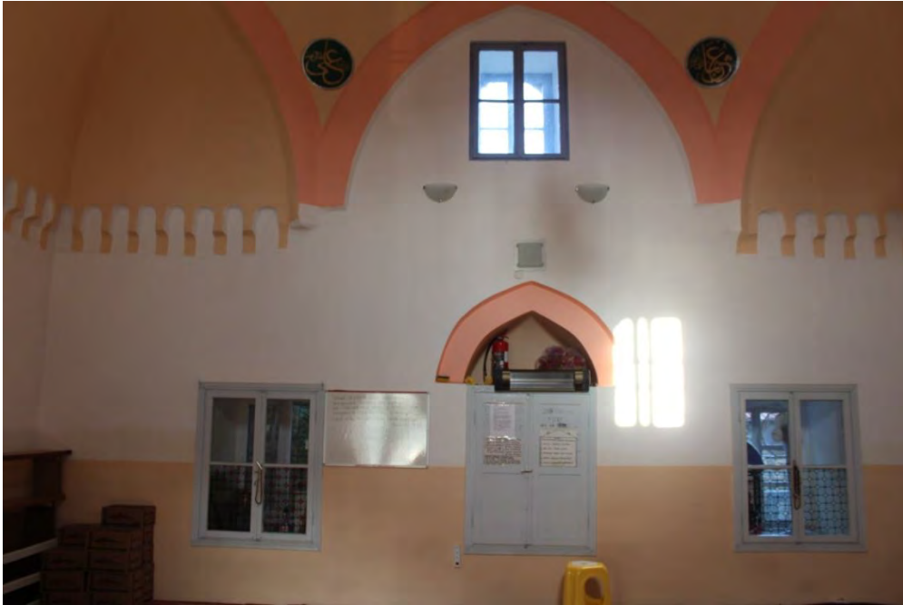
Fotoğraf No:30 Hoşkadem Cami Doğu Cephe Ve Niş Bölümü (2017) (Sinan ÜNAL)
