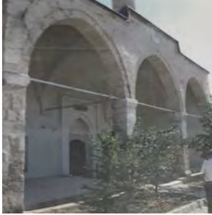
Fotoğraf No:12 Kurşunlu Cami Batı Cephe Bölümü Son Cemaat yeri Onarım Öncesi(2008) (EKVKBKMA)
