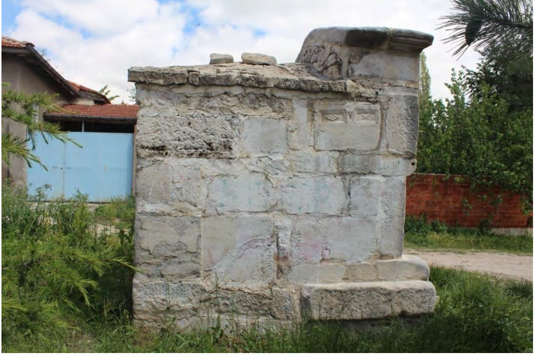
Fotoğraf No:7 Ak Çeşme Batı Cephe Bölümü(2017) (Sinan ÜNAL)
