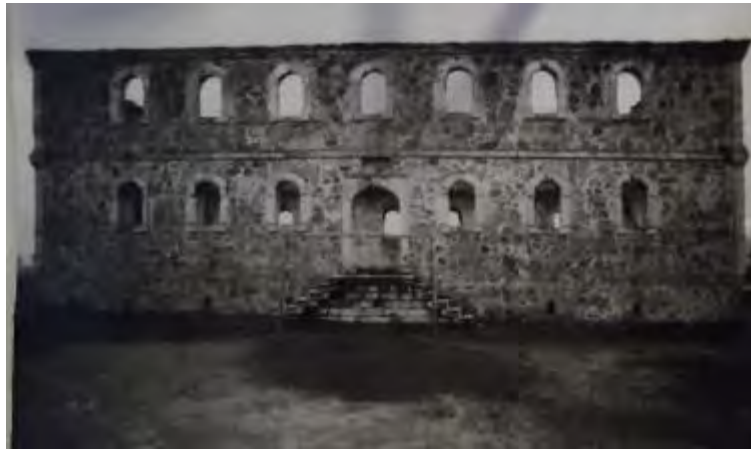
Fotoğraf No:1 Askerlik Şubesi 1 Nolu Yapı Kuzey Cephe Bölümü(1987) (EKVKBKMA)
