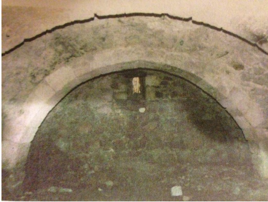
Fotoğraf No:8 Mahmud Suzani Türbesi Cenazelik Doğu Cephe Bölümü(2006) (Erol ALTINSAPAN)
