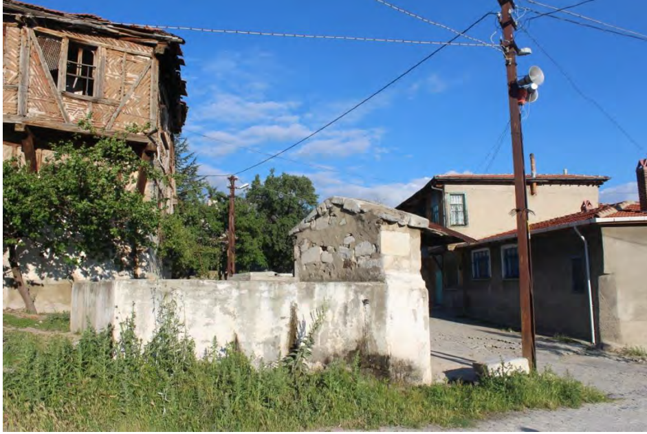
Fotoğraf No:3 Kavakdibi Çeşmesi Kuzey ve Doğu Cephe Bölümü(2018) (Sinan ÜNAL)
