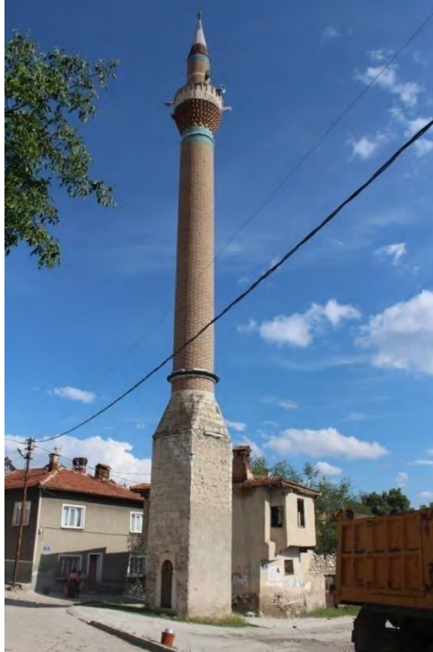
Fotoğraf No:2 Tek Minare Kuzey Cephe ve Batı Cephe Bölümü (2017) (Sinan ÜNAL)
