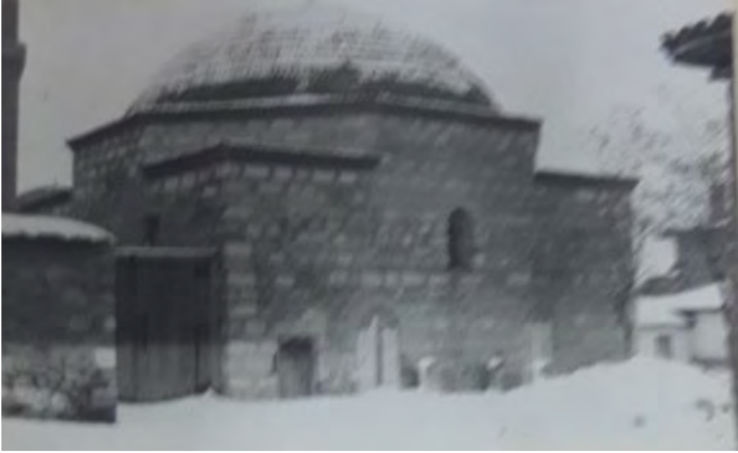
Fotoğraf No:4 Hazinedar Cami Kubbe Bölümü(1965) (EKVKBKMA)
