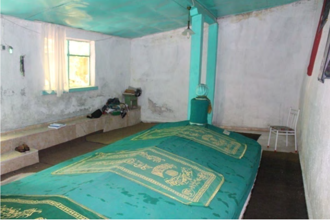
Fotoğraf No:3 Cafer Tayyar Türbesi Batı Cephe Bölümü (2017) (Sinan ÜNAL)
