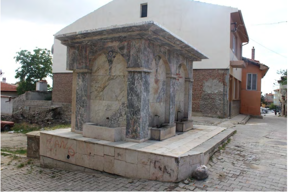
Fotoğraf No:2 Kurtlu Çeşme Doğu Ve Kuzey Cephe Bölümü(2017) (Sinan ÜNAL)
