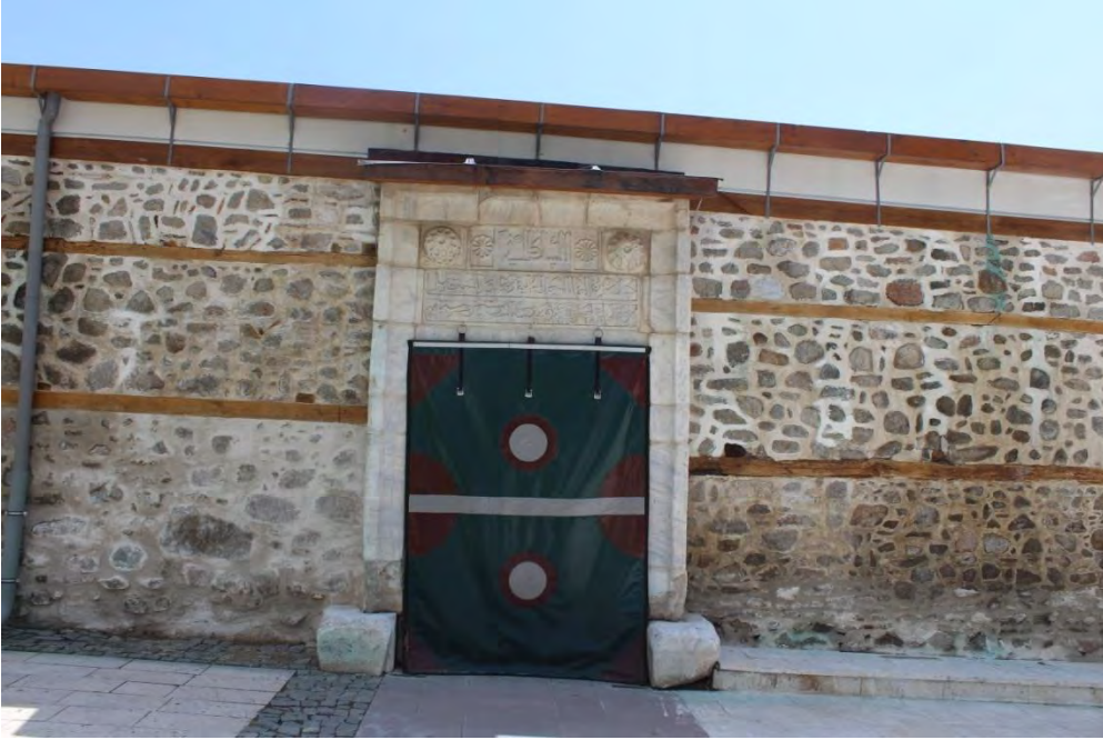
Fotoğraf No:17 Ulu Cami Kuzey Cephe Giriş Açıklığı (2017) (Sinan ÜNAL)
