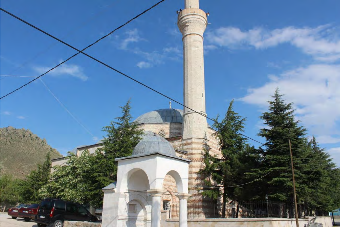
Fotoğraf No:27 Kurşunlu Cami Batı Cephe Bölümü (2017) (Sinan ÜNAL)
