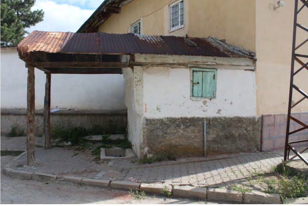
Fotoğraf No:2 Yenice eşme Kuzey cephe Bölümü ile Su Deposu Bölümü(2018) (Sinan Ünal)
