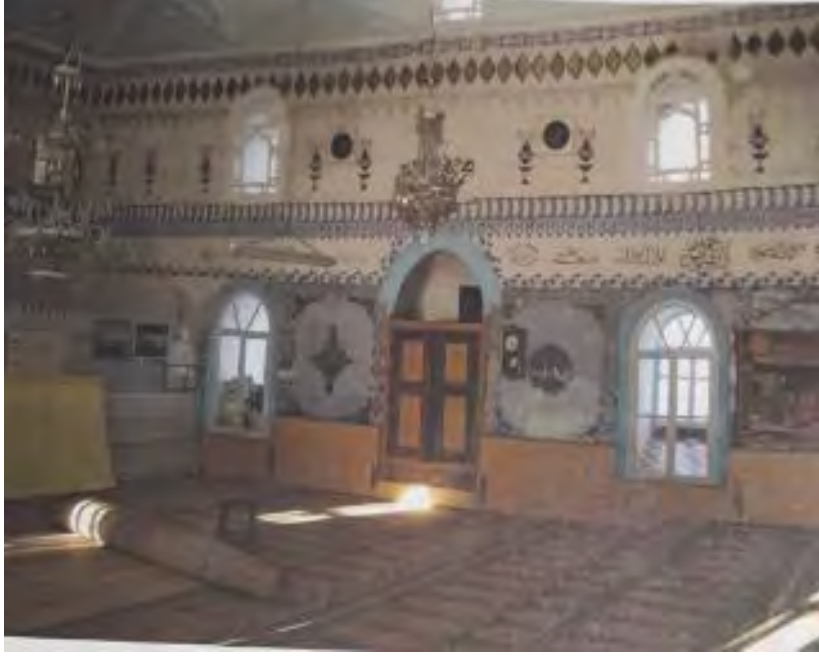
Fotoğraf No:20 Kurşunlu Cami Harim Doğu Cephe Bölümü Onarım Öncesi(2008) (EKVKBKMA)
