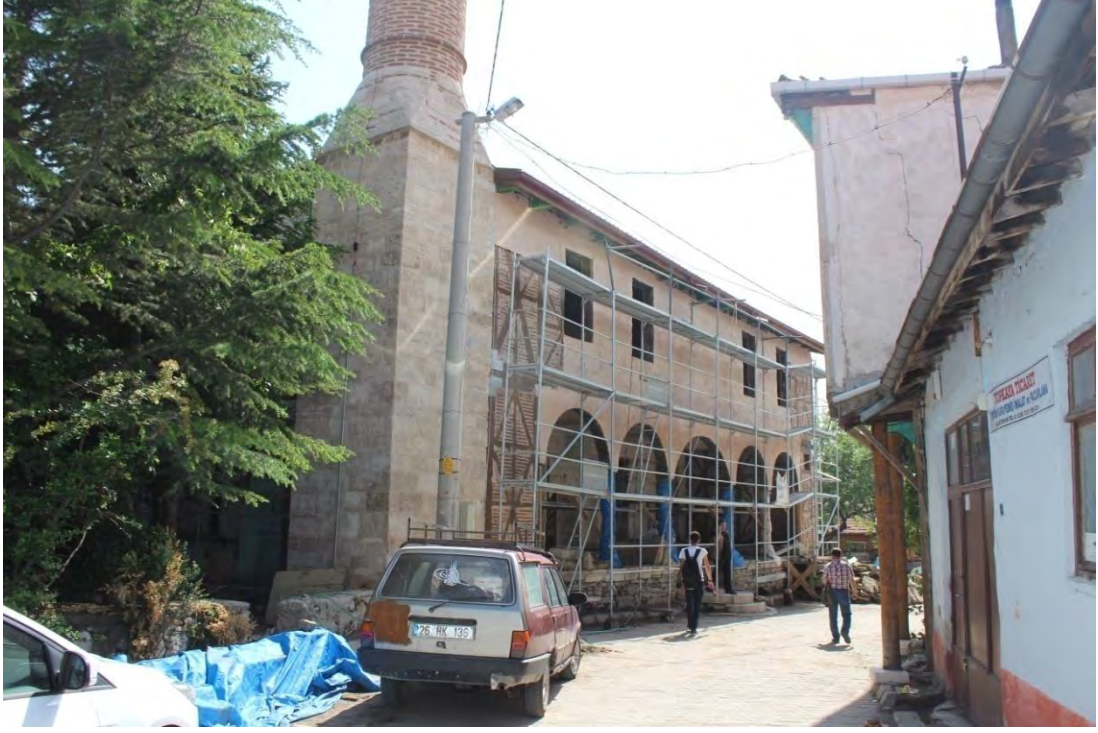
Fotoğraf No:16 Yeni Cami Kuzey Cephe Bölümü(2017) (Sinan ÜNAL)
