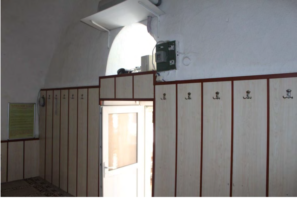
Fotoğraf No:15 Kumbet Cami Kuzey Cephe Bölümü(2017) (Sinan ÜNAL)
