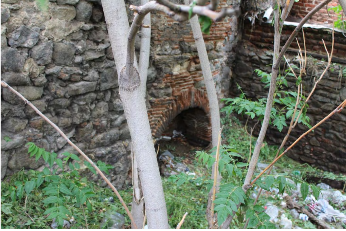
Fotoğraf No:9 Kumacık Hamamı Külhan Bölümü(2017) (Sinan ÜNAL)
