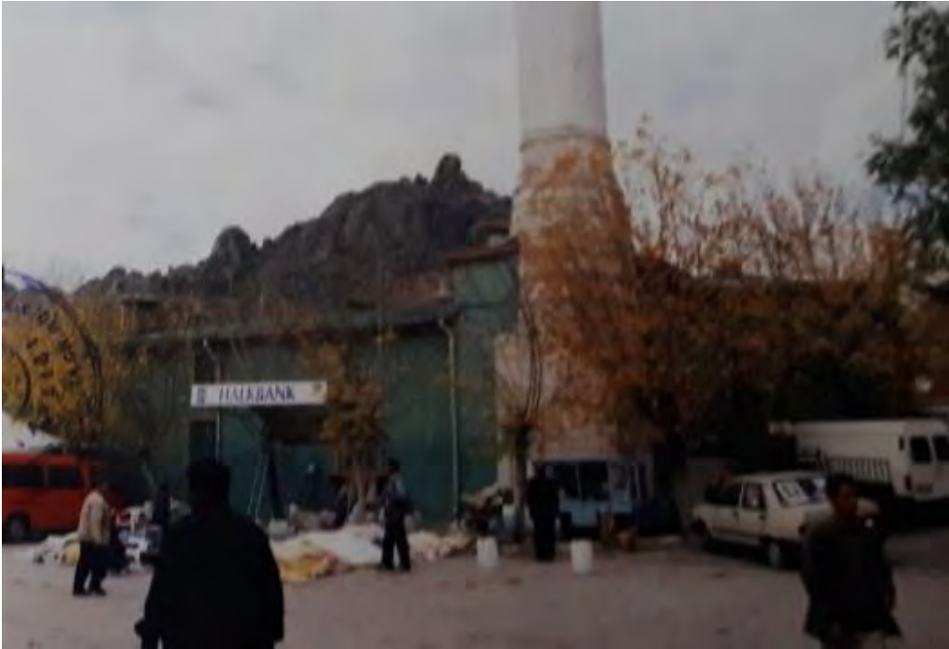
Fotoğraf No:9 Ulu Cami Güney Cephe Bölümü Ve Minare Bölümü(2003) (EKVKBKMA)
