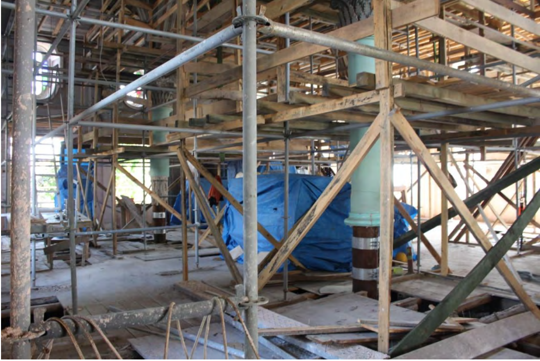
Fotoğraf No:21 Yeni Cami Harim Kuzey ve Batı Cephe Bölümü(2017) (Sinan ÜNAL)
