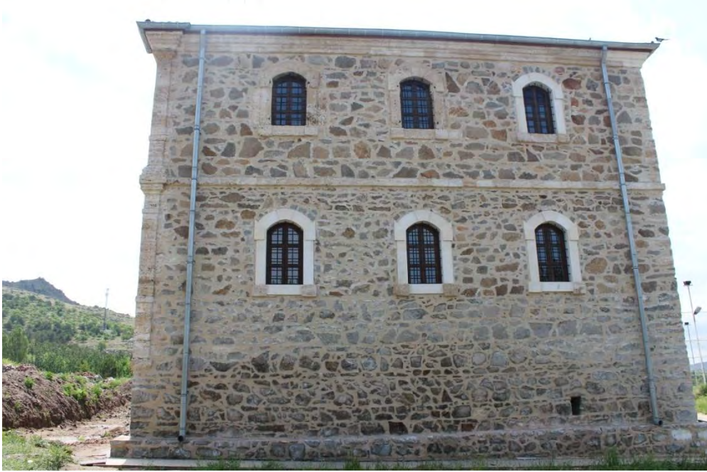
Fotoğraf No:9 Askerlik Şubesi 1 Nolu Yapı Batı Cephe Bölümü (2018) (Sinan ÜNAL)
