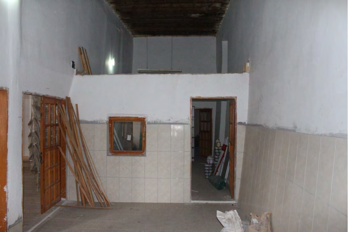
Fotoğraf No:14 Elmalı Cami Bat Cephe Bölümüne Bakış(2018) (Sinan ÜNAL)
