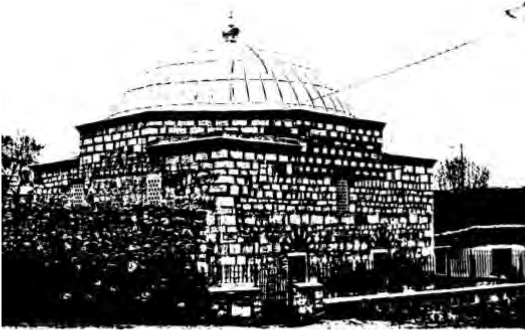
Fotoğraf No:6 Hazinedar Cami Kuzey Ve Batı Cephe Bölümü(1988) (Erol ALTINSAPAN)
