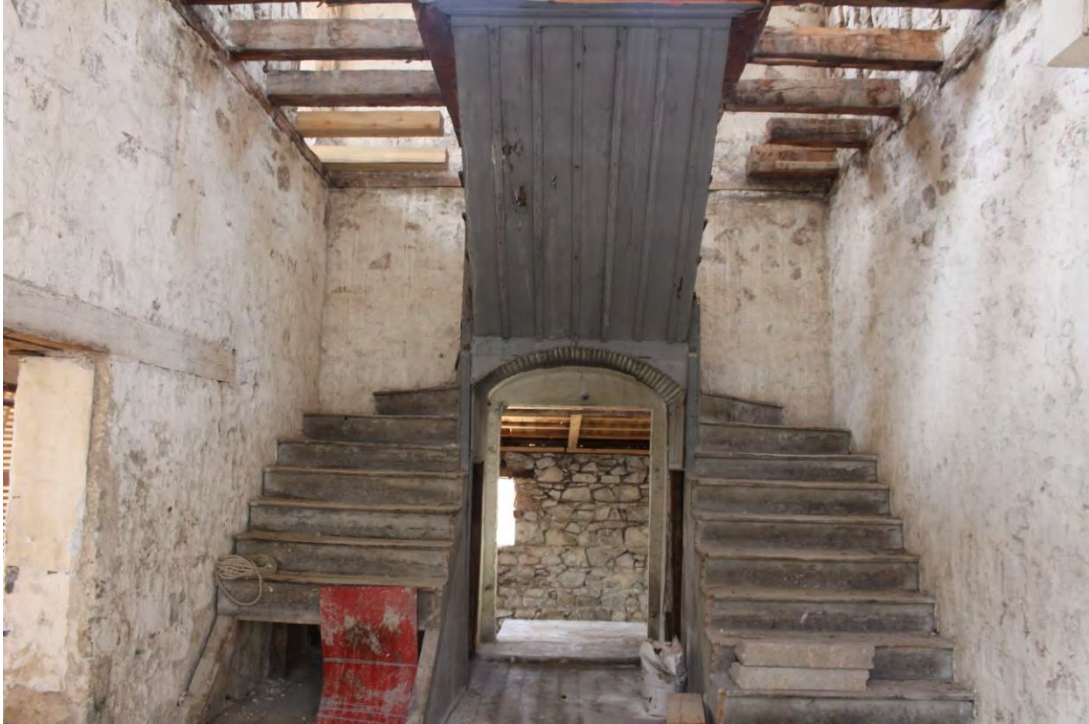
Fotoğraf No:12 Askerlik Şubesi 2 Nolu Yapı Zemin Kat Merdiven Bölümü(2017) (Sinan ÜNAL)
