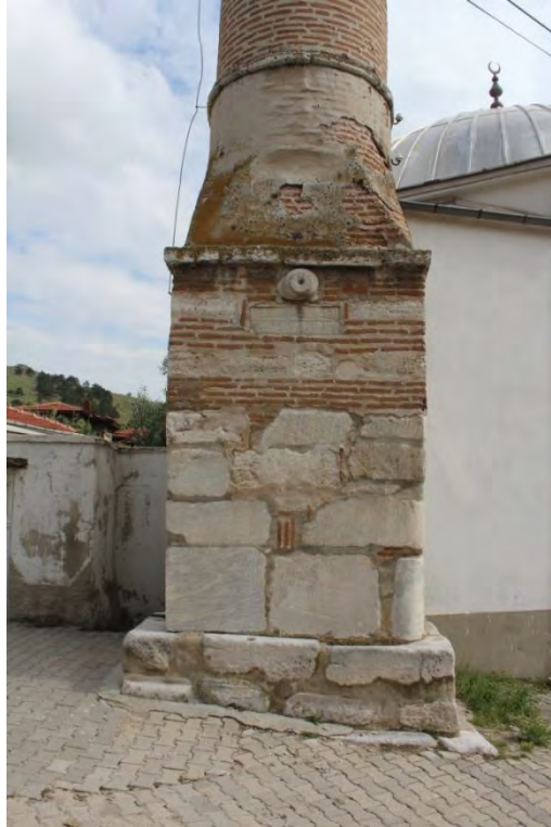
Fotoğraf No:3 Ak Minare Kuzey Cephe Bölümü (2017) (Sinan Ünal)
