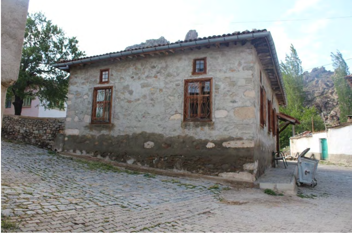
Fotoğraf No:14 Akdoğan Mescidi Güney Cephe Bölümü(2017) (Sinan ÜNAL)
