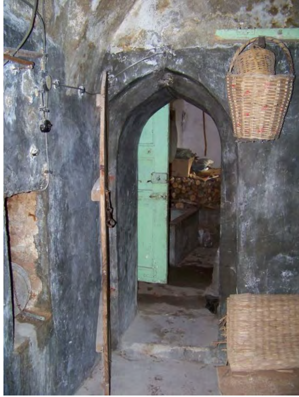
Fotoğraf No:4 Sinan Paşa Hamamı Sıcaklık Bölümü(2018) (M.Soner Özdemir )
