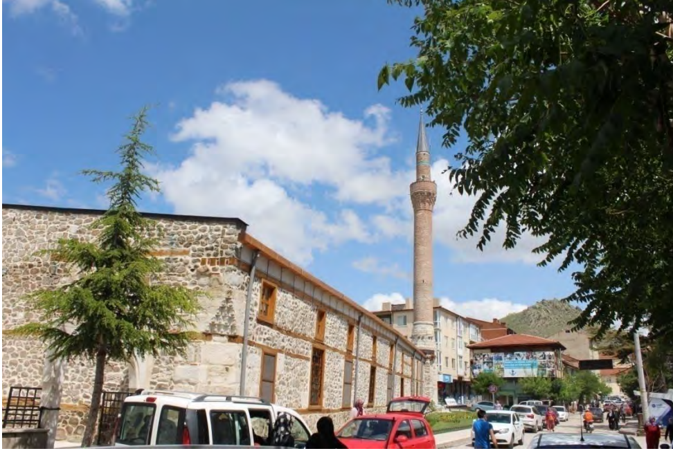
Fotoğraf No:19 Ulu Cami Batı ve Güney Cephe Bölümü(2017) (Sinan ÜNAL)
