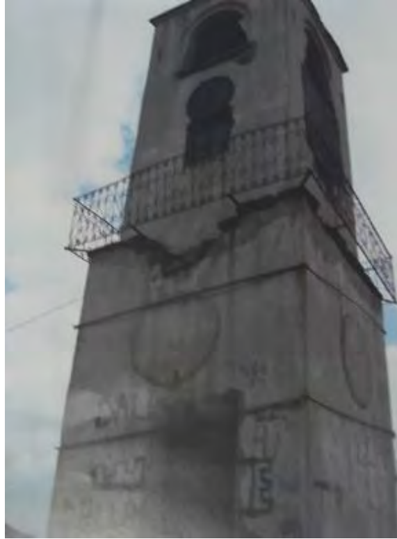
Fotoğraf No:5 Sivrihisar Saat Kulesi Kuzey Cephe Bölümü(2010) (EKVKBKMA)
