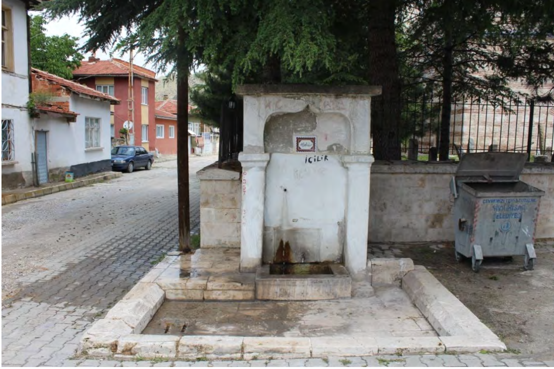
Fotoğraf No:3 Osmancık Çeşmesi Güney Cephe Bölümü (2017) (Sinan Ünal)
