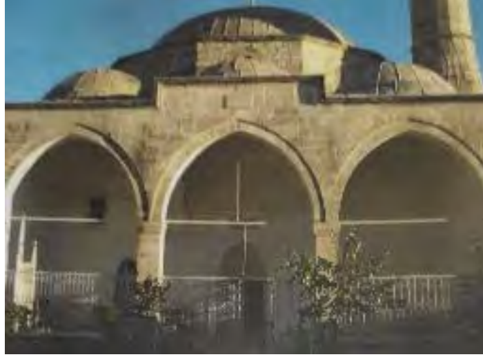
Fotoğraf No:4 Kurşunlu Cami Kuzey Cephe Bölümü Onarım Öncesi(2008) (EKVKBKMA)
