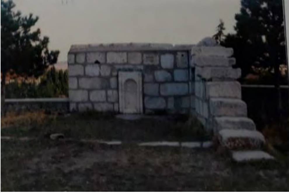
Fotoğraf No:2 Namazgah(Hacı Musalla) Güney Cephe Bölümü(2003) (EKVKBKMA)
