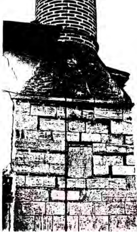
Fotoğraf No:3 Bodur Cami Minare Bölümü(1988) (Erol ALTINSAPAN)
