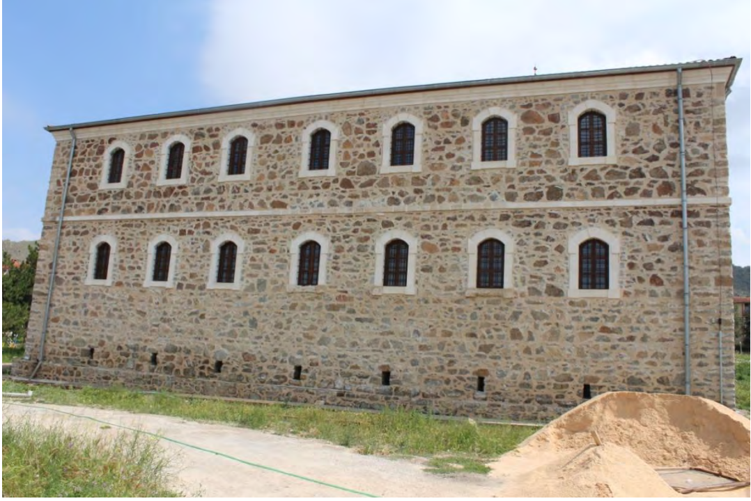
Fotoğraf No:8 Askerlik Şubesi 1 Nolu Yapı Güney Cephe Bölümü (2018) (Sinan ÜNAL)
