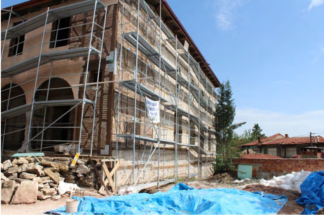
Fotoğraf No:17 Yeni Cami Kuzey ve Batı Cephe Bölümü(2017) (Sinan ÜNAL)
