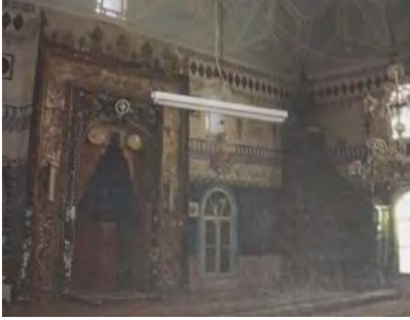
Fotoğraf No:18 Kurşunlu Cami Mihrap Bölümü Onarım Öncesi(2008) (EKVKBKMA)
