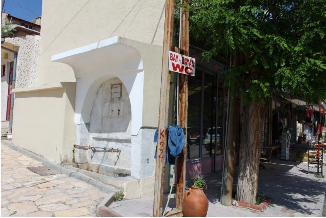
Fotoğraf No:4 Kağnı pazar Çeşme Batı Cephe Ve Güney Cephe(2017) (Sinan ÜNAL)
