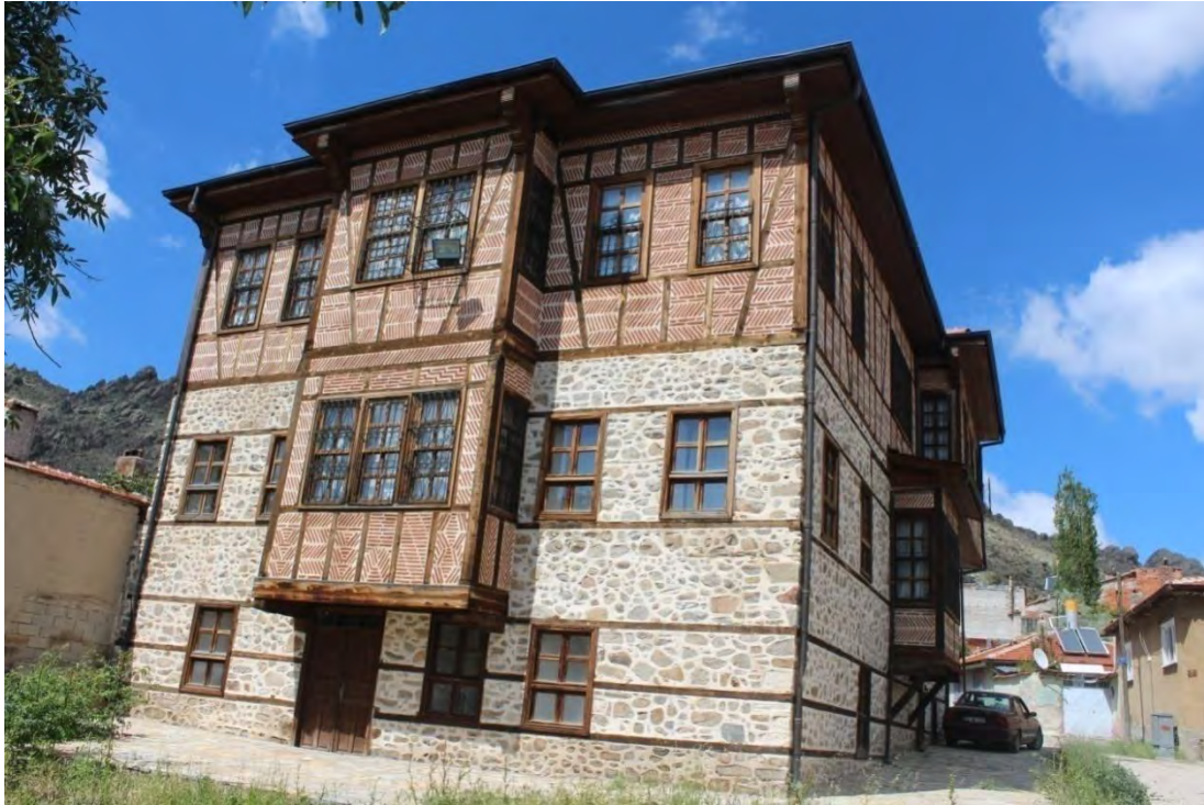
Fotoğraf No:12 Zaim Ağa Konağı Güney Cephe Bölümü(2017) (Sinan ÜNAL)
