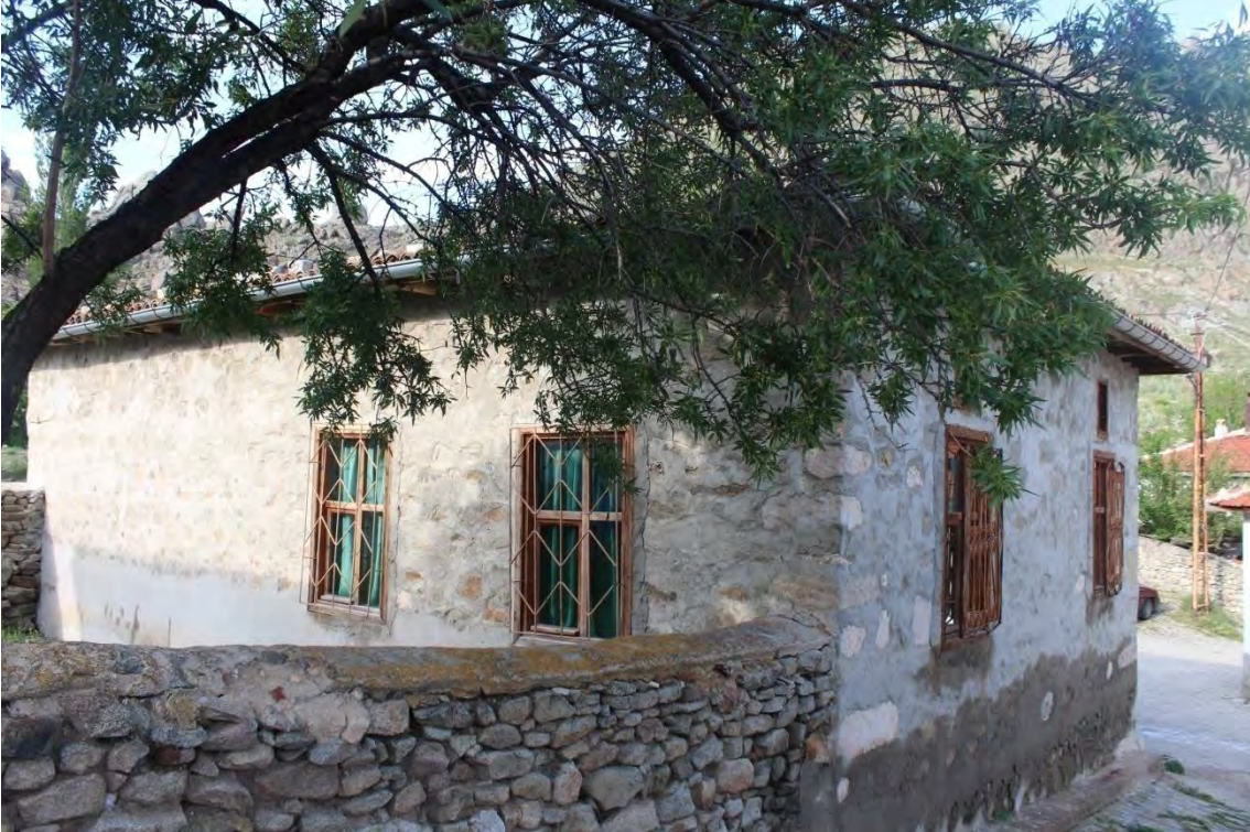
Fotoğraf No:15 Akdoğan Mescidi Batı Ve Güney Cephe Bölümü(2017) (Sinan ÜNAL)
