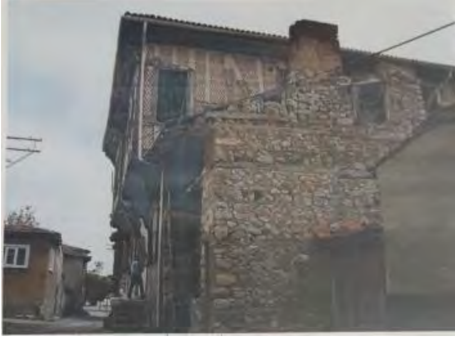
Fotoğraf No:5 Zaim Ağa Konağı Batı Cephe Bölümü(2007) (EKVKBKMA)
