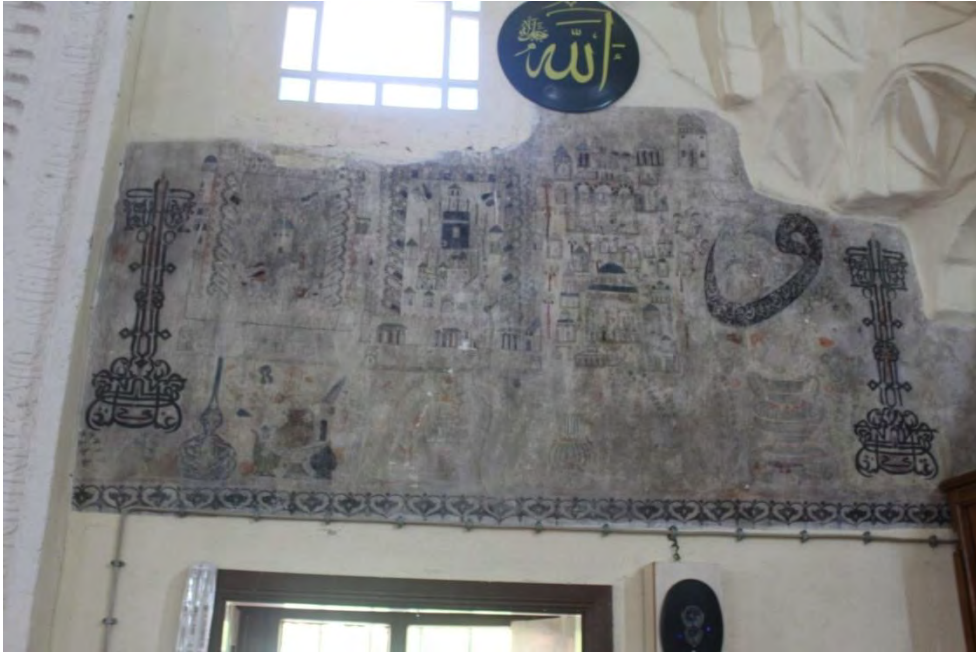
Fotoğraf No:36 Hazinedar Cami Harim Güney Cephe Kalem İşleri(Sağ Bölüm)(2017) (Sinan ÜNAL)
