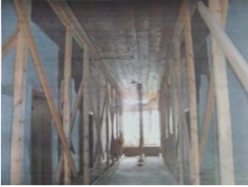
Fotoğraf No:7 Zaim Ağa Konağı Zemin kat Bölümü(2007) (EKVKBKMA)
