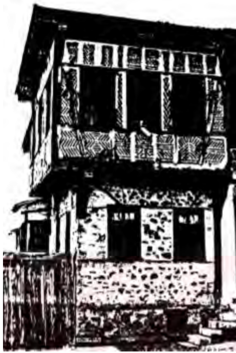
Fotoğraf No:2 Zaim Ağa Konağı Kuzey Cephe Ve Doğu Cephe Bölümü(1988) (Erol ALTINSAPAN)
