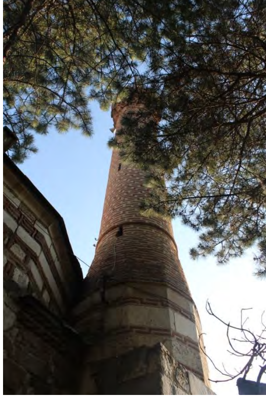
Fotoğraf No:21 Hoşkadem Cami Minare Bölümü (2017) (Sinan ÜNAL)
