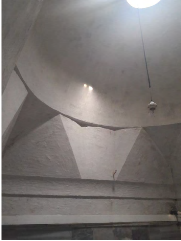
Fotoğraf No:17 Seydiler Hamamı Sıcaklık Bölümü Kubbeye Geçiş Öğeleri(2017) (Sinan ÜNAL)
