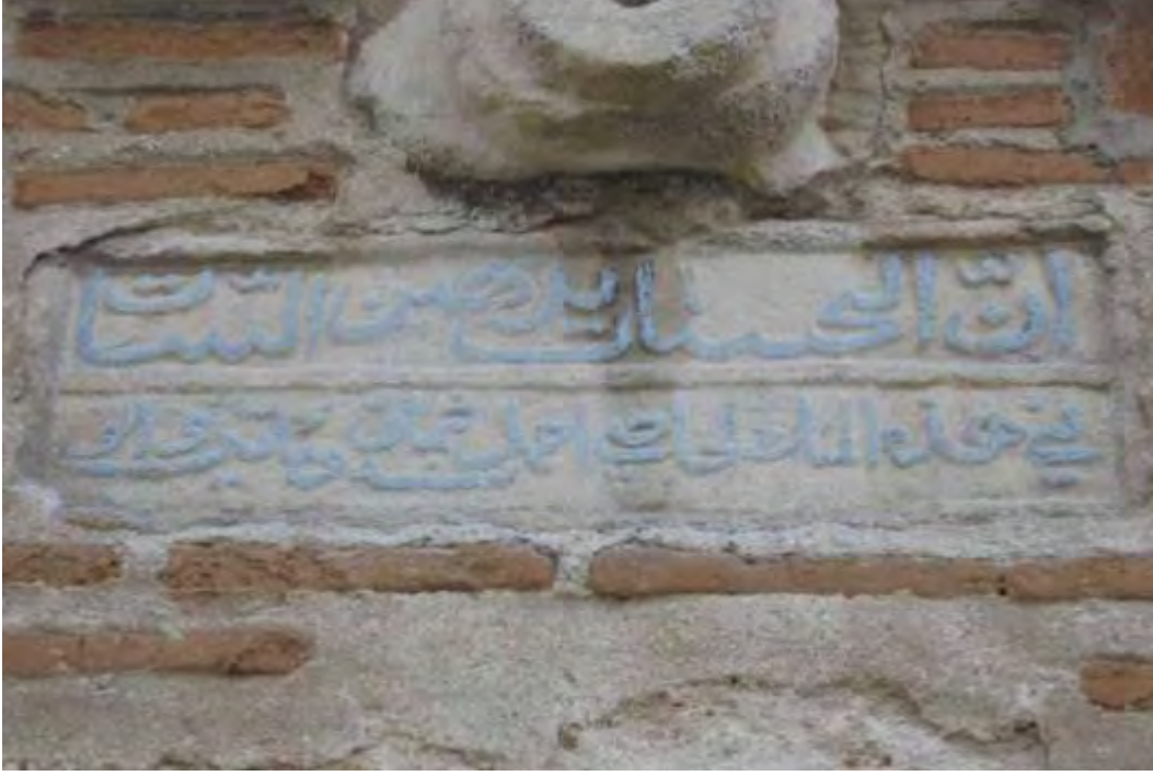
Fotoğraf No:4 Ak Minare Kitabe Bölümü (2014) (Nizamettin Arslan)
