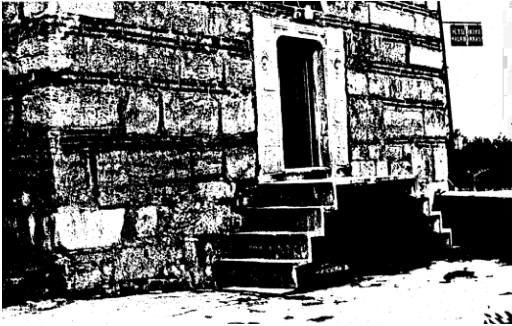
Fotoğraf No:2 Kümbet Cami Kuzey Cephe Bölümü İle Giriş Açıklığı(1988) (Erol ALTINSAPAN)
