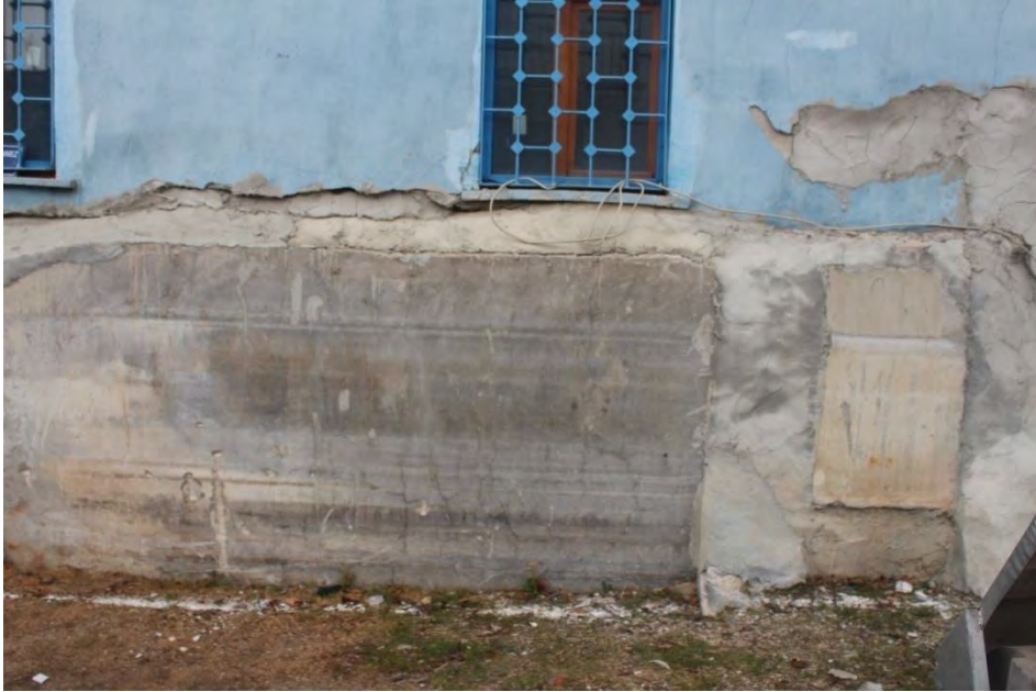
Fotoğraf No:3 Elmalı Çeşme Doğu Cephe Bölümü(2018) (Sinan ÜNAL)
