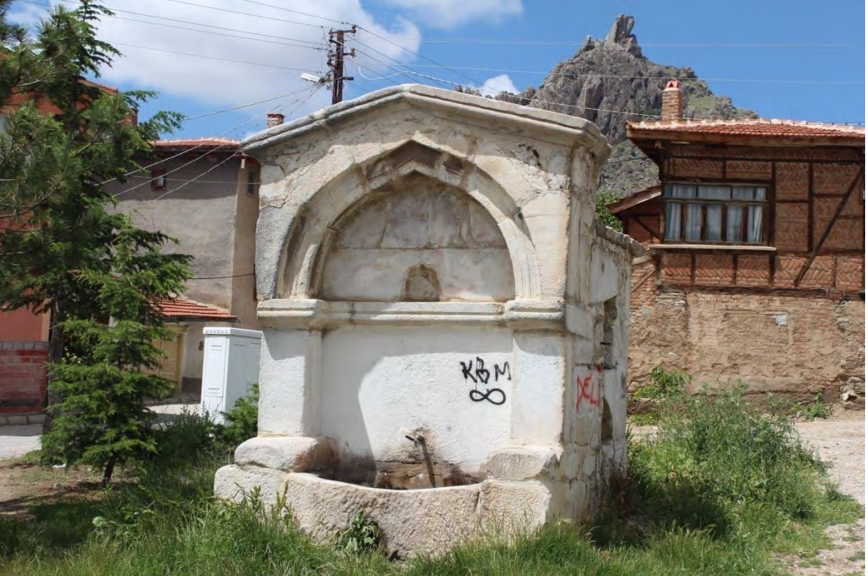
Fotoğraf No:6 Ak Çeşme Yeni Konumu Ve Kuzey Cephe Bölümü(2017) (Sinan ÜNAL)
