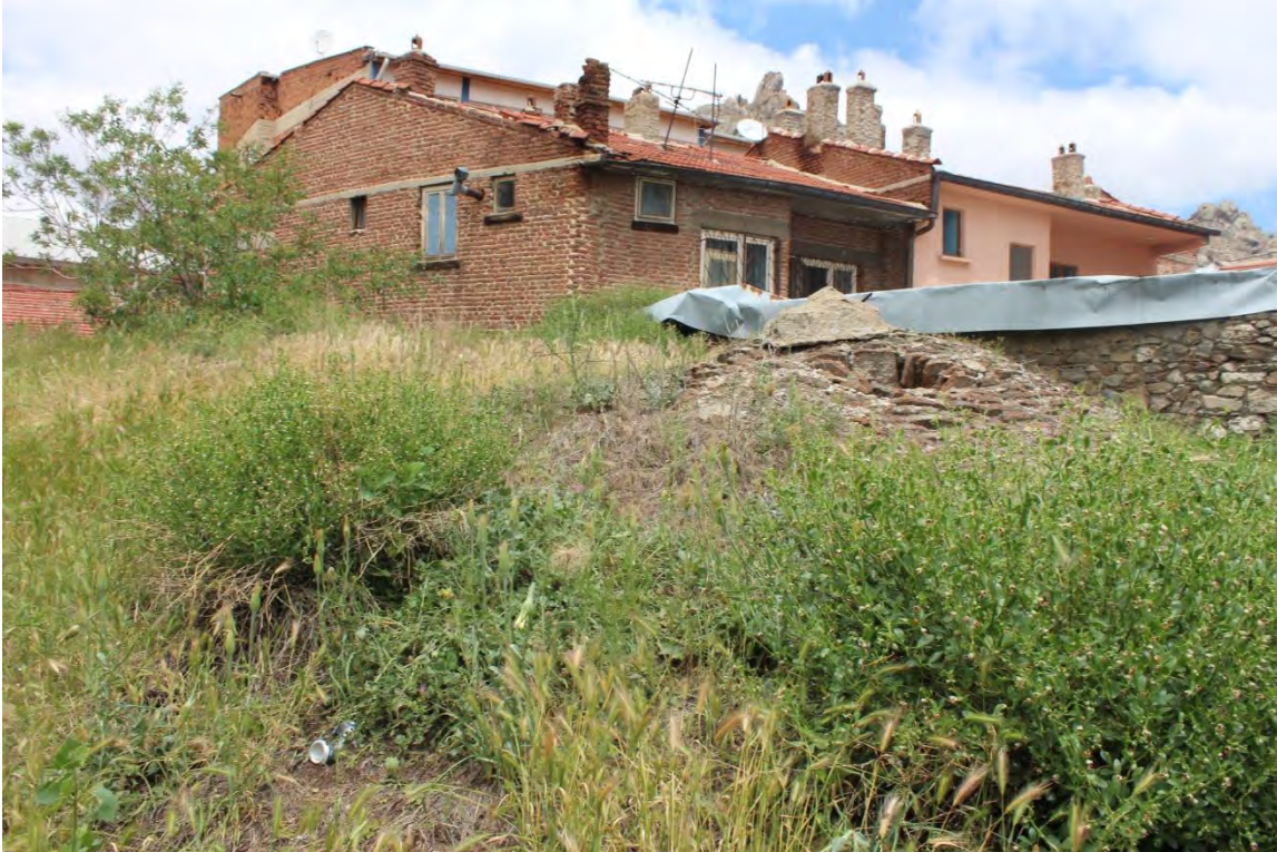
Fotoğraf No:10 Kumacık Hamamı Örtü Sistemi Bölümü(2017) (Sinan ÜNAL)
