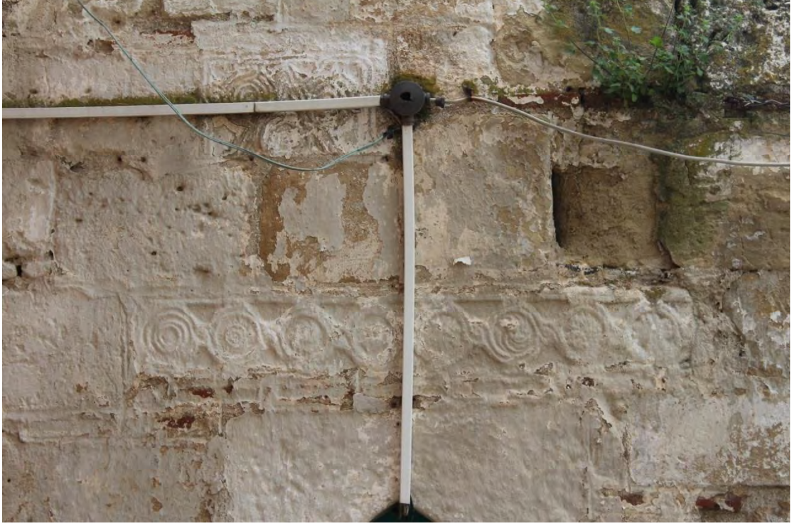
Fotoğraf No:29 Balaban Cami Minare Bölümü Kuzey Cephe Devşirme Malzemeler(2017) (Sinan ÜNAL)
