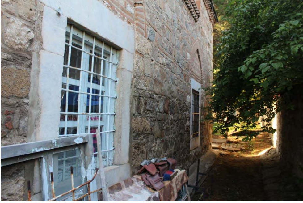
Fotoğraf No:23 Hoşkadem Cami Güney Cephe Bölümü(2017) (Sinan ÜNAL)
