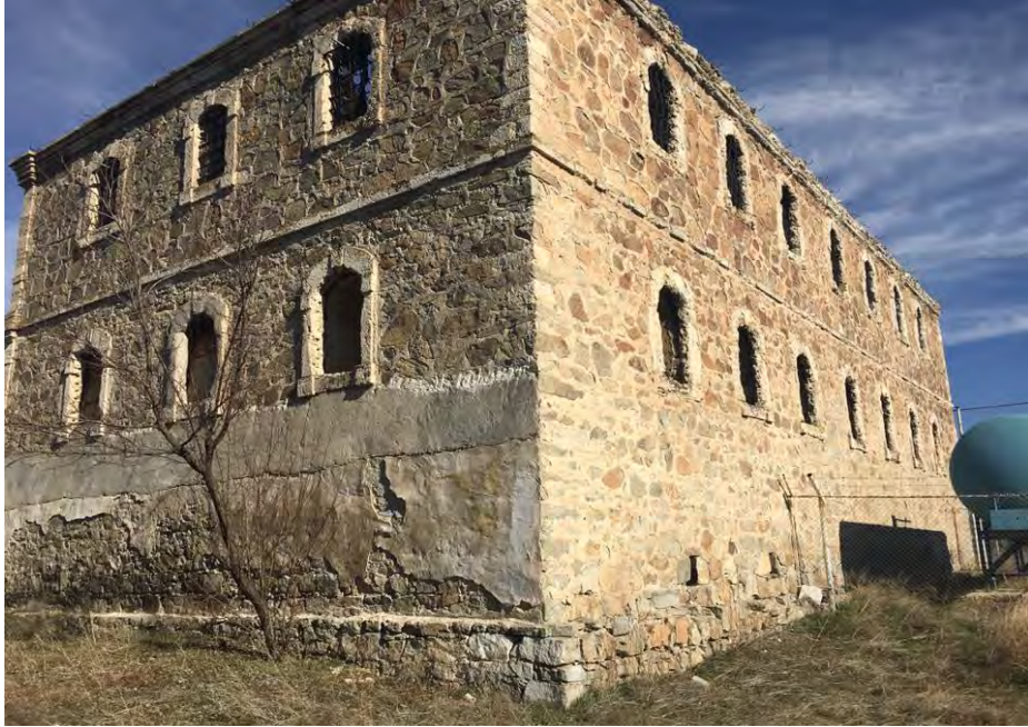
Fotoğraf No:5 Askerlik Şubesi 1 Nolu Yapı Batı ve Güney Cephe(2017) ( KAAN RESTORASYON İNŞ.TAAH.TUR.PROJE SAN.TİC.LTD.ŞTİ. )
