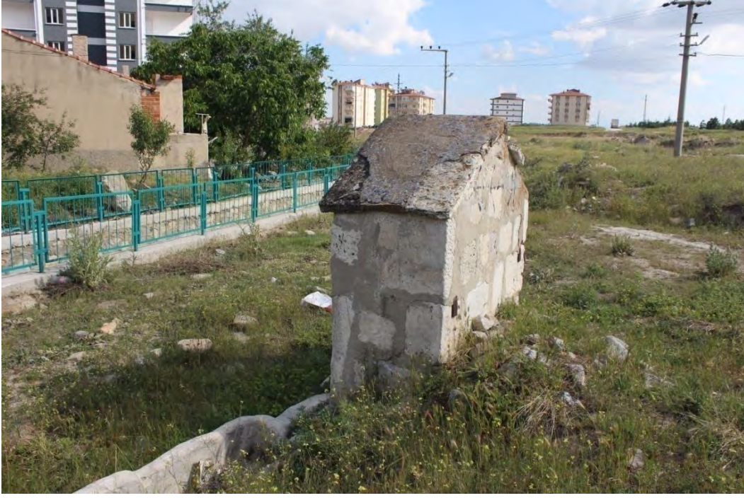
Fotoğraf No:4 Garipçe Çeşme Kuzey Cephe,Batı Cephe ve Su Deposu Bölümü(2017) (Sinan ÜNAL)
