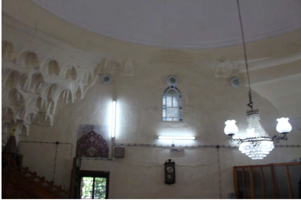
Fotoğraf No:28 Hazinedar Cami Harim Batı Cephe Bölüm(2017) (Sinan ÜNAL)
