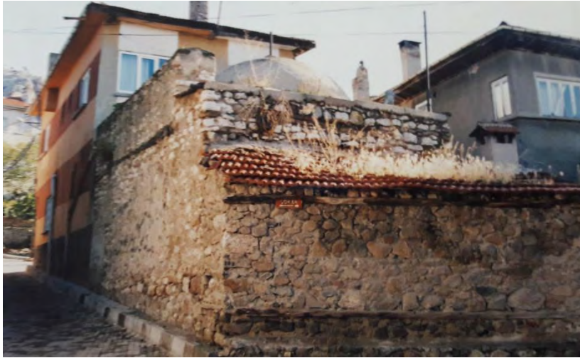
Fotoğraf No:1 Sinan Paşa Hamamı Batı ve Güney Cephe Bölümü(2003) (EKVKBKMA )
