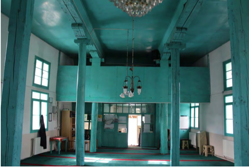
Fotoğraf No:11 Bodur Cami Kuzey Cephe Ve Kadınlar Mahfili(2017) (Sinan ÜNAL)
