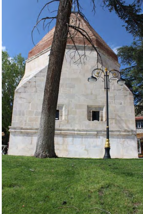
Fotoğraf No:11 Alemşah Türbesi Güney Cephe Bölümü (2017) (Sinan ÜNAL)
