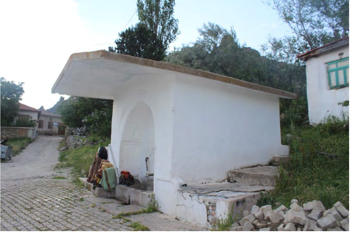
Fotoğraf No:4 Akdoğan eşme Güney ve Doęu Cephe Bölümü(2017) (Sinan ÜNAL)
