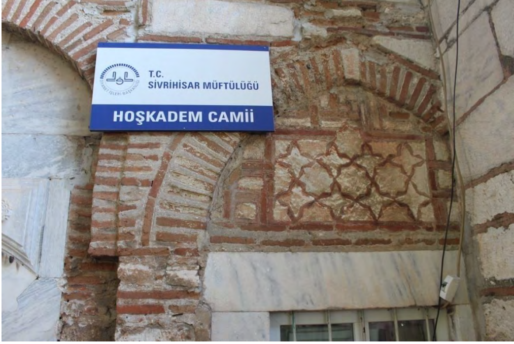
Fotoğraf No:25 Hoşkadem Cami Kuzey Cephe Pencere Bölümü(2017) (Sinan ÜNAL)
