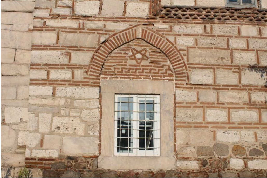
Fotoğraf No:26 Hoşkadem Cami Batı Cephe Pencere Bölümü(2017) (Sinan ÜNAL)
