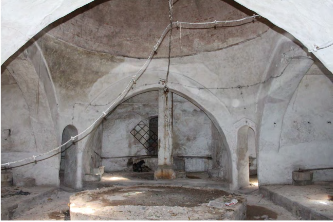
Fotoğraf No:6 Yeni(Çifte)Hamam Sıcaklık Bölümü(2017) (Sinan ÜNAL)
