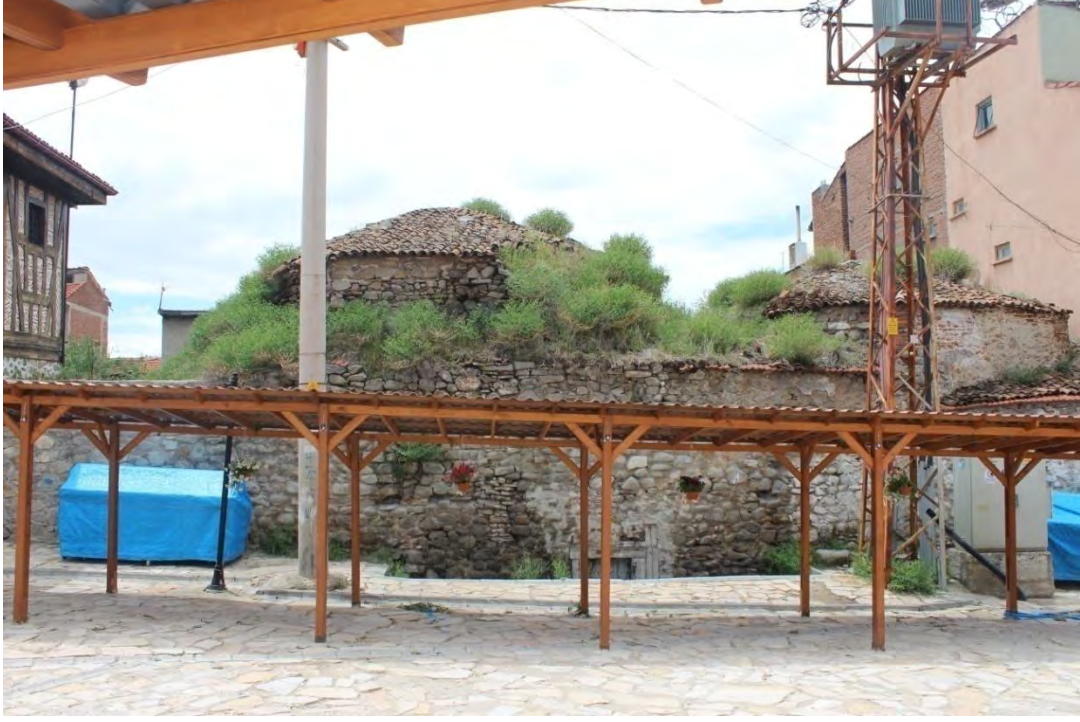
Fotoğraf No:2 Yeni(Çifte)Hamam Kuzey Cephe Bölümü(2017) (Sinan ÜNAL)
