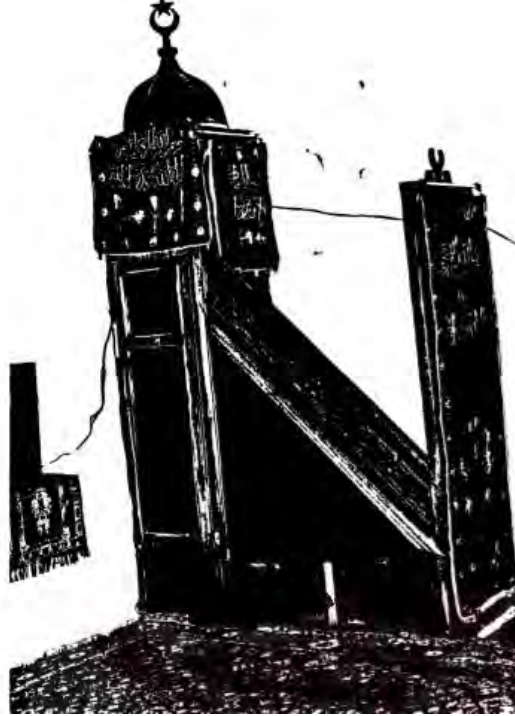
Fotoğraf No:8 Balaban Cami Güney Cephe Minber Bölümü (1988) (Erol ALTINSAPAN)
