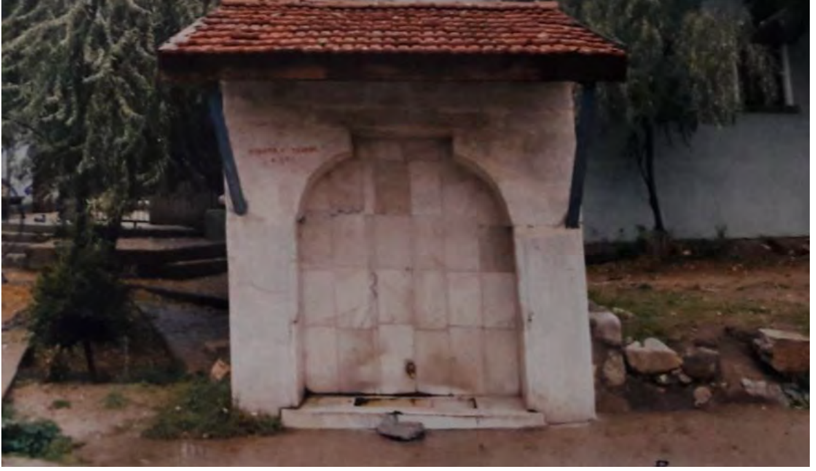
Fotoğraf No:2 Balaban Çeşmesi Kuzey Cephe Bölümü(2003) (EKVKBKMA)
