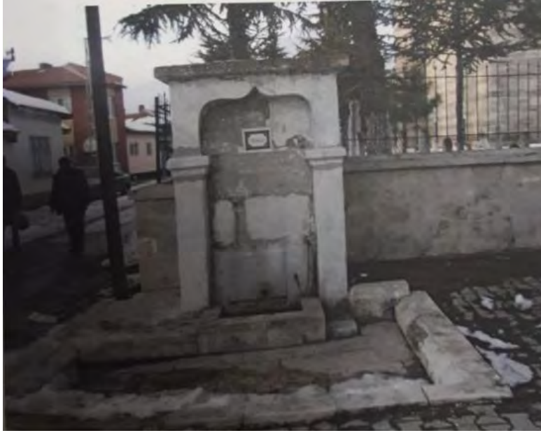
Fotoğraf No:2 Osmancık Çeşmesi Güney Cephe Bölümü Onarım Sonrası (2012) (EKVKBKMA)
