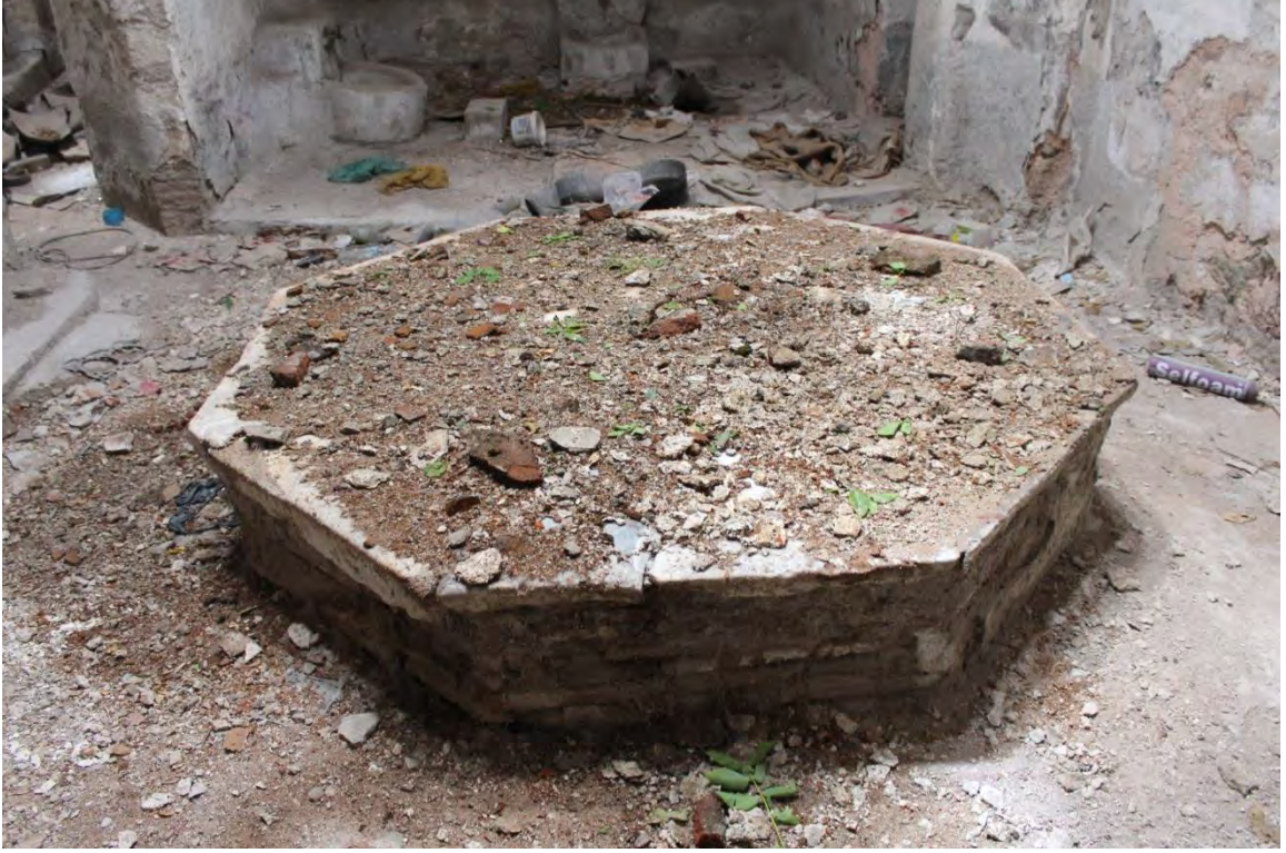
Fotoğraf No:7 Kumacık Hamamı Sıcaklık Bölümü(2017) (Sinan ÜNAL)
