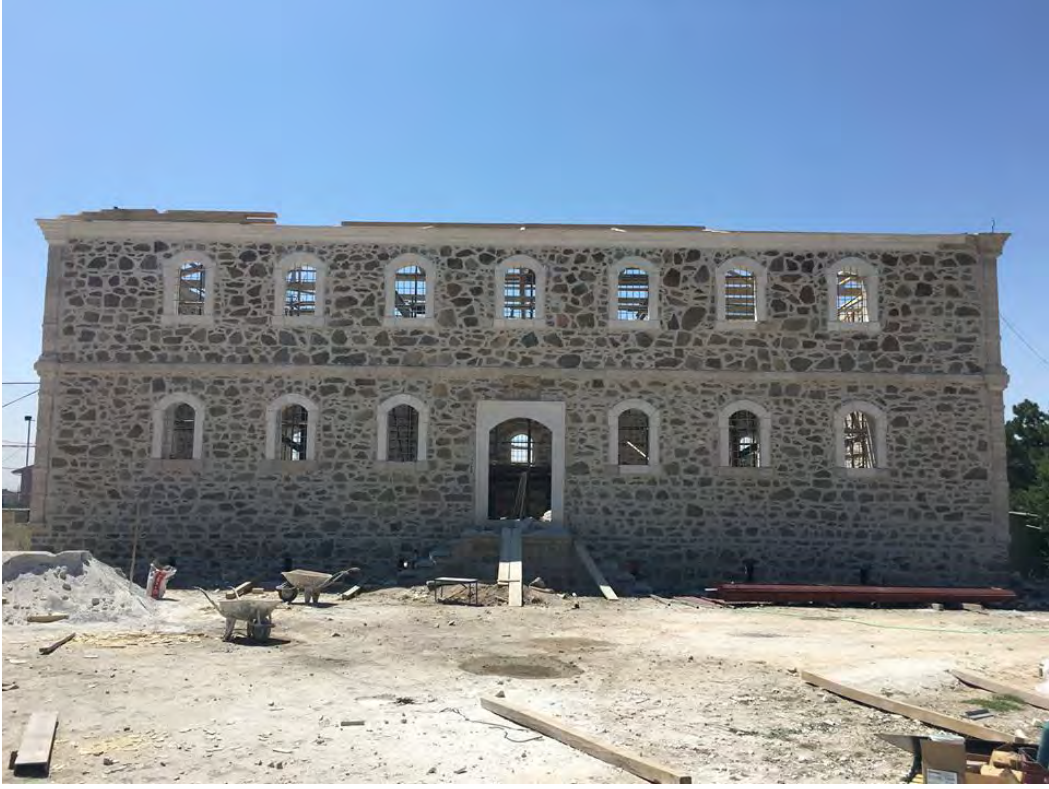
Fotoğraf No:4 Askerlik Şubesi 1 Nolu Yapı Kuzey Cephe Bölümü(2017) ( KAAN RESTORASYON İNŞ.TAAH.TUR.PROJE SAN.TİC.LTD.ŞTİ. )
