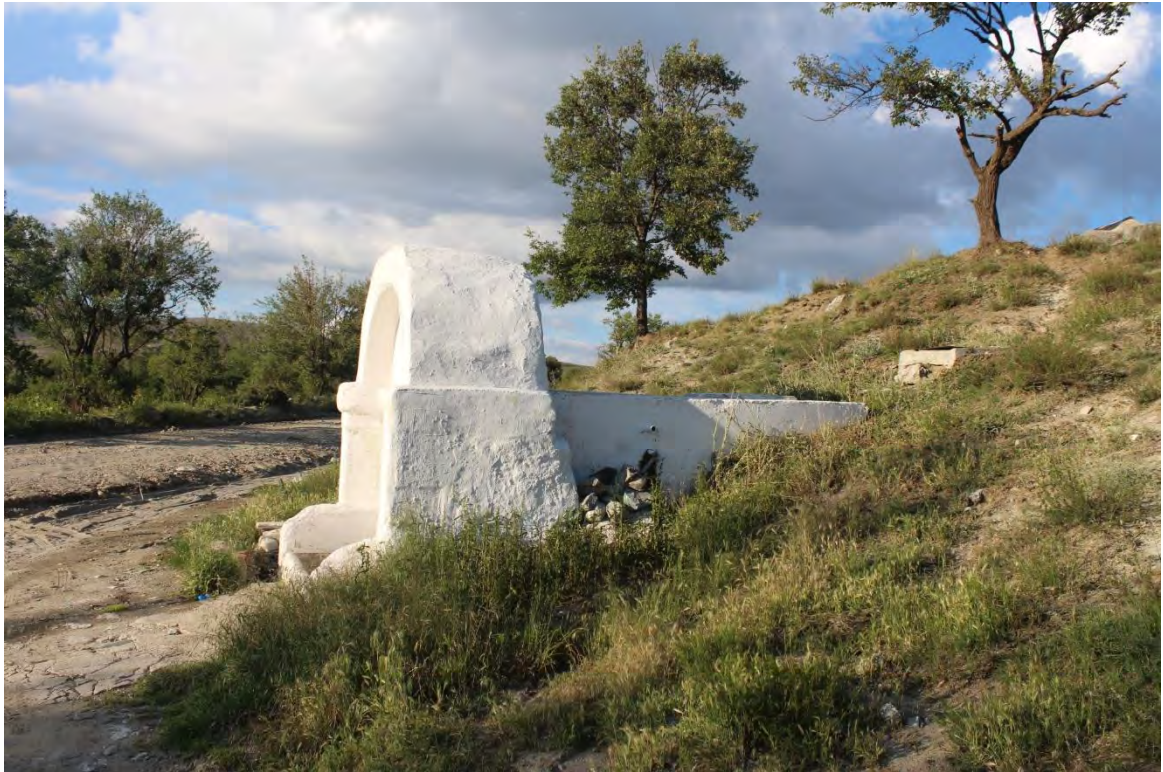
Fotoğraf No:3 Baba Çeşmesi Doğu Cephe Bölümü(2017) (Sinan ÜNAL)
