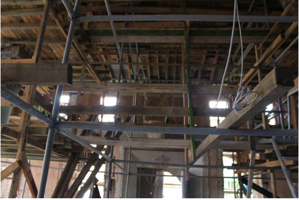
Fotoğraf No:20 Yeni Cami Harim Kuzey Cephe Bölümü(2017) (Sinan ÜNAL)
