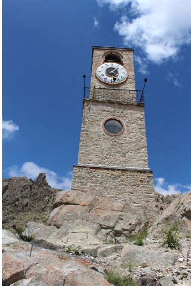
Fotoğraf No:14 Sivrihisar Saat Kulesi Güney Cephe Bölümü(2017) (Sinan ÜNAL)
