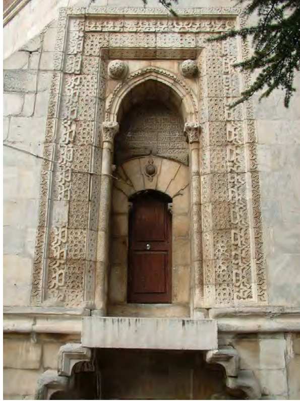
Fotoğraf No:9 Alemşah Türbesi Portal Bölümü(2017) (Sinan ÜNAL)
