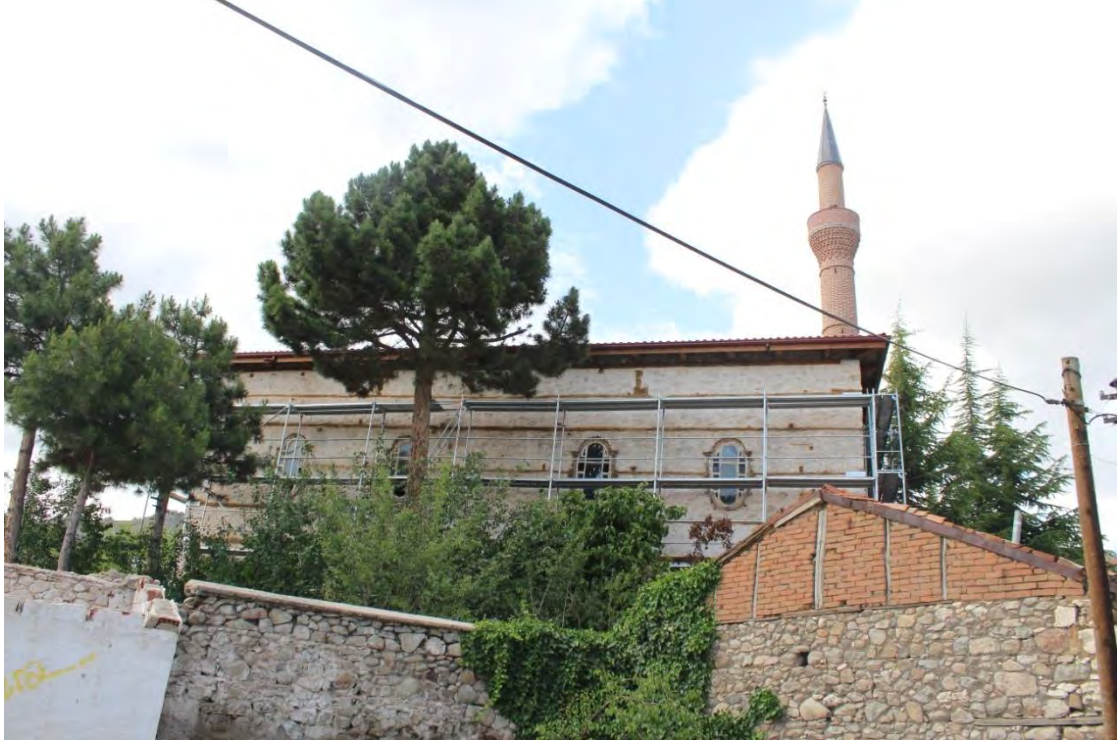
Fotoğraf No:18 Yeni Cami Güney Cephe Bölümü(2017) (Sinan ÜNAL)
