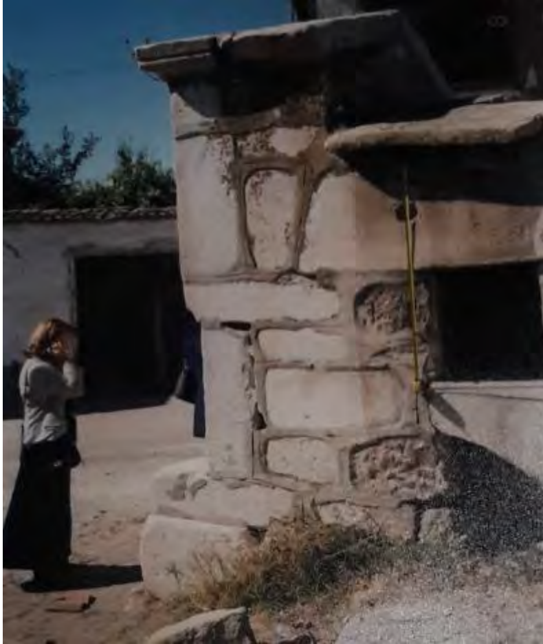
Fotoğraf No:4 Ak Çeşme Restore Edilme Durumu(1998) (EKVKBKMA)
