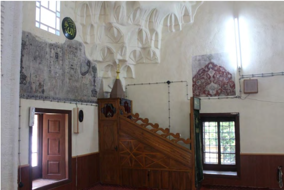
Fotoğraf No:34 Hazinedar Cami Harim Batı Cephe Minber Bölümü(2017) (Sinan ÜNAL)
