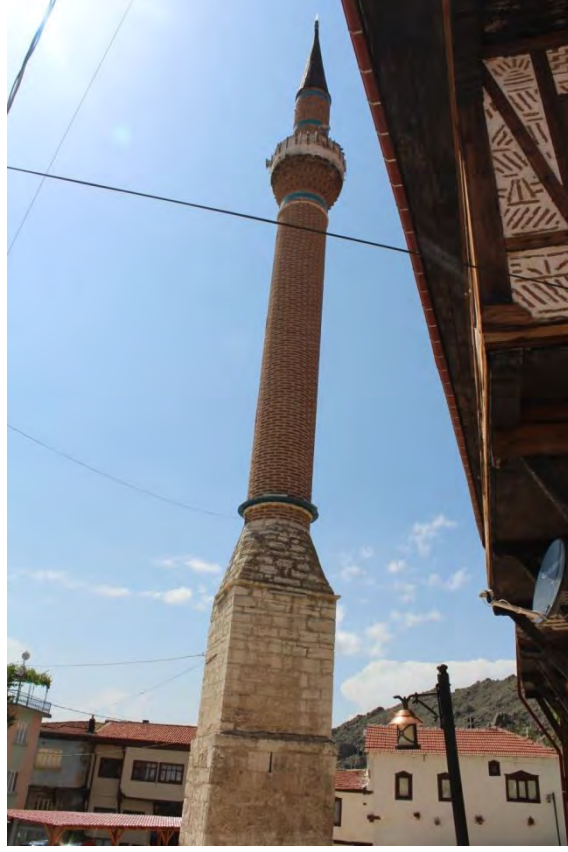
Fotoğraf No:9 Kılıç Mescit Minaresi Kuzey Cephe Bölümü (2017) (Sinan ÜNAL)
