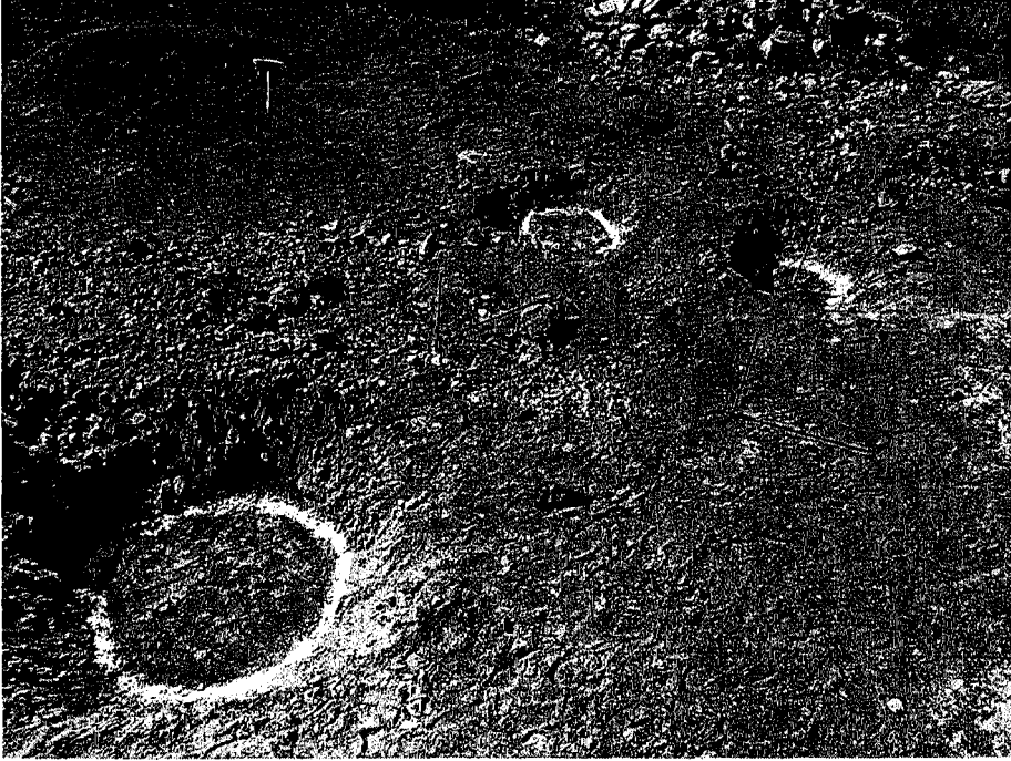
Şekil 5.20 Jet Grout kolonlarının hafriyat öncesi
