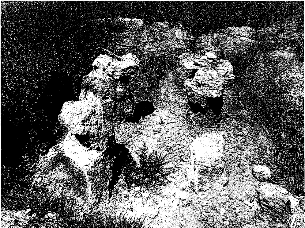
Şekil 5.23.a \Phi 80 Jet Grout kolonu hafriyat sonrası görünümü
