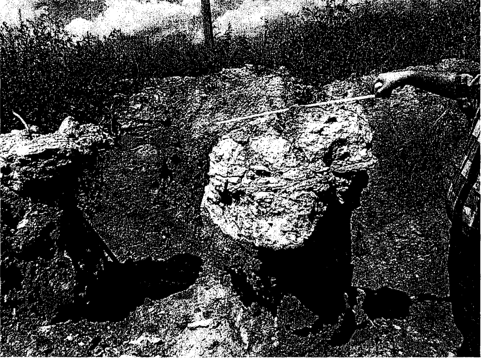
Şekil 5.23.b \Phi 80 Jet Grout kolonu hafriyat sonrası görünümü
