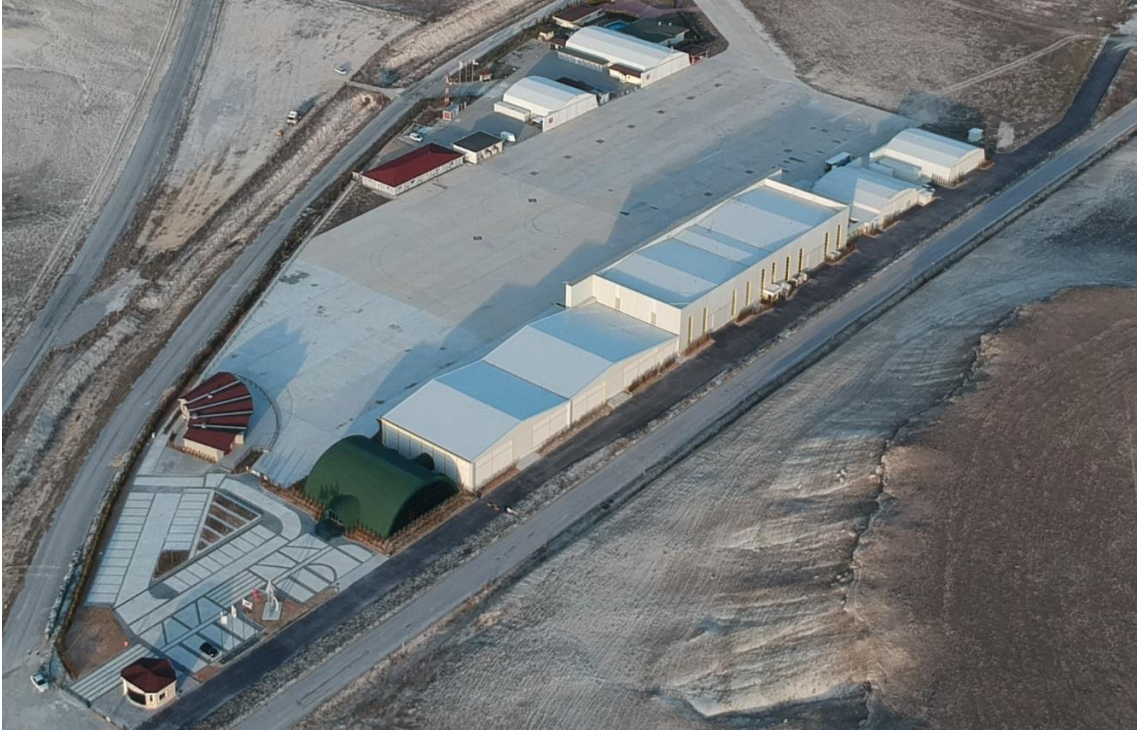
Görsel 3.11. Sivrihisar Havacılık Merkezi Tesisleri (Kaynak: https://www.shm.aero/ , Erişim Tarihi: 22.05.2022).
