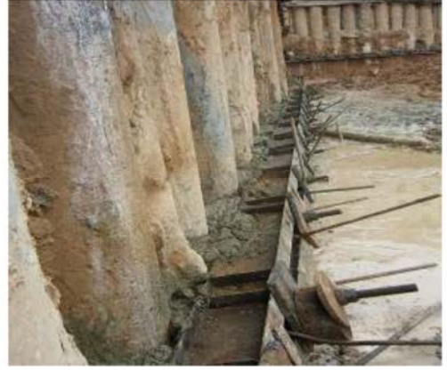
Görsel 11.2. Ankrāj İçeren Duvarlar, a. Kazık-Kiriş Tipi ve b. Arazideki Deliklere Sonradan Yerleştirilen Tip Kaynak: Nikitenko vd., 2013, s. 809
