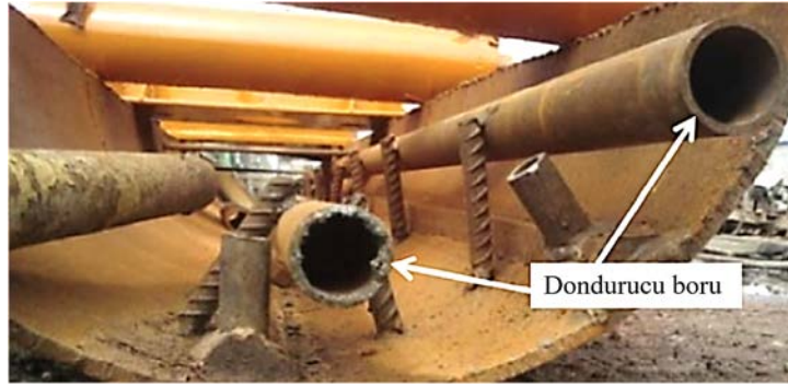
Görsel 2.3. a. Kaplama Çizimi ve b. Dondurucu Boru Fotoğrafı Kaynak. Kang vd., 2016, s. 5
