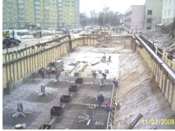
Görsel 11.1. Derin Temel Kazısında Ankrajsız Kazık-Kiriş Duvar Sistemi Kaynak: Nikitenko vd., 2013, s. 808
