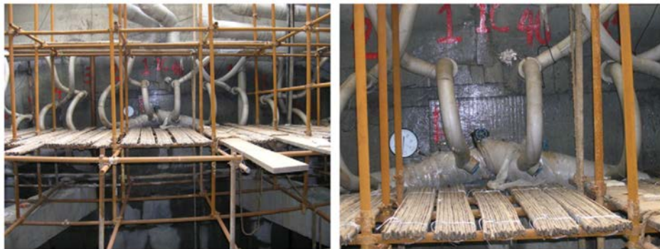
Görsel 2.2. Dondurma İşlemi ve Dondurucu Boru Fotoğrafları Kaynak: Li vd., 2006, s. 182
