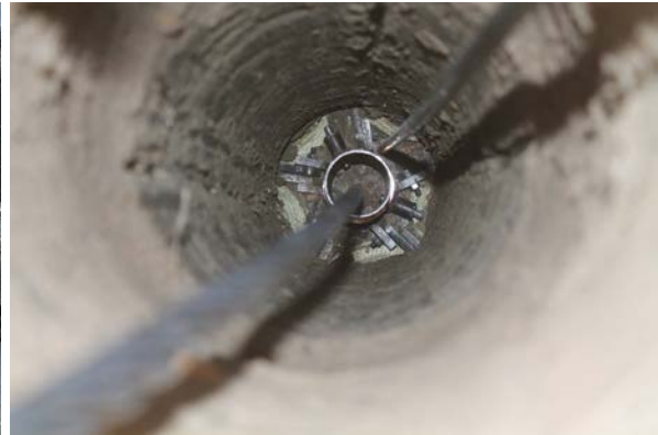
Görsel 14.9. Kesici Kanatların Açılması; a. Şematik Gösterim, b. Halat Payının Ölçümü, c. Açma Sonrası Halat Payı Ölçümü ve d. Kuyu İçerisinde Açılmış Şemsiye Ankraj
