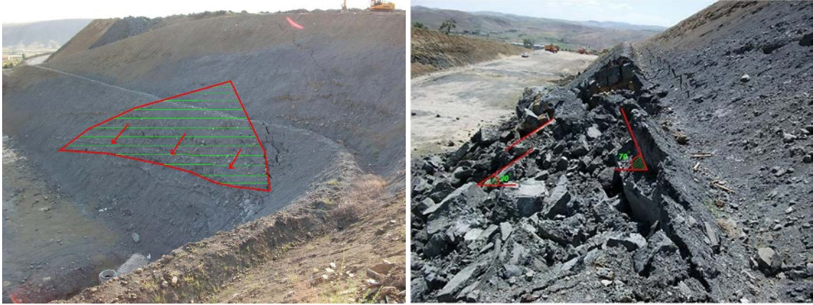
Görsel 9.3. a. Kayma Öncesi Şevde Öngörülen Kayma Yüzeyi ve b. Kayma Sonrası Gözlenen Kayma Açıkları
