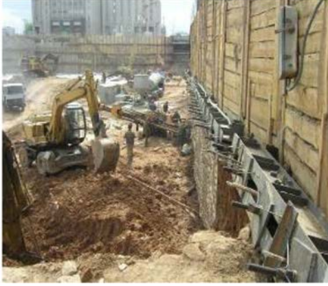
Görsel 11.2. Ankrāj İçeren Duvarlar, a. Kazık-Kiriş Tipi ve b. Arazideki Deliklere Sonradan Yerleştirilen Tip Kaynak: Nikitenko vd., 2013, s. 809
