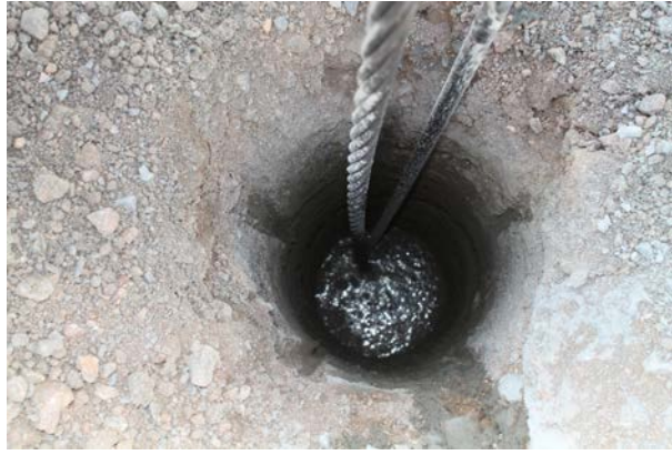
Görsel 14.11. (Devam) Enjeksiyon İşlemi, a. Şematik Gösterim, b. Enjeksiyon Makinesinde Çimento - Su Karışımının Hazırlanması, c. Enjeksiyon Deliklerinden Püskürtme İşlemi ve d. Enjeksiyon İşlemi Bitmiş Kuyu
