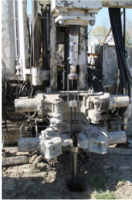
Görsel 14.10. Zeminin Boşaltılması İşlemi; a. Şematik Gösterim ve b. Arazi Uygulaması
