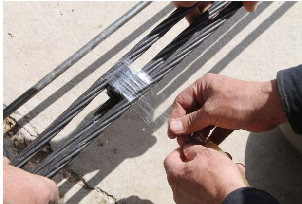
Görsel 14.7. Ankrajın Hazırlanması, a. Kapalı Konum Şematik Gösterim, b. Açık Konum Şematik Gösterim, c. Halatların Sabitlenmesi, d. Ayırıcının Sabitlenmesi ve e. Enjeksiyon Rekorunun Kapatılması
