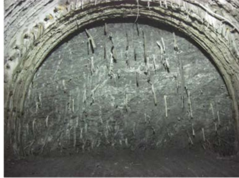
Görsel 10.4. Zemin Çivisi Uygulaması İle İyileştirilen Timpa Delle Vigne Tünel Yüzeyi
