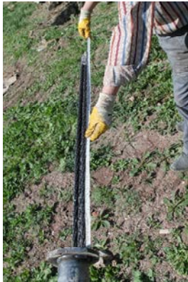
Görsel 14.9. Kesici Kanatların Açılması; a. Şematik Gösterim, b. Halat Payının Ölçümü, c. Açma Sonrası Halat Payı Ölçümü ve d. Kuyu İçerisinde Açılmış Şemsiye Ankraj
