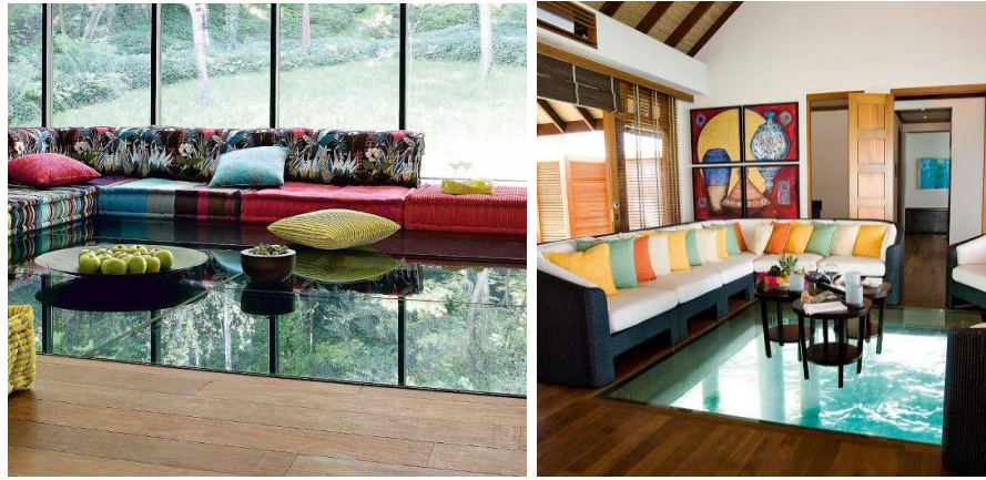
Görsel 1.36. İç mekân lamine cam parke zemin uygulamaları ( http-30 , 2019)
