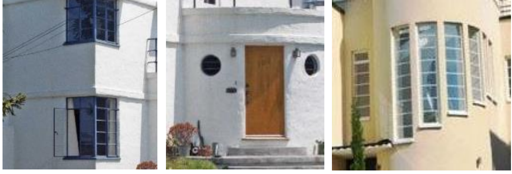
Görsel 4.7. Konutların dış cephelerinde ve köşe noktalarında bulunan pencere detayları ( http-87 , 2019)
