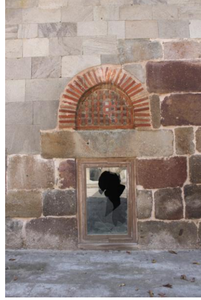
Fotoğraf 3.7. Kuzey Cephe Duvarında yer alan pencere alınlılığının süslemesi ( Mert Keke)
