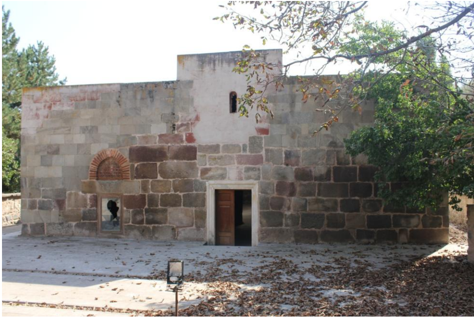
Fotoğraf 3.5. Hankah yapısı kuzey cephesi (Mert Keke 2018)
