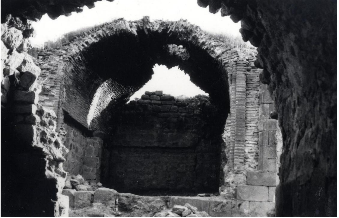
Fotoğraf 3.33. Eyvan tipi türbe batı cephe (VGM arşiv)
