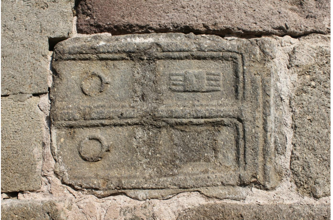
Fotoğraf 3.9. Batı Cephe duvarında yer alan devşirme taş (Mert Keke, 2018)
