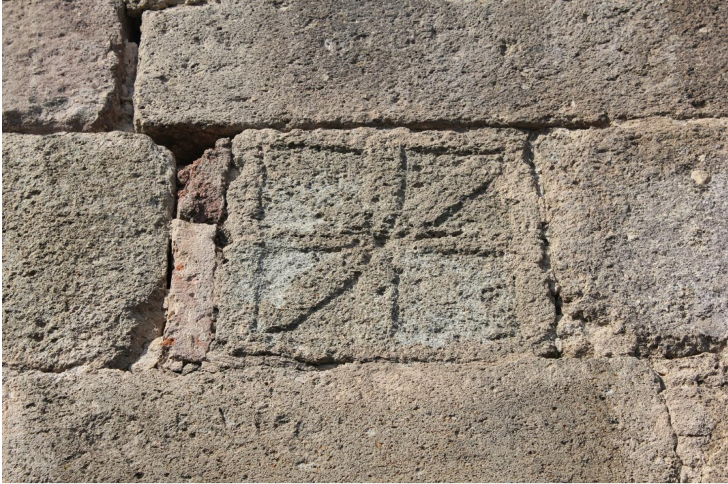
Fotoğraf 3.31. Boyalıköy Hankahı güney cephe duvarında olan devşirme taş malzeme (Mert Keke, 2018)
