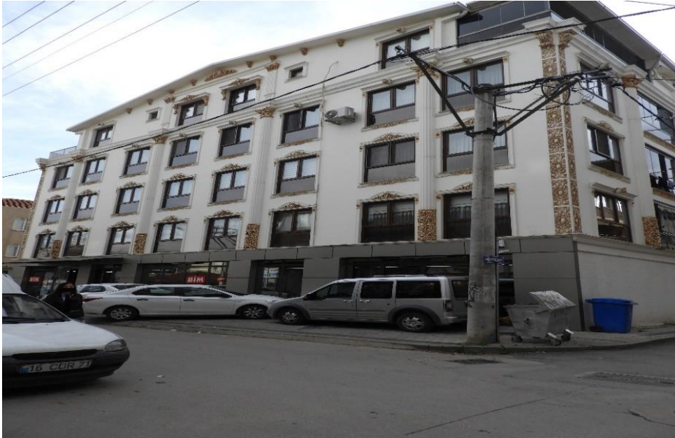
Görsel 5.5. Mahallede müteahhit tarafından inşa edilen apartmanlara bir örnek (Yazarın kişisel arşivinden)
