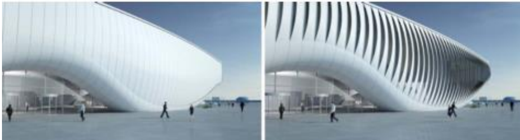
Görsel 3.9. Ocean Thematic Pavilion, 2012, açık ve kapalı hareketli cephe panjurları, SOMA Architecture, Güney Kore ( http-15 )
