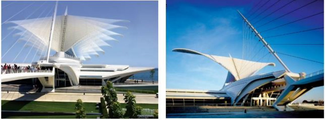
Görsel 3.11. Milwaukee Pavyonunun, 2001, kanatlarının açılıp kapanma hareketi ( http-17 )
