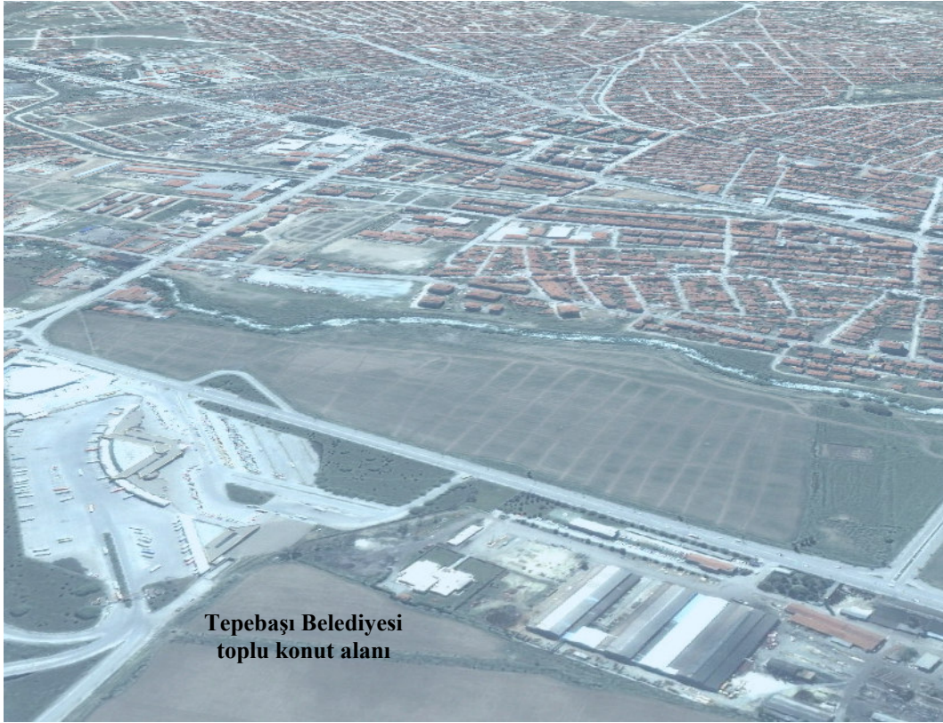
Şekil 4.107. Tepebaşı Belediyesi toplu konut alanlarının kuzeybatı yönünden görünüşü
