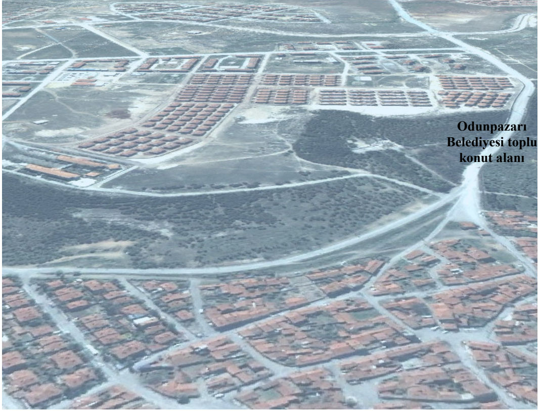
Şekil 4.112. Çankaya Mahallesiindeki mevcut konutlar ve Odunpazarı Belediyesi toplu konut alanının görünüşü
