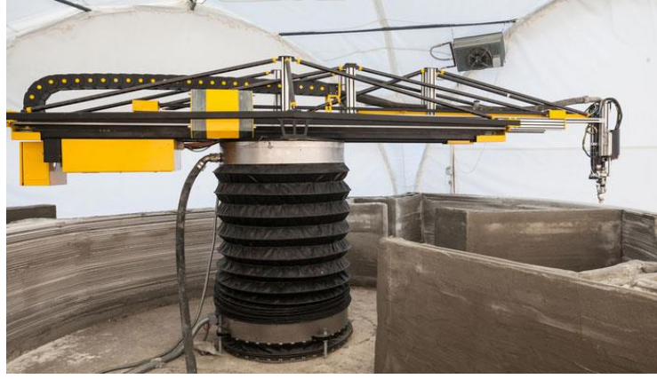
Görsel 2.17. Üç boyutlu yazıcı ile ev inşa aşaması, Apis Cor firması Kaynak: https://www.3dnatives.com/en/3d-printed-house-companies-120220184/
