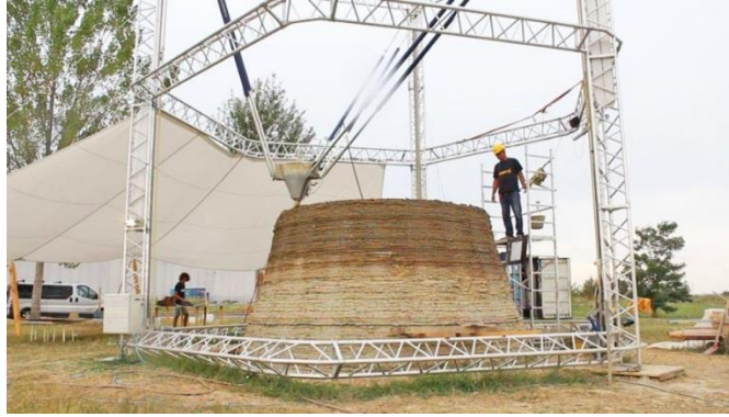
Görsel 3.5. Üç boyutlu yazıcı ile yapı inşası, Wasp Projesi
