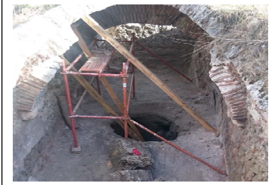
Fotoğraf 2.12. Eski-Yeni/Süleyman Şah Hamamı Su Deposu (KVBM Arşivi)
