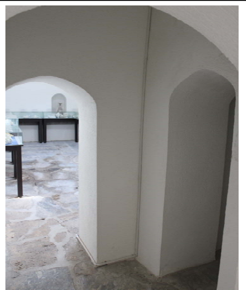
Fotoğraf 2.42. Şengül Hamamı Aralık Mekânı
