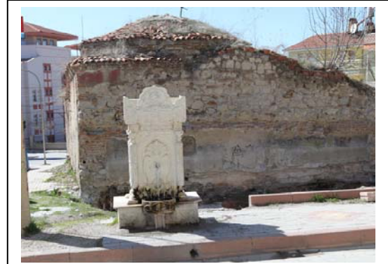
Fotoğraf 2.81. Moymul Hamamı Doğu Cephesi
