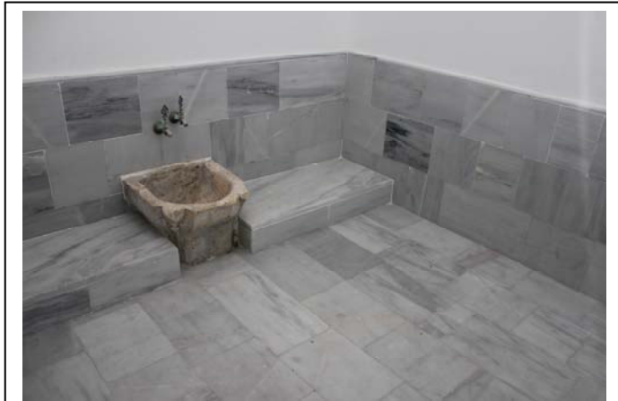
Fotoğraf 2.71. Gazanfer Ağa Hamamı Erkekler Bölümü Sıcaklık Bölümünün Halvet Hücrelerinden Biri
