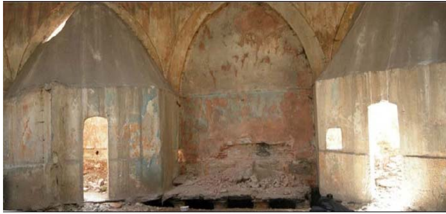
Fotoğraf 2.95. Gâvur Hamamı Sıcaklık Bölümü (Sayan, 2010, s. 397)
