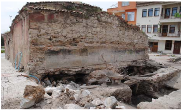
Fotoğraf 2.88. Moymul Hamamı'nın Kütahya Müzesi'nin Gerçekleştirdiği Kurtarma Kazısı Sonucunda Ortaya Çıkarılan Külhan Mekânının Temelleri (Tavşanlı Belediyesi Arşivi)
