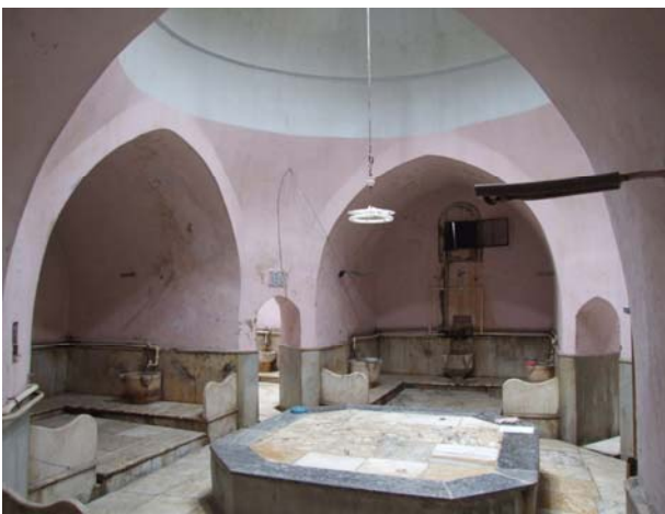
Fotoğraf 2.24. Egedemir Hamamı Sıcaklık Bölümü
