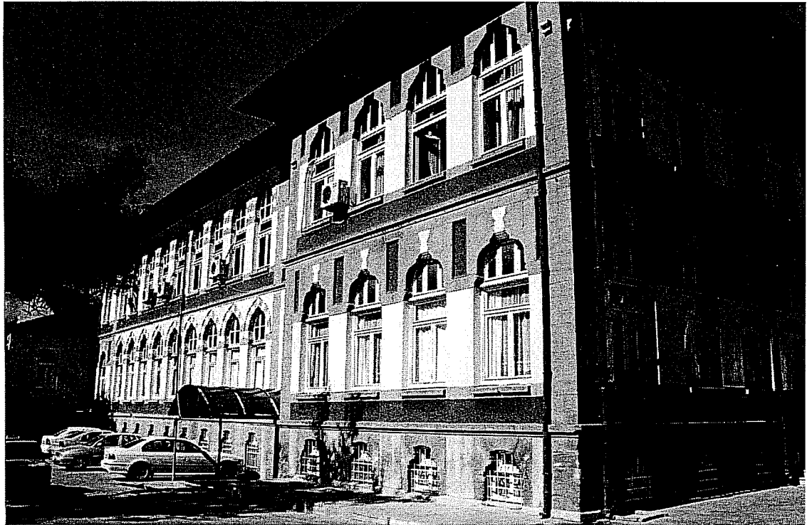
Resim 66-Konya Kız Öğretmen Okulu güney cephesi
