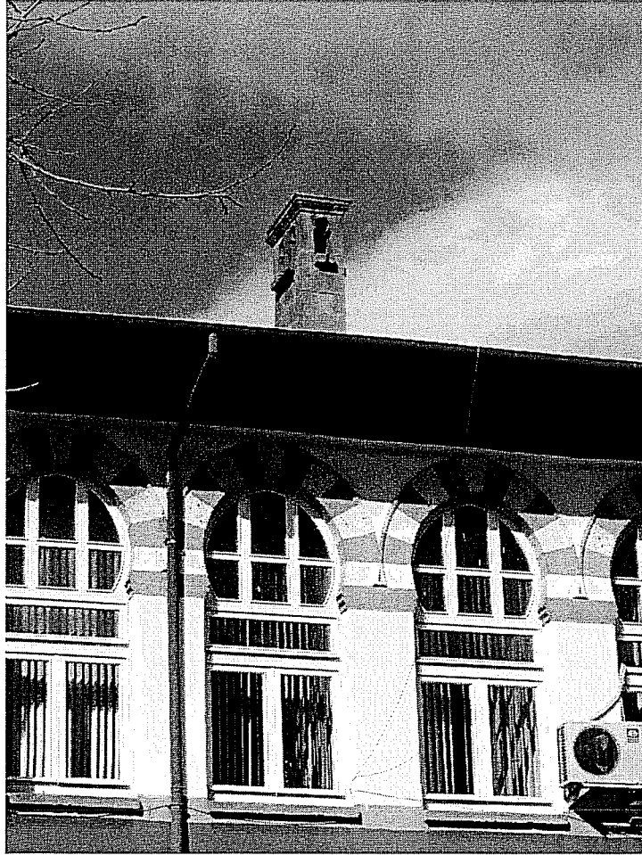
Resim 74- Konya Kız Öğretmen Okulu güney cephe detay
