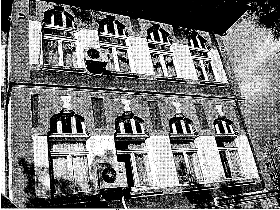
Resim 73- Konya Kız Öğretmen Okulu güney cephe detay
