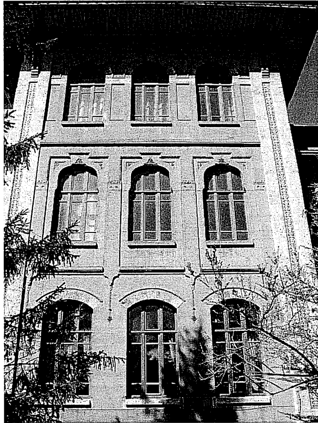
Resim 58-Konya Erkek Öğretmen Okulu güney cephe detay
