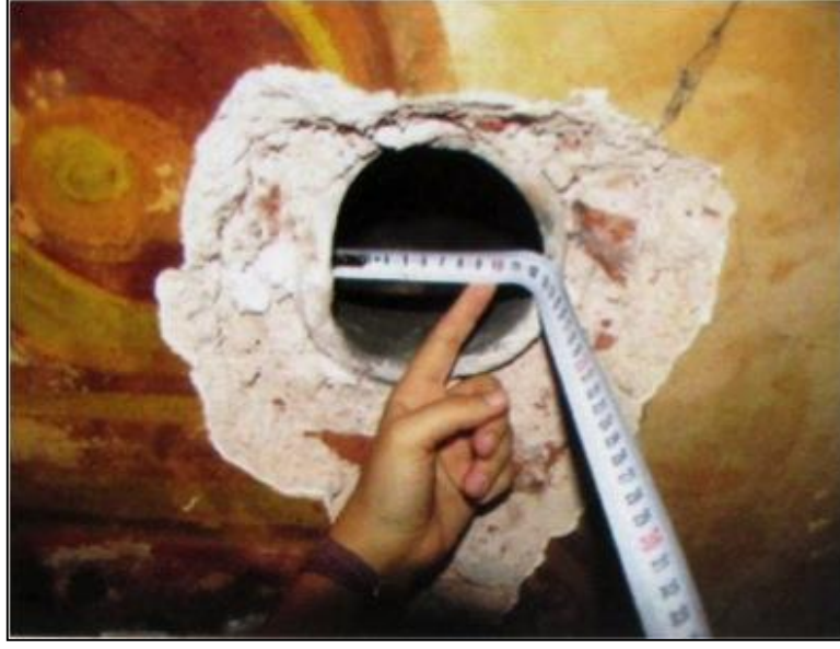
Şekil 3.14. Süleymaniye Camisi restorasyonunda bulunan rezonatör ağzı (Çılı ve ark. 2011)
