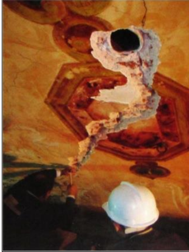
Şekil 3.15. Süleymaniye Camisi kubbesindeki rezonatörlerin yarattığı bozulma (Çılı ve ark. 2011)
