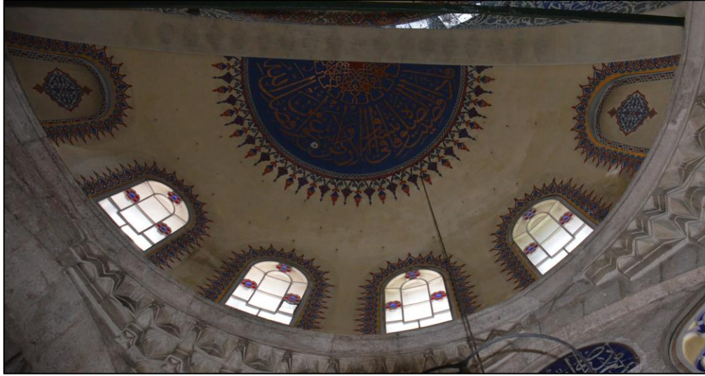
Şekil 5.30. Kuzeydoğu yarım kubbenin fotoğrafla yapılan ikinci belgelemede elde edilen görüntüsü
