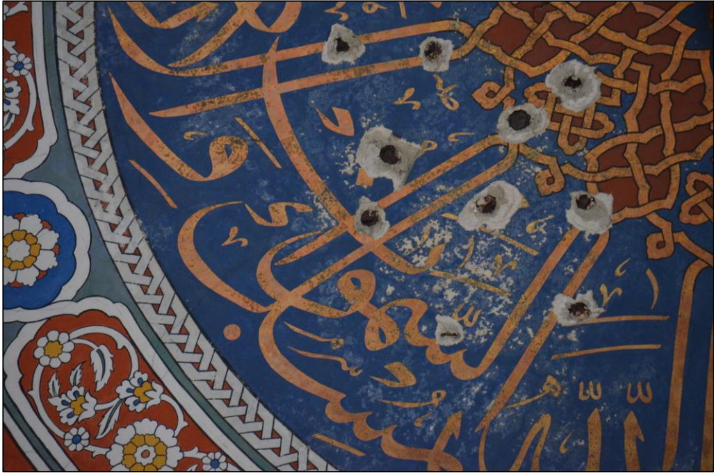
Şekil 6.4. Ana kubbenin merkezinde oluşmuş bozulmalar
