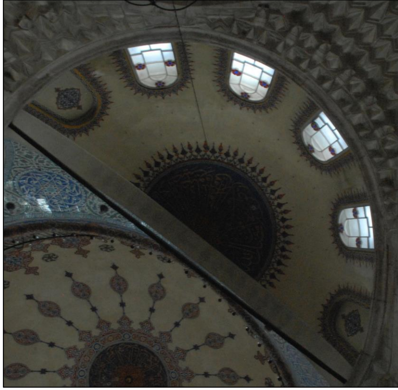
Şekil 5.7. Kuzeydoğu yarım kubbenin, batı mahfilden çekilmiş fotoğrafı
