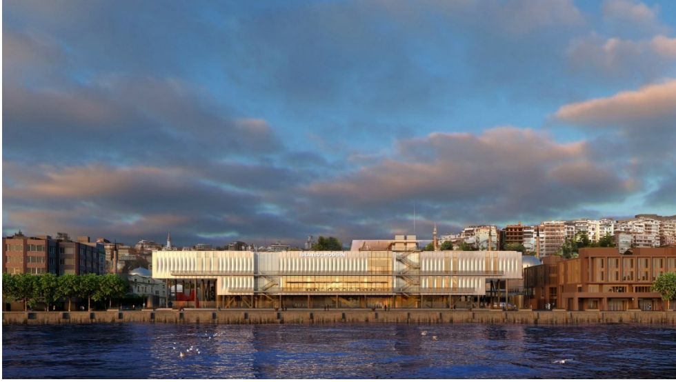
Görsel 61. İstanbul Modern Müze'nin yeni binası
