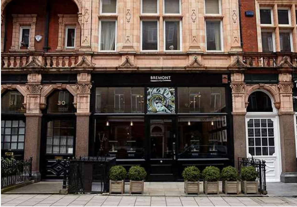
Görsel 3.35. Bremont mağazası cephe görüntüsü (http-54)
