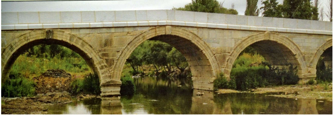
Şekil 3.31. Yeni mermer korkuluklarla onarılmış 4 numaralı köprü (Türktüzün, 2017, s. 7)
