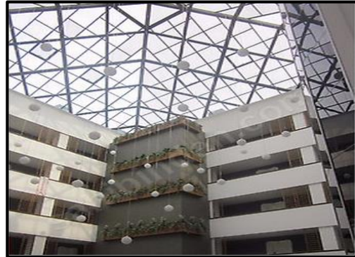
Görsel 127. Başak Rezidans Atrium, Orta Mekanın Çatı İle Örtülmesi
