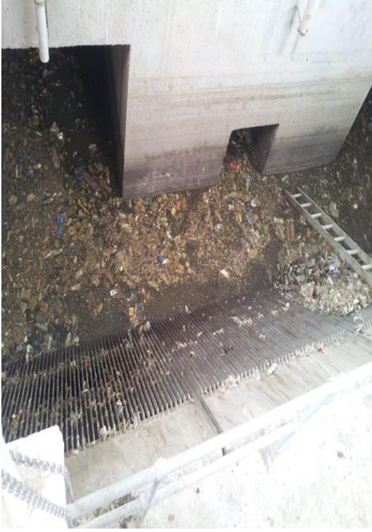
Şekil 2.4. Belediye Atık Su Arıtma Tesisi giriş ve kum yağ tutucu ünitesi
