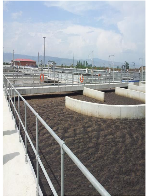
Şekil 2.5. Belediye Atık Su Arıtma Tesisi ön çöktürme ve havalandırma ünitesi
