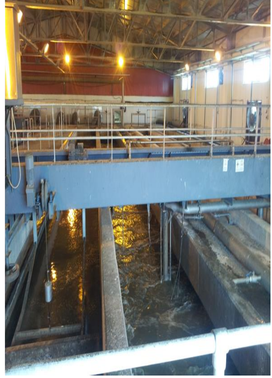
Şekil 2.4. Belediye Atık Su Arıtma Tesisi giriş ve kum yağ tutucu ünitesi
