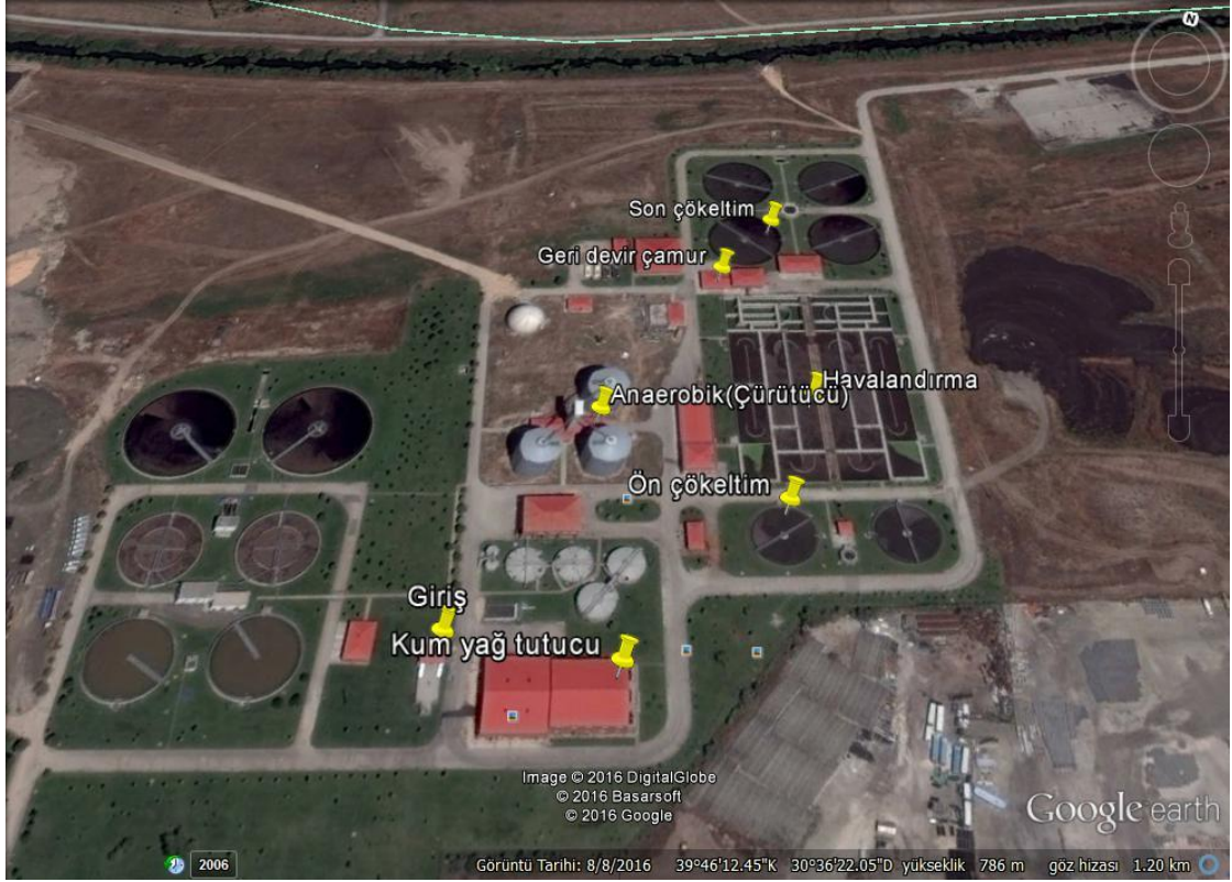
Şekil 2.2. Belediye Atık Su Arıtma Tesisi örnekleme noktaları
