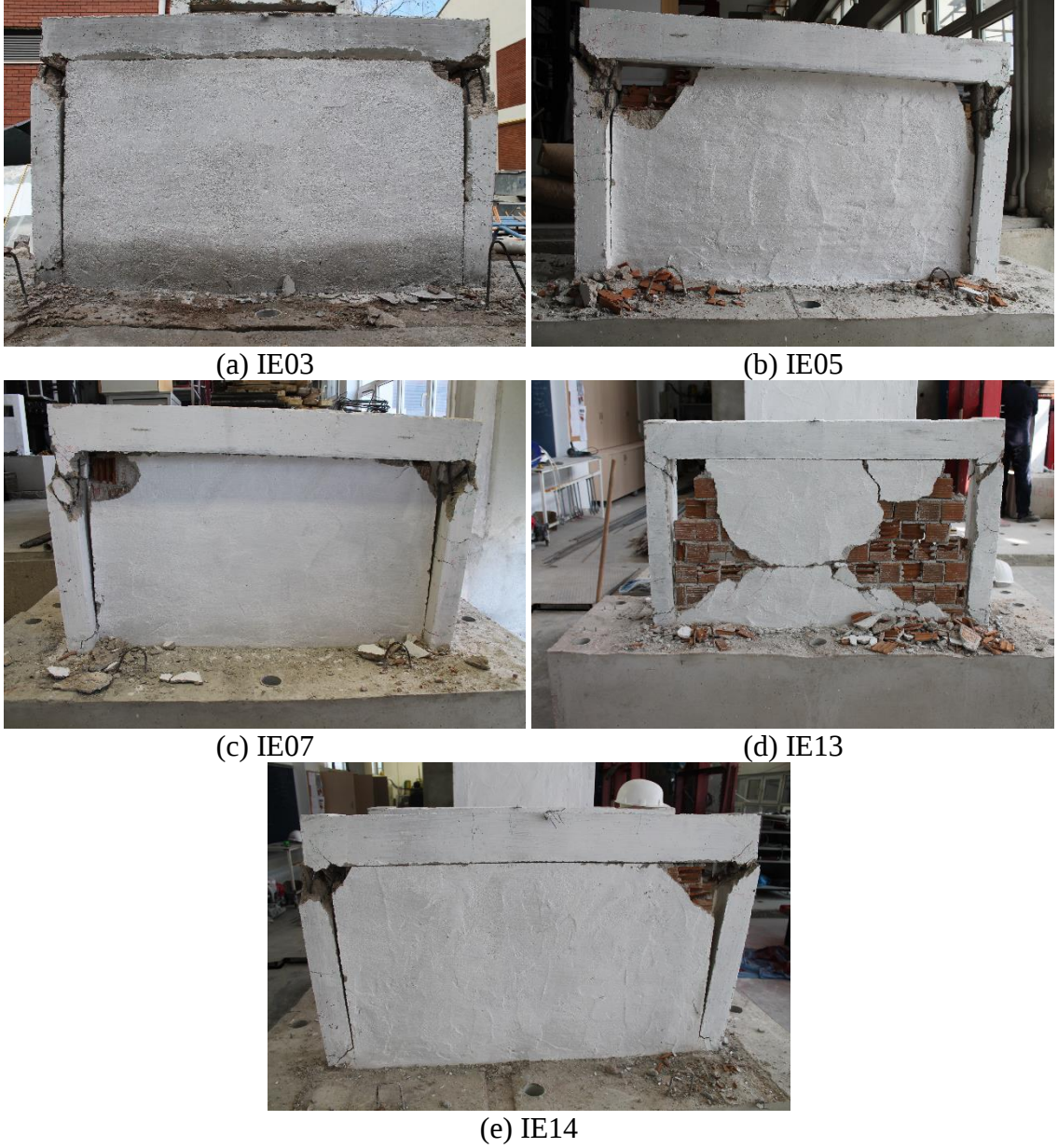
Görsel 4.63. Beklenmeyen kısa kolon hasarı gözlenen numuneler
