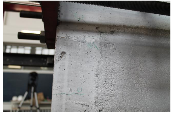
(b) Kolondaki ilk kesme çatlakı
