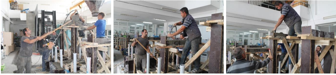
Görsel 3.15. Kolon kiriş beton dökümü
