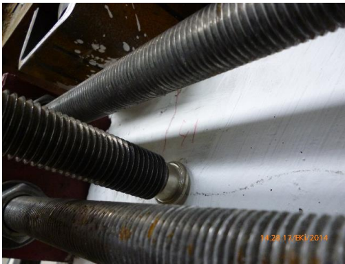
(a) Kirişteki ilk eğilme çatlağı
