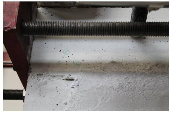
(b) Birleşim bölgesindeki ilk çatlak
