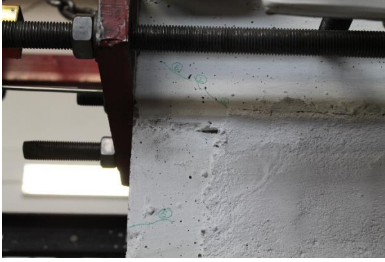
(a) Kolondaki ilk eğilme çatlağı
