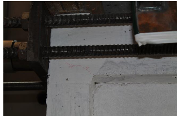
(b) Birleşim bölgesindeki ilk çatlak
