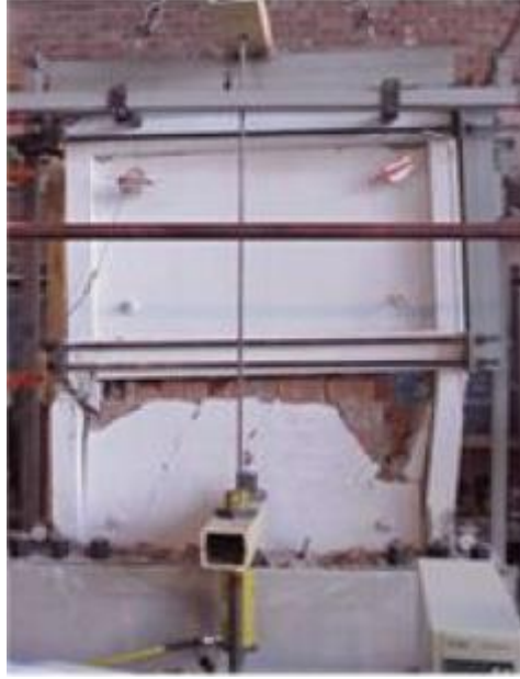
Görsel 2.10. Kolonda ilk katta gözlenen kesme hasarı
