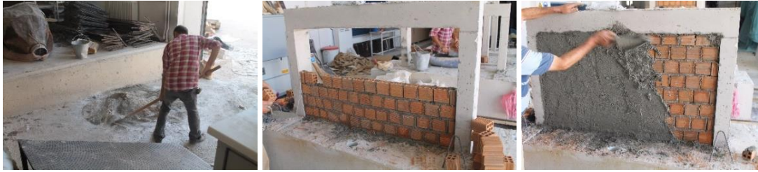
Görsel 3.5. Harç ve sıva uygulaması
