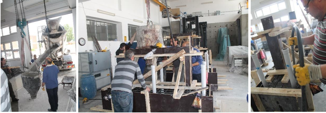
Görsel 3.14. Temel betonu dökümü
