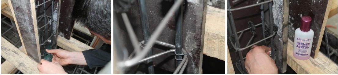
Görsel 3.10. Birim deformasyon ölçer yapıştırılacak bölgenin temizlenmesi
