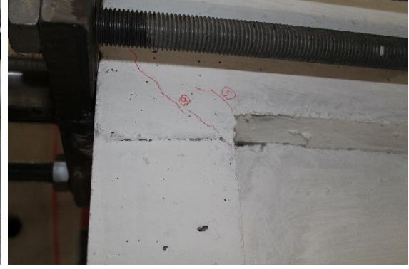
(b) Kolondaki ilk kesme çatlağı
