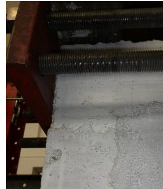
(b) Birleşim bölgesindeki ilk çatlak
