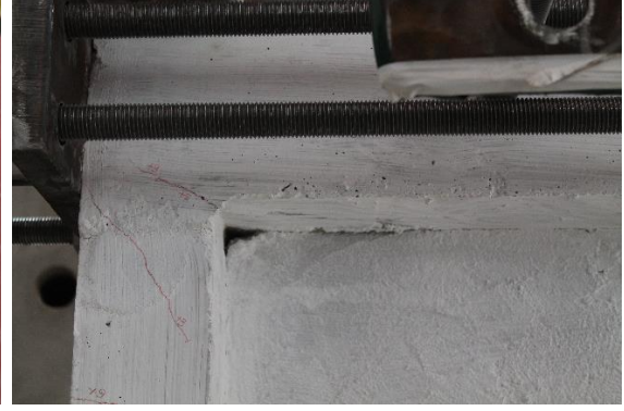
(b) Kolondaki ilk kesme çatlağı
