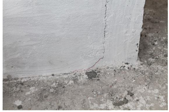
(b) Duvarda dönmeye neden olabilecek hasar
