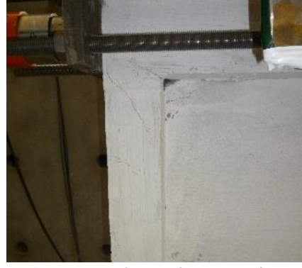
(b) Duvarda gözlenen ezilme
