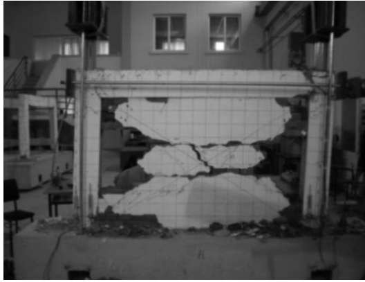
(a) Standart tuğla ile gözlenen hasar
