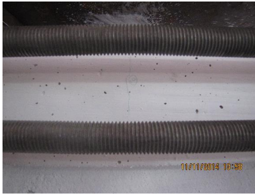
(a) Kirişteki ilk eğilme çatlak
