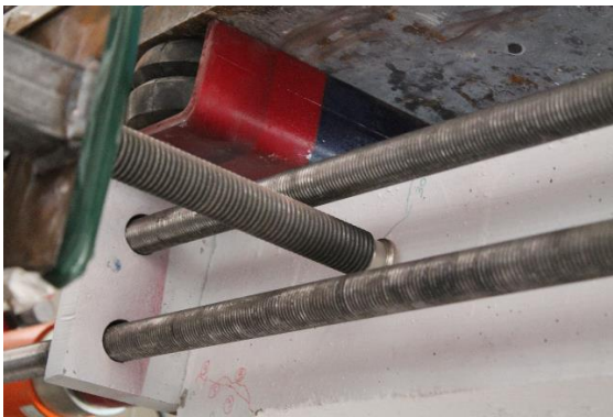
(a) Kirişteki ilk eğilme çatlak
