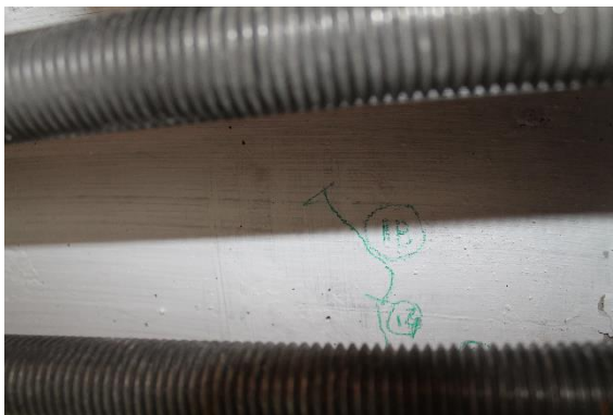
(a) Kirişteki ilk eğilme çatlakı
