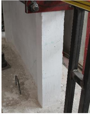
(a) Kolondaki ilk eğilme çatlakı
