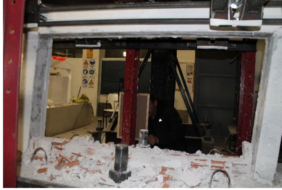
(c) Son çevrimdeki duvar hasarı
